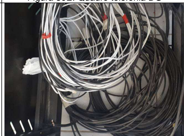
Figura 32E: cabos rede lógica UTP e fibras MM
