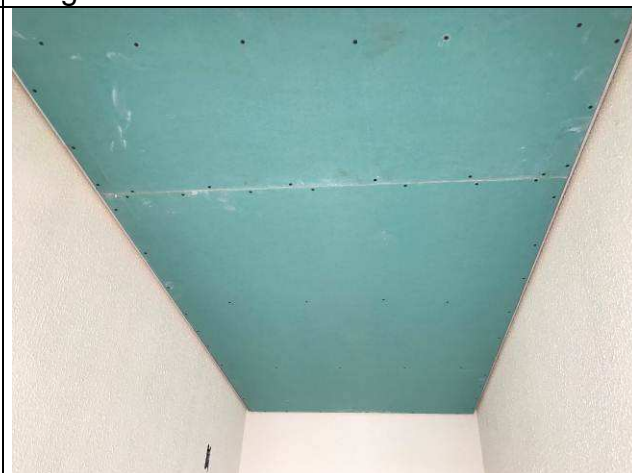
Figura 51C: Forro de gesso acartonado - Hall's de Entrada Laterais.
