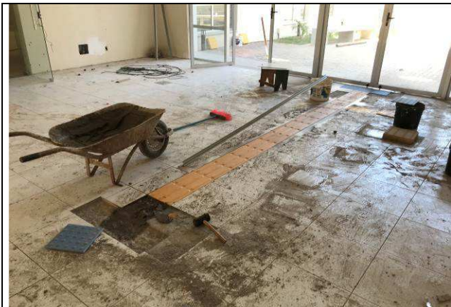
Figura 55C: Instalação do piso podotátil - Hall de entrada.
