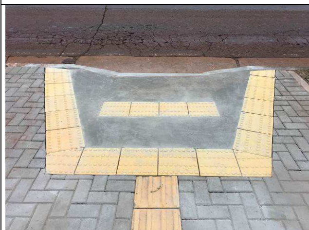
Figura 83C: Rampa de acesso PNE - calçadas externas.
