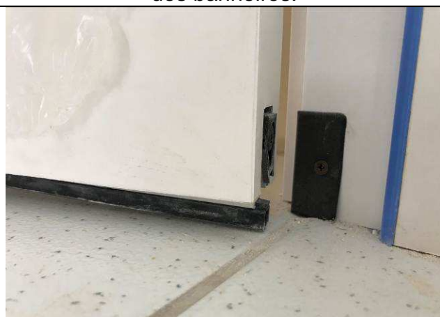
Figura 28C: Detalhe da barra retrátil inferior - portas acústicas.
