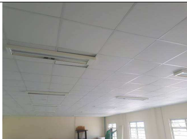
Figura 13E: luminárias arquivo
