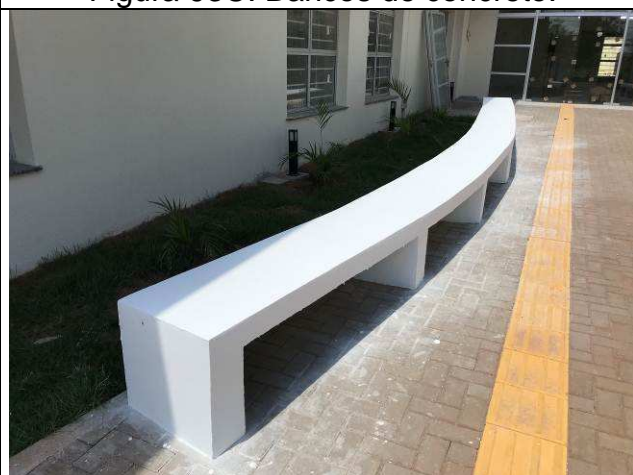
Figura 95C: Bancos de concreto.
