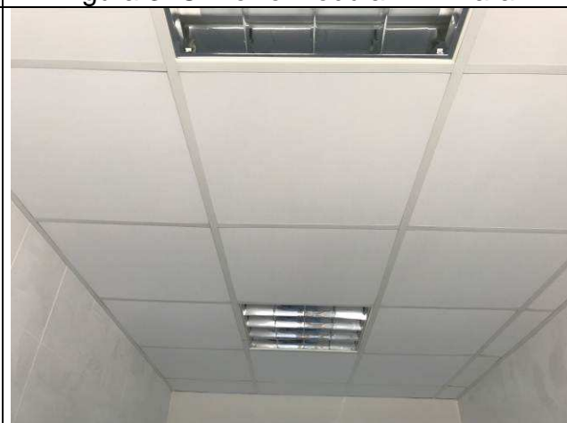
Figura 39C: Forro modular - 1ª Vara.
