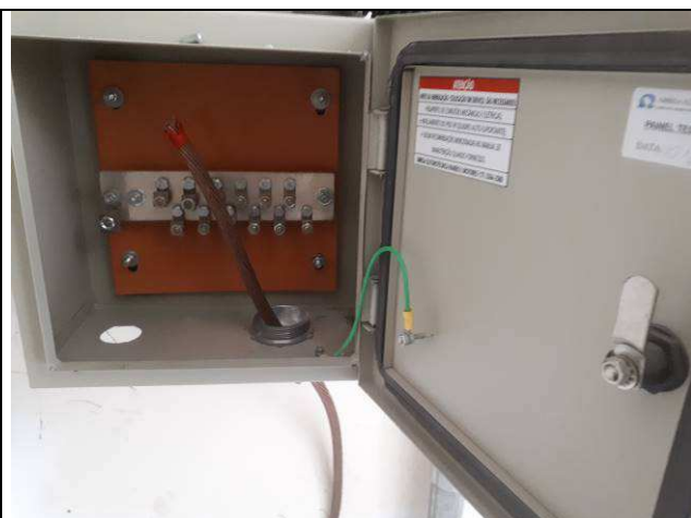
Figura 38E: BEP sala técnica
