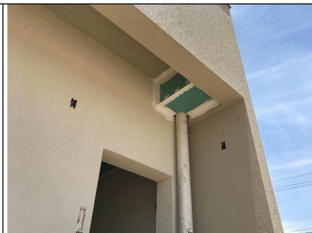
Figura 53C: Forro de gesso acartonado - Descidas das prumadas das calhas.
