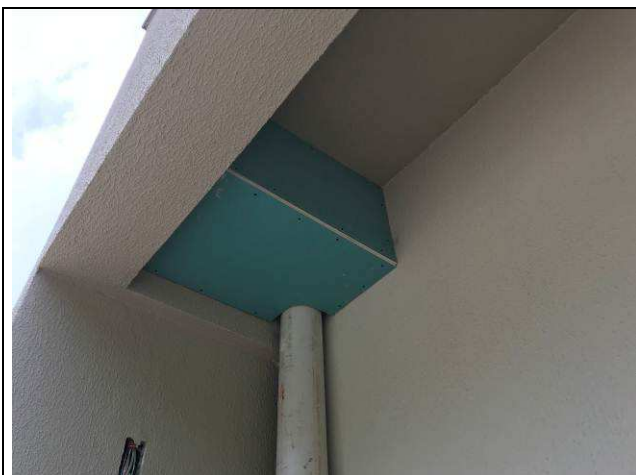
Figura 52C: Forro de gesso acartonado - Descidas das prumadas das calhas.
