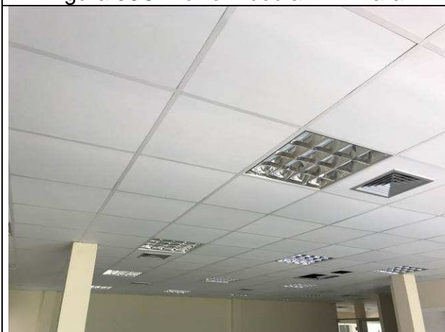
Figura 38C: Forro modular - 1ª Vara.
