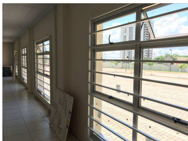
Figura 32C: Grades de janela - Arquivo.
