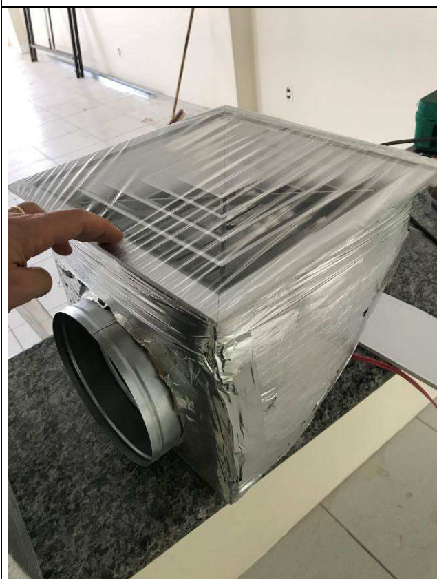
Figura 71C: Conjunto caixa + difusor de insuflamento - Fórum.
