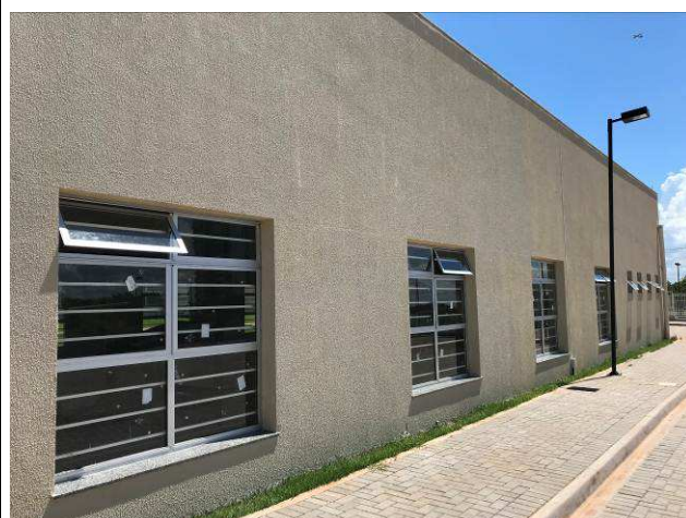
Figura 33C: Grades de janela - Arquivo.
