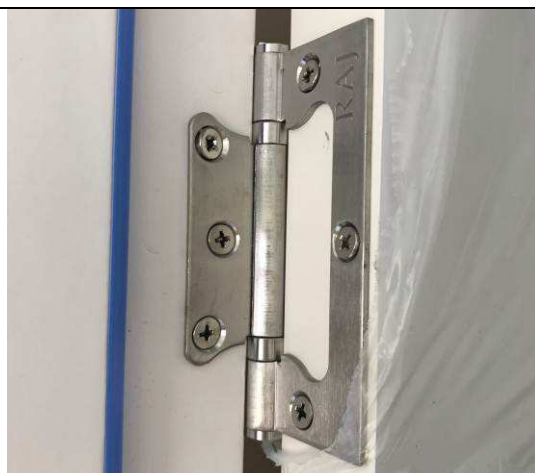
Figura 25C: Dobradiças instaladas.
