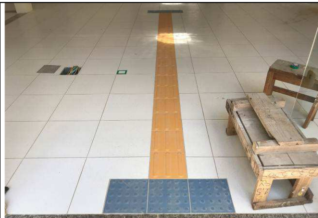
Figura 56C: Piso podotátil - Hall de entrada.
