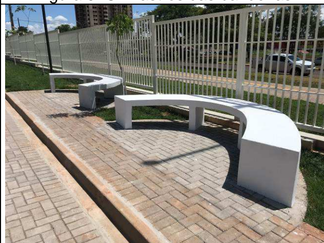
Figura 94C: Bancos de concreto.
