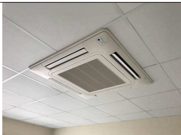
Figura 77C: Acabamento da evaporadoras tipo cassete - PAB Fórum.
