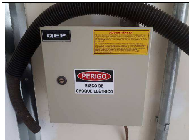
Figura 37E: BEP sala técnica
