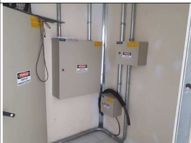
Figura 03E: Infraestrutura interna - eletrodutos
