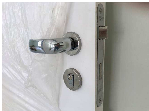
Figura 24C: Fechaduras instaladas.
