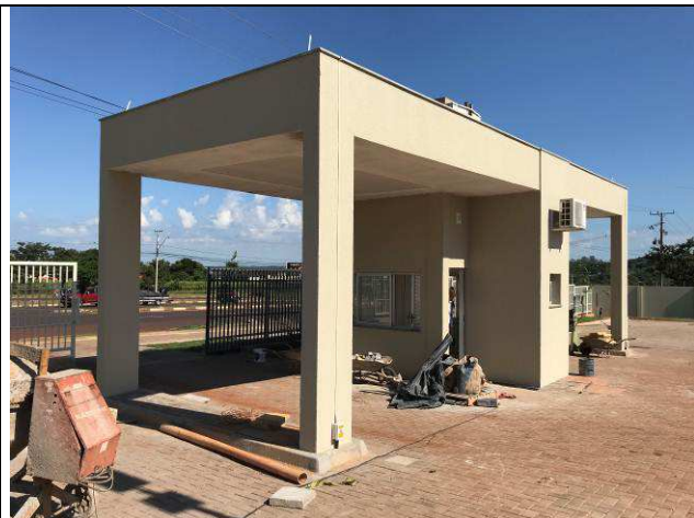
Figura 86C: Textura em paredes externas - Guarita.
