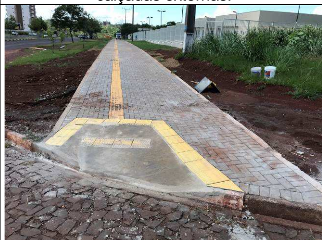
Figura 84C: Rampa de acesso PNE - calçadas externas.
