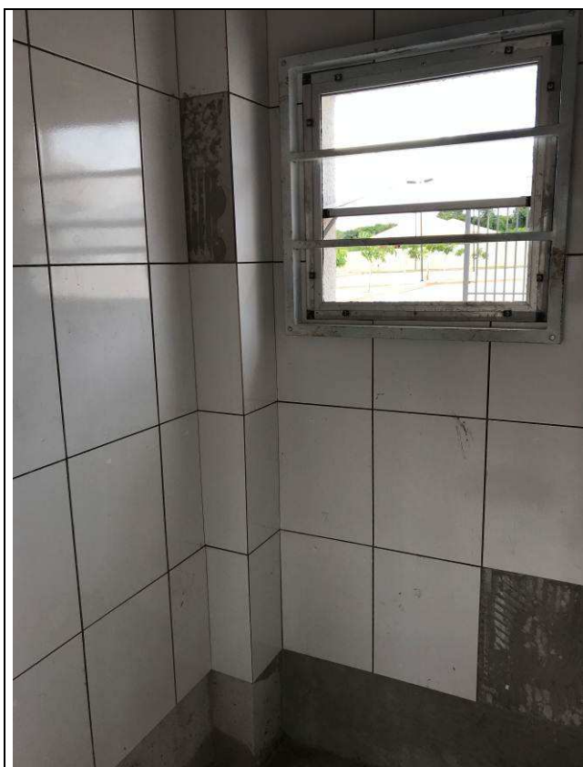
Figura 54C: Instalação de azulejos - Guarita.
