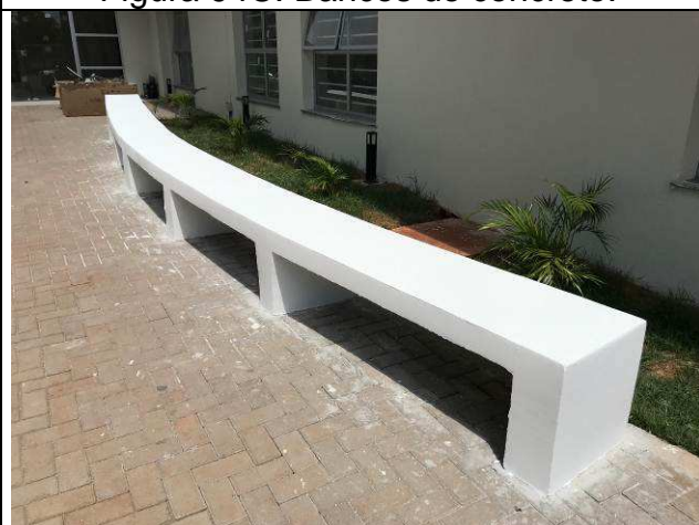
Figura 96C: Bancos de concreto.
