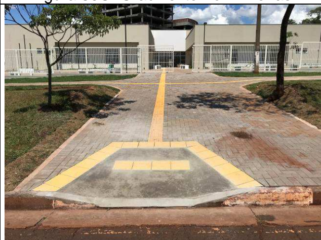
Figura 82C: Rampa de acesso PNE - calçadas externas.
