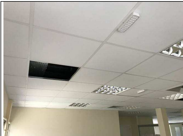
Figura 34C: Forro modular - 1ª Vara.
