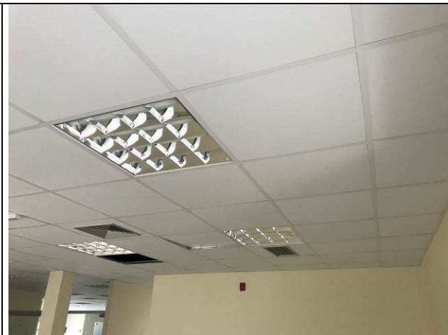
Figura 35C: Forro modular - 1ª Vara.
