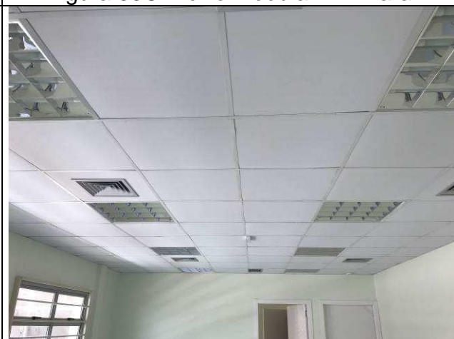
Figura 37C: Forro modular - 1ª Vara.
