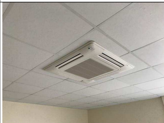
Figura 78C: Acabamento da evaporadoras tipo cassete - PAB Fórum.
