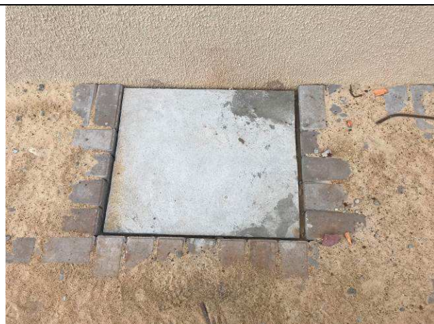
Figura 20C: Tampas das caixas de esgoto.
