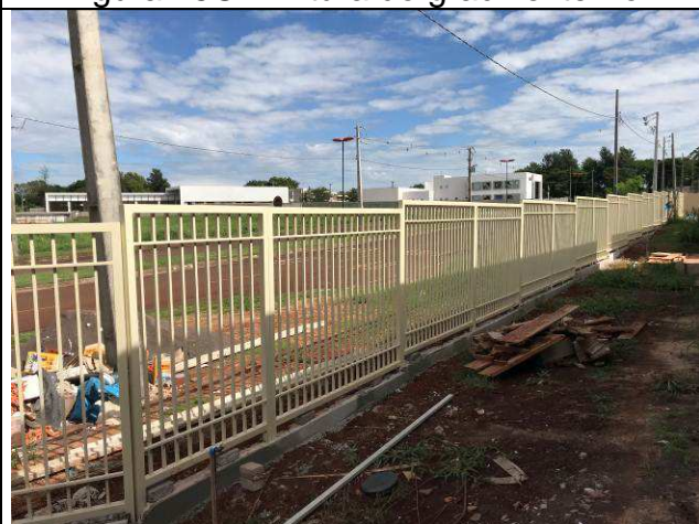
Figura 27C: Pintura do gradil externo.
