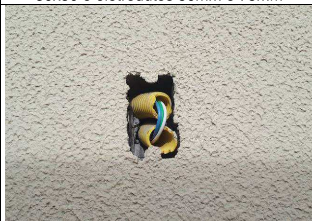
Figura 06E: caixas 2x4" embutir e cabeamento elétrico
