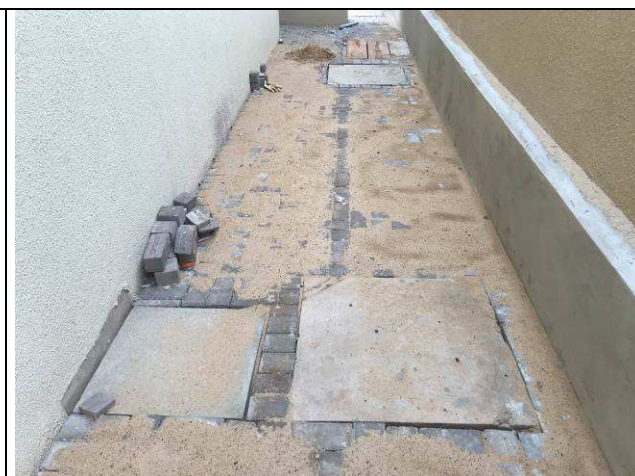
Figura 17C: Tampas das caixas de gordura e de esgoto.
