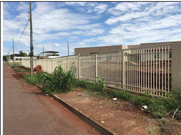
Figura 25C: Pintura do gradil externo.
