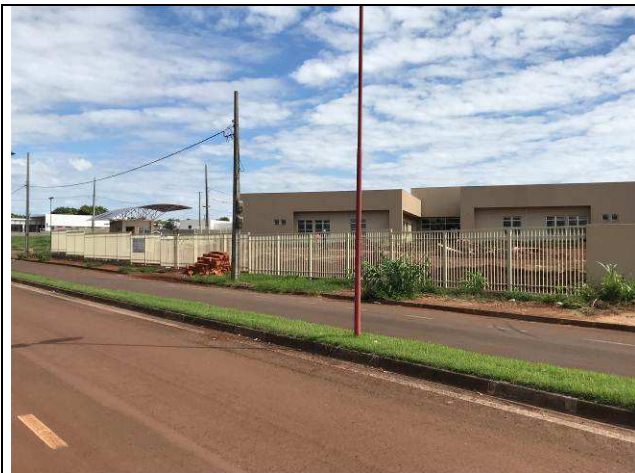
Figura 24C: Pintura do gradil externo.
