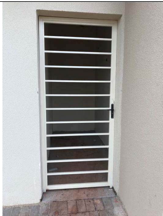
Figura 13C: Porta de grade - entrada da Distribuição.
