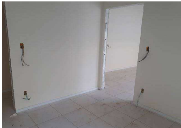
Figura 14E: cabearmento elétrico 2,5mm 2
