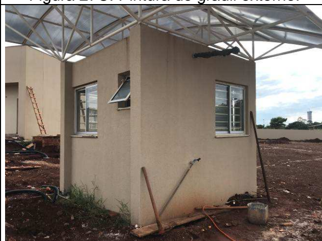
Figura 29C: Pintura externa da Guarita.
