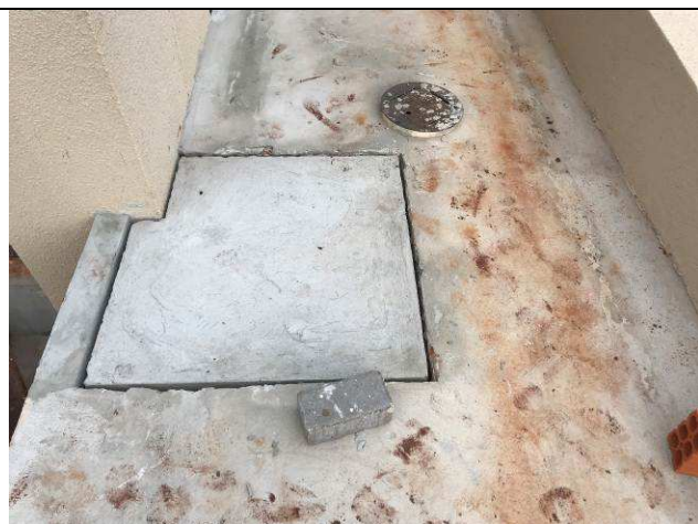
Figura 18C: Tampas das caixas de esgoto.
