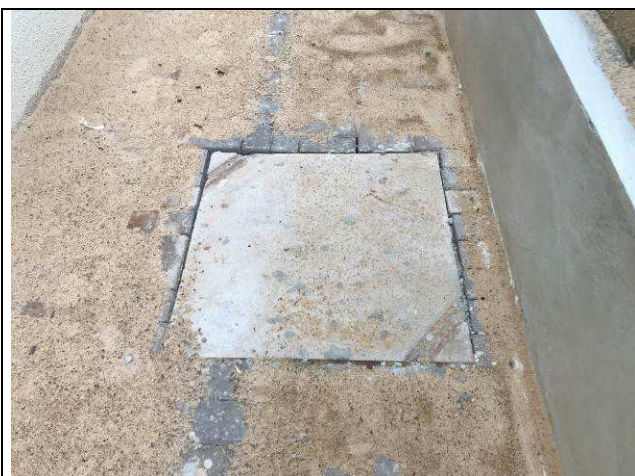
Figura 16C: Tampas das caixas de esgoto.
