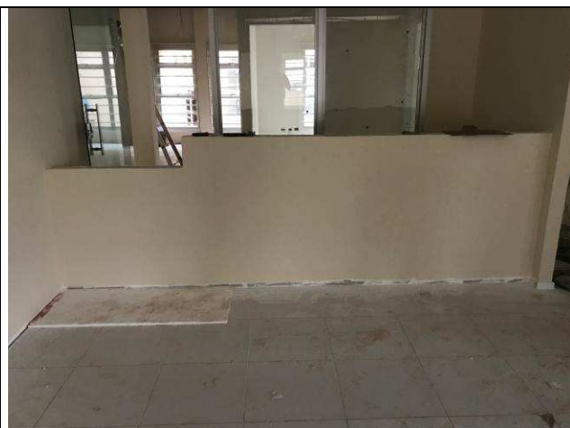
Figura 08C: Parede do balcão de atendimento - 2ª Vara.
