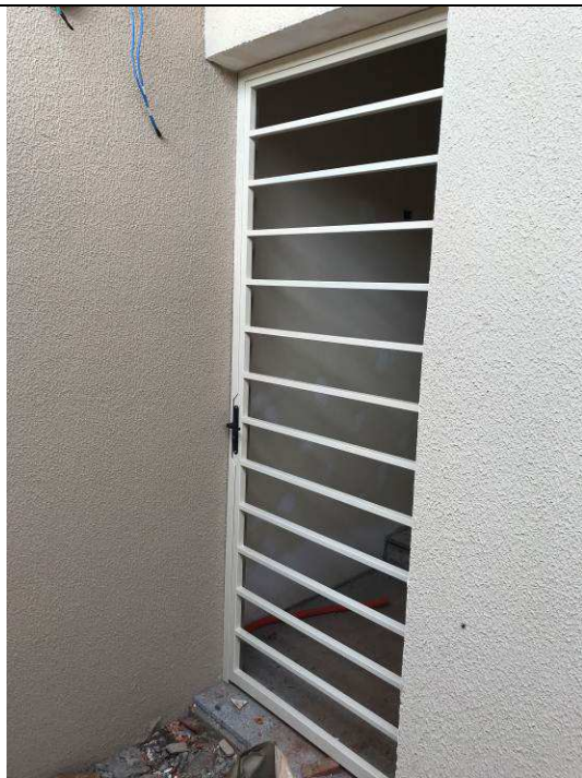
Figura 11C: Porta de grade - entrada da 1ª Vara.
