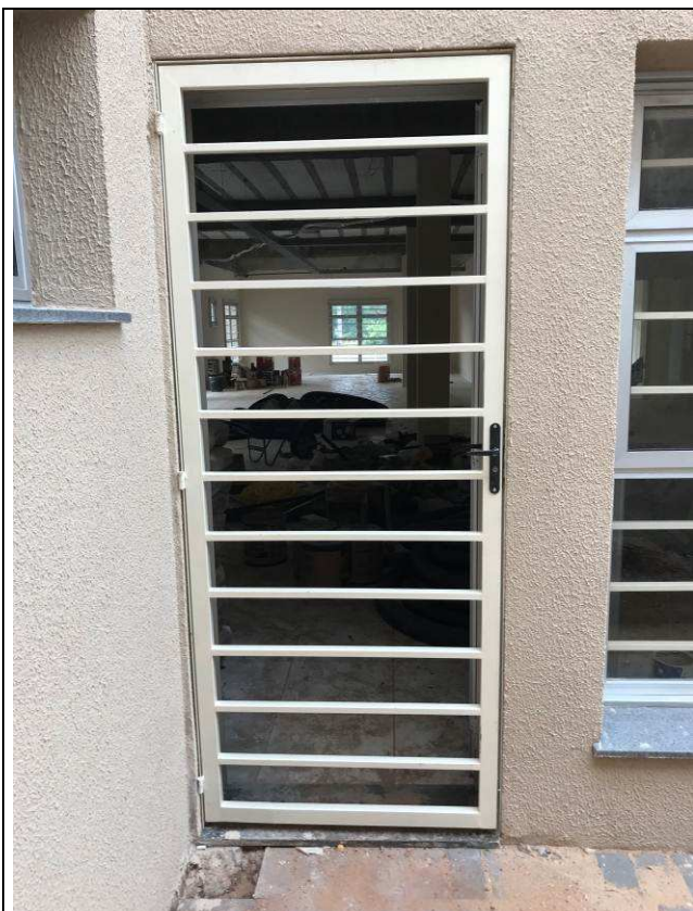
Figura 15C: Porta de grade - entrada lateral do Hall central.
