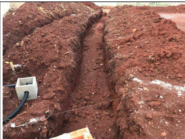
Figura 04C: Escavações estacionamento frontal - tubulações de águas pluviais.
