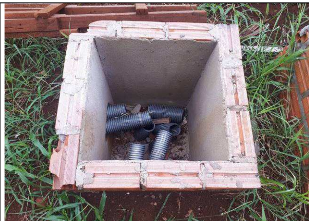
Figura 18E: infraestrutura externa
