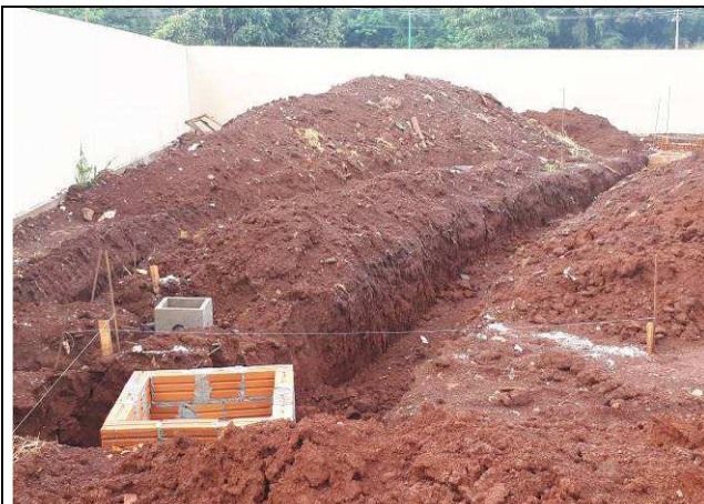
Figura 17E: infraestrutura externa
