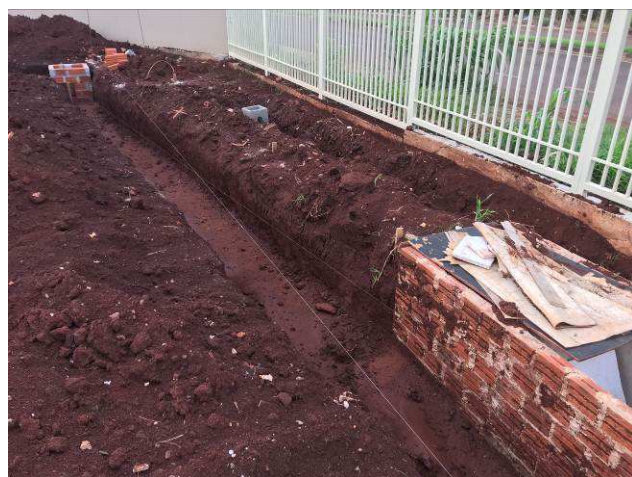
Figura 01C: Escavações estacionamento frontal - tubulações de águas pluviais.
