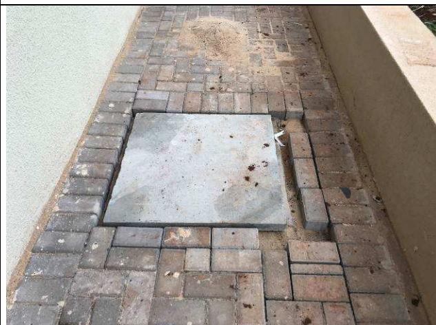
Figura 21C: Tampas das caixas de esgoto.
