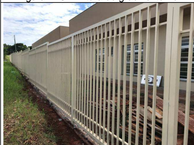
Figura 26C: Pintura do gradil externo.
