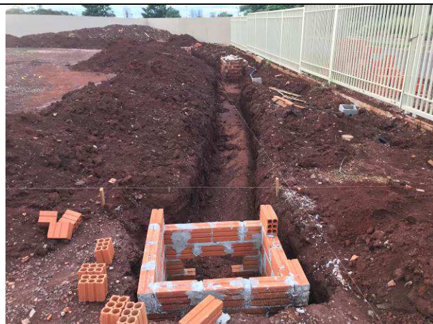
Figura 03C: Escavações estacionamento frontal - tubulações de águas pluviais.
