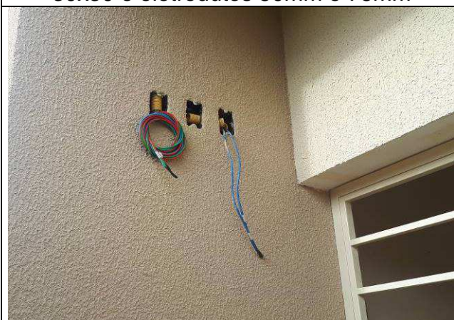
Figura 05E: caixas 2x4" embutir e cabeamento elétrico
