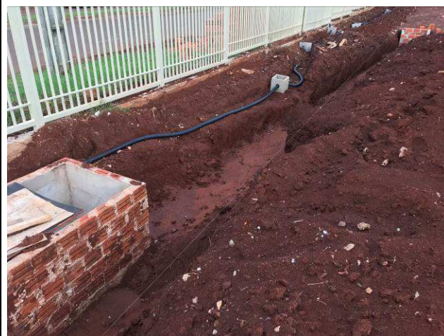
Figura 02C: Escavações estacionamento frontal - tubulações de águas pluviais.
