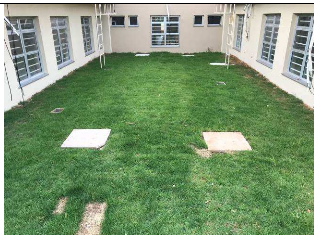
Figura 19C: Tampas das caixas de esgoto.
