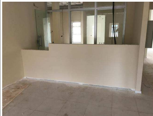
Figura 06C: Parede do balcão de atendimento - 1ª Vara.
