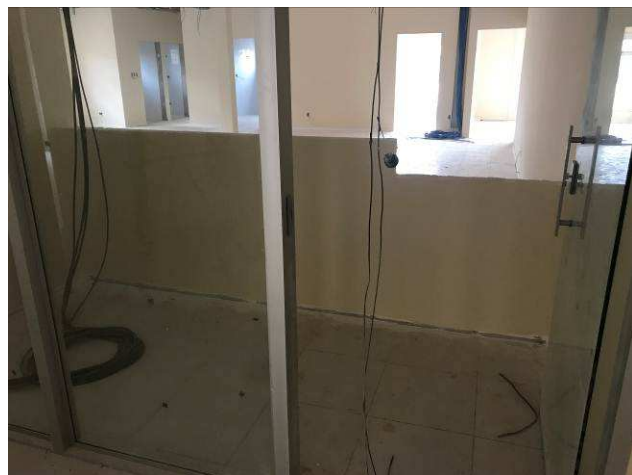
Figura 05C: Parede do balcão de atendimento - 1ª Vara.
