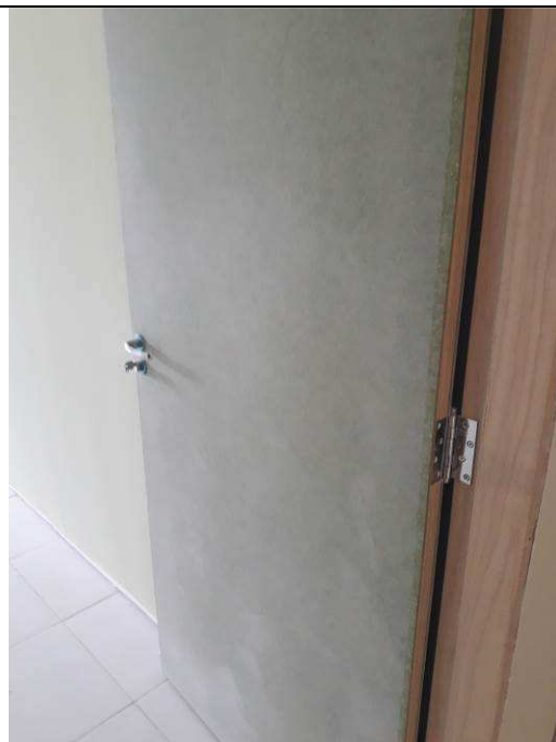
Figura 12C: Porta acústica instalada.
