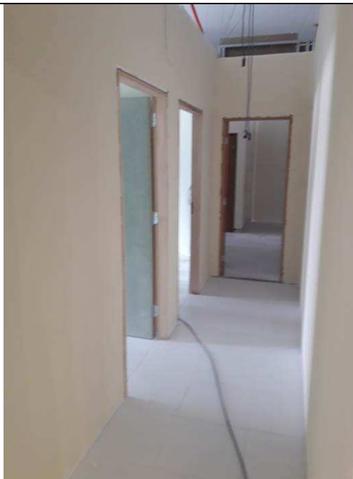
Figura 06C: Divisórias instaladas.
