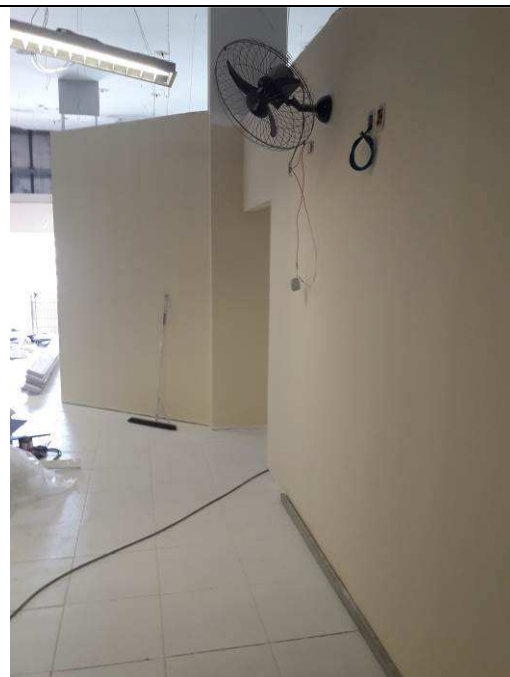
Figura 08C: Divisórias instaladas.
