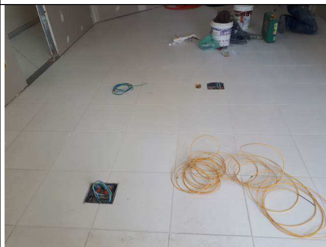
Figura 07E: serviços preliminares - salas de audiências - 6ª VT
