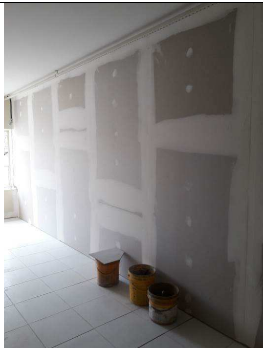
Figura 05C: Divisórias instaladas.
