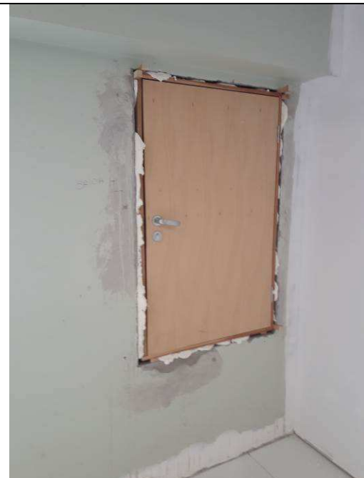
Figura 10C: Vergas, contravergas e requadro realizados.
