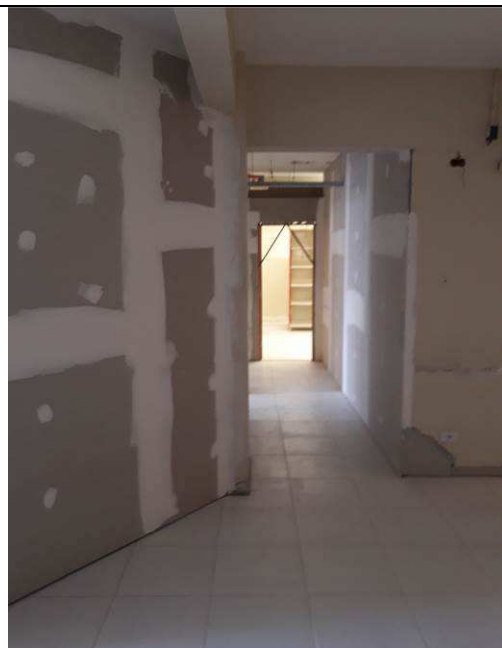
Figura 04C: Piso completamente assentado.
