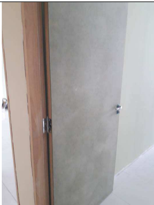
Figura 11C: Porta acústica instalada.
