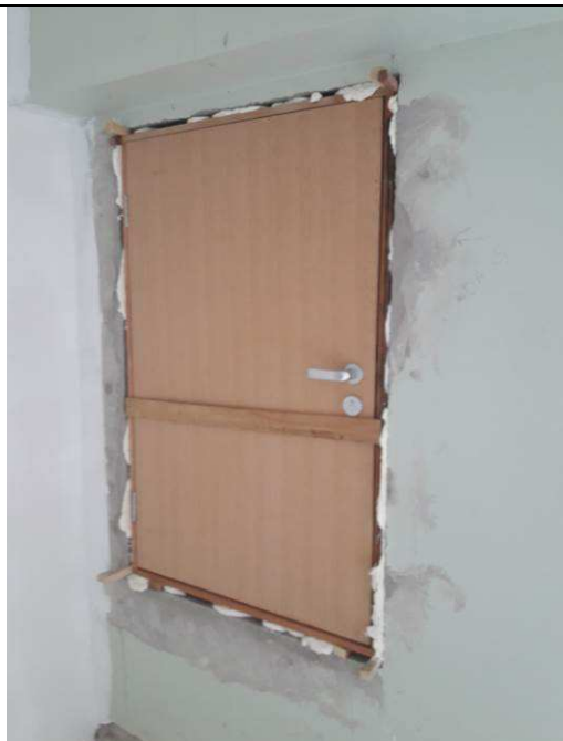
Figura 09C: Vergas, contravergas e requadro realizados.
