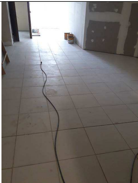
Figura 01C: Piso completamente assentado.
