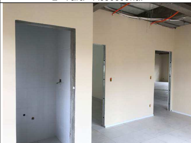
Figura 28C: Paredes de gesso acartonado - 2ª Vara - Gabinete de juiz.
