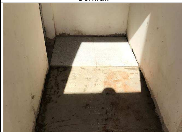
Figura 75C: Piso em granito - Entrada da área de terceirizados.
