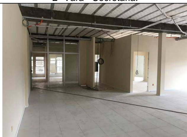
Figura 23C: Paredes de gesso acartonado - 2ª Vara - Secretaria.
