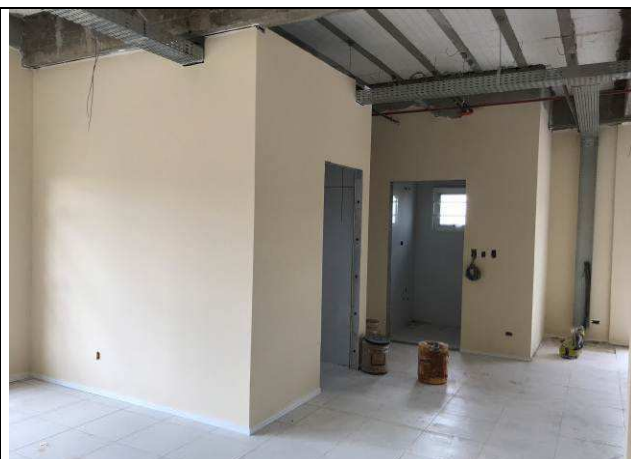
Figura 58C: Paredes de gesso acartonado - Distribuição / Sala dos Oficiais.
