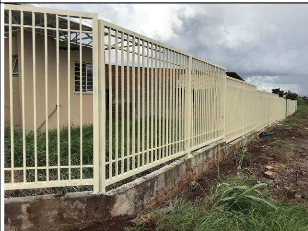
Figura 98C: Pintura no gradil externo.
