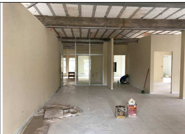
Figura 09C: Paredes de gesso acartonado - 1ª Vara - Secretaria.
