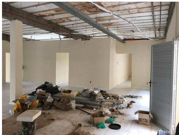
Figura 54C: Paredes de gesso acartonado - Circulação Sala de Perícias e OAB.
