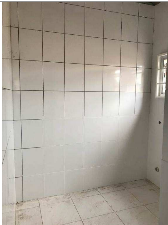
Figura 50C: Paredes de gesso acartonado - Área de Serviço.
