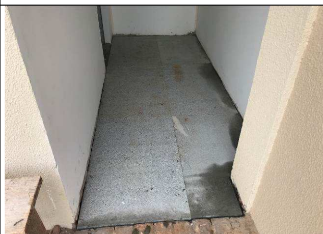
Figura 76C: Piso em granito - Entrada Distribuição / Sala dos Oficiais.
