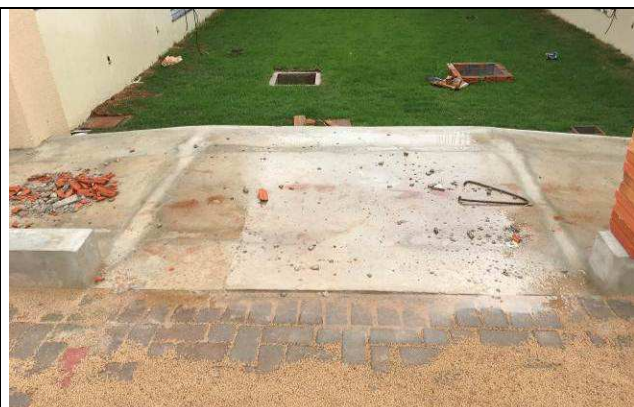
Figura 88C: Rampa de acesso em concreto - estacionamento dos fundos.
