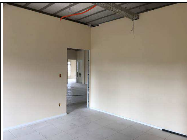
Figura 20C: Paredes de gesso acartonado - 2ª Vara - Gabinete de juiz.
