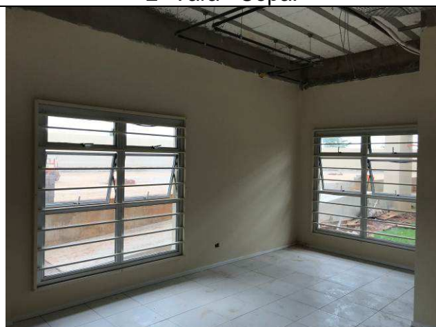
Figura 27C: Paredes de gesso acartonado - 2ª Vara - Gabinete de juiz.
