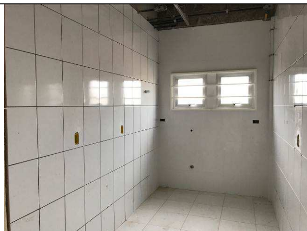
Figura 25C: Paredes de gesso acartonado - 2ª Vara - Copa.
