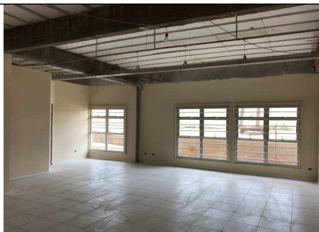
Figura 44C: Paredes de gesso acartonado - Auditório.
