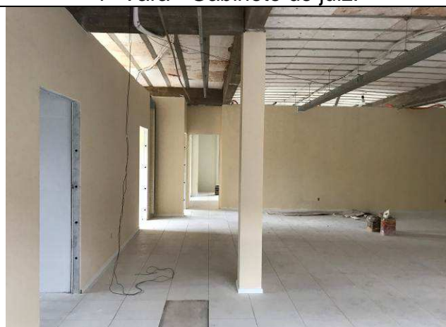
Figura 07C: Paredes de gesso acartonado - 1ª Vara - Secretaria.
