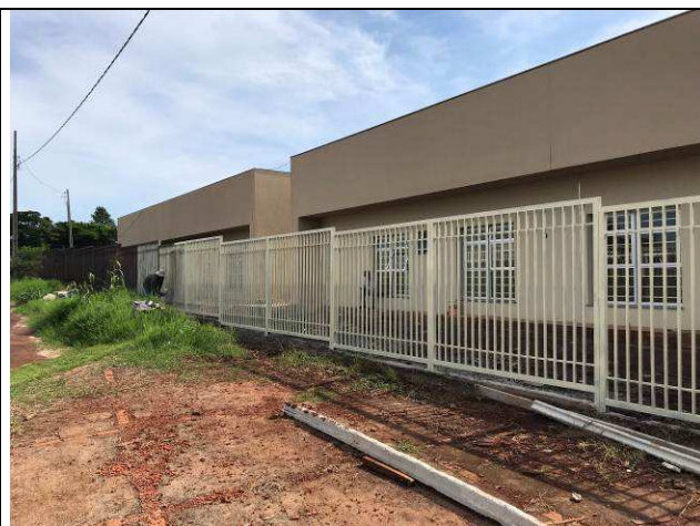
Figura 100C: Pintura no gradil externo.
