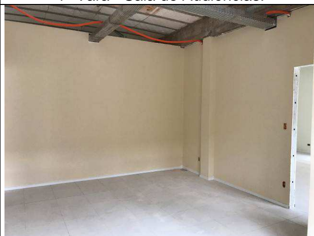
Figura 06C: Paredes de gesso acartonado - 1ª Vara - Gabinete de juiz.
