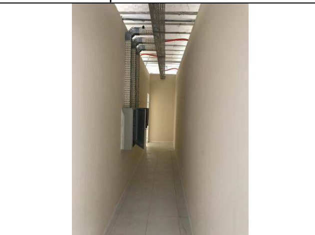
Figura 48C: Paredes de gesso acartonado - Circulação Área de Terceirizados.
