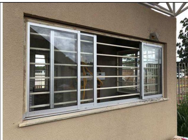
Figura 65C: Grates de proteção das janelas - Guarita.
