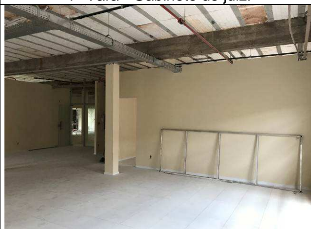
Figura 08C: Paredes de gesso acartonado - 1ª Vara - Secretaria.
