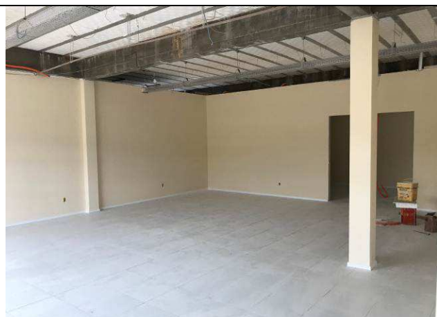
Figura 43C: Paredes de gesso acartonado - Auditório.
