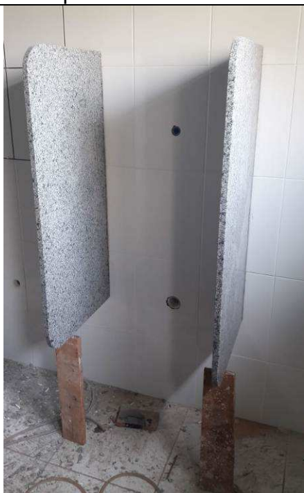
Figura 63C: Divisórias dos mictórios - banheiro público masculino.
