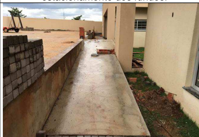
Figura 90C: Rampa de acesso em concreto - estacionamento dos fundos.
