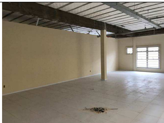
Figura 37C: Paredes de gesso acartonado - Arquivo.
