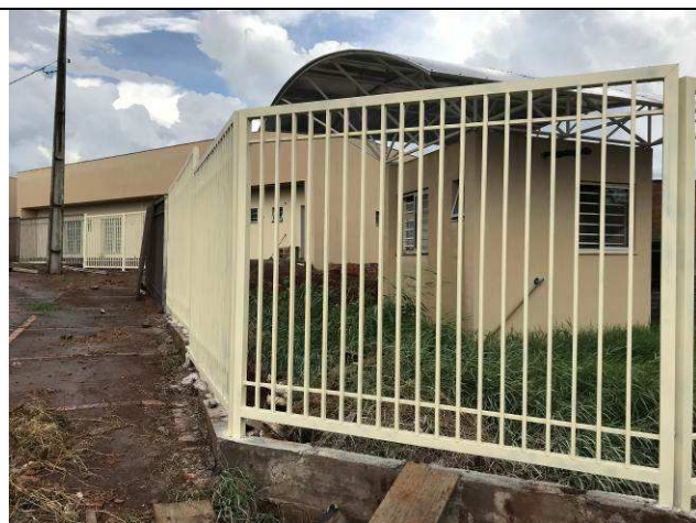
Figura 99C: Pintura no gradil externo.
