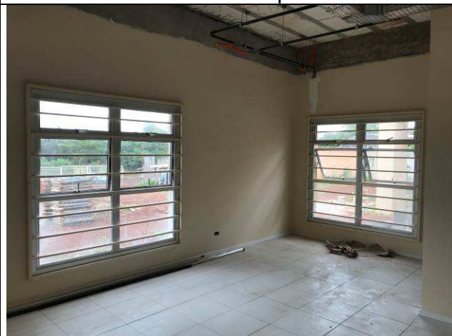
Figura 13C: Paredes de gesso acartonado - 1ª Vara - Gabinete de juiz.
