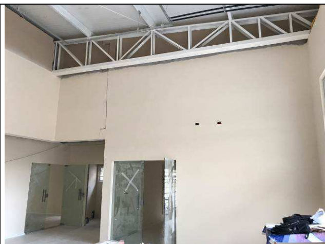
Figura 32C: Paredes de gesso acartonado - Hall Central.
