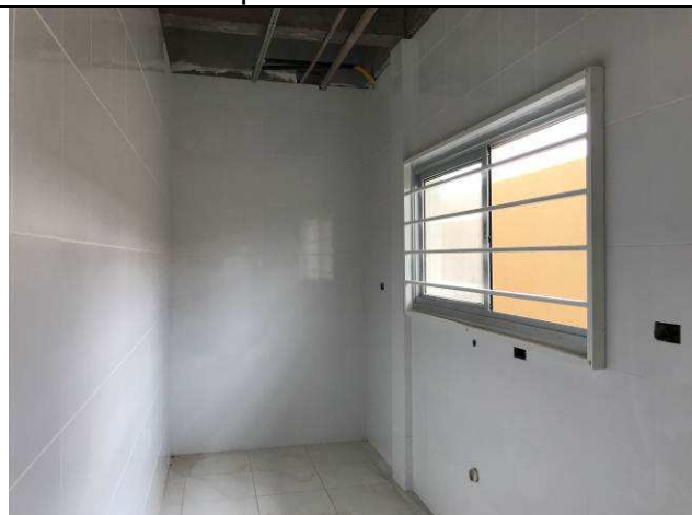
Figura 47C: Paredes de gesso acartonado - Cozinha Terceirizados.
