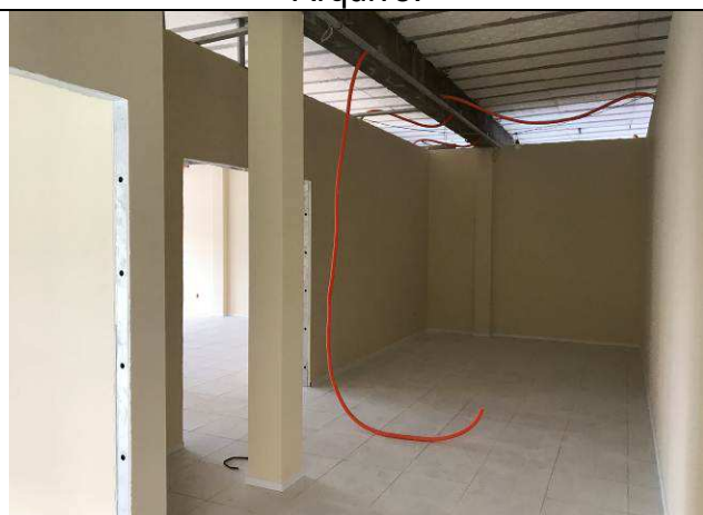
Figura 39C: Paredes de gesso acartonado - Espera Auditório.
