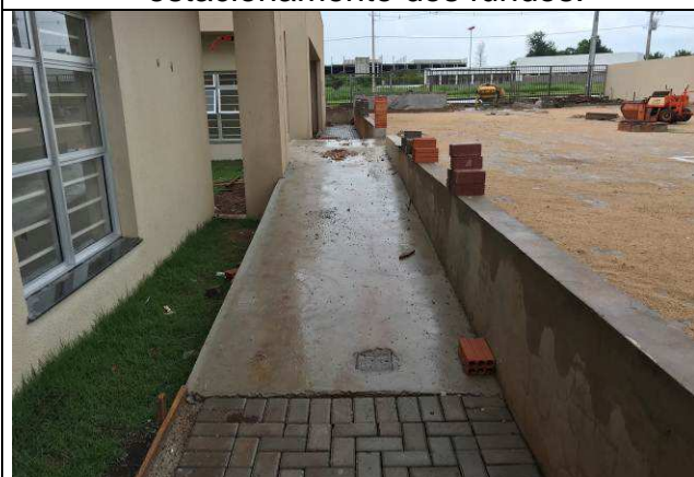
Figura 89C: Rampa de acesso em concreto - estacionamento dos fundos.
