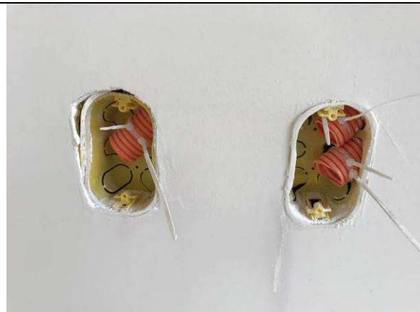
Figura 20E: infraestrutura interna - caixas 2x4" e eletrodutos
