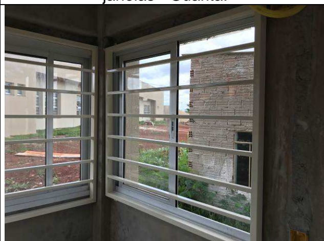
Figura 68C: Grates de proteção das janelas - Guarita.
