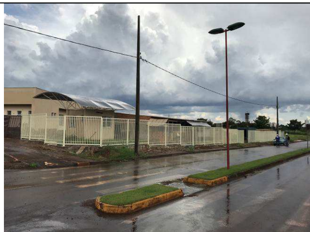
Figura 97C: Pintura no gradil externo.
