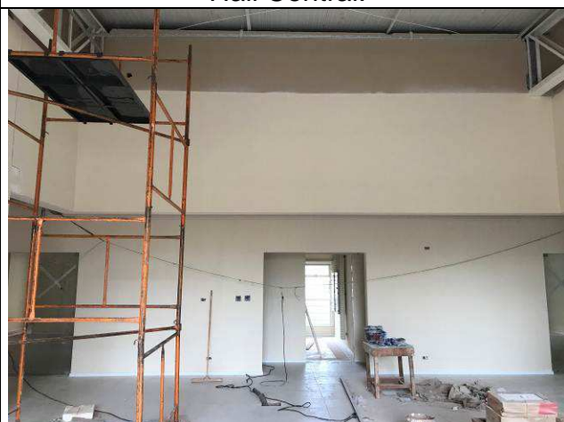
Figura 33C: Paredes de gesso acartonado - Hall Central.
