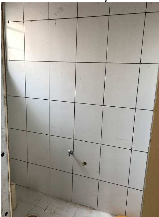
Figura 52C: Paredes de gesso acartonado - Banheiro do Apoio Administrativo do Hall.
