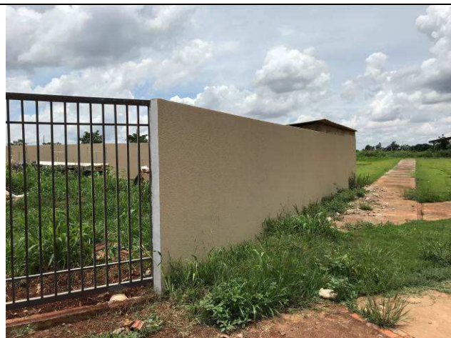
Figura 93C: Textura aplicada no muro da divisa.
