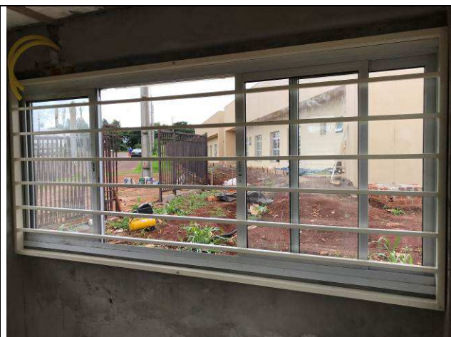
Figura 66C: Grates de proteção das janelas - Guarita.
