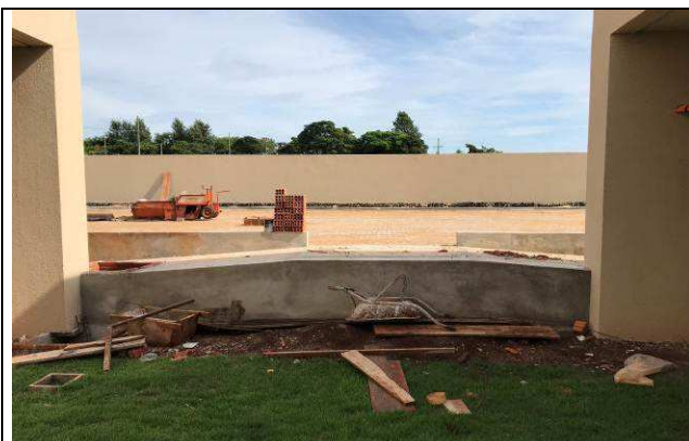
Figura 87C: Rampa de acesso em concreto - estacionamento dos fundos.
