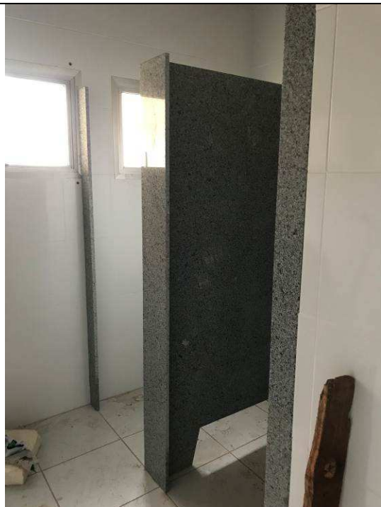
Figura 61C: Divisórias sanitárias - banheiro público masculino.
