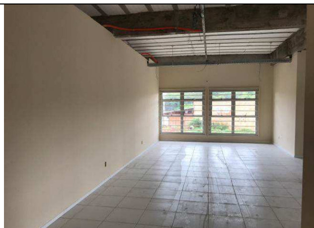
Figura 57C: Paredes de gesso acartonado - Distribuição / Sala dos Oficiais.
