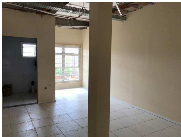
Figura 56C: Paredes de gesso acartonado - Circulação Sala de Perícias e OAB.
