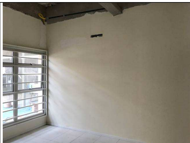
Figura 14C: Paredes de gesso acartonado - 1ª Vara - Conciliação.
