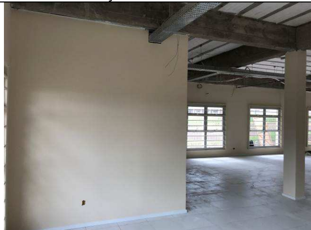
Figura 59C: Paredes de gesso acartonado - Distribuição / Sala dos Oficiais.
