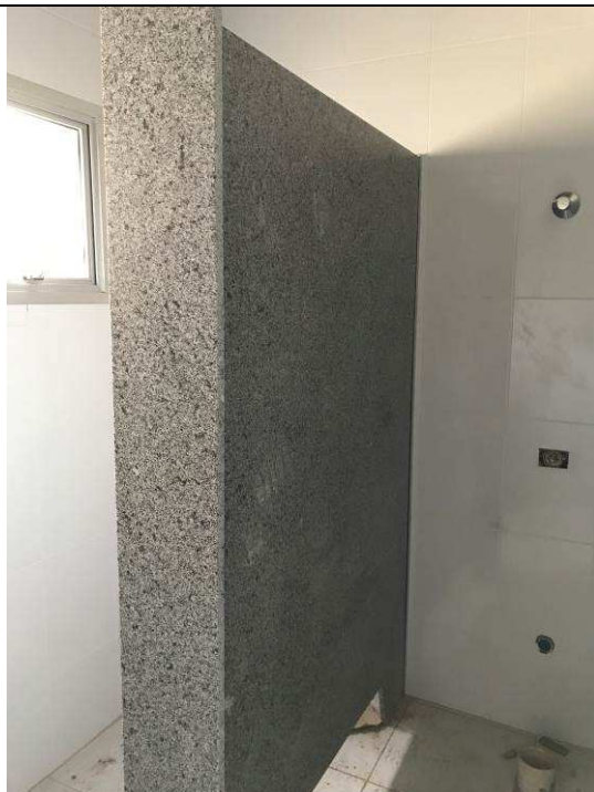
Figura 62C: Divisórias sanitárias - banheiro público masculino.
