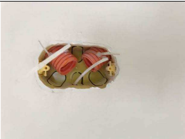
Figura 21E: infraestrutura interna - caixas 2x4" e eletrodutos
