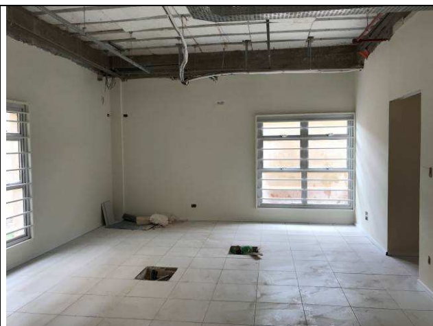
Figura 04C: Paredes de gesso acartonado - 1ª Vara - Sala de Audiências.
