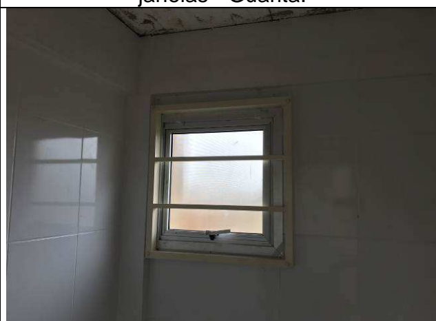
Figura 70C: Grates de proteção das janelas - Guarita.
