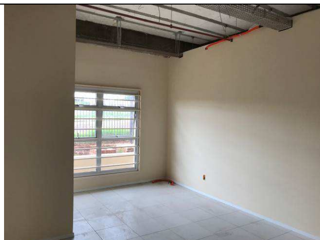
Figura 19C: Paredes de gesso acartonado - 2ª Vara - Gabinete de juiz.
