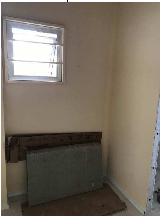
Figura 51C: Paredes de gesso acartonado - Apoio Administrativo do Hall Central.
