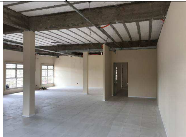
Figura 60C: Paredes de gesso acartonado - Distribuição / Sala dos Oficiais.
