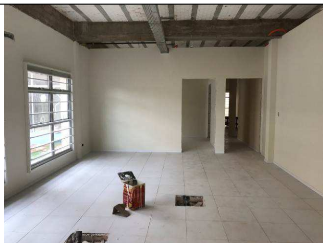
Figura 13C: Paredes de gesso acartonado - 1ª Vara - Sala de Audiências.
