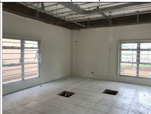
Figura 18C: Paredes de gesso acartonado - 2ª Vara - Sala de Audiências.
