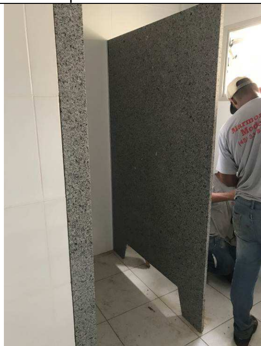
Figura 64C: Divisórias sanitárias - banheiro público feminino.
