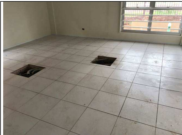
Figura 71C: Pisos cerâmicos - Sala de Audiências - 2ª Vara.
