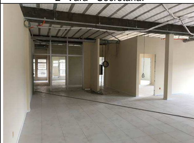
Figura 24C: Paredes de gesso acartonado - 2ª Vara - Secretaria.
