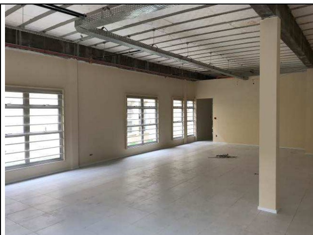
Figura 38C: Paredes de gesso acartonado - Arquivo.
