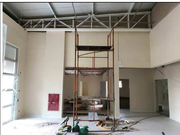
Figura 31C: Paredes de gesso acartonado - Hall Central.
