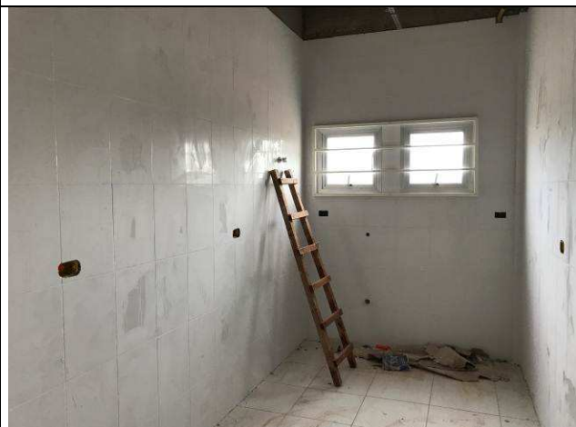
Figura 11C: Paredes de gesso acartonado - 1ª Vara - Copa.
