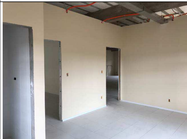
Figura 14C: Paredes de gesso acartonado - 1ª Vara - Gabinete de juiz.
