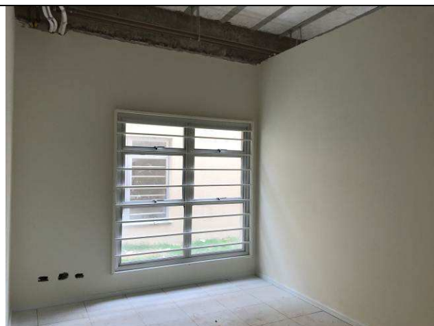
Figura 03C: Paredes de gesso acartonado - 1ª Vara - Conciliação.
