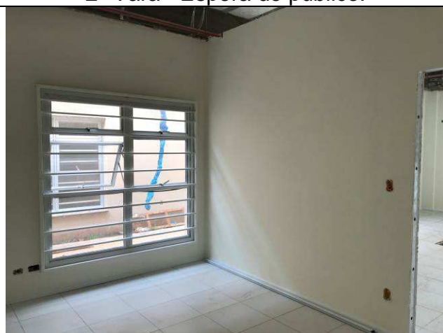
Figura 17C: Paredes de gesso acartonado - 2ª Vara - Conciliação.
