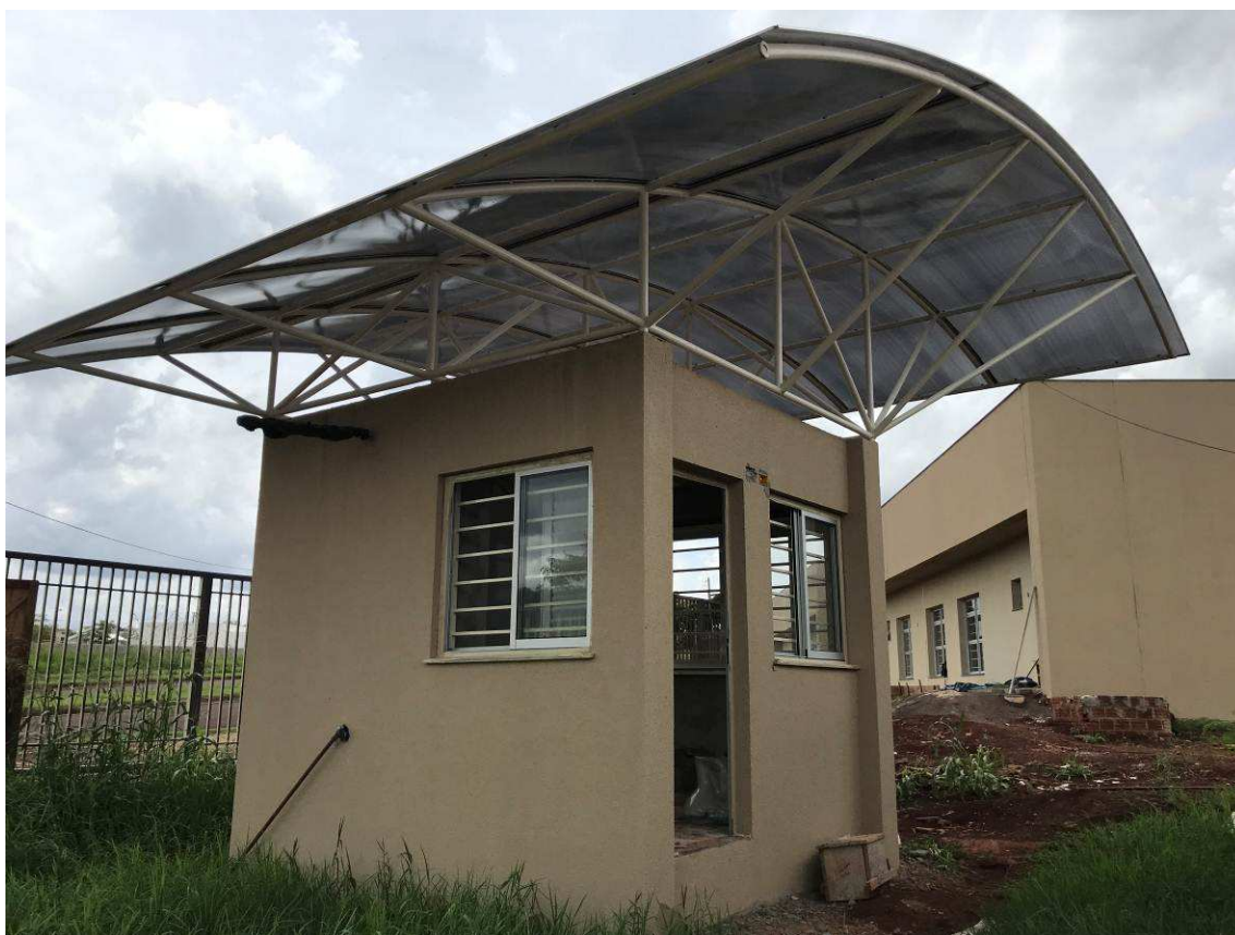
Figura 2 – Guarita - Vista externa.
