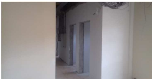
Figura 53C: Aplicação de massa corrida - bloco da esquerda
