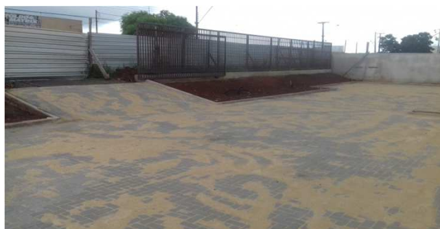
Figura 40C: Paver e meio-fio, instalados no estacionamento esquerdo
