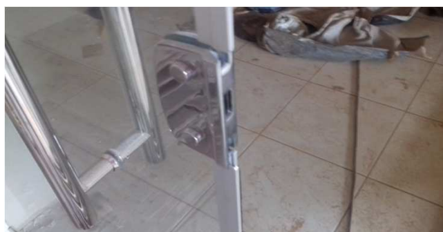
Figura 06C: Detalhe de fechadura
