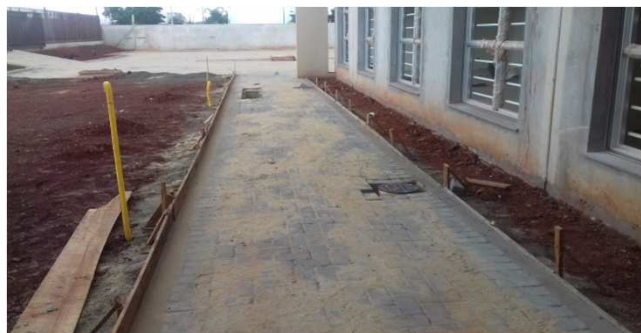
Figura 48C: Calçada no acesso entre estacionamento e fórum - bloco da esquerda
