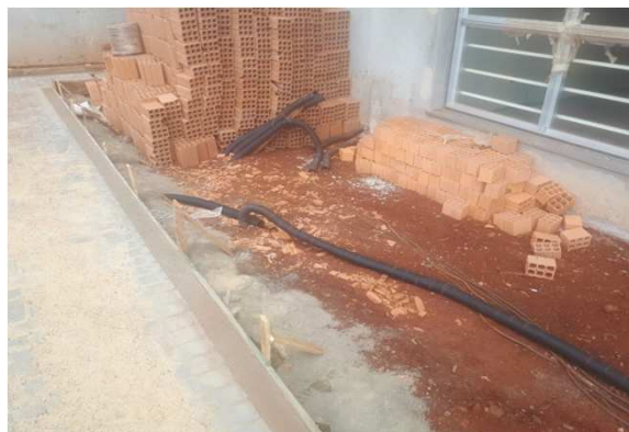
Figura 10E: malha de aterramento e caixas de inspeção
