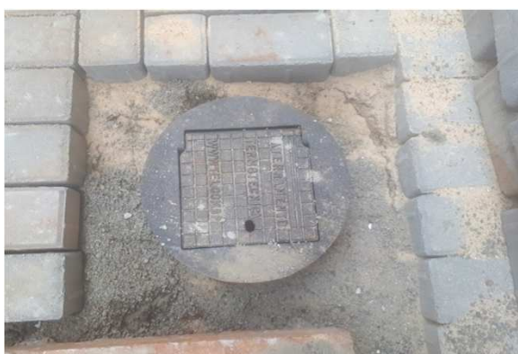
Figura 13E: malha de aterramento e caixas de inspeção
