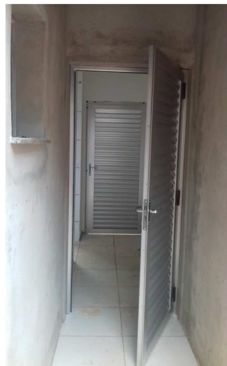
Figura 13: Portas de acesso ao fosso de luz e acesso externo - bloco direito
