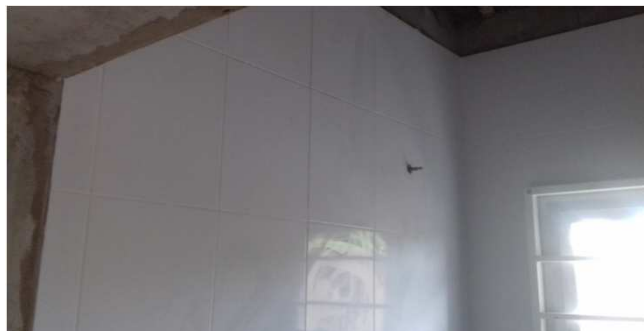
Figura 28C: Azulejos instalados em vestiário (bloco da direita)
