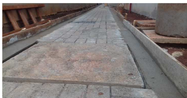
Figura 51C: Detalhe de vigota de travamento da calçada
