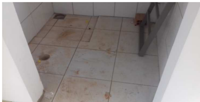
Figura 33C: Piso instalado em sanitário
