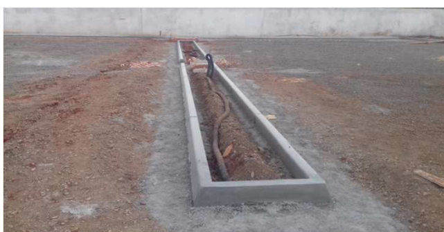
Figura 44C: Meio-fio instalado no bloco da direita
