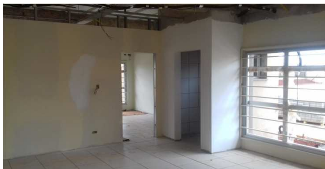
Figura 54C: Aplicação de massa corrida - bloco da esquerda
