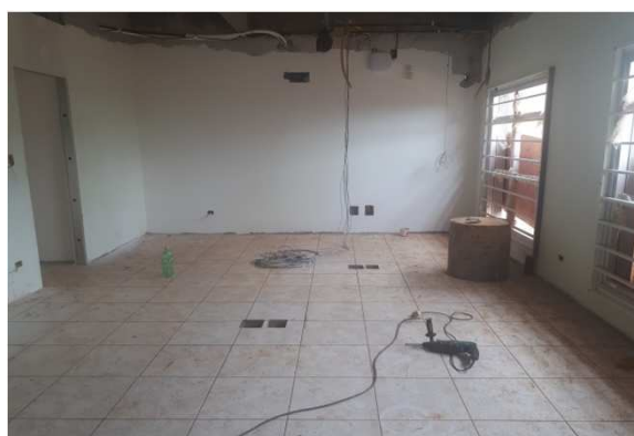
Figura 06E: infraestrutura interna - salas de audiências
