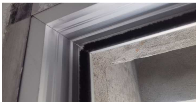
Figura 16: Detalhe do caixilho de porta de alumínio
