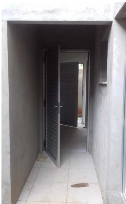
Figura 14: Portas de acesso ao fosso de luz e acesso externo - bloco esquerdo
