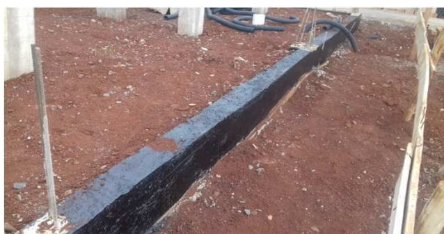
Figura 02C: Vigas baldrame concretadas e já deformadas - Reservatório de incêndio
