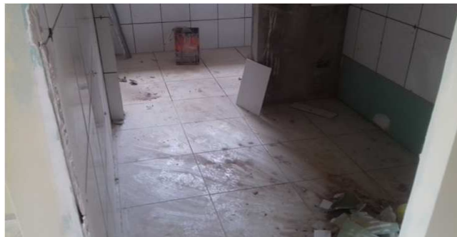
Figura 34C: Piso instalado em sanitário
