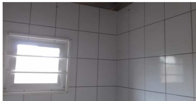
Figura 18C: Gradil 60x60, instalado em sanitário público
