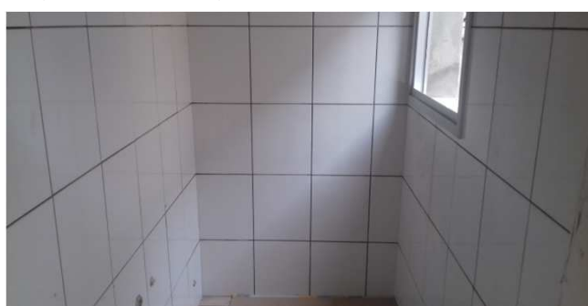
Figura 30C: Azulejos instalados em sanitário da sala múltiplo uso
