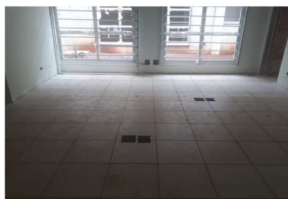
Figura 20E: infraestrutura sala de audiências
