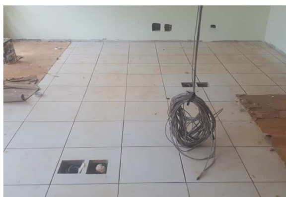
Figura 19E: infraestrutura sala de audiências
