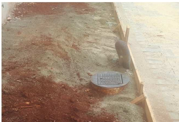
Figura 09E: malha de aterramento e caixas de inspeção
