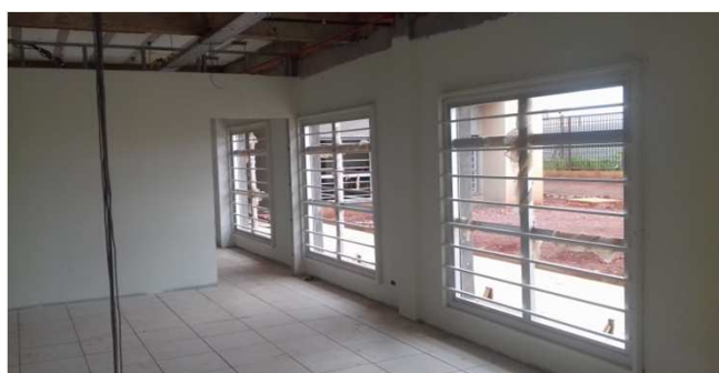
Figura 23C: Gradil 180x180, sendo instalado em gabinete (bloco da esquerda)
