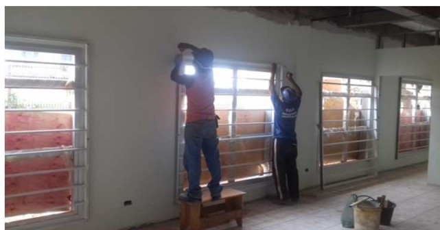
Figura 22C: Gradil 180x180, sendo instalado em sala de audiência (bloco da direita)
