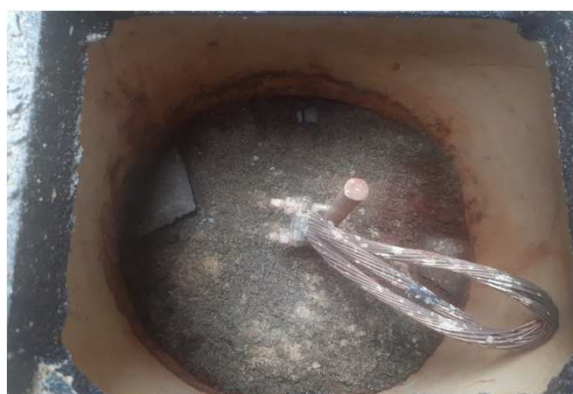
Figura 12E: malha de aterramento e caixas de inspeção
