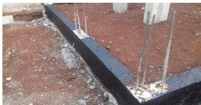
Figura 25C: Pintura impermeabilizante em baldrame - reservatório de incêndio
