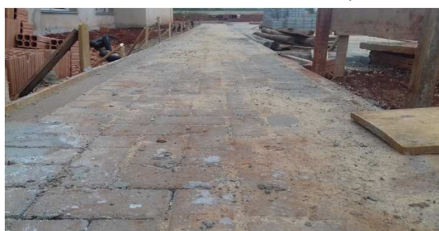
Figura 50C: Detalhe da calçada - lateral esquerda
