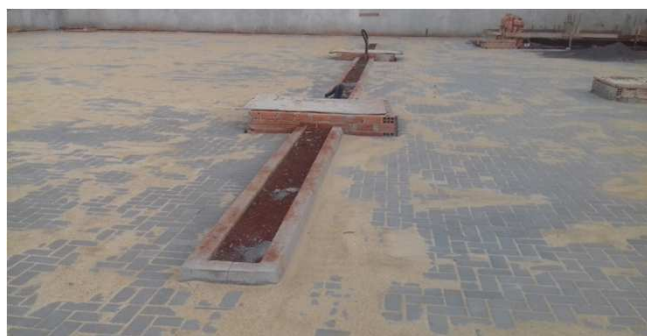
Figura 37C: Paver instalado no estacionamento esquerdo
