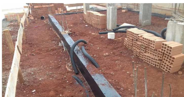
Figura 26C: Pintura impermeabilizante em baldrame - reservatório de incêndio
