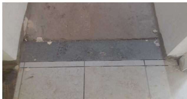
Figura 36C: Soleira instalada em porta de acesso aos fundos - bloco da direita
