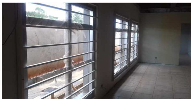
Figura 21C: Gradil 180x180, instalado no bloco da esquerda
