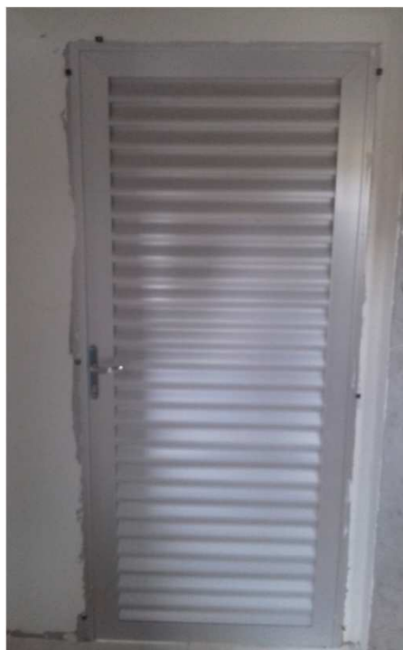
Figura 12: Porta de acesso externo - bloco direito
