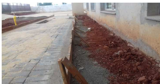
Figura 52C: Detalhe de vigota de travamento da calçada
