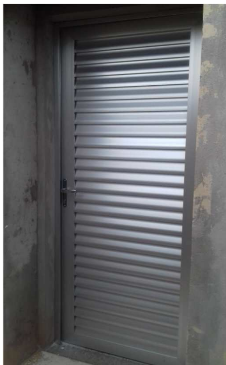
Figura 11: Porta de acesso ao fosso de luz - bloco esquerdo
