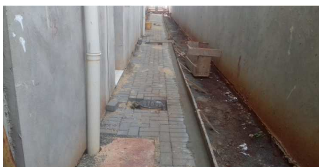
Figura 49C: Calçada executada nos fundos da edificação
