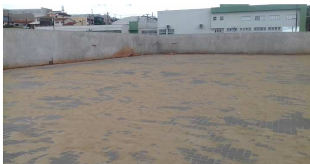
Figura 38C: Paver instalado no estacionamento esquerdo
