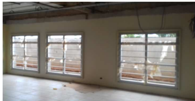
Figura 20C: Gradil 180x180, instalado no bloco da esquerda
