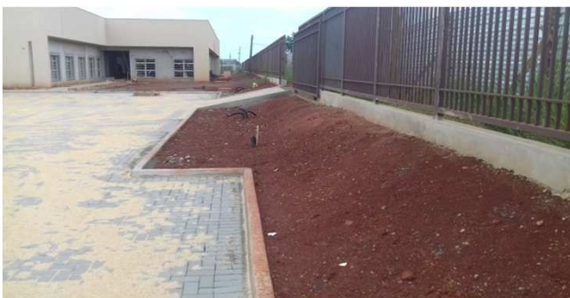
Figura 46C: Meio-fio instalado no bloco da esquerda
