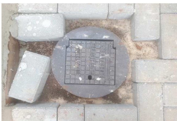
Figura 11E: malha de aterramento e caixas de inspeção
