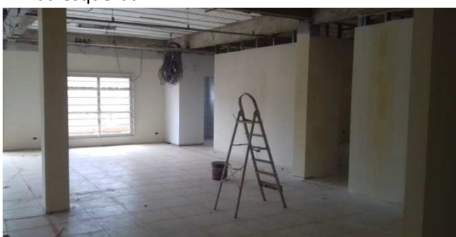
Figura 55C: Aplicação de massa corrida - bloco da esquerda
