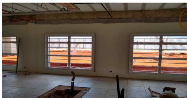
Figura 24C: Gradil 180x180, sendo instalado em sala de audiência (bloco da esquerda)
