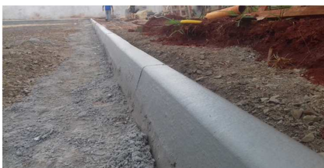
Figura 43C: Meio-fio em detalhe
