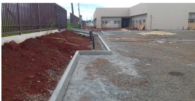
Figura 45C: Meio-fio instalado no bloco da direita
