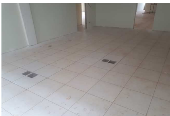
Figura 05E: infraestrutura interna - salas de audiências
