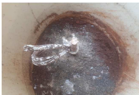
Figura 14E: malha de aterramento e caixas de inspeção
