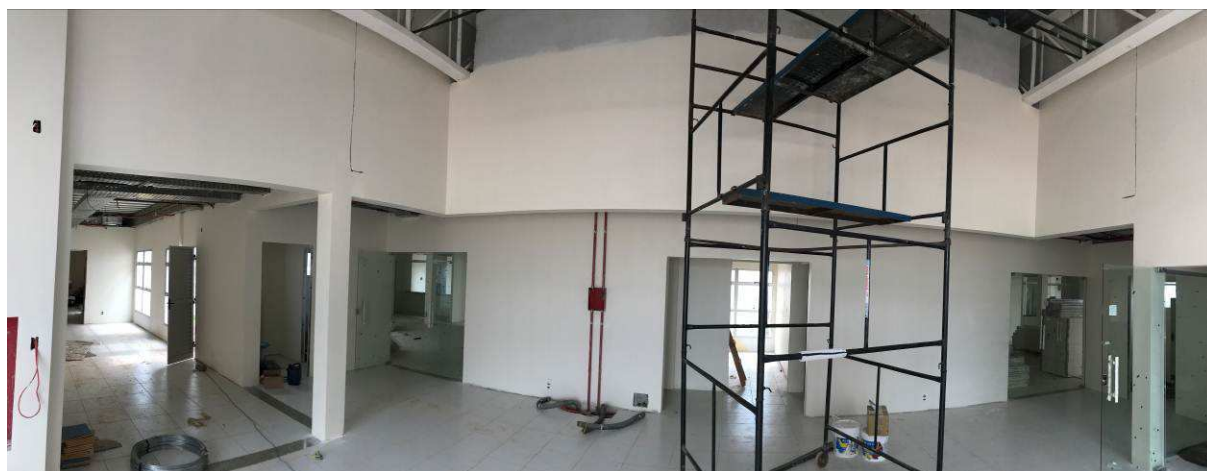
Figura 7 – Prédio do Fórum – Hall de entrada.
