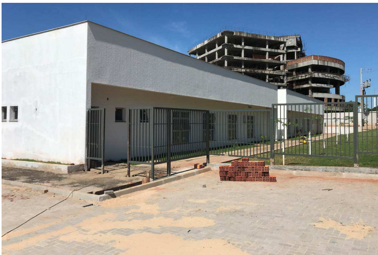
Figura 2 – Prédio do Fórum – vista externa.
