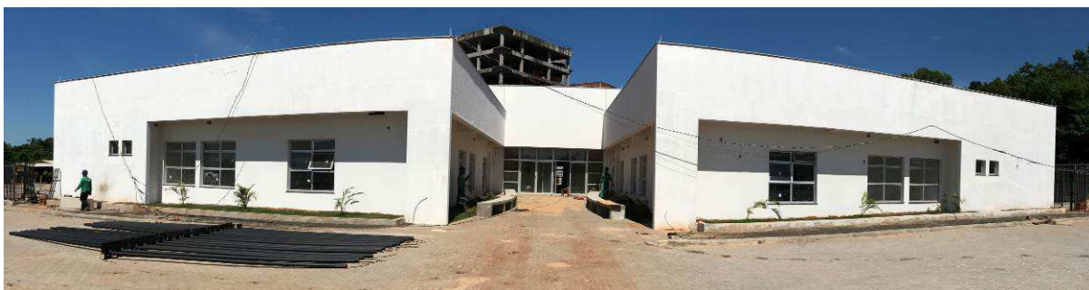
Figura 1 – Prédio do Fórum – vista externa.
