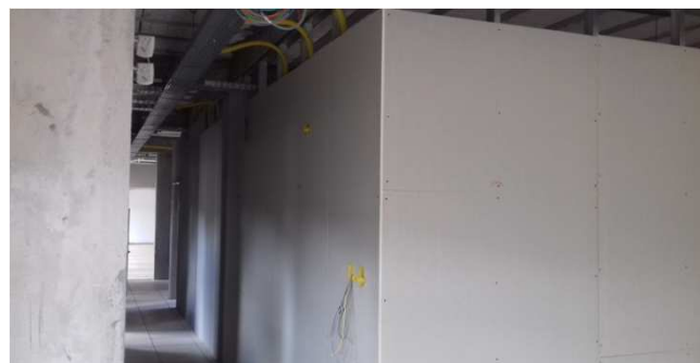
Figura 10C: Paredes de gesso acartonado simples - gabinete do juiz auxiliar
