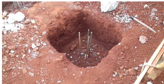
Figura 06C: Estaca já concretada - reservatório de incêndio
