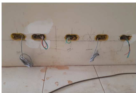
Figura 04E: infraestrutura interna - caixas drywall e eletrodutos (lado esquerdo)
