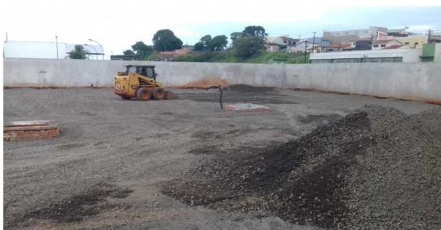
Figura 52C: Macadame hidráulico sendo espalhado no estacionamento da esquerda
