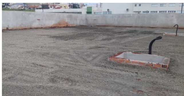
Figura 53C: Macadame hidráulico após total espalhamento - estacionamento da esquerda
