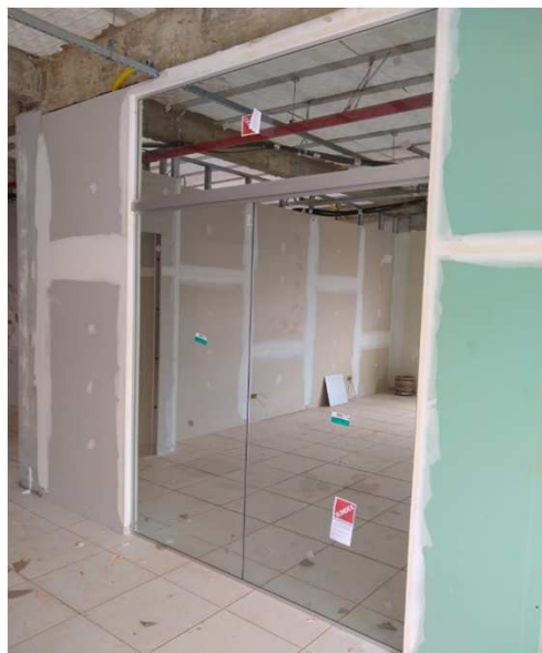
Figura 23C: Painel de vidro fixo, instalado na sala de assistentes (bloco da esquerda)
