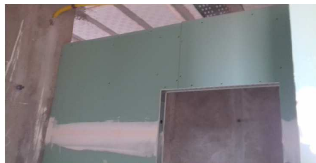
Figura 17C: Parede de gesso acartonado verde - sanitário público
