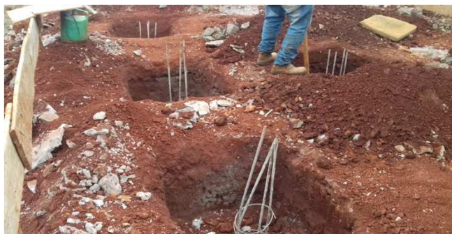
Figura 07C: Estacas concretadas - reservatório de incêndio
