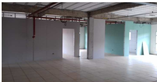
Figura 18C: Parede de gesso acartonado verde - copa do bloco esquerdo
