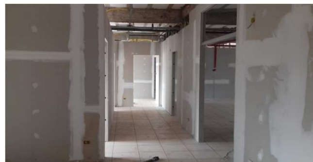
Figura 15C: Paredes de gesso acartonado simples (a direita) e dupla (a esquerda)
