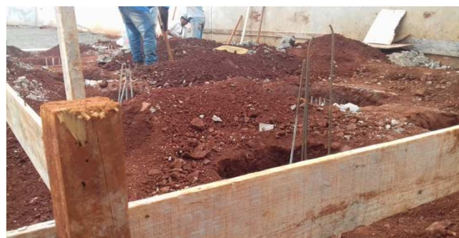
Figura 08C: Estacas concretadas - reservatório de incêndio
