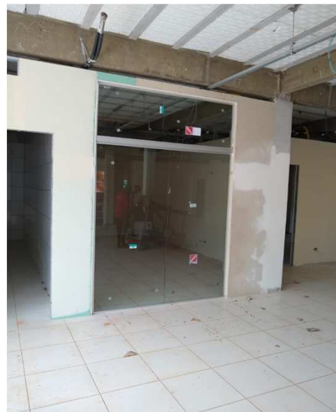
Figura 22C: Painel de vidro fixo, instalado na sala de assistentes (bloco da direita)
