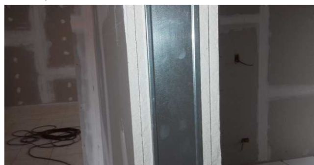
Figura 14C: Dupla placa de gesso acartonado (audiência - bloco esquerdo)
