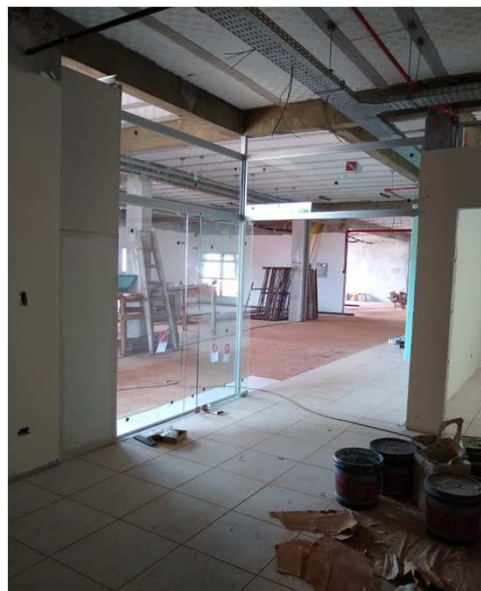
Figura 20C: Painel de vidro fixo (esquerda, na imagem) e de abrir (centro da imagem), instalados na entrada do bloco da direita
