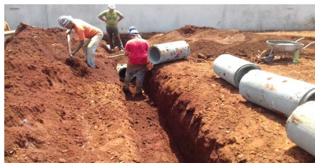
Figura 03C: Fechamento de vala em local de boca-de-lobo
