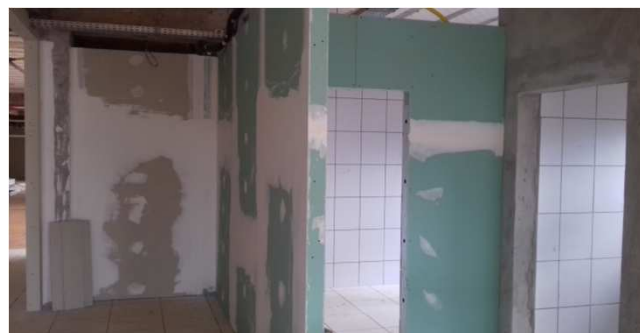
Figura 16C: Parede de gesso acartonado verde - Copa da distribuição/oficiais
