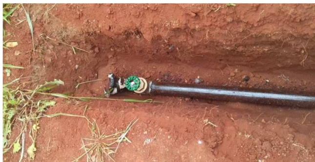
Figura 51C: Ponto de fim da tubulação de incêndio - onde ficará o hidrante da calçada
