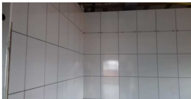
Figura 34C: Azulejos instalados em sanitário público
