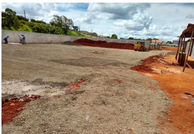
Figura 54C: Macadame hidráulico após total espalhamento - estacionamento da direita
