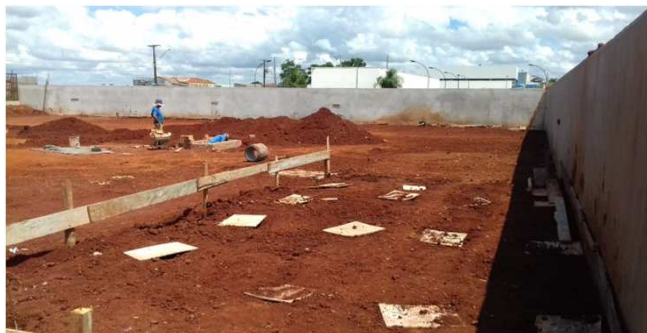
Figura 05C: Estacas-brocas perfuradas - Reservatório de incêndio
