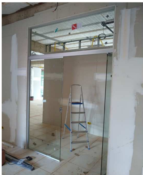
Figura 19C: Painel de vidro fixo + de abrir, instalado no atendimento (bloco da direita)
