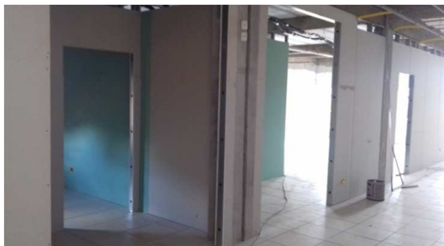
Figura 38C: Piso executado no hall, copa da distribuição e sala de perícias
