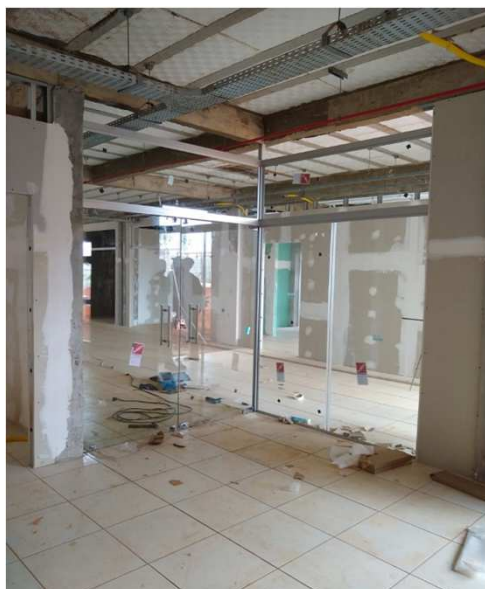
Figura 21C: Painel de vidro fixo (direita, na imagem) e de abrir (esquerda da imagem), instalados na entrada do bloco da esquerda
