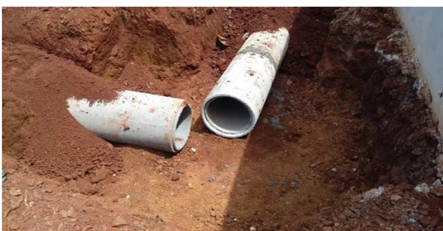
Figura 39C: Tubos de concreto 400mm, instalados no estacionamento da direita
