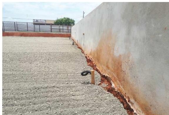
Figura 02E: infraestrutura de eletrodutos e caixas 30x30 - externo estacionamento
