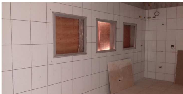
Figura 33C: Azulejos instalados na copa do bloco da direita
