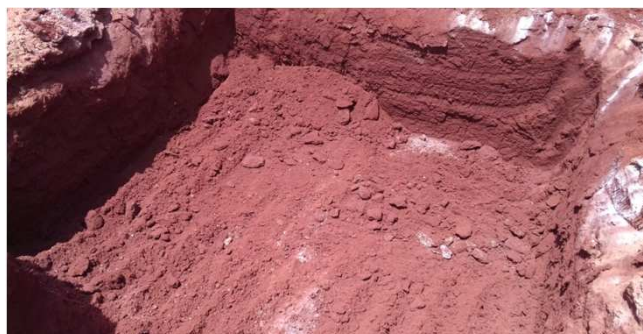
Figura 02C: Abertura de vala para execução de boca-de-lobo
