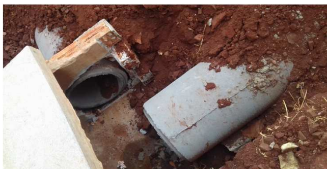
Figura 40C: Tubos de concreto 400mm, instalados no estacionamento da direita, junto a boca-de-lobo
