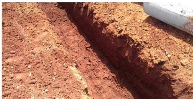
Figura 01C: Abertura de vala para instalação de rede pluvial - estacionamento da direita
