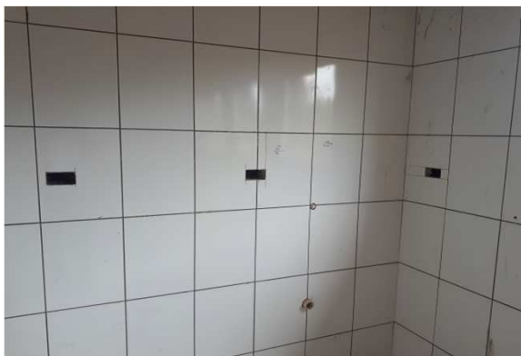
Figura 07E: infraestrutura interna - caixas drywall e eletrodutos (central)
