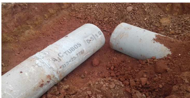
Figura 41C: Tubos de concreto 400mm, instalados no estacionamento da direita, em ponto onde será executada cx de inspeção
