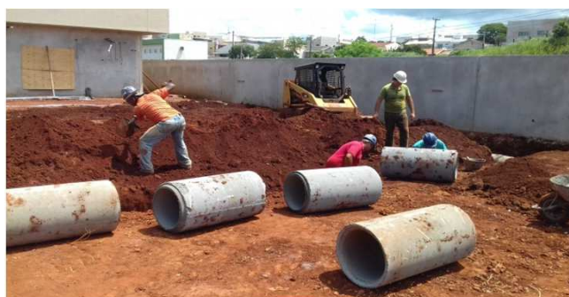
Figura 04C: Fechamento de vala no estacionamento da direita
