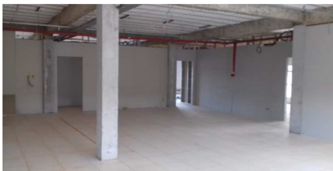
Figura 09C: Paredes de gesso acartonado simples - secretaria do bloco esquerdo
