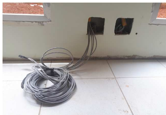
Figura 14E: infraestrutura interna - caixas drywall e eletrodutos
