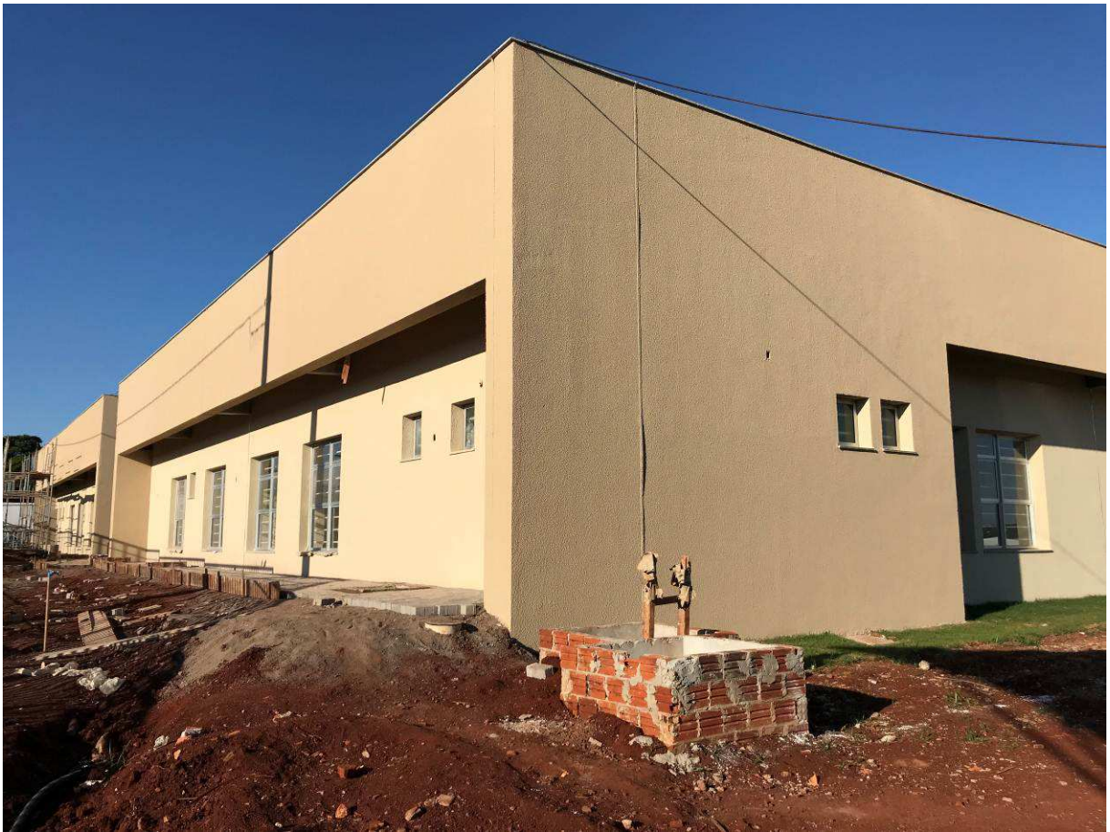
Figura 2 – Fórum - Vista externa.
