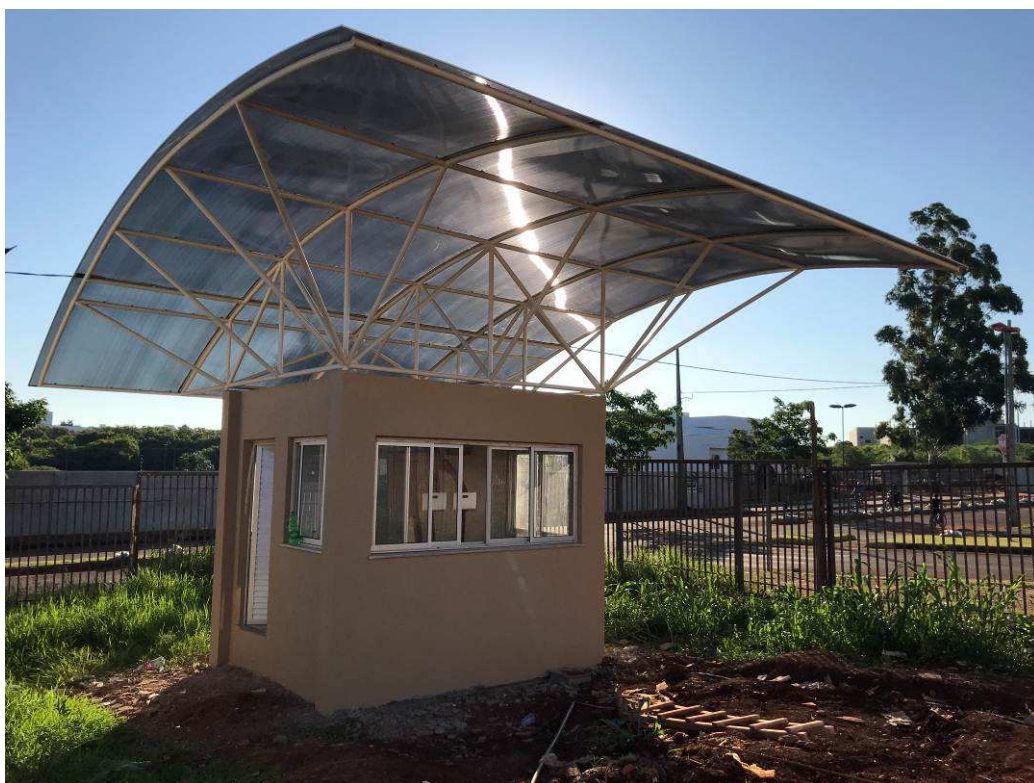
Figura 4 – Guarita - Vista externa.
