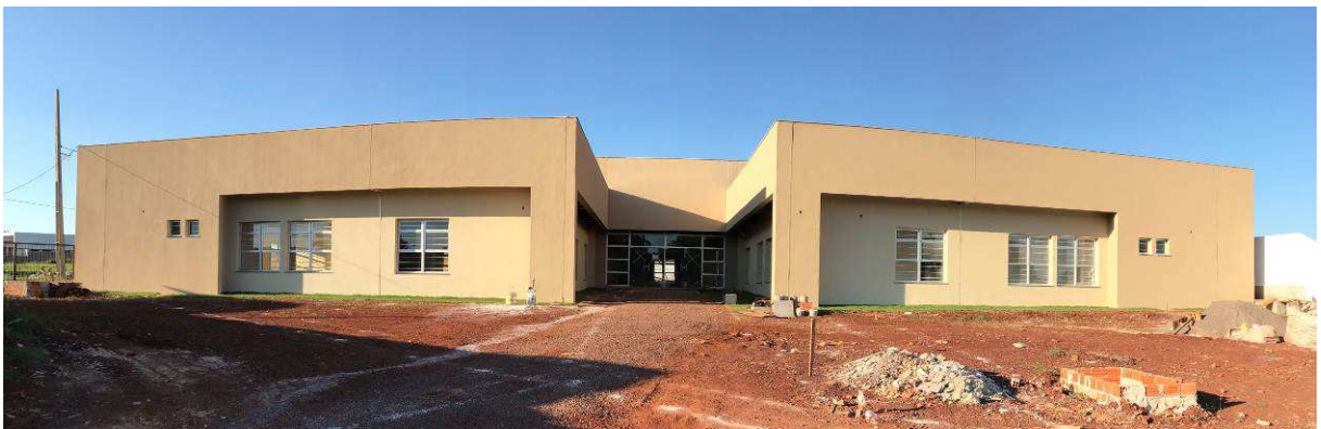
Figura 1 – Fórum - Vista externa.
