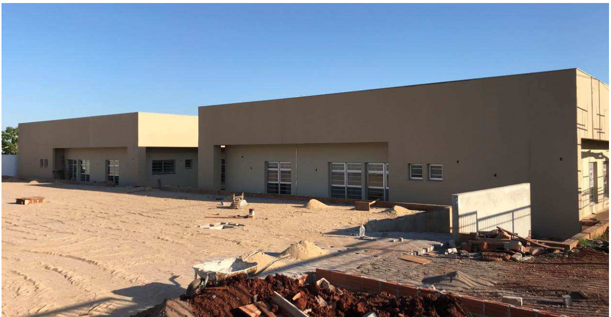
Figura 3 – Fórum - Vista externa.
