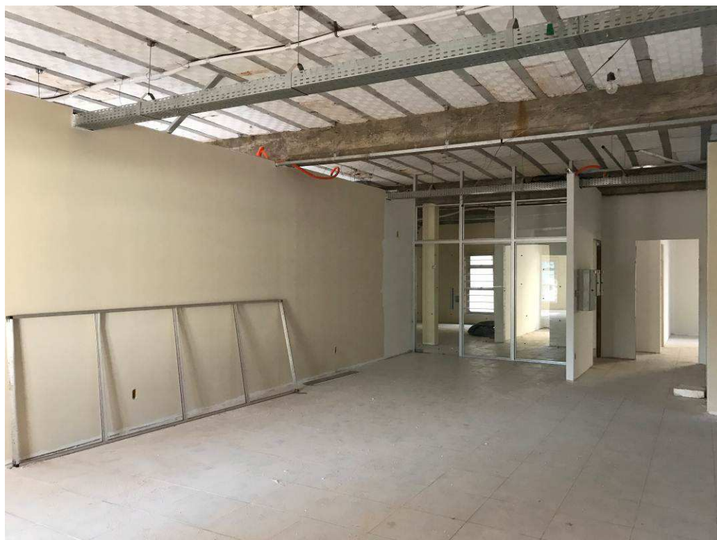
Figura 5 – Fórum - Vista interna.
