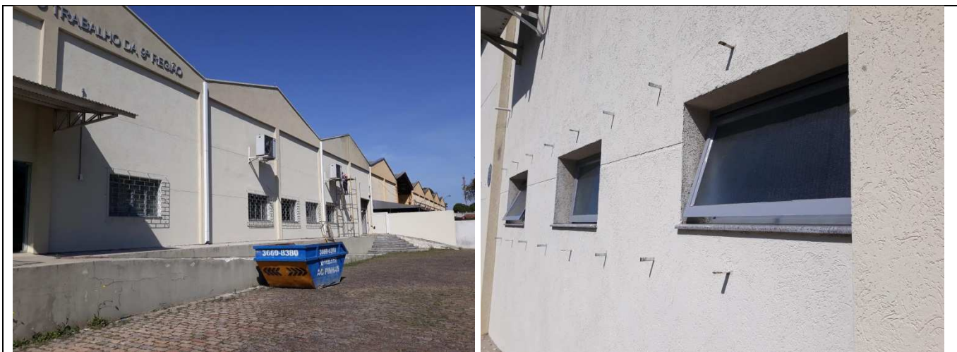
Figuras 06: Remoções de guarda corpo e gradis das janelas.
