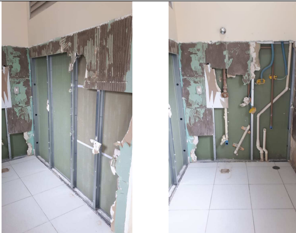
Figura 05: Remoções de divisórias em dry wall e remoção de azulejos.
