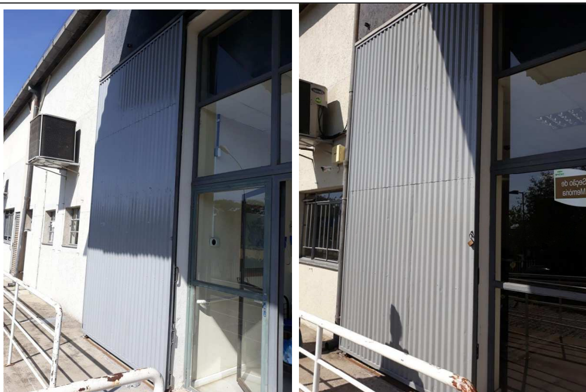
Figuras 16 - Pintura dos portões metálicos.
