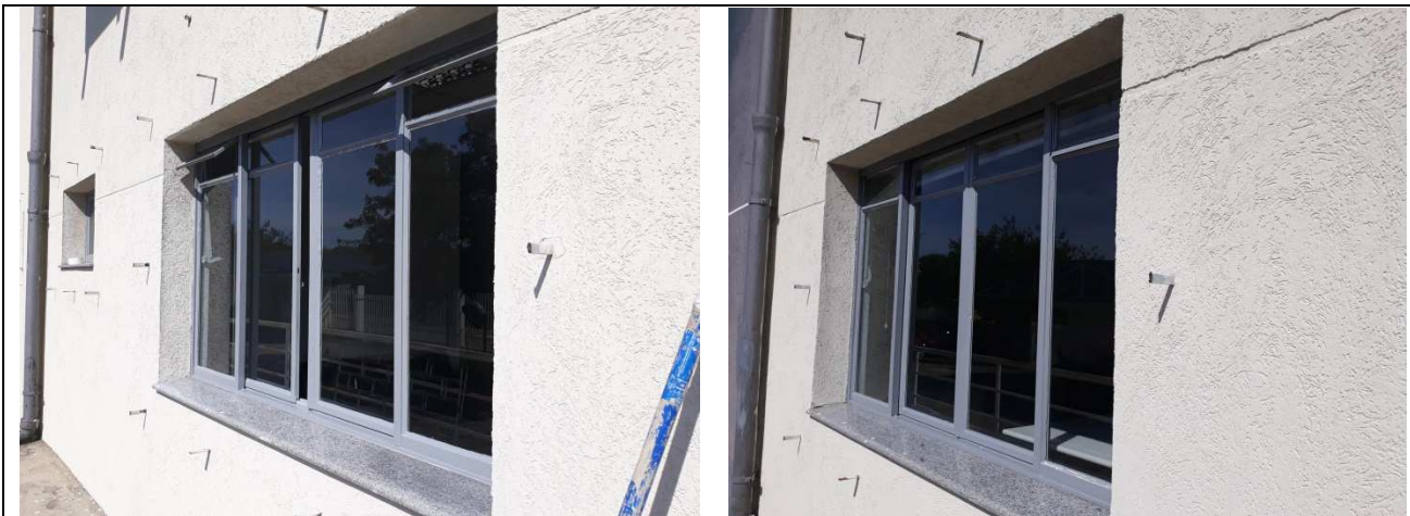
Figuras 09 - Execução de peitoril em granito.
