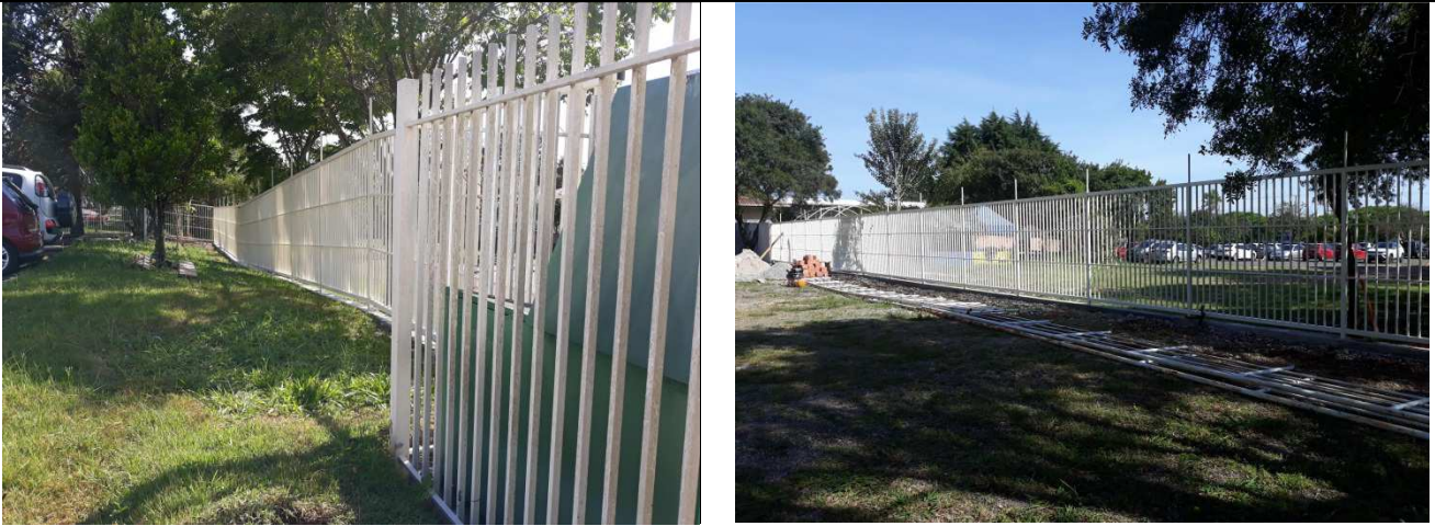
Figuras 10 - Gradis de fechamento de terreno.
