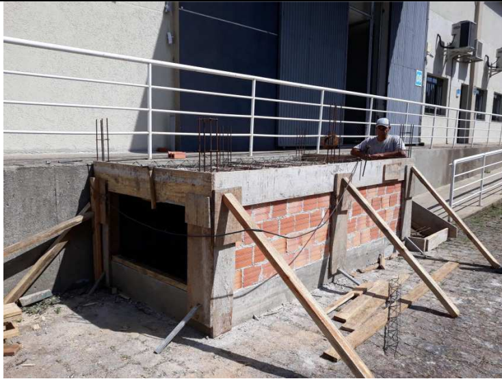
Figuras 08 - Confeção da estrutura da guarita plataforma.
