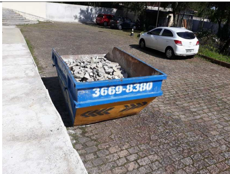
Figura 04 - Caçamba de entulho
