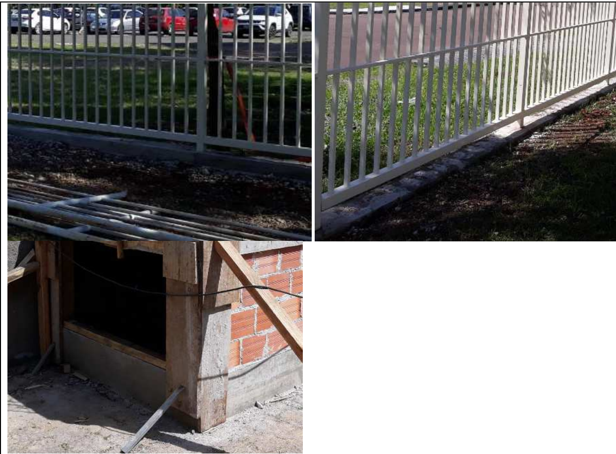
Figura 07 - Confeccção baldrame para atender o gradil e guarita nova.
