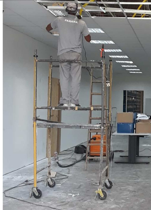
Figura 03 - Andaime metálico modular
