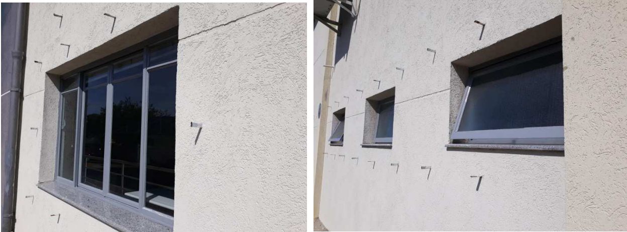
Figuras 14 - Pintura das esquadrias.
