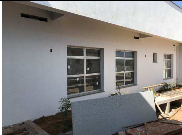
Figura 82C: Textura nas paredes externas.
