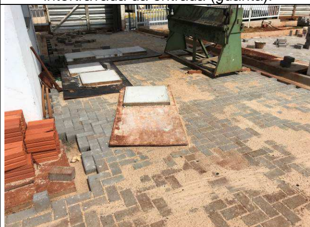
Figura 58C Pavimentação intertravada da entrada (guarita).
