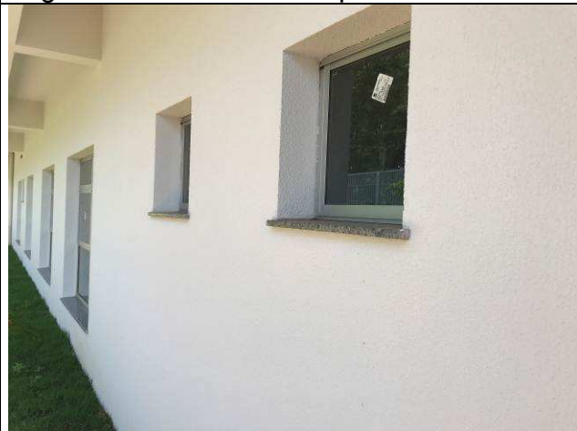
Figura 87C: Textura nas paredes externas.
