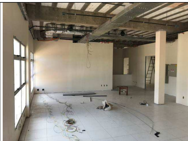
Figura 73C: Pintura das parede internas - Distribuição / Sala dos Oficiais.
