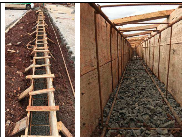
Figura 100C: Viga baldrame - Formas e armaduras.
