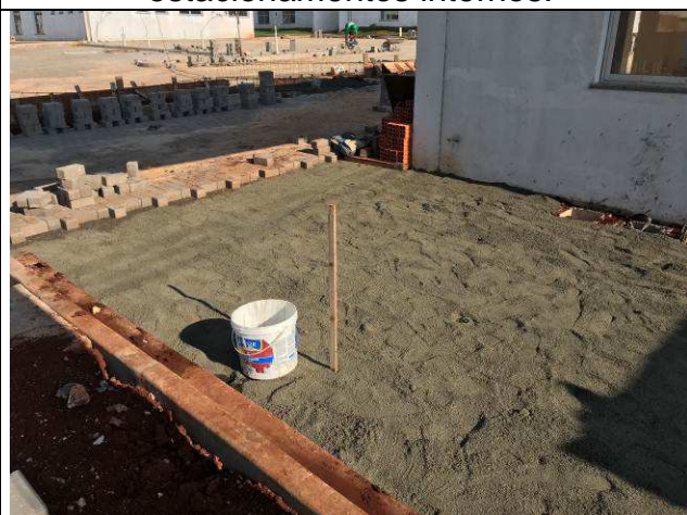
Figura 56C: Execução da pavimentação intertravada da entrada (guarita).
