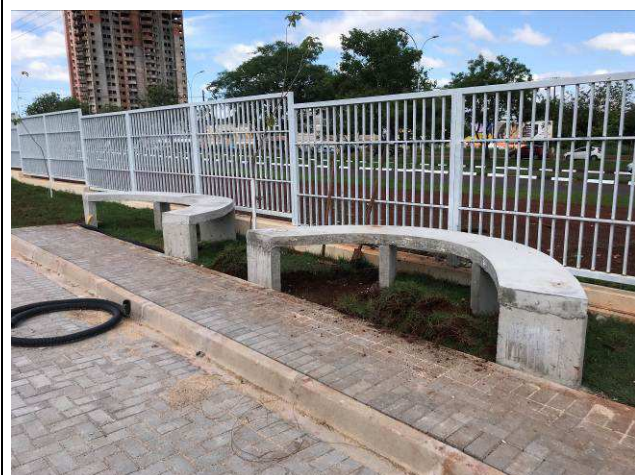
Figura 97C: Bancos em concreto próximos a gradil.
