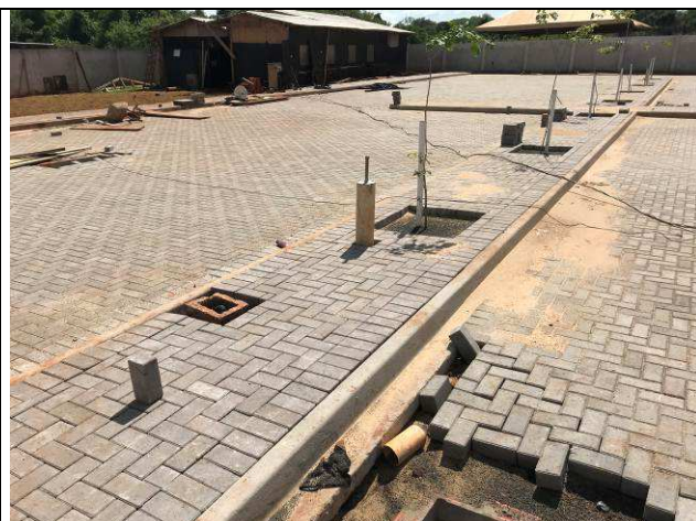
Figura 49C: Pavimentação intertravada das calçadas internas.
