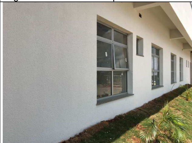
Figura 89C: Textura nas paredes externas.
