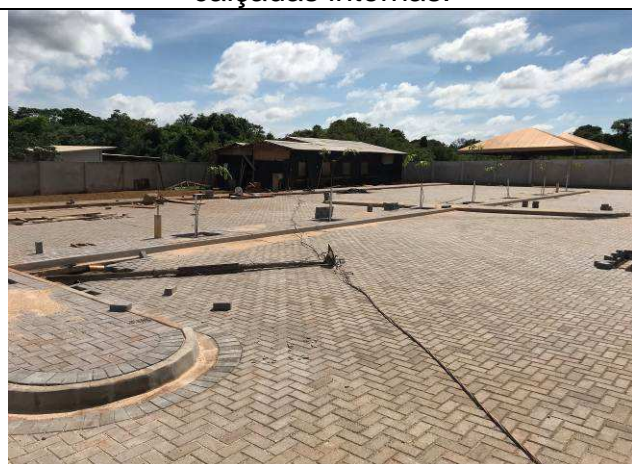
Figura 52C: Pavimentação intertravada dos estacionamentos internos.
