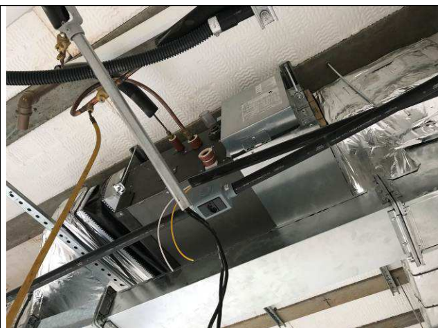
Figura 29C: Evaporadoras substituídas.
