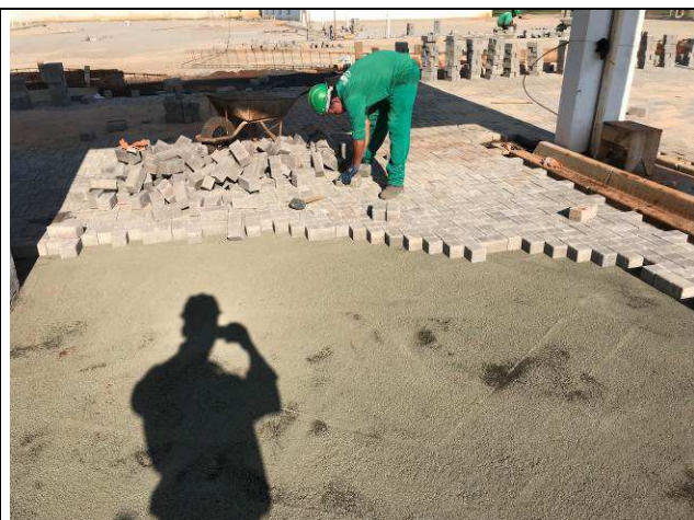
Figura 55C: Execução da pavimentação intertravada da entrada (guarita).
