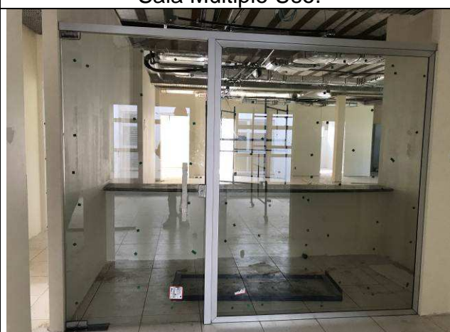
Figura 07C: Porta de vidro temperado e painel de vidro do balcão da 2ª Vara.
