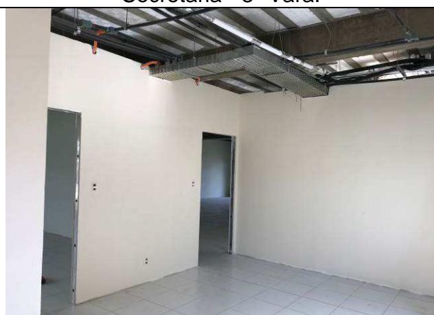
Figura 70C: Pintura das parede internas - Gabinete de juiz - 3ª Vara.
