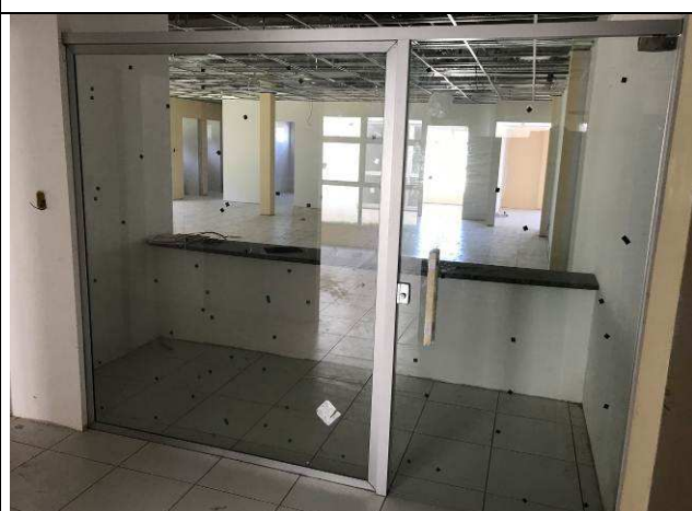
Figura 06C: Porta de vidro temperado e painel de vidro do balcão da 1ª Vara.
