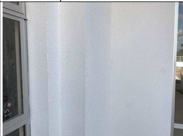
Figura 81C: Textura nas paredes externas.
