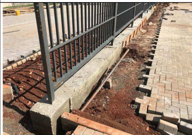
Figura 101C: Viga baldrame concretada.
