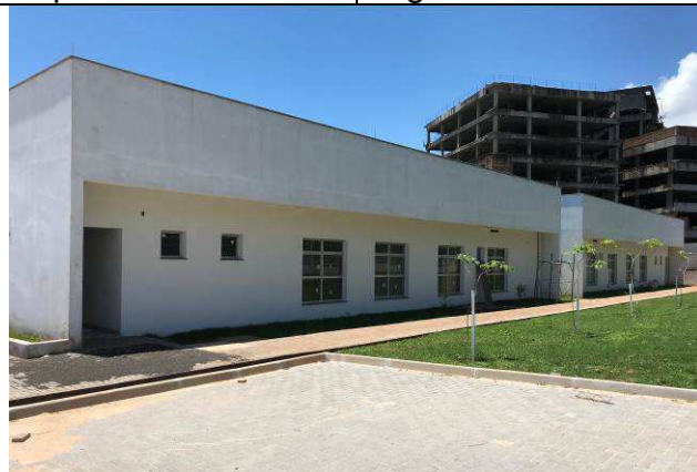
Figura 92C: Textura nas paredes externas.
