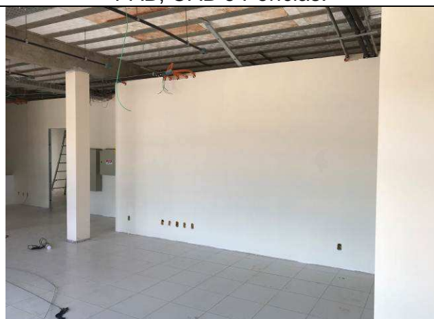
Figura 74C: Pintura das parede internas - Distribuição / Sala dos Oficiais.
