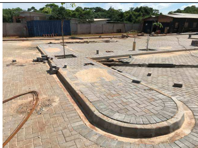
Figura 48C: Pavimentação intertravada das calçadas internas.
