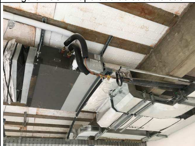
Figura 25C: Evaporadoras substituídas.
