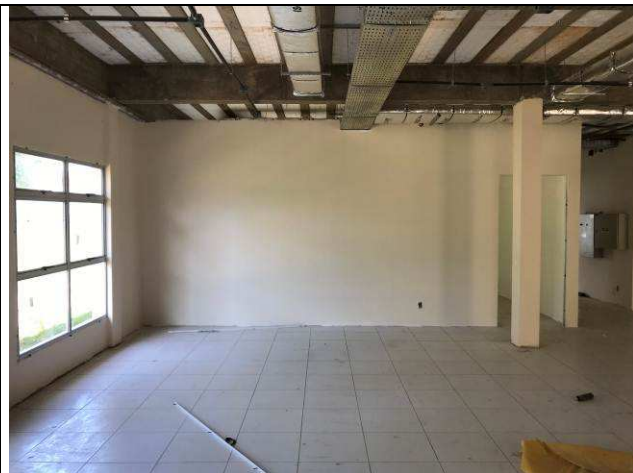
Figura 60C: Pintura das parede internas - Secretaria - 2ª Vara.
