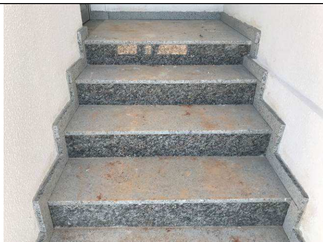
Figura 21C: Rodapés em granito - entrada lateral da Distribuição.
