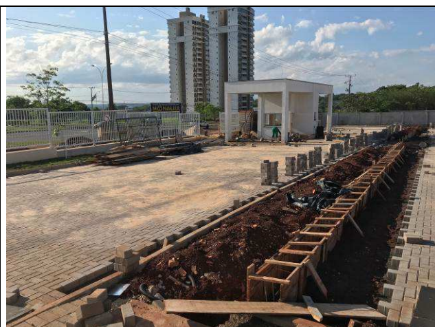
Figura 99C: Viga baldrame - Formas e armaduras.
