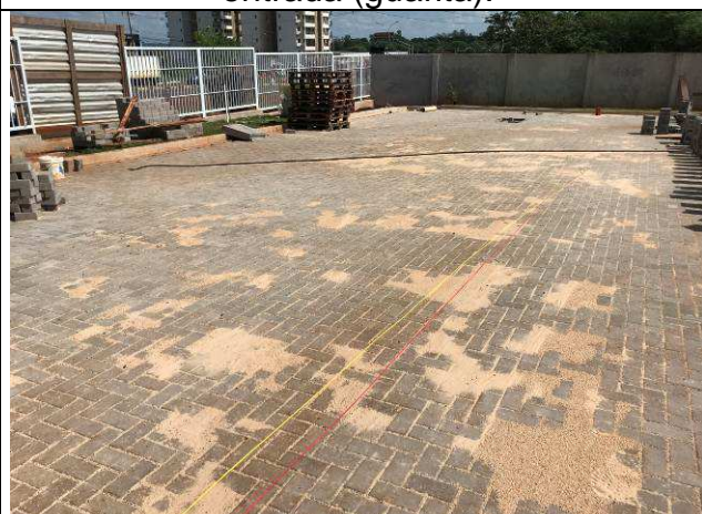
Figura 59C: Pavimentação intertravada dos estacionamentos internos.
