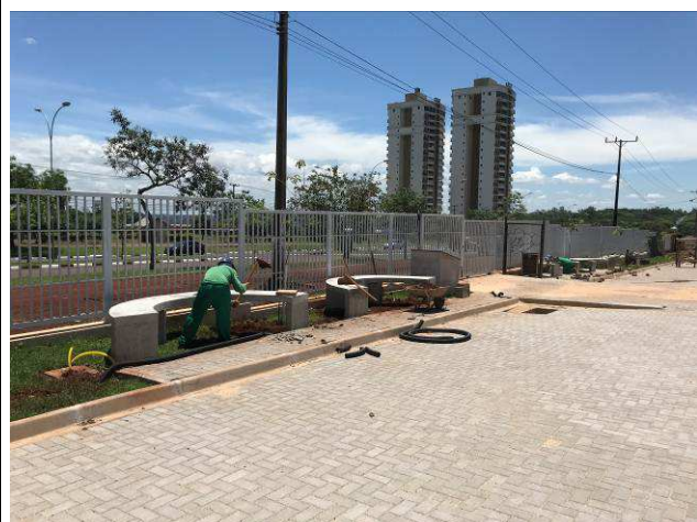
Figura 98C: Bancos em concreto próximos a gradil.
