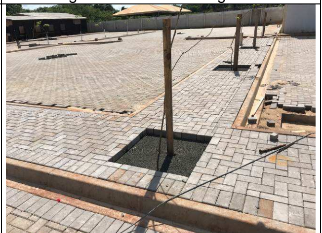
Figura 47C: Pavimentação intertravada das calçadas internas.
