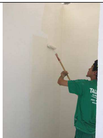
Figura 79C: Aplicação da pintura palha nas parede internas.
