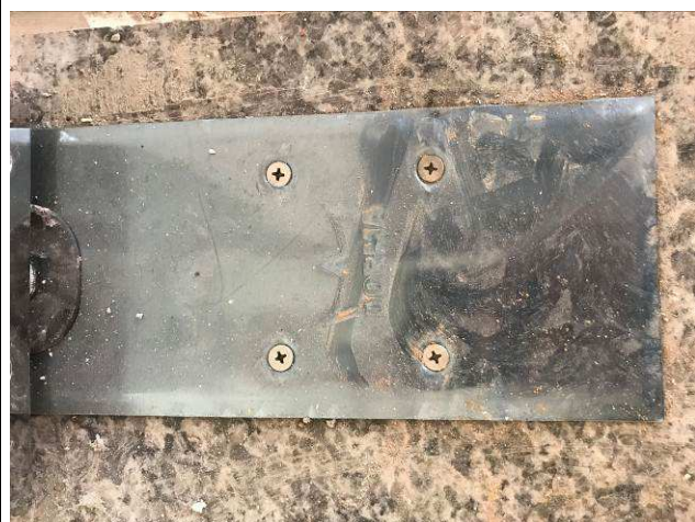
Figura 11C: Molas de piso instaladas.
