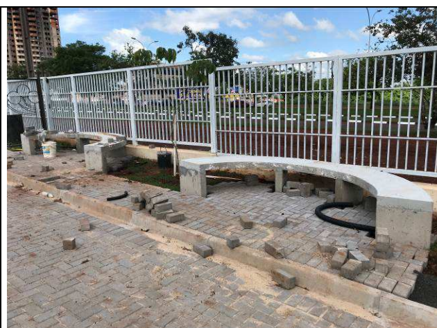
Figura 94C: Bancos em concreto próximos a gradil.
