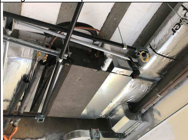
Figura 27C: Evaporadoras substituídas.
