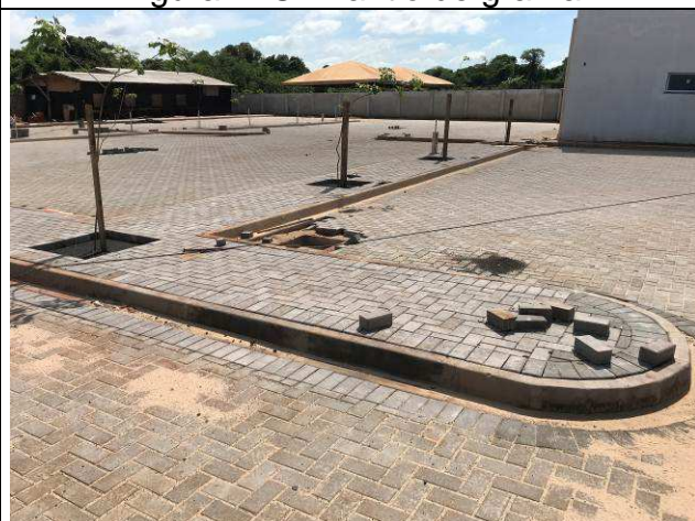
Figura 46C: Pavimentação intertravada das calçadas internas.
