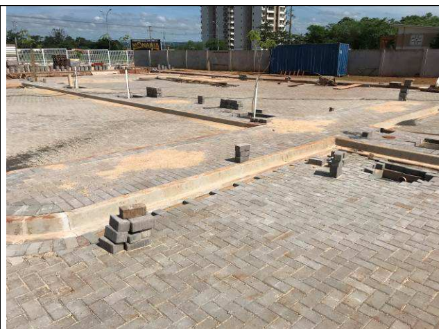
Figura 54C: Pavimentação intertravada dos estacionamentos internos.
