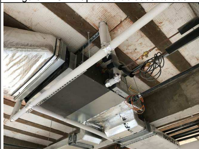
Figura 24C: Evaporadoras substituídas.
