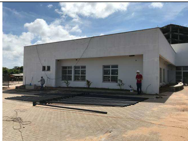
Figura 90C: Textura nas paredes externas.
