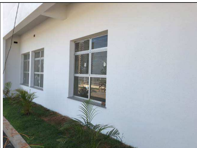
Figura 84C: Textura nas paredes externas.
