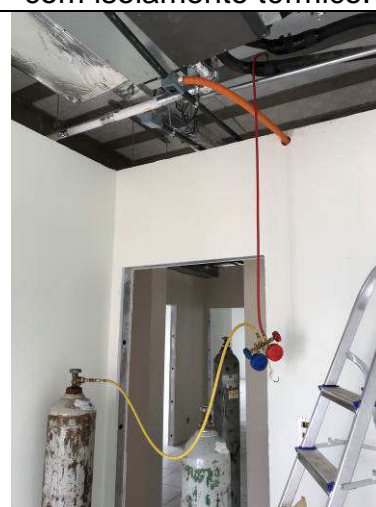
Figura 39C: Teste das tubulações.
