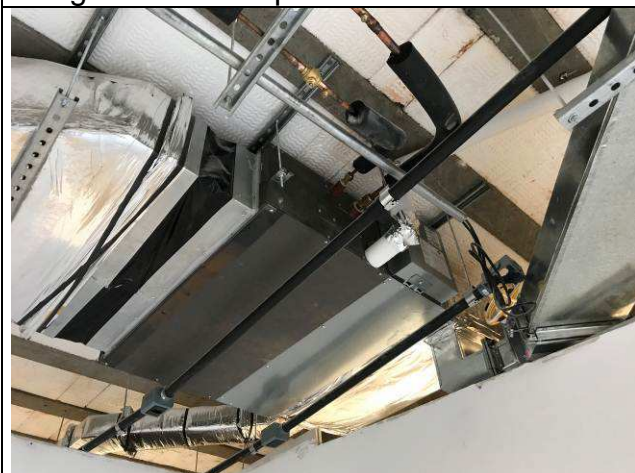
Figura 26C: Evaporadoras substituídas.
