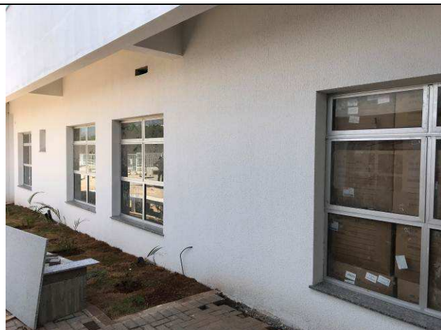
Figura 80C: Textura nas paredes externas.
