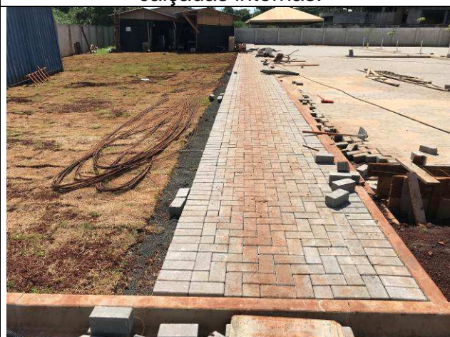
Figura 51C: Pavimentação intertravada das calçadas internas.
