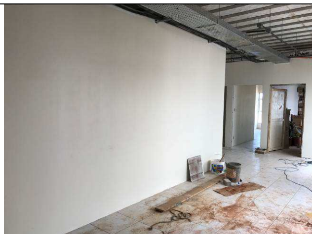
Figura 72C: Pintura das parede internas - PAB, OAB e Perícias.
