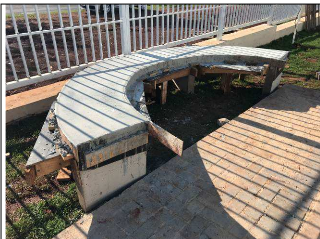
Figura 95C: Bancos em concreto próximos a gradil.
