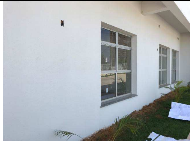
Figura 83C: Textura nas paredes externas.
