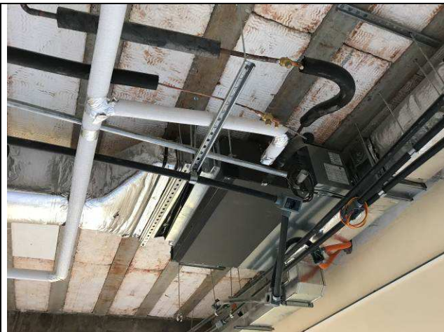
Figura 23C: Evaporadoras substituídas.
