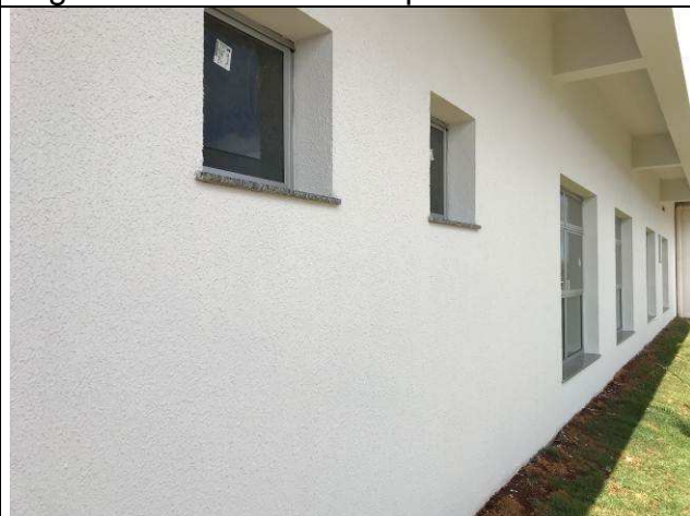
Figura 88C: Textura nas paredes externas.
