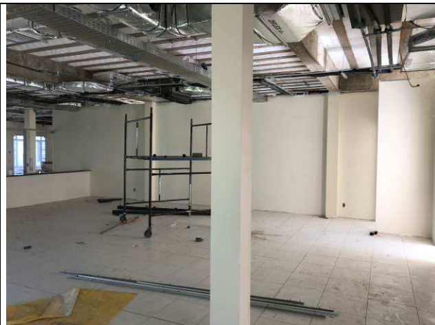
Figura 61C: Pintura das parede internas - Secretaria - 2ª Vara.
