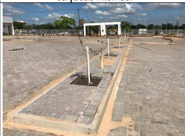
Figura 53C: Pavimentação intertravada dos estacionamentos internos.
