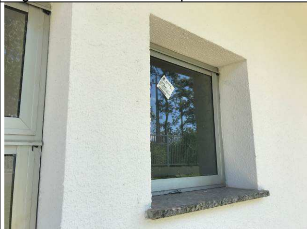
Figura 86C: Textura nas paredes externas.
