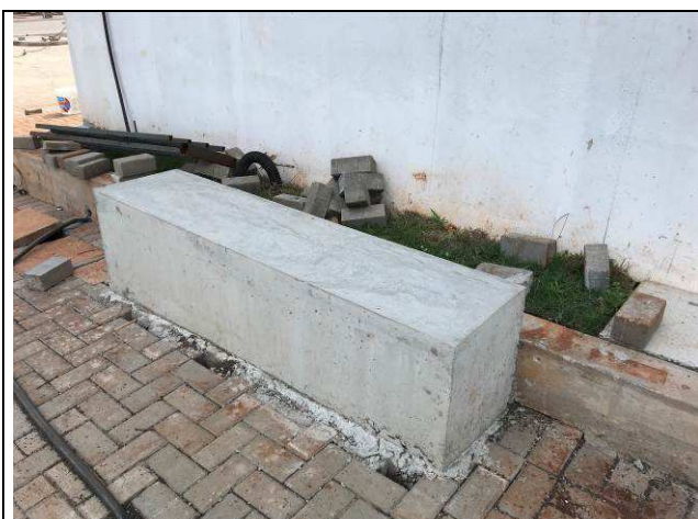
Figura 93C: Base em concreto para os mastros das bandeiras.
