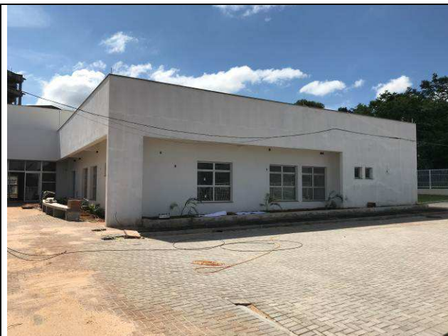
Figura 91C: Textura nas paredes externas.
