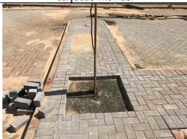
Figura 50C: Pavimentação intertravada das calçadas internas.
