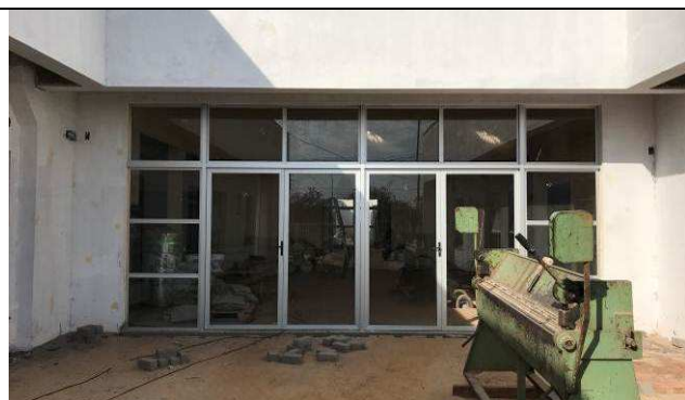
Figura 16C: Painéis de vidro nas laterais das portas de entrada.
