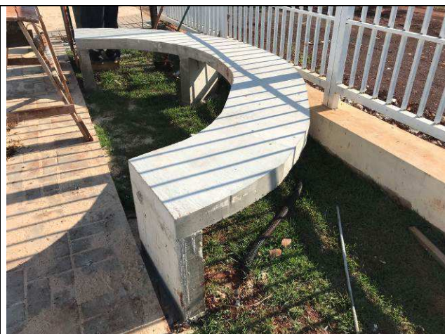
Figura 96C: Bancos em concreto próximos a gradil.
