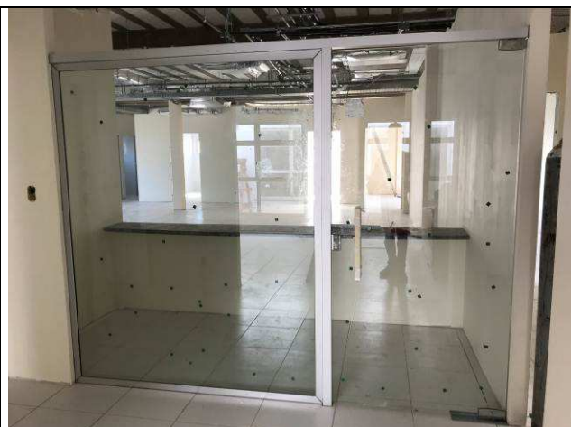
Figura 08C: Porta de vidro temperado e painel de vidro do balcão da 3ª Vara.
