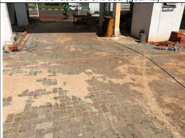
Figura 57C: Pavimentação intertravada da entrada (guarita).
