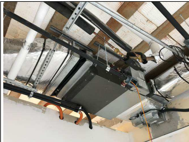
Figura 22C: Evaporadoras substituídas.
