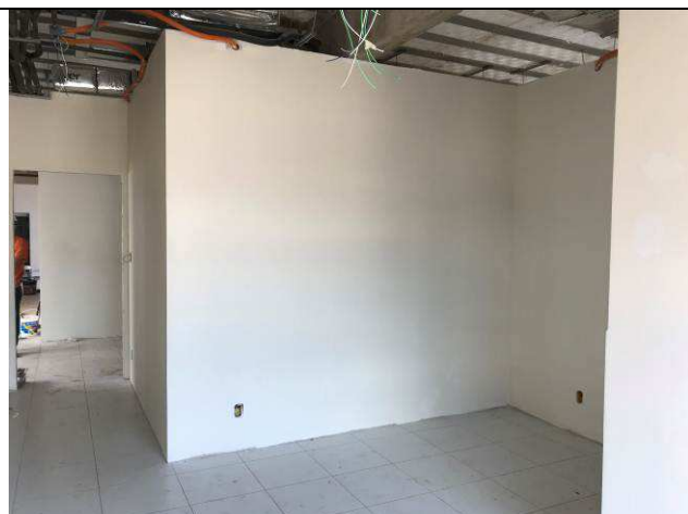
Figura 78C: Pintura das parede internas - Sala de Perícias.
