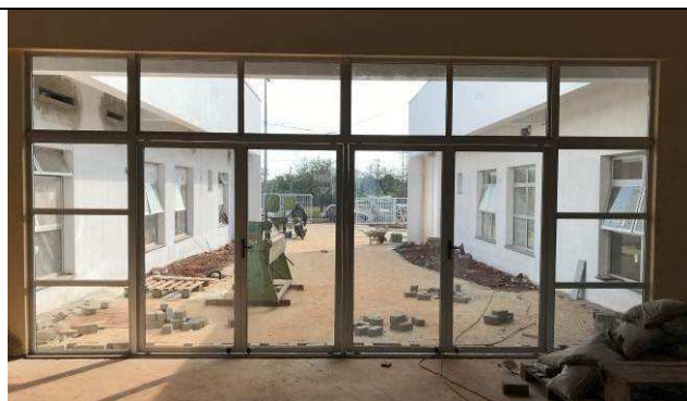
Figura 17C: Painéis de vidro nas laterais das portas de entrada.
