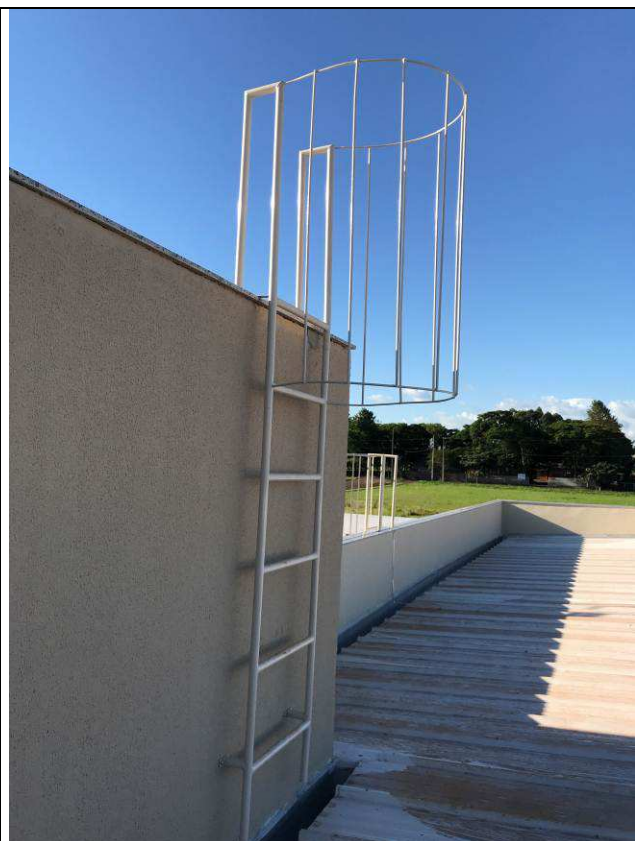
Figura 153C: Escada marinheiro - acesso à cobertura dos reservatórios / hall central.
