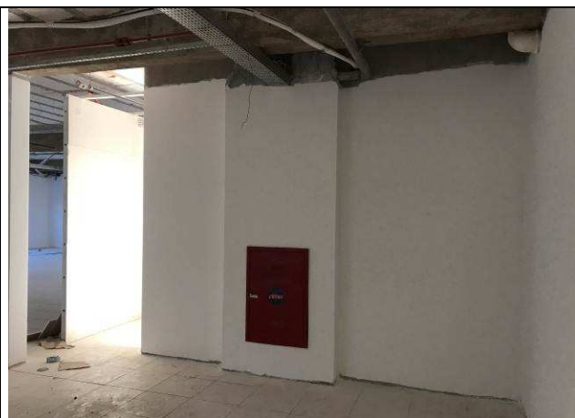
Figura 132C: Emassamento das paredes de alvenaria - hall central.
