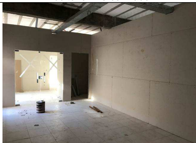
Figura 13C: Paredes de gesso acartonado - Hall da Sala Múltiplo Uso e Arquivo.
