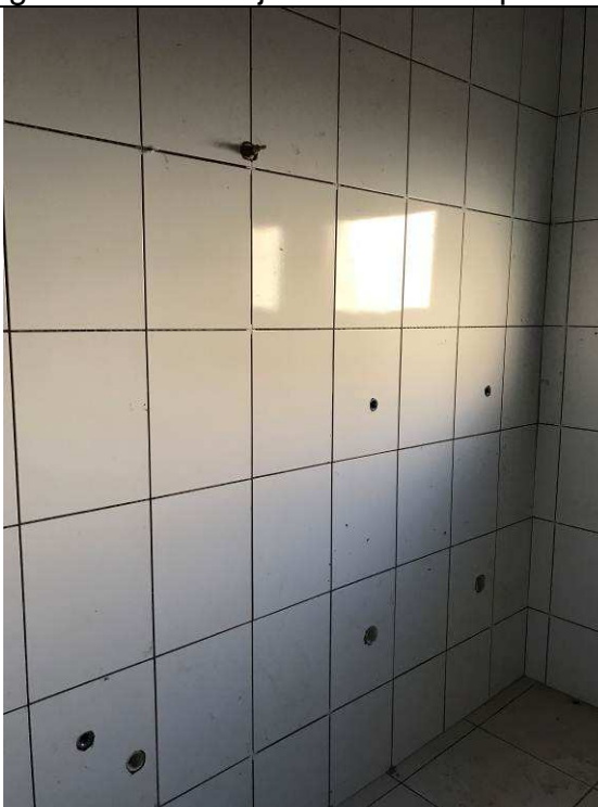
Figura 64C: Azulejos - Banheiros públicos.
