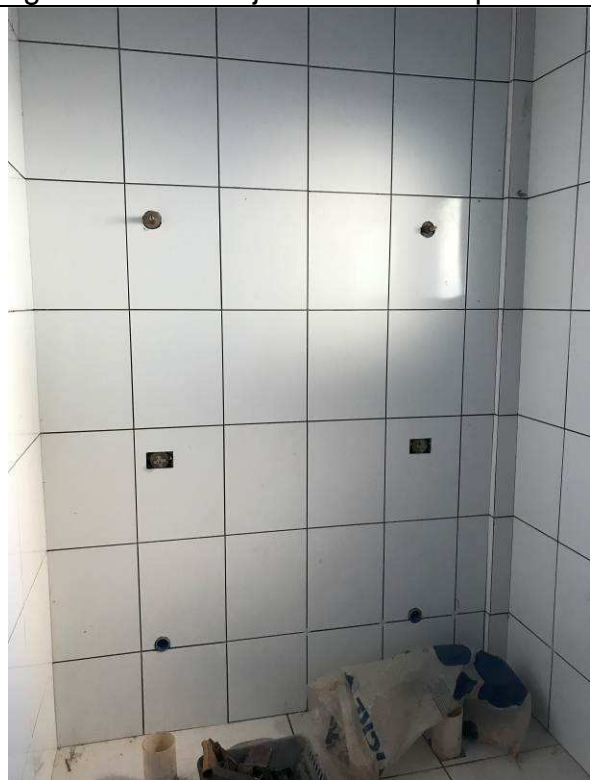
Figura 67C: Azulejos - Banheiros públicos.
