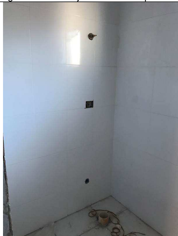
Figura 68C: Azulejos - Banheiros 1ª Vara.
