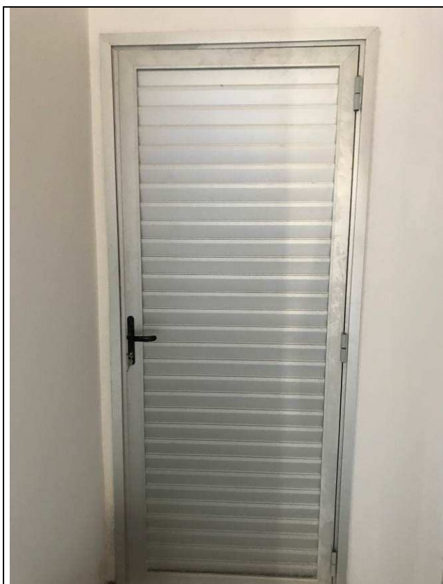
Figura 17C: Porta de Alumínio - saída lateral da 1ª Vara.
