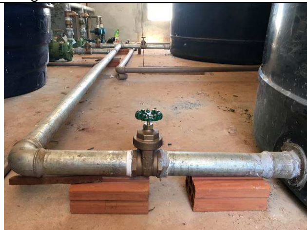
Figura 93C: Conexões - reservatórios.
