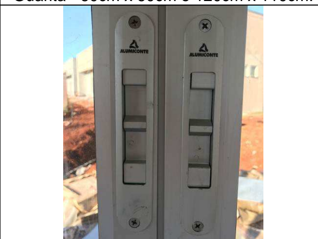
Figura 56C: Janelas em alumínio da Guarita - detalhe do trinco.
