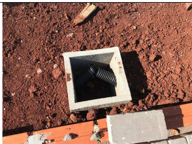
Figura 03E: infraestrutura externa - escavação, eletrodutos PEAD e caixas.
