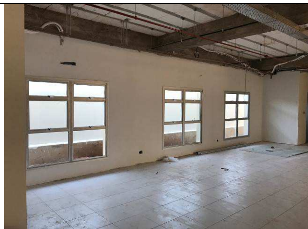
Figura 133C: Emassamento das paredes de alvenaria - 1ª Vara.
