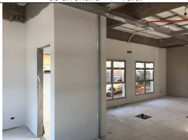
Figura 135C: Emassamento das paredes de alvenaria - 1ª Vara.
