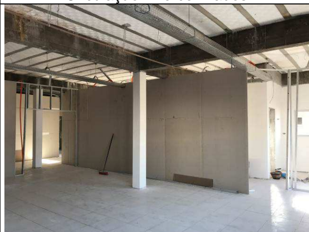
Figura 12C: Paredes de gesso acartonado - Auditório - Terceirizado.
