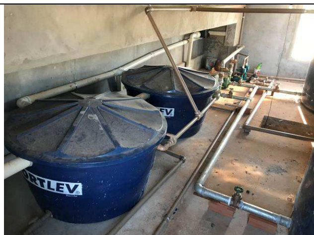
Figura 103C: Vista geral da sala dos reservatórios superiores.
