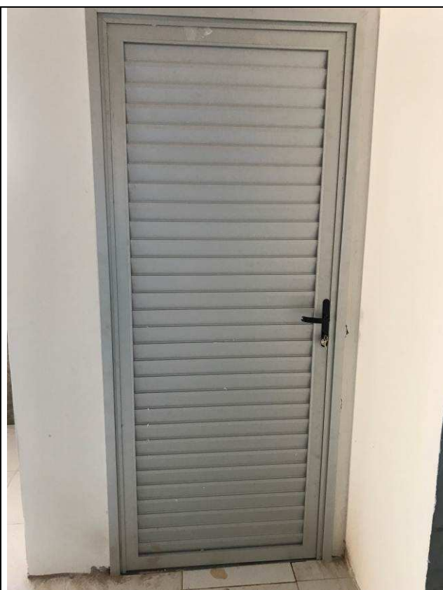
Figura 18C: Porta de Alumínio - saída lateral da área de Terceirizados.
