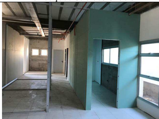
Figura 07C: Paredes de gesso acartonado - Cozinha - Terceirizado.
