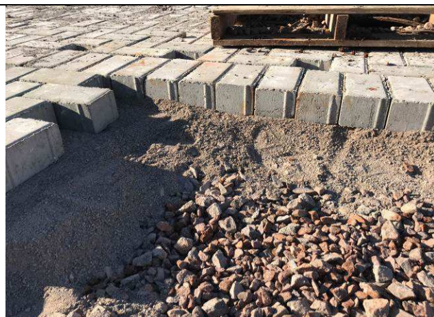
Figura 123C: Pavimentação intertravada - base - estacionamento dos fundos.
