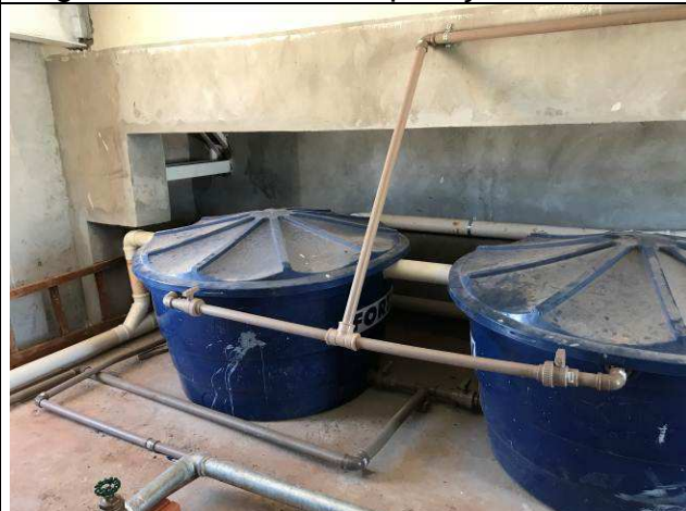
Figura 101C: Sistema de reaproveitamento de água de chuva.
