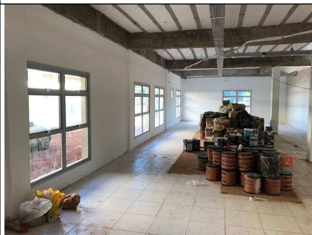
Figura 142C: Emassamento das paredes de alvenaria - PAB's.
