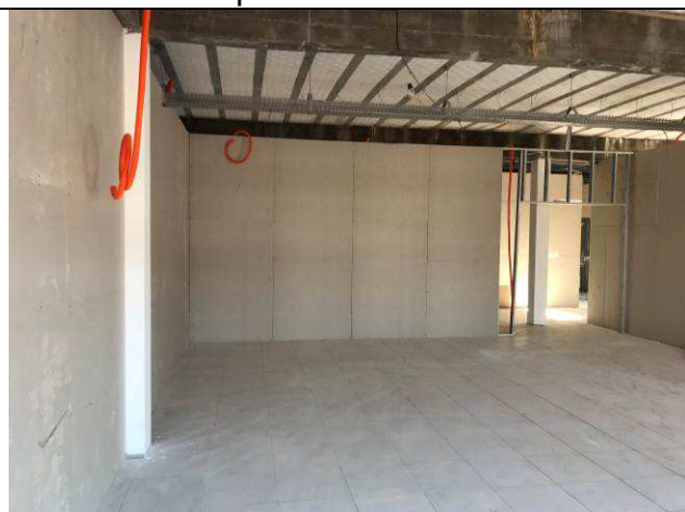
Figura 11C: Paredes de gesso acartonado - Auditório - Terceirizado.
