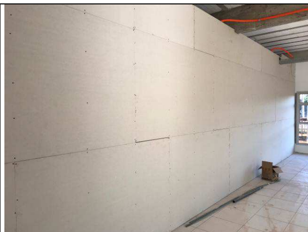
Figura 04C: Paredes de gesso acartonado - PAB's e Distribuição / Sala dos Oficiais.
