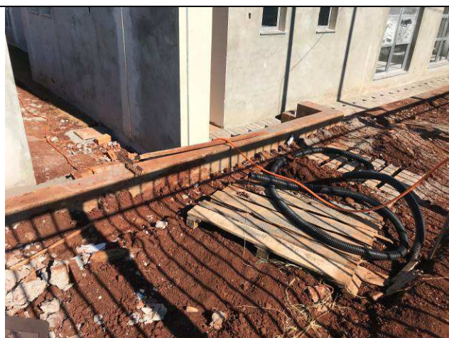
Figura 02E: infraestrutura externa - escavação, eletrodutos PEAD e caixas.
