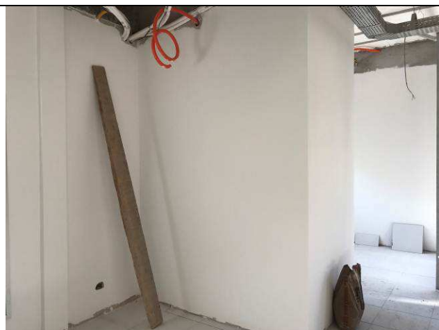
Figura 137C: Emassamento das paredes de alvenaria - Área de vivência.
