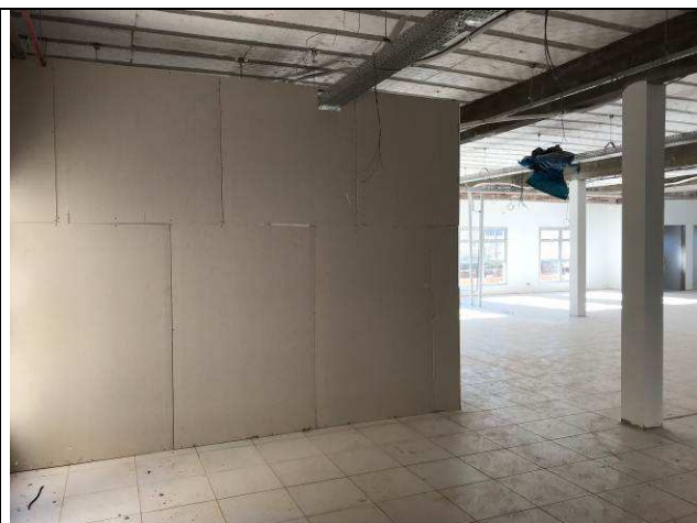
Figura 15C: Paredes de gesso acartonado - Sala de Conciliação - 2ª Vara.
