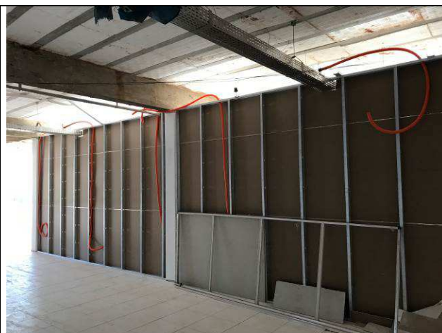
Figura 10E: infraestrutura interna - eletrodutos 1\"
