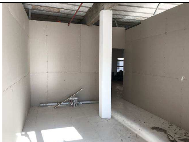
Figura 03C: Paredes de gesso acartonado - Sala de Perícias.
