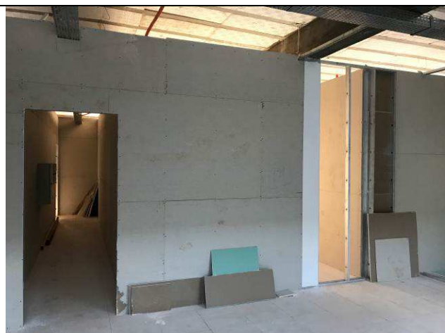
Figura 09C: Paredes de gesso acartonado - Copa - Terceirizado.
