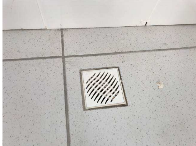
Figura 91C: Ralos das caixas sifonadas.
