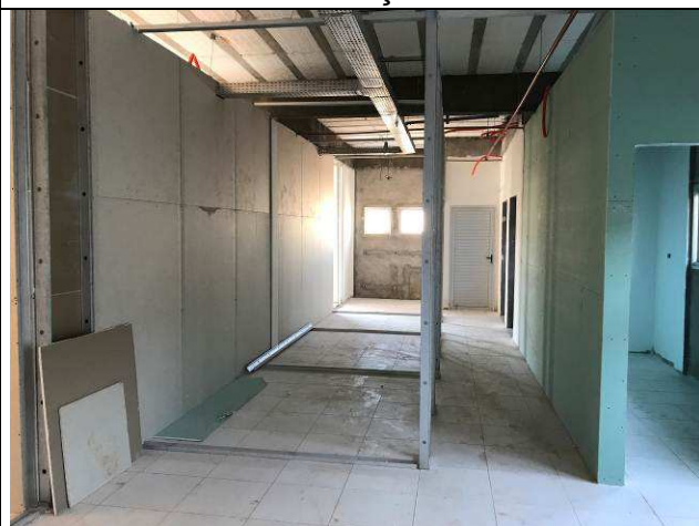
Figura 08C: Paredes de gesso acartonado - Vestiários e Cozinha - Terceirizados.
