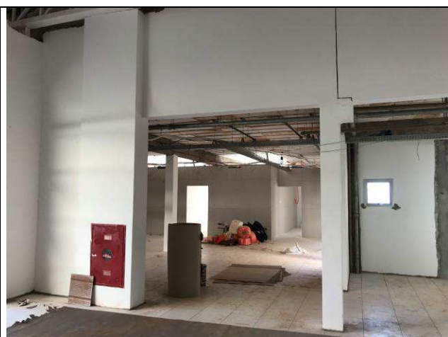
Figura 129C: Emassamento das paredes de alvenaria - hall central.
