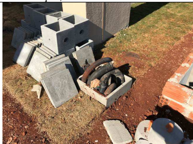
Figura 05E: infraestrutura externa - escavação, eletrodutos PEAD e caixas.
