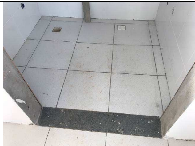
Figura 86C: Soleira em granito - Fórum.
