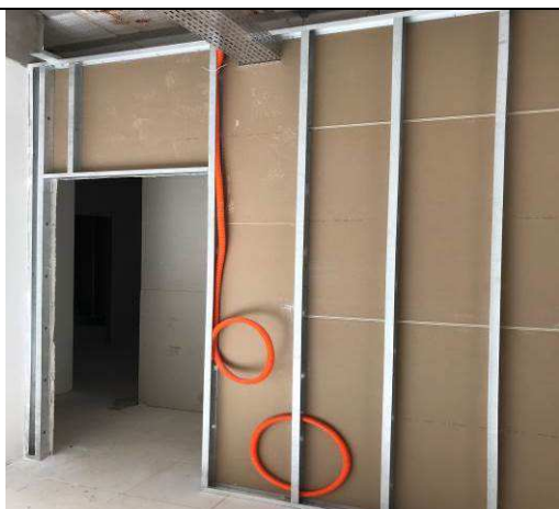
Figura 09E: infraestrutura interna - eletrodutos 1\"
