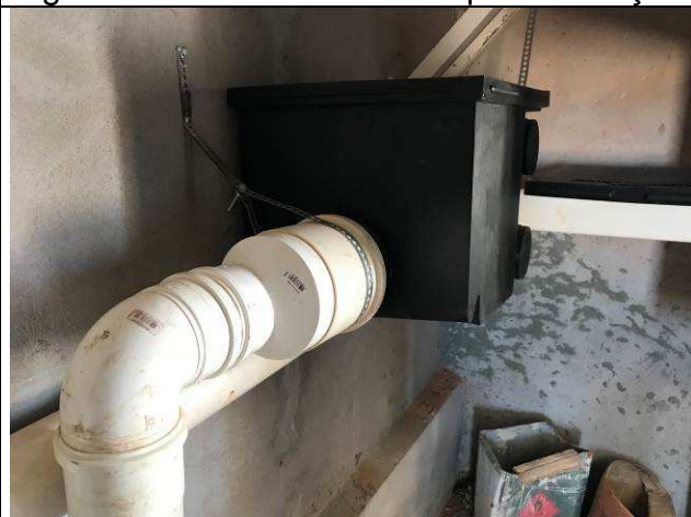
Figura 99C: Filtro de separação de folhas.
