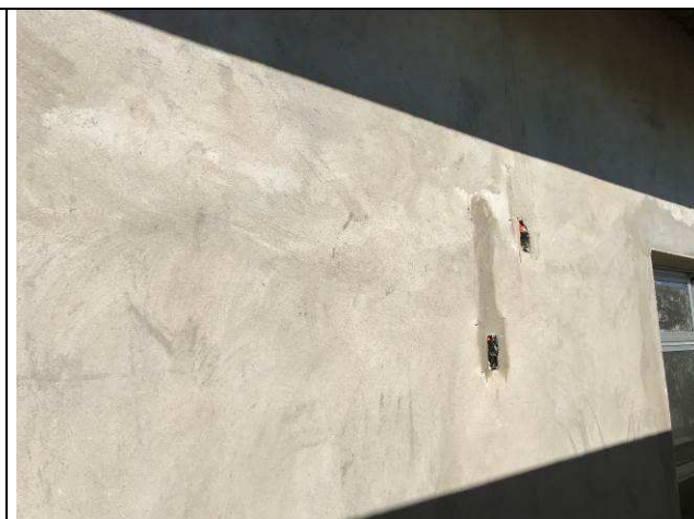
Figura 24E: infraestrutura interna - eletrodutos 1" e caixas 2x4".
