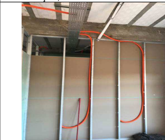
Figura 08E: infraestrutura interna - eletrodutos 1\"
