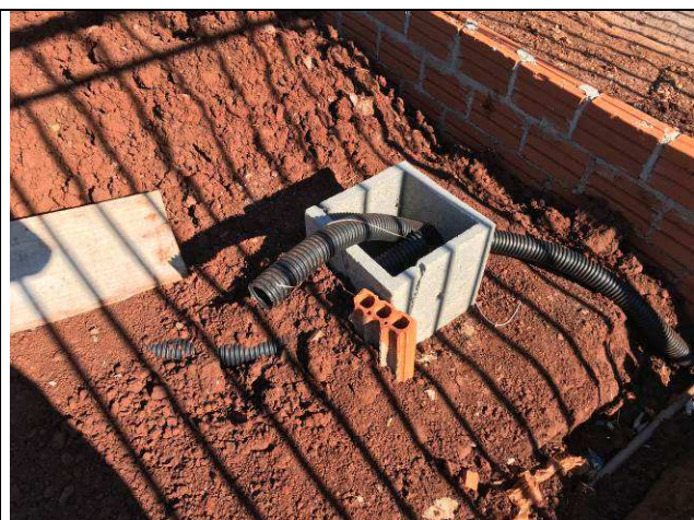
Figura 01E: infraestrutura externa - escavação, eletrodutos PEAD e caixas.
