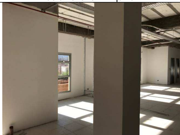
Figura 141C: Emassamento das paredes de alvenaria - 2ª Vara.
