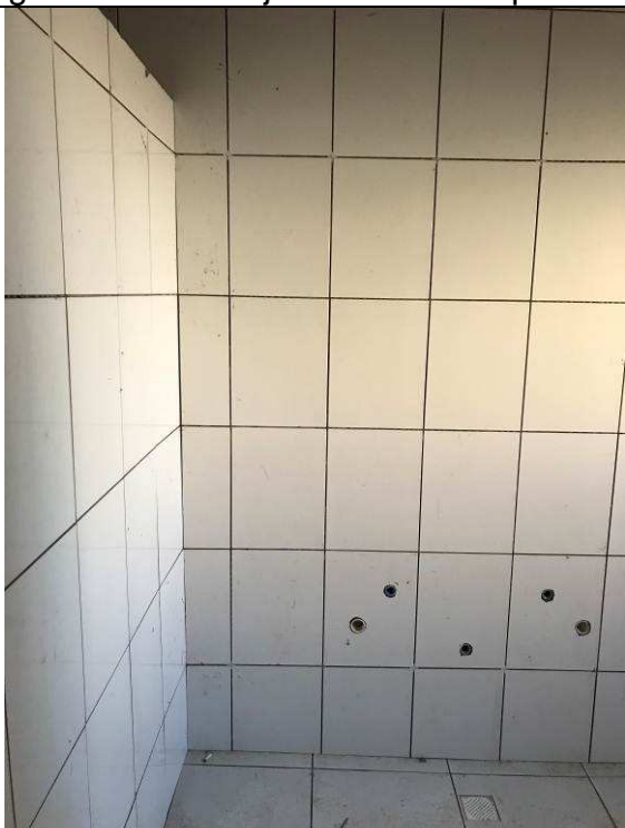
Figura 63C: Azulejos - Banheiros públicos.
