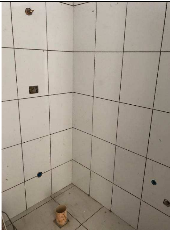
Figura 62C: Azulejos - Banheiros públicos.
