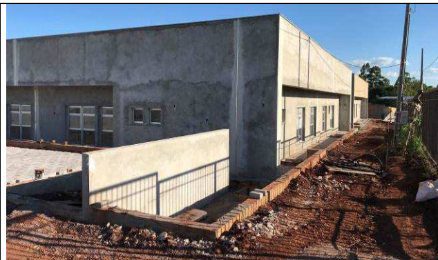
Figura 74C: Revestimento argamassado.
