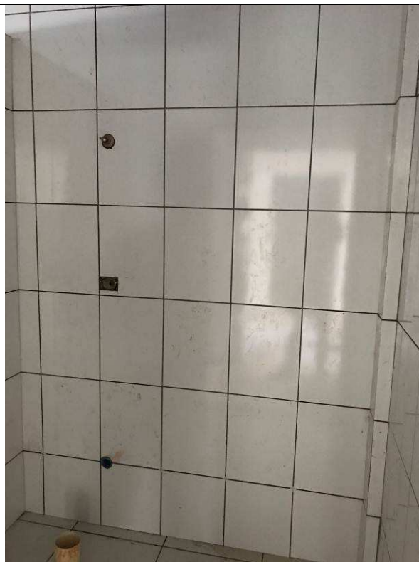
Figura 66C: Azulejos - Banheiros públicos.
