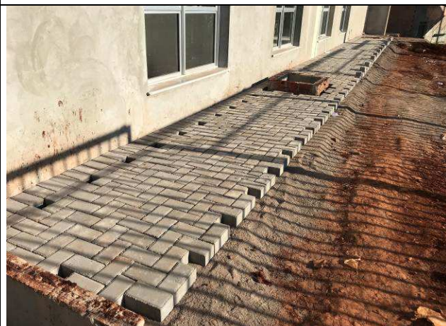
Figura 124C: Pavimentação intertravada - calçada lado esquerdo.
