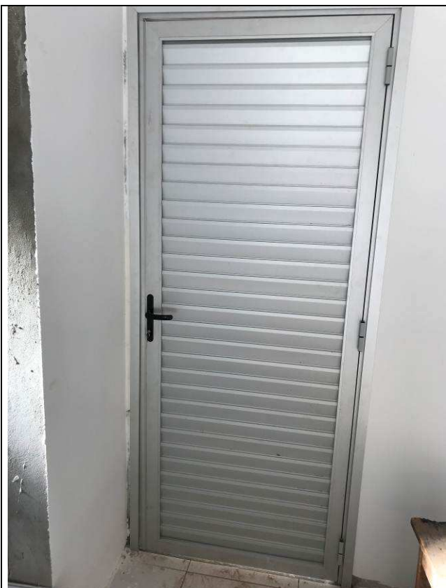
Figura 19C: Porta de Alumínio - saída lateral da 2ª Vara.
