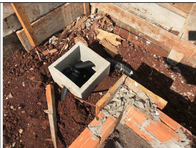
Figura 04E: infraestrutura externa - escavação, eletrodutos PEAD e caixas.
