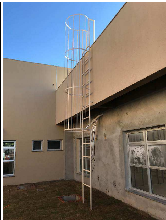
Figura 152C: Escada marinheiro - acesso à cobertura dos módulos do lado esquerdo.
