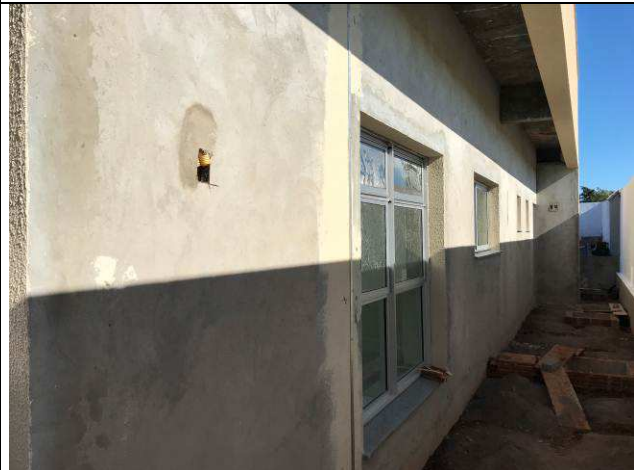
Figura 76C: Revestimento argamassado.
