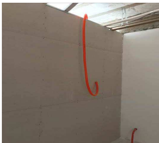
Figura 22E: infraestrutura interna - eletrodutos 1\".
