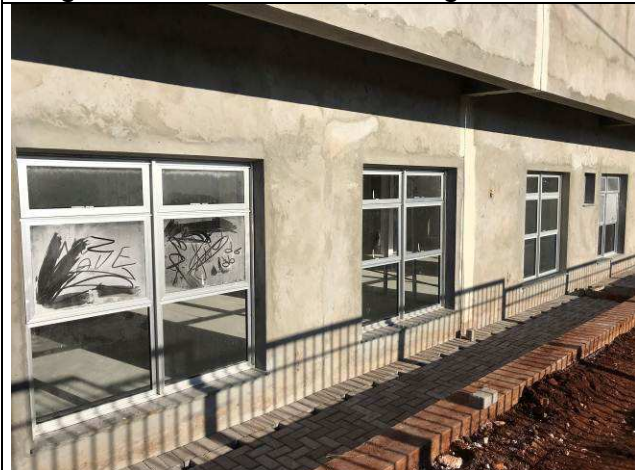
Figura 75C: Revestimento argamassado.
