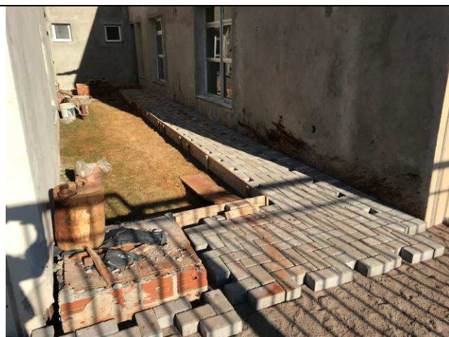
Figura 125C: Pavimentação intertravada - calçada lado esquerdo.
