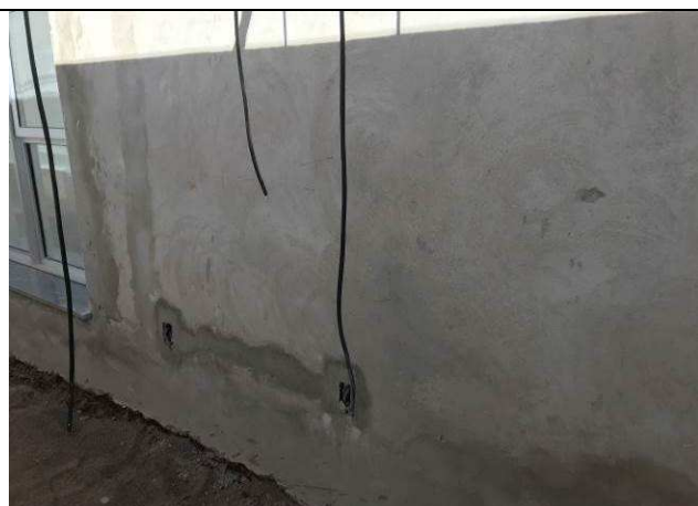
Figura 11E: infraestrutura interna - eletrodutos 1\" e caixas 2x4\".
