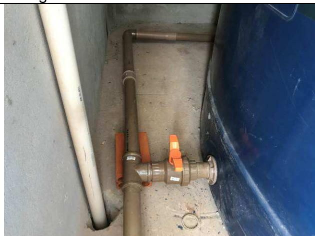
Figura 95C: Conexões - reservatórios.
