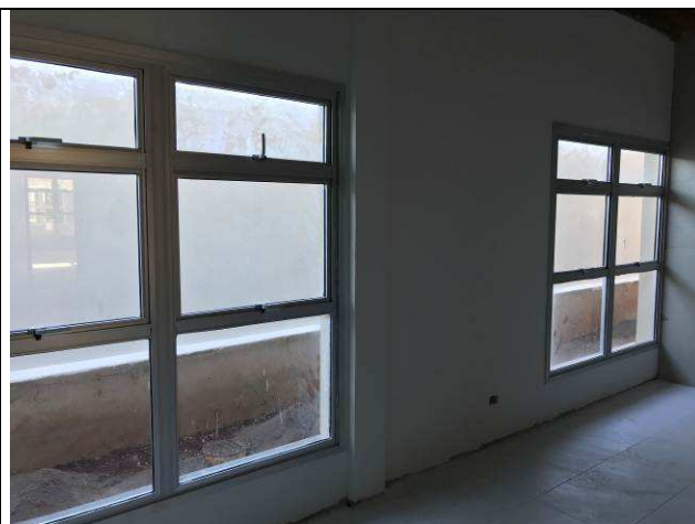
Figura 138C: Emassamento das paredes de alvenaria - copa terceirizados.
