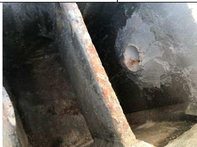
Figura 105C: Caixas de gordura.
