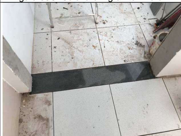
Figura 88C: Soleira em granito - Fórum.
