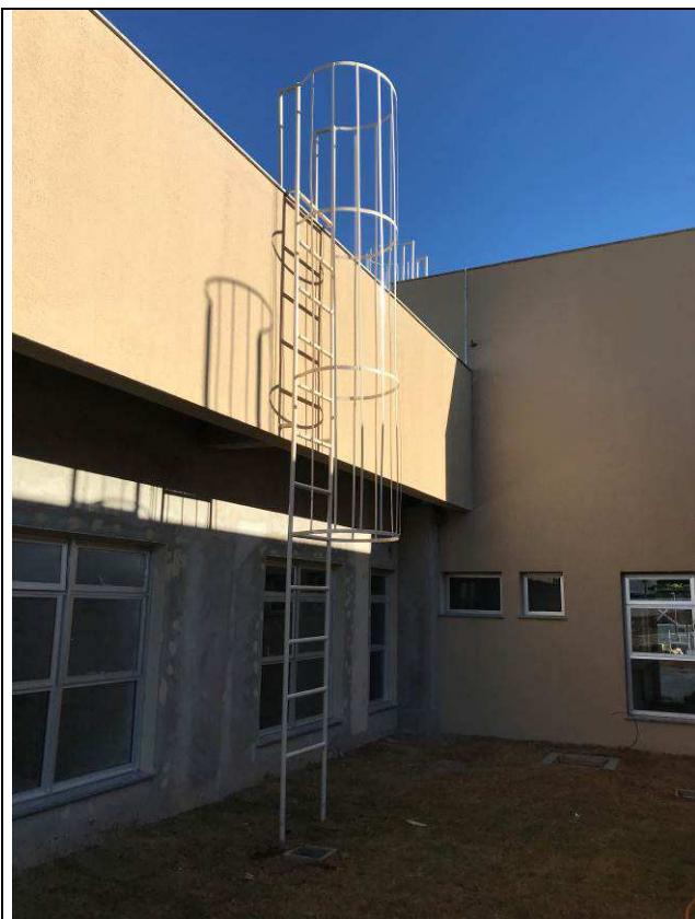
Figura 151C: Escada marinheiro - acesso à cobertura dos módulos do lado direito.
