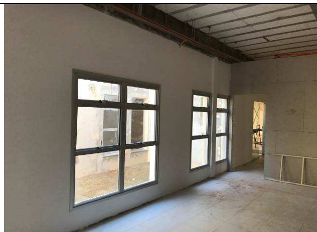
Figura 139C: Emassamento das paredes de alvenaria - Arquivo.
