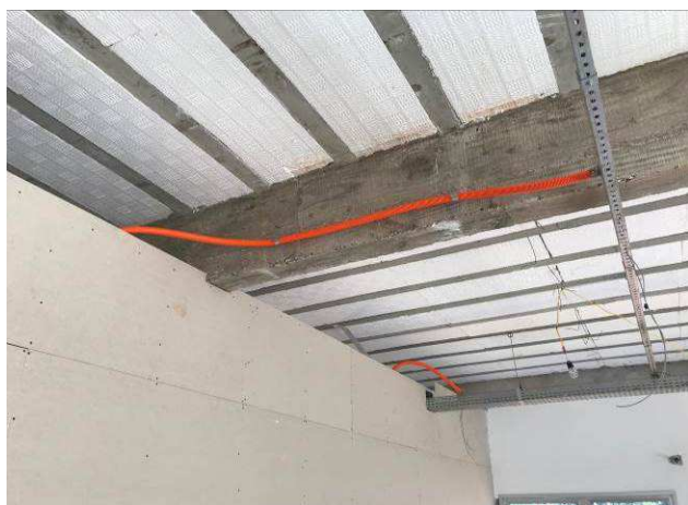
Figura 21E: infraestrutura interna - eletrodutos 1\".
