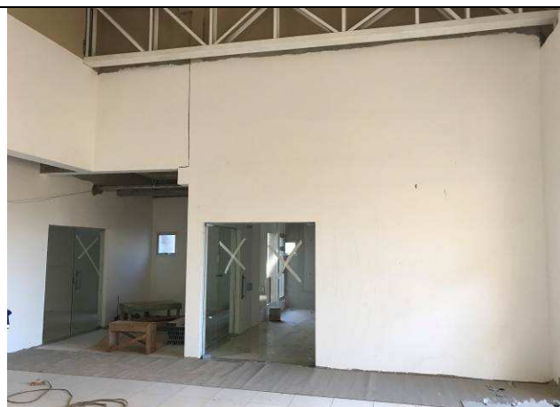
Figura 131C: Emassamento das paredes de alvenaria - hall central.
