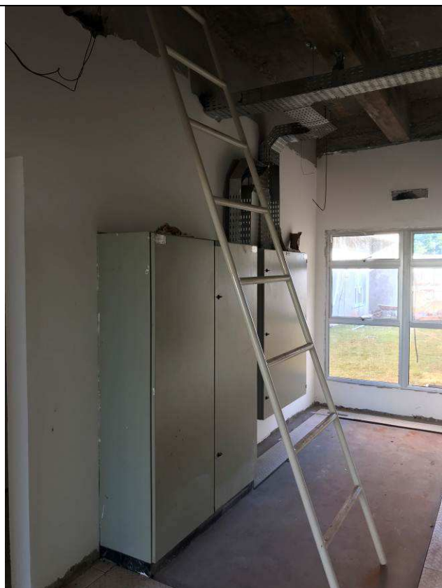
Figura 154C: Escada interna - acesso à laje dos reservatórios.
