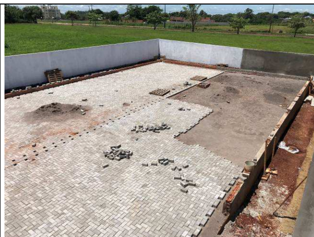
Figura 122C: Pavimentação intertravada - estacionamento dos fundos.
