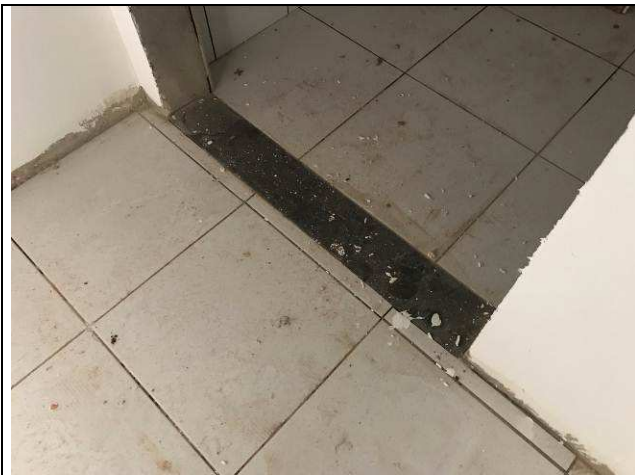
Figura 85C: Soleira em granito - Fórum.
