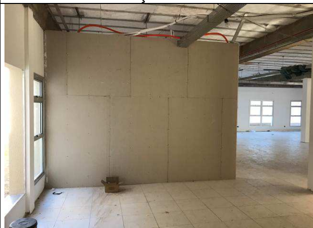
Figura 06C: Paredes de gesso acartonado - Sala de Conciliação - 1ª Vara.
