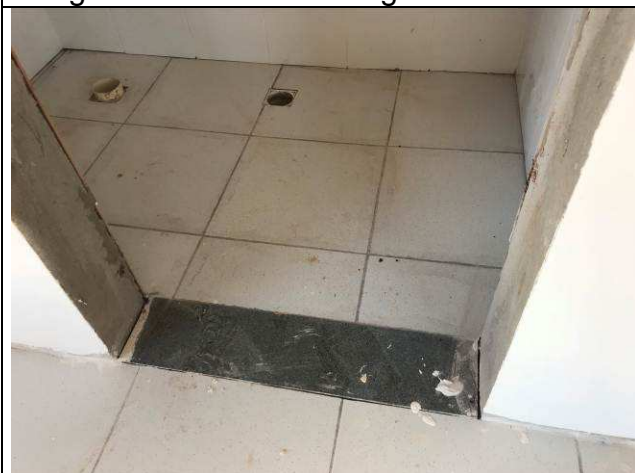
Figura 89C: Soleira em granito - Fórum.
