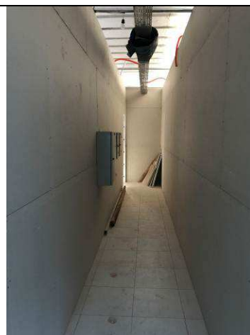
Figura 10C: Paredes de gesso acartonado - Circulação - Terceirizados.
