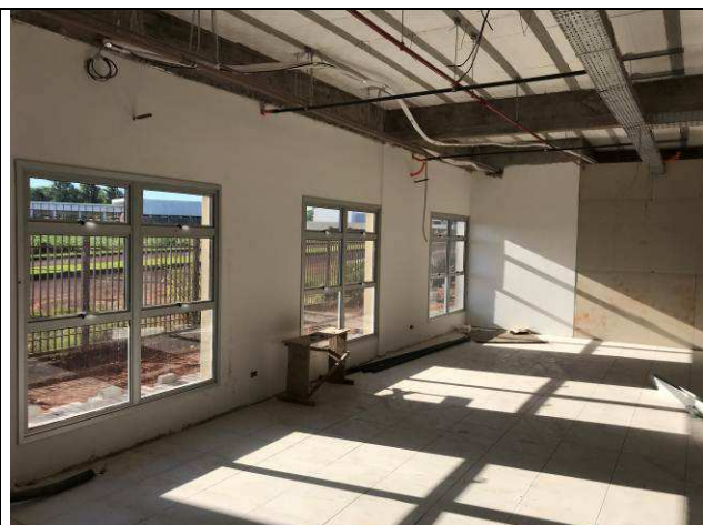
Figura 144C: Emassamento das paredes de alvenaria - Distribuição / Oficiais.
