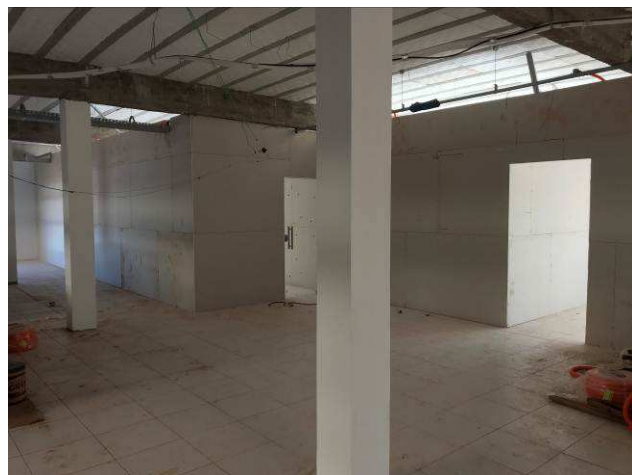
Figura 01C: Paredes de gesso acartonado - PAB's e Distribuição / Sala dos Oficiais.
