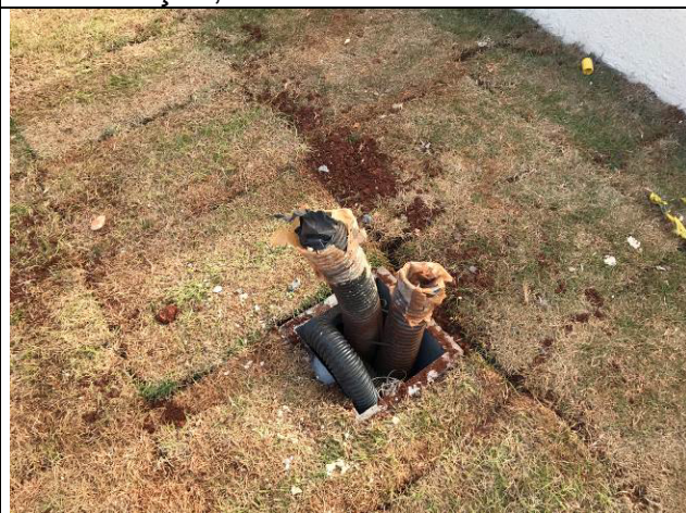
Figura 06E: infraestrutura externa - escavação, eletrodutos PEAD e caixas.
