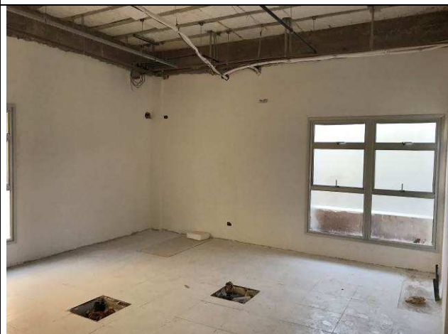
Figura 134C: Emassamento das paredes de alvenaria - 1ª Vara.
