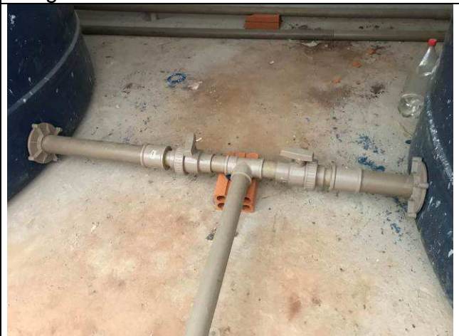
Figura 94C: Conexões - reservatórios.
