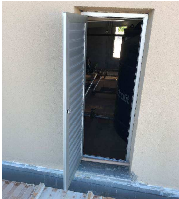
Figura 21C: Porta de Alumínio - Acesso da Sala dos reservatórios para cobertura.
