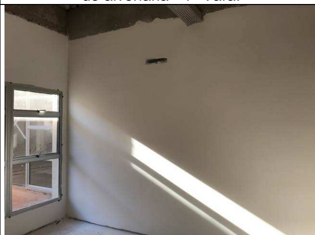
Figura 136C: Emassamento das paredes de alvenaria - 1ª Vara.
