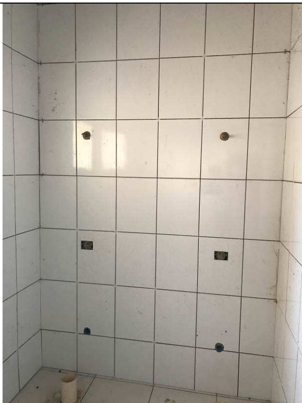
Figura 65C: Azulejos - Banheiros públicos.
