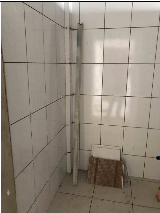
Figura 61C: Azulejos - Banheiros públicos.
