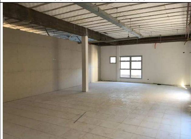
Figura 14C: Paredes de gesso acartonado - Arquivo.
