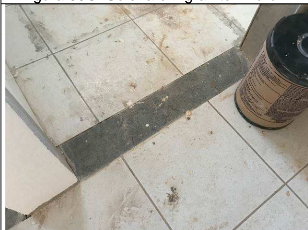
Figura 87C: Soleira em granito - Fórum.
