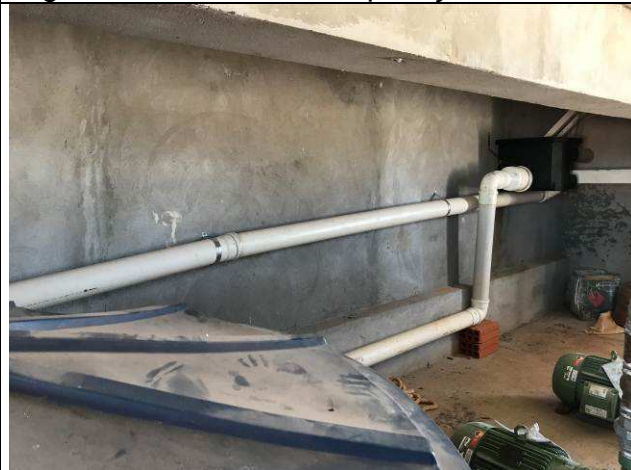
Figura 102C: Sistema de reaproveitamento de água de chuva.
