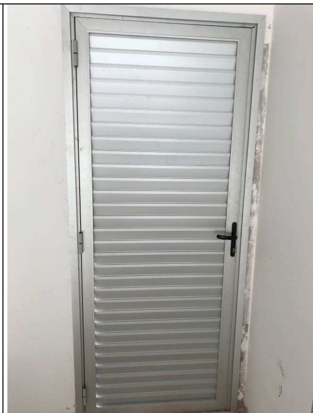
Figura 20C: Porta de Alumínio - saída lateral da Distribuição / Sala dos Oficiais.
