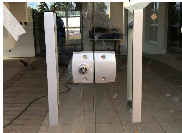
Figura 28C: Porta de Vidro Temperado - Detalhes de fechaduras e puxadores.
