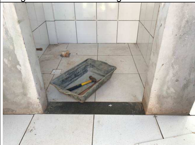
Figura 90C: Soleira em granito - Guarita.
