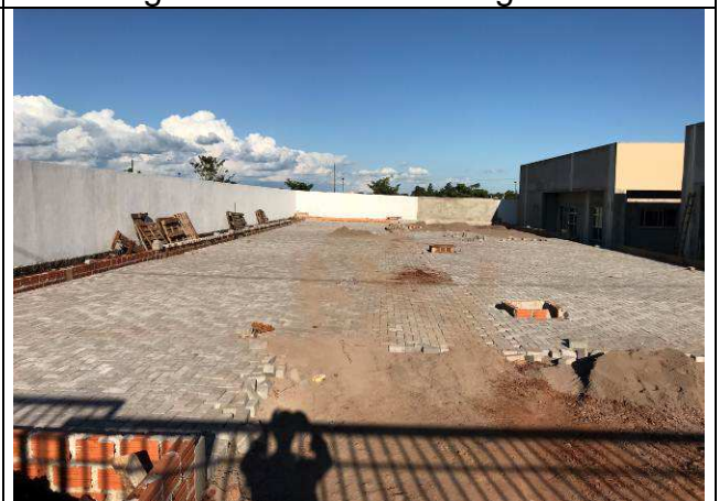
Figura 120C: Pavimentação intertravada - estacionamento dos fundos.
