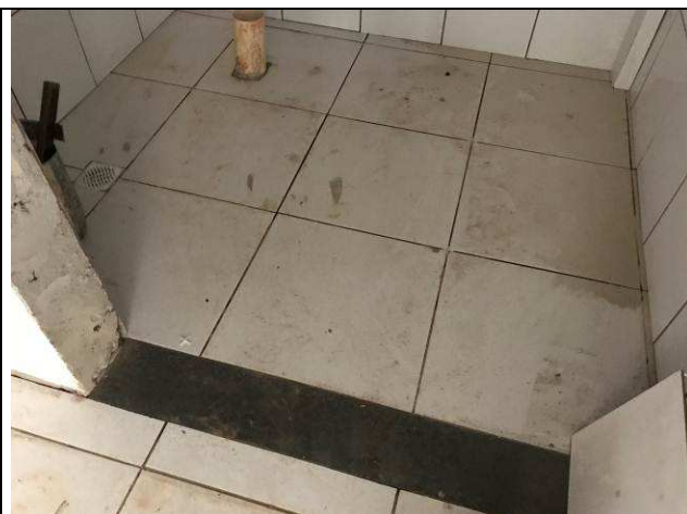
Figura 80C: Piso cerâmico - banheiros públicos.
