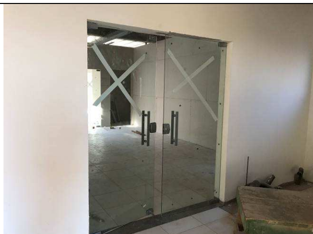
Figura 26C: Porta de Vidro Temperado - entrada Hall da Sala Múltiplo Uso.
