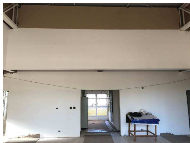
Figura 130C: Emassamento das paredes de alvenaria - hall central.
