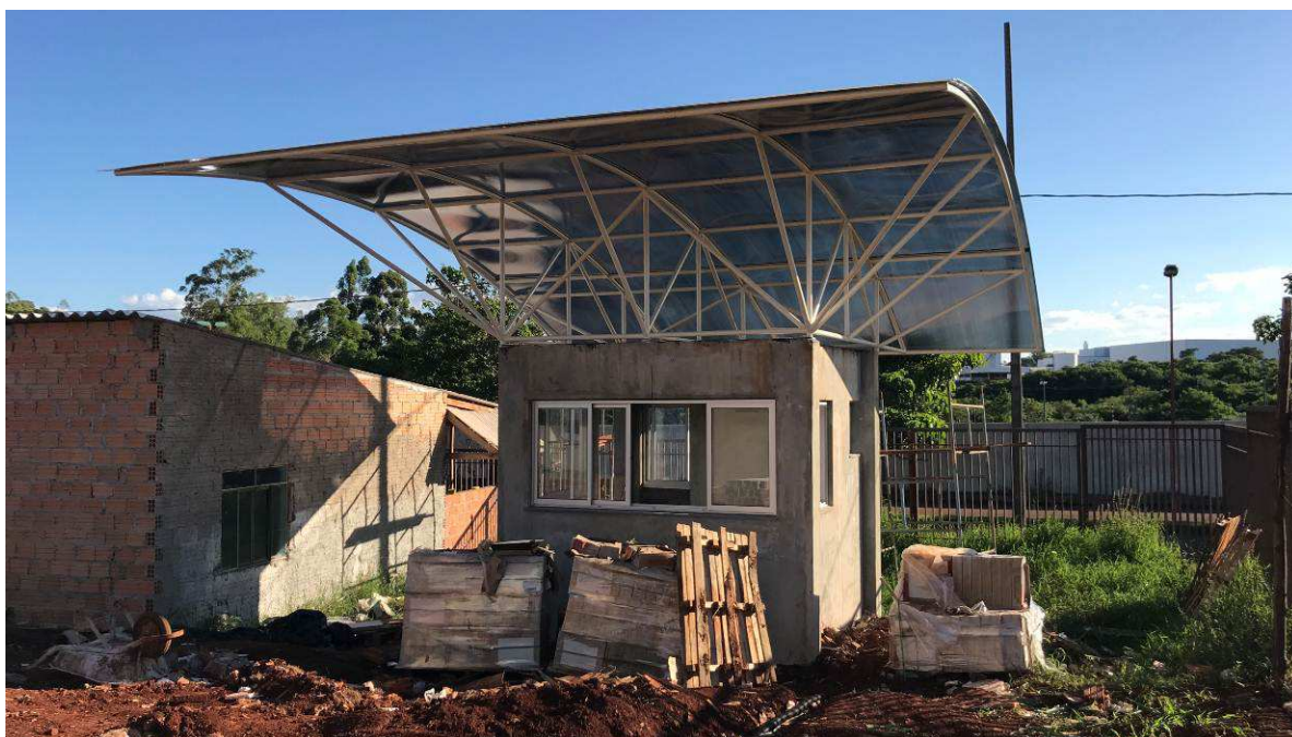
Figura 4 – Guarita - Vista externa.
