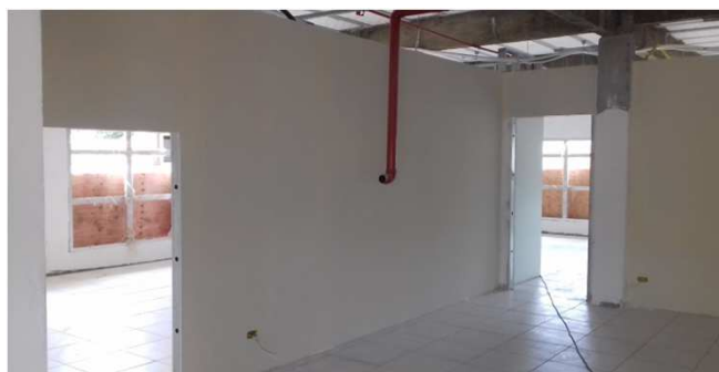
Figura 07C: paredes de gesso acartonado simples (a esquerda) e duplo (a direita), com fechamento de ambas as faces no bloco da direita
