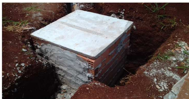
Figura 16C: caixa de inspeção - executada na região do estacionamento esquerdo
