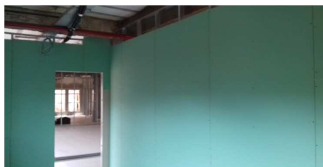
Figura 09C: parede de gesso acartonado verde - copa do bloco esquerdo
