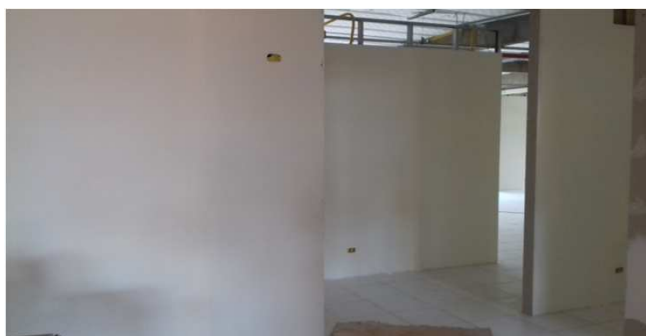
Figura 27C: paredes de dry-wall com primeira demão de pintura já executada - bloco da direita
