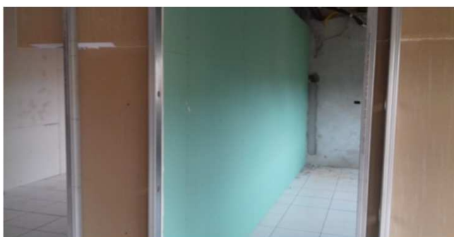
Figura 10C: parede de gesso acartonado verde - copa do bloco esquerdo
