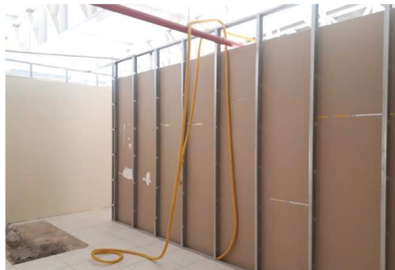
Figura 18E: infraestrutura de eletrodutos - lado esquerdo
