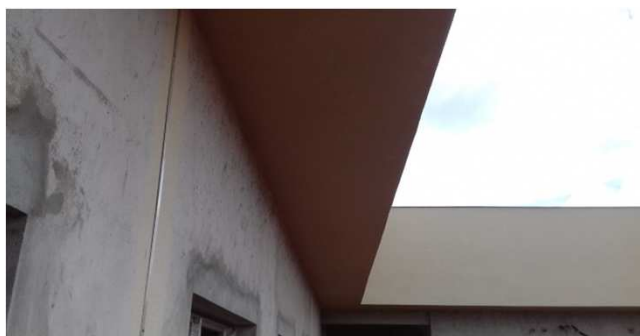
Figura 30C: teto da marquise externa com textura executada
