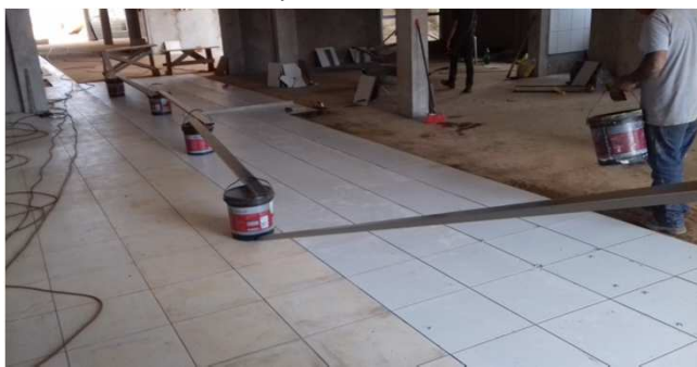
Figura 14C: piso instalado na região do hall público
