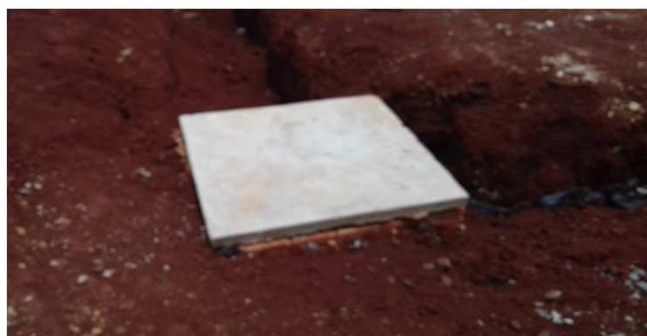
Figura 15C: caixa de inspeção - executada na região do estacionamento esquerdo
