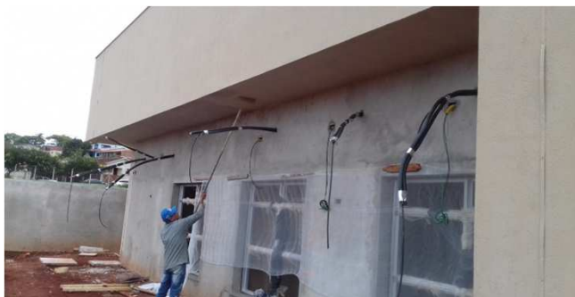
Figura 31C: pintor executando a pintura do teto da marquise
