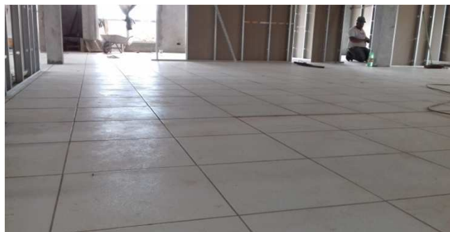
Figura 11C: piso instalado na região da secretaria do bloco esquerdo
