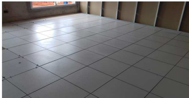
Figura 12C: piso instalado no gabinete do juiz auxiliar - bloco esquerdo
