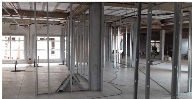
Figura 02C: início da execução das paredes de dry-wall no bloco esquerdo - estrutura
