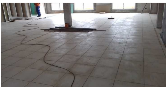
Figura 13C: piso instalado na região da secretaria do bloco esquerdo
