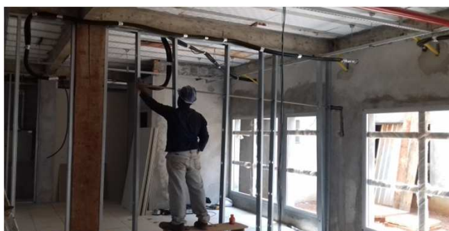
Figura 19C: operário instalando dreno em sala de audiência 2 - Bloco esquerdo
