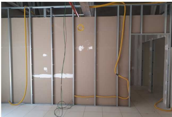
Figura 17E: infraestrutura de eletrodutos - lado esquerdo
