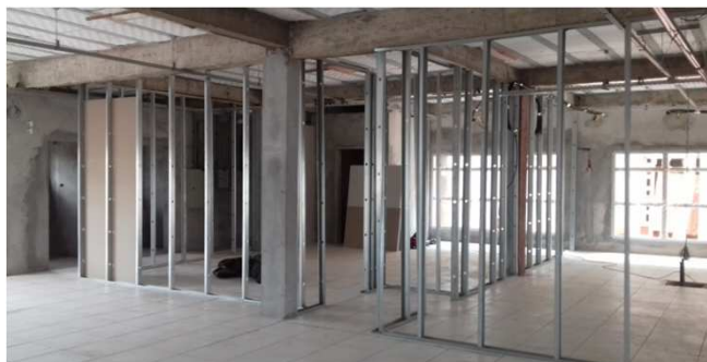
Figura 01C: início da execução das paredes de dry-wall no bloco esquerdo - estrutura
