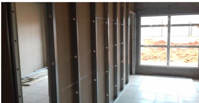
Figura 04C: fechamento de uma das faces de paredes de gesso acartonado dupla - bloco esquerdo
