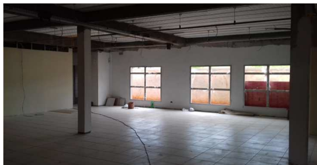
Figura 26C: emassamento de paredes externas - bloco da direita
