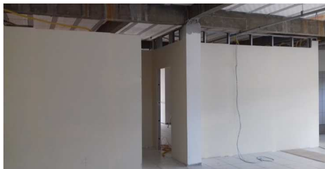
Figura 06C: paredes de gesso acartonado simples com fechamento das duas faces - bloco da direita
