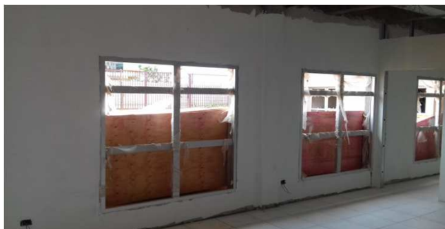
Figura 25C: emassamento de paredes externas - bloco da direita
