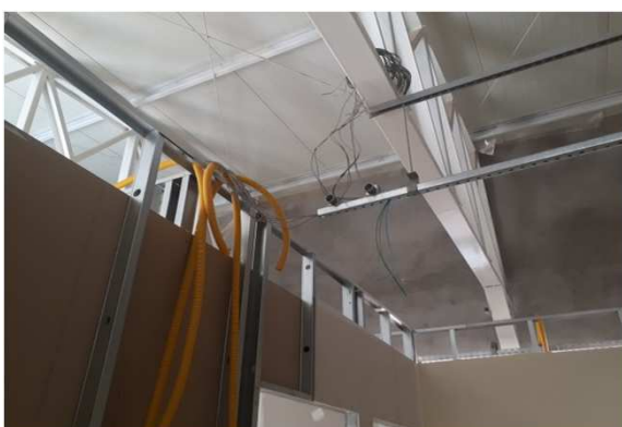
Figura 19E: infraestrutura de eletrodutos - lado esquerdo
