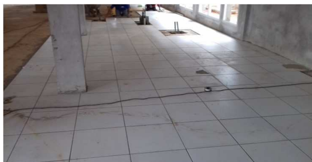
Figura 22C: instalação de piso cerâmico - bloco da esquerda
