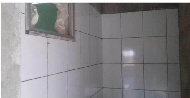
Figura 13C: aplicação de azulejo - sanitários públicos
