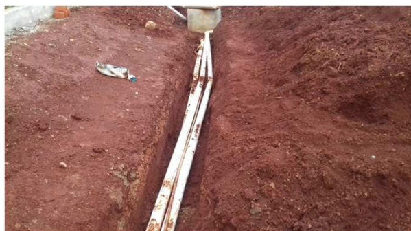
Figura 04C: tubulação de esgoto - vala pronta para ser fechada
