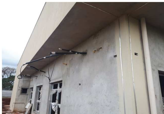
Figura 08E: infraestrutura de eletrodutos e caixas 2x4" área externa
