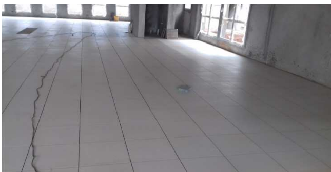
Figura 19C: piso instalado na sala múltiplo-uso
