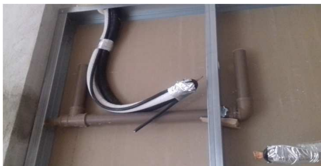
Figura 25C: rede frigorígena e drenos para dois aparelhos - audiência e gab juiz aux.
