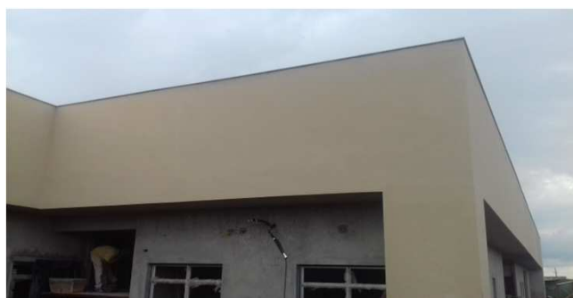
Figura 34C: textura aplicada em platibanda - parte frontal e lateral esquerda
