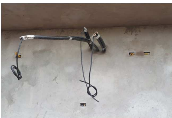
Figura 09E: infraestrutura de eletrodutos e caixas 2x4" área externa
