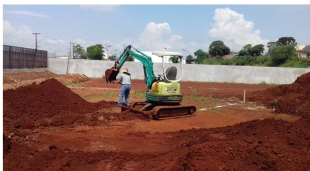
Figura 03C: máquina realizando a abertura de vala no estacionamento da esquerda
