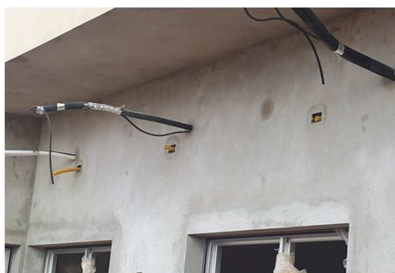
Figura 10E: infraestrutura de eletrodutos e caixas 2x4" área externa
