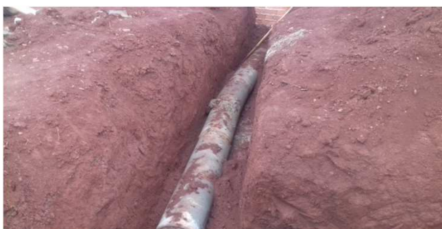
Figura 23C: tubulação pluvial de concreto - 400mm, estacionamento da esquerda
