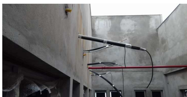
Figura 31C: redes frigorígenas saindo para o fosso de luz
