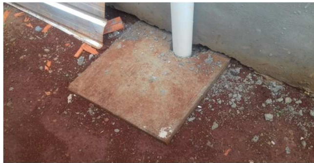
Figura 40C: caixa de inspeção em alvenaria - tamanho 40x40x40cm
