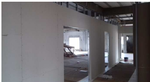
Figura 07C: parede de gesso acartonado simples - secretaria
