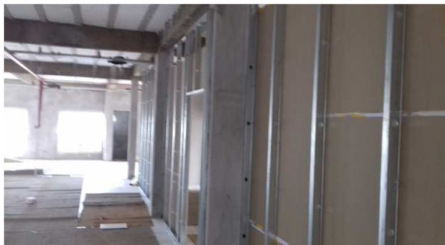
Figura 06C: parede de gesso acartonado simples - secretaria
