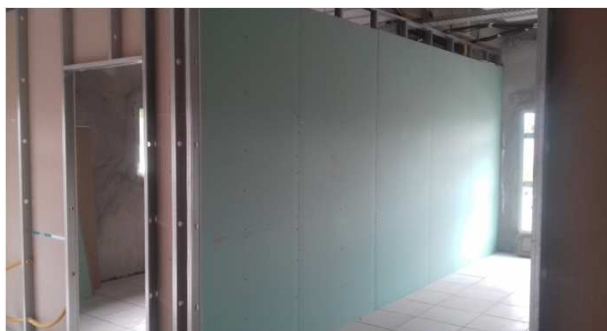
Figura 09C: parede de gesso acartonado verde - copa
