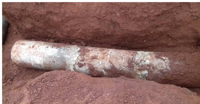
Figura 24C: tubulação pluvial de concreto - 400mm, estacionamento da esquerda
