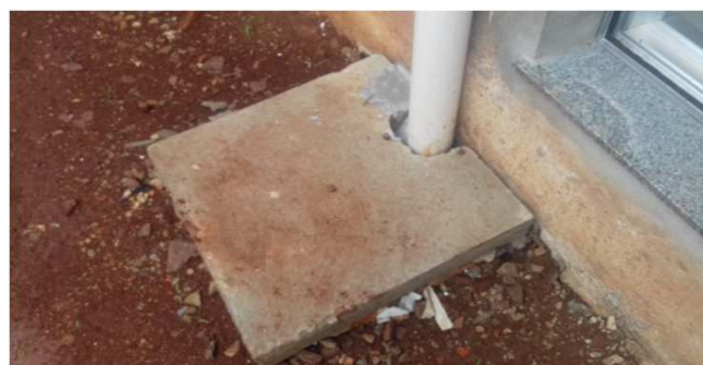
Figura 39C: caixa de inspeção em alvenaria - tamanho 40x40x40cm
