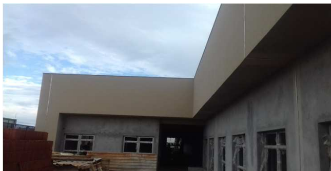
Figura 35C: textura aplicada em platibanda - parte frontal - bloco da direita
