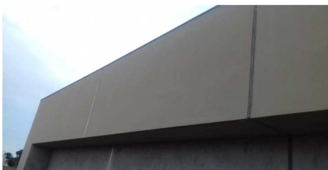
Figura 33C: textura aplicada em platibanda - parte frontal
