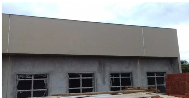
Figura 36C: textura aplicada em platibanda - lateral direita
