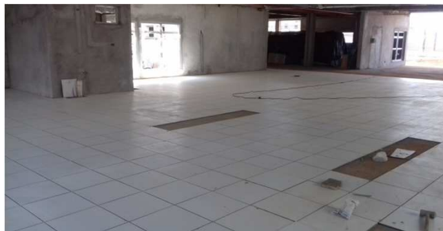
Figura 20C: piso instalado na sala múltiplo-uso
