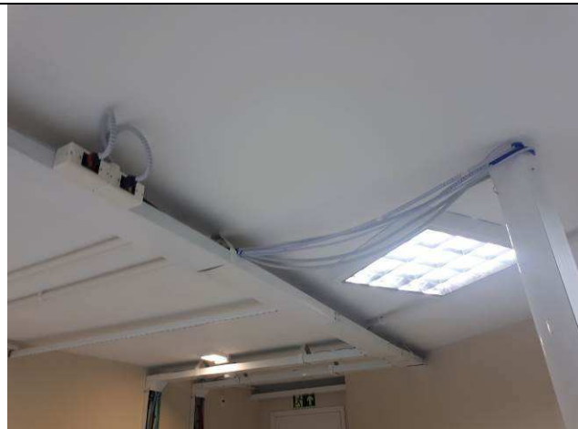
Figura 07E: tomadas elétricas e lógicas, acabamento fita espiral
