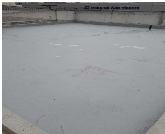
Figura 17C: Manta líquida aplicada.
