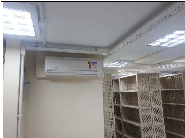
Figura 03E: infraestrutura de condutores, eletrodutos, eletrocalhas, perfilados.
