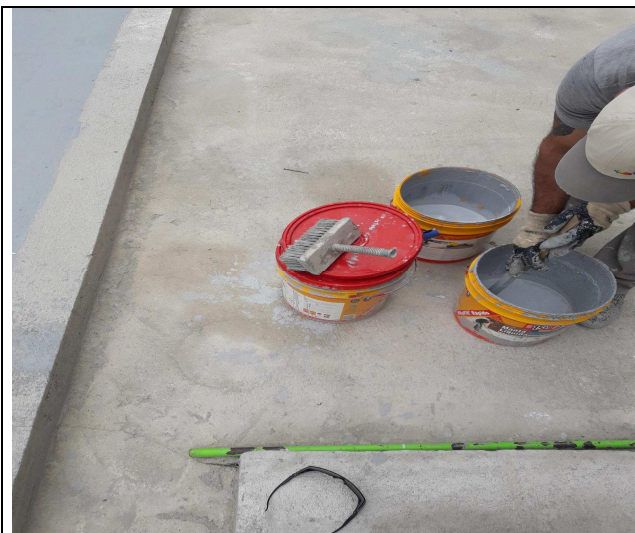
Figura 15C: Aplicação manta líquida.
