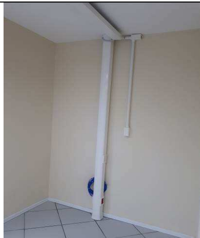
Figura 08E: tomadas elétricas e lógicas, acabamento fita espiral
