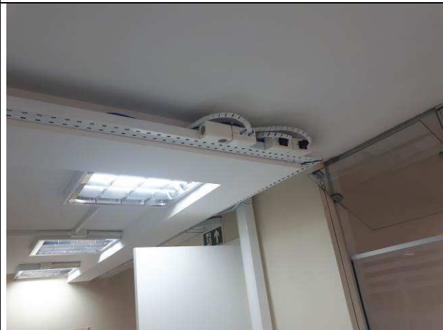
Figura 10E: ramais alimentadores e cabos elétricos circuitos estabilizados
