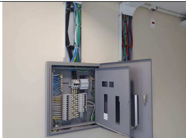
Figura 09E: ramais alimentadores e cabos elétricos circuitos rede comum e iluminação
