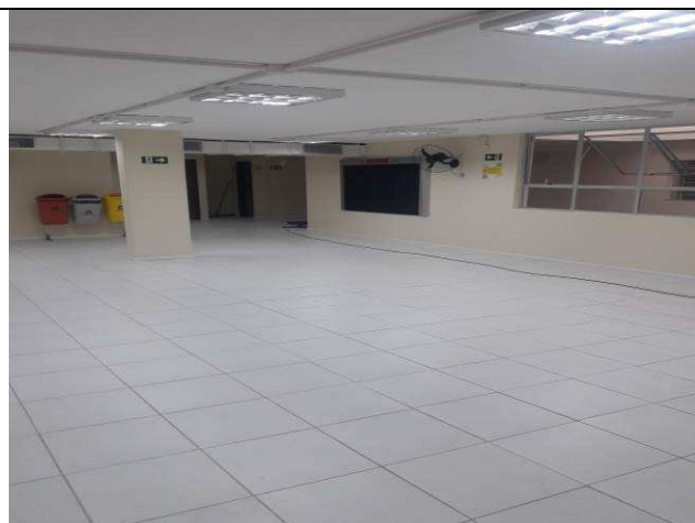
Figura 02C: piso completamente assentado.
