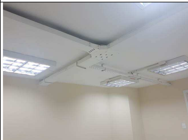
Figura 04E: infraestrutura de condutores, eletrodutos, eletrocalhas, perfilados.
