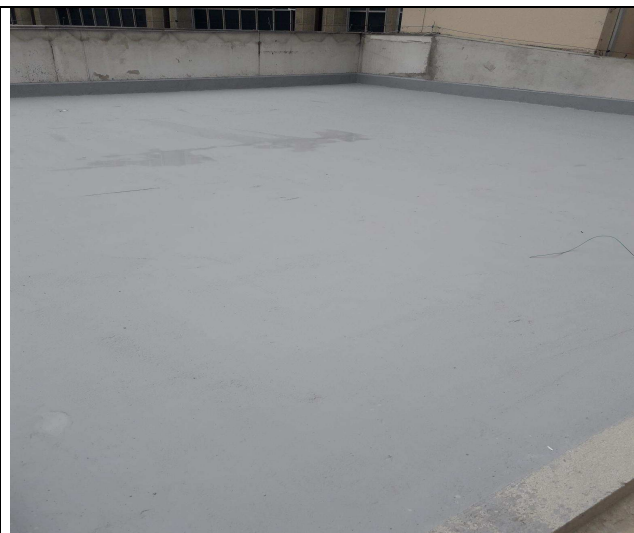
Figura 16C: Manta líquida aplicada.
