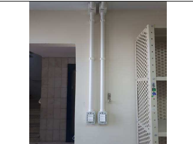
Figura 09E: ramais alimentadores e cabos elétricos circuitos rede comum e iluminação
