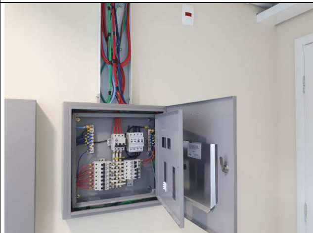
Figura 10E: ramais alimentadores e cabos elétricos circuitos estabilizados
