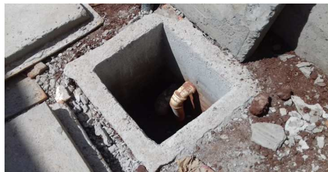
Figura 22C: caixa de inspeção de esgoto 60x60mm (fundos)
