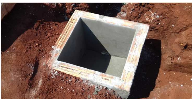
Figura 19C: caixa de inspeção de esgoto 60x60mm (frontal)
