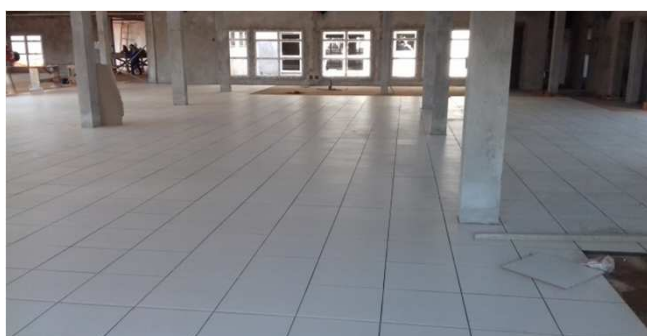
Figura 13C: instalação de piso cerâmico - bloco da direita
