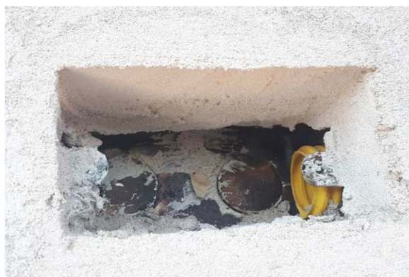
Figura 04E: caixas 2x4" par ailuminação externa
