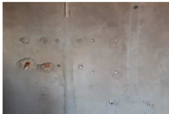
Figura 12E: Fixação quadros elétricos
