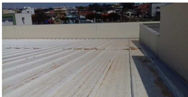
Figura 06C: instalação de telhas no bloco esquerdo
