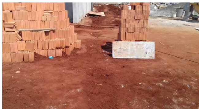
Figura 03C: vala já fechada após instalação de tubulação - lateral direita
