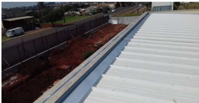
Figura 10C: rufo transversal - bloco esquerdo
