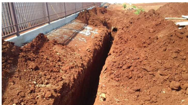
Figura 02C: abertura de vala para instalação de tubulação de esgoto - frente
