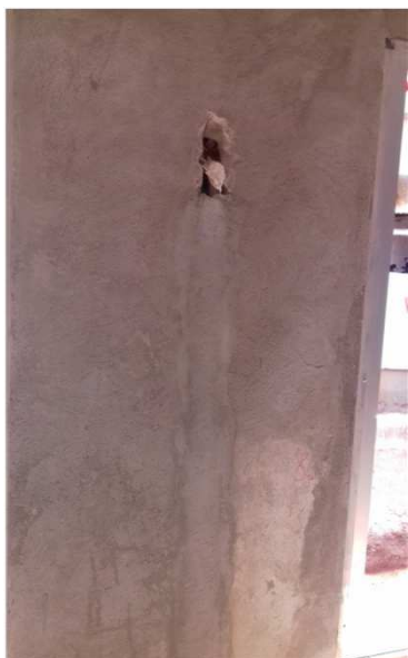
Figura 25C: Dreno executado em parede da secretaria - Bloco esquerdo
