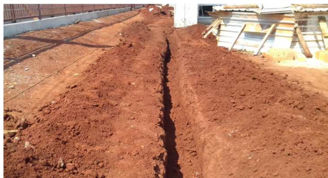
Figura 01C: abertura de vala para instalação de tubulação de esgoto - frente
