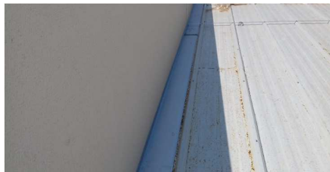
Figura 08C: rufo lateral, no bloco esquerdo
