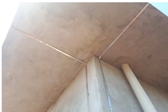
Figura 26E: SPDA tipo Faraday, fitas alumínio, descidas, curvas, fixação
