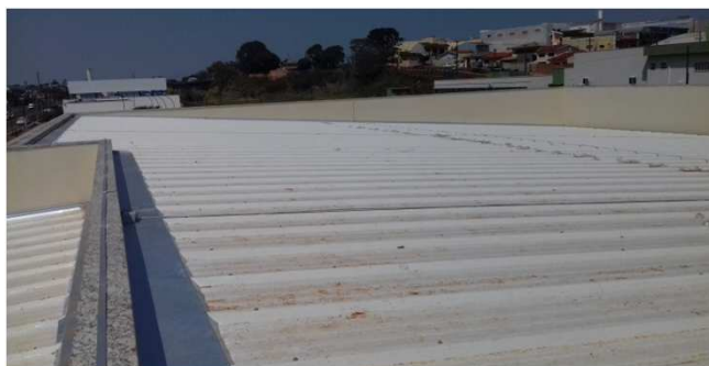
Figura 05C: instalação de telhas no bloco esquerdo
