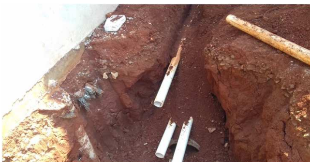
Figura 16C: tubulação de esgoto - 100mm, parte frontal
