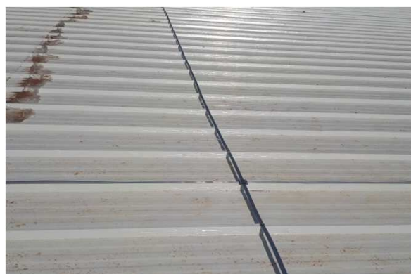
Figura 21E: SPDA tipo Faraday, fitas alumínio, descidas, curvas, fixação
