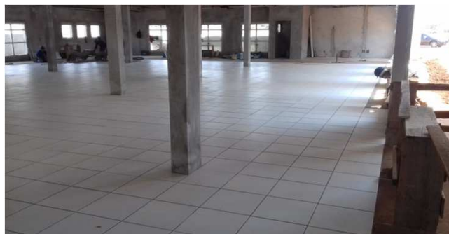
Figura 12C: instalação de piso cerâmico - bloco da direita
