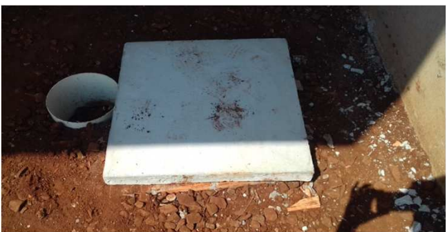
Figura 23C: caixa de inspeção de esgoto 60x60mm (fundos)
