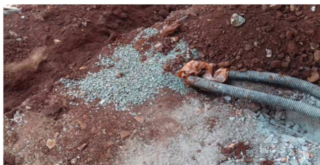
Figura 28C: Broca executada e preenchida com brita, para descarga do dreno
