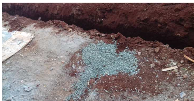
Figura 29C: Broca executada e preenchida com brita, para descarga do dreno
