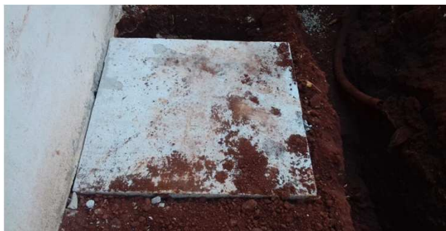
Figura 21C: caixa de inspeção de esgoto 60x60mm (fundos)
