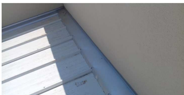
Figura 09C: rufo transversal - bloco esquerdo (recorte de platibanda)
