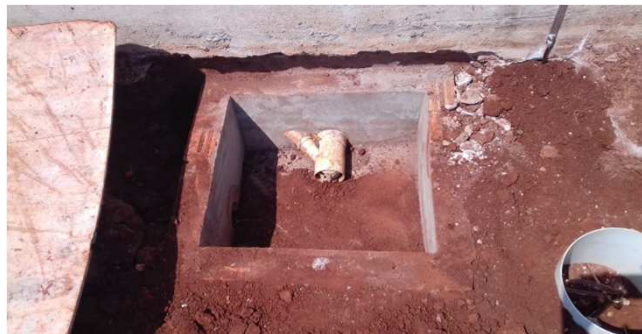
Figura 18C: caixa de inspeção de esgoto 60x60mm (vazio central)
