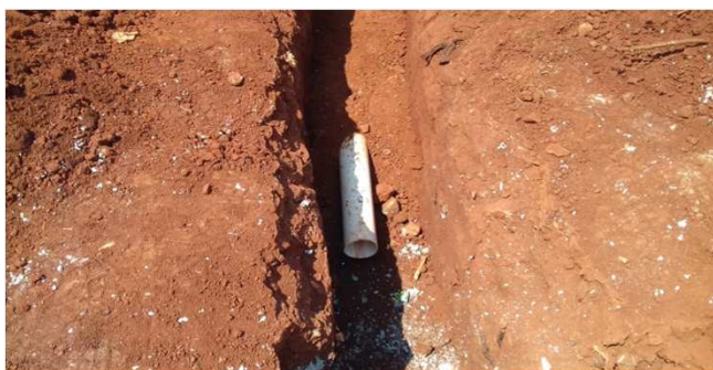
Figura 15C: tubulação de esgoto - 100mm, parte frontal
