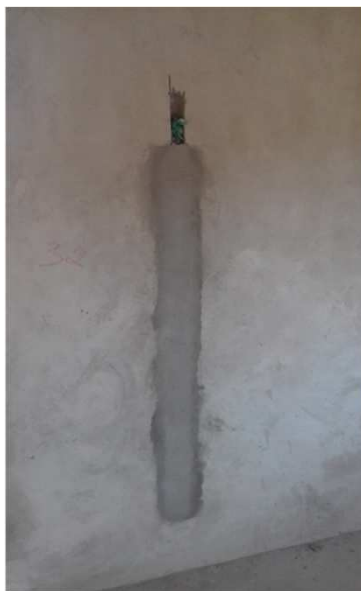
Figura 26C: Dreno executado em parede da secretaria - Bloco da direita
