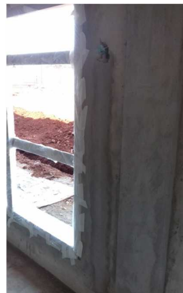
Figura 27C: Dreno executado em parede - bloco da esquerda
