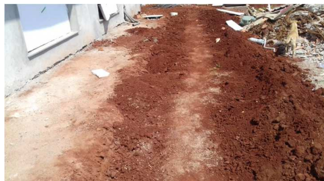
Figura 04C: vala já fechada após instalação de tubulação - lateral direita
