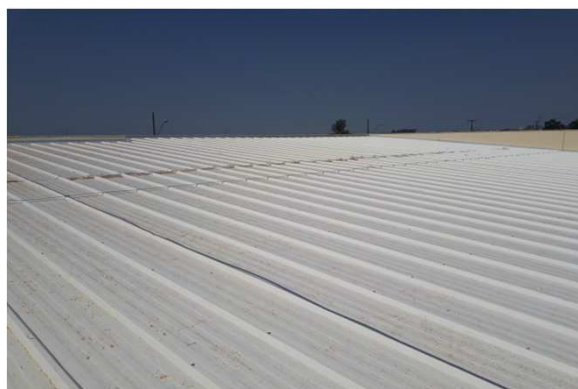
Figura 18E: SPDA tipo Faraday, fitas alumínio, descidas, curvas, fixação
