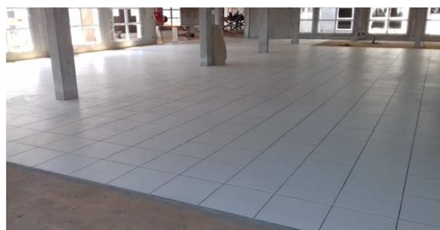
Figura 14C: instalação de piso cerâmico - bloco da direita
