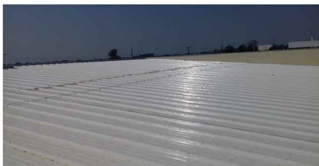
Figura 07C: instalação de telhas no bloco esquerdo
