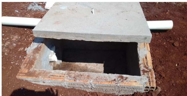
Figura 17C: caixa de inspeção de esgoto 60x60mm (fundos)
