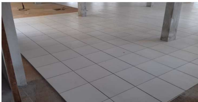
Figura 11C: instalação de piso cerâmico - bloco da direita
