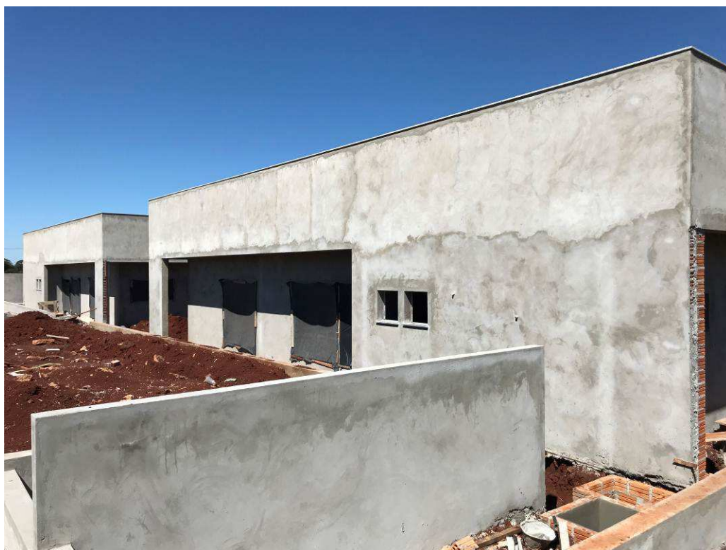
Figura 2 – Fórum - Vista externa.
