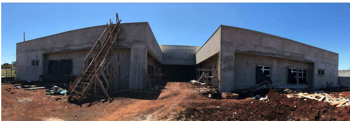
Figura 1 – Fórum - Vista externa.
