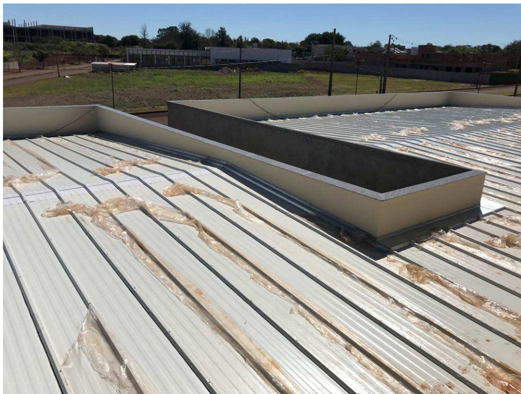
Figura 3 – Fórum - Vista externa - Cobertura.
