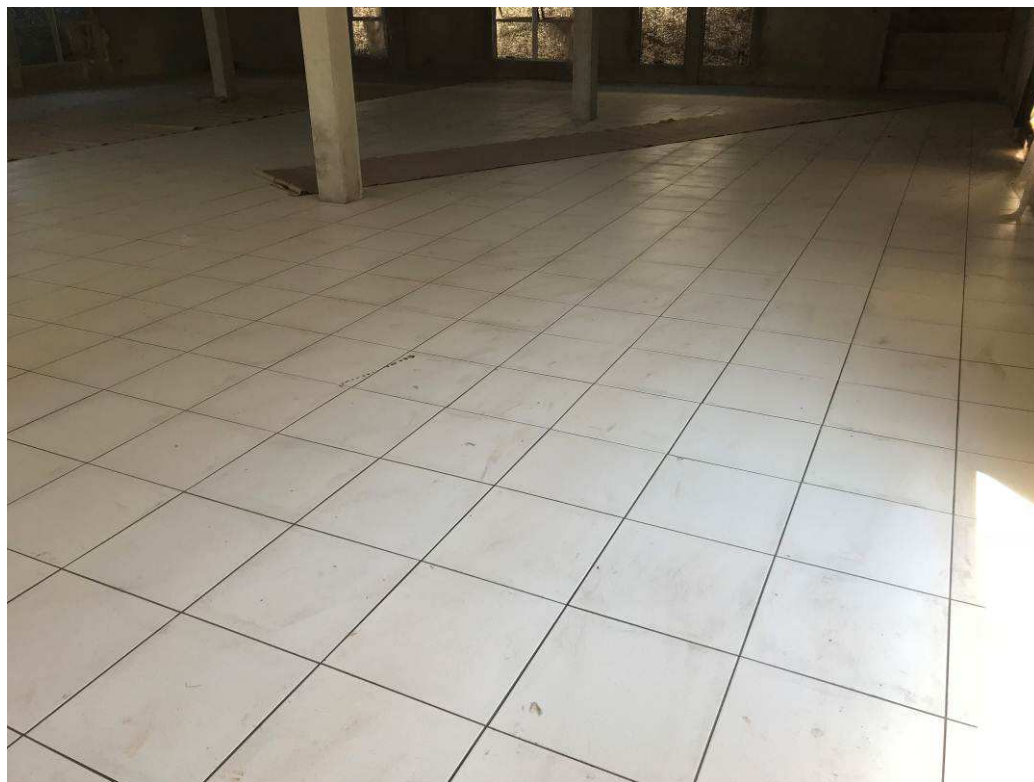
Figura 4 – Fórum - Vista interna.
