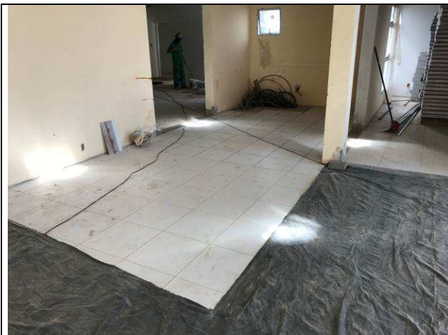
Figura 34C: Piso cerâmico - hall Fórum.
