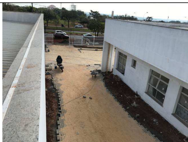
Figura 68C: Pavimentação intertravada - estacionamentos.
