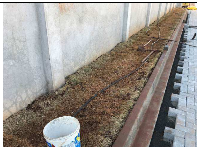
Figura 61C: Grama plantada - muro dos fundos do estacionamento.
