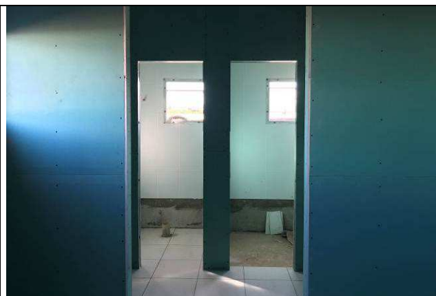
Figura 12C: Paredes de gesso acartonado - sanitários e vestiários do Arquivo.
