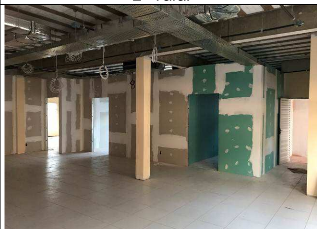
Figura 04C: Paredes de gesso acartonado - 2ª Vara.
