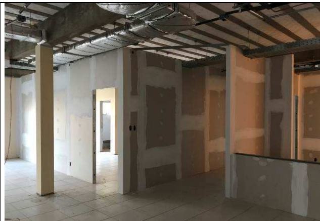
Figura 03C: Paredes de gesso acartonado - 2ª Vara.
