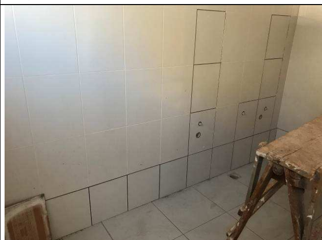
Figura 27C: Azulejos - banheiros públicos.
