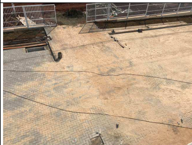
Figura 69C: Pavimentação intertravada - estacionamentos.
