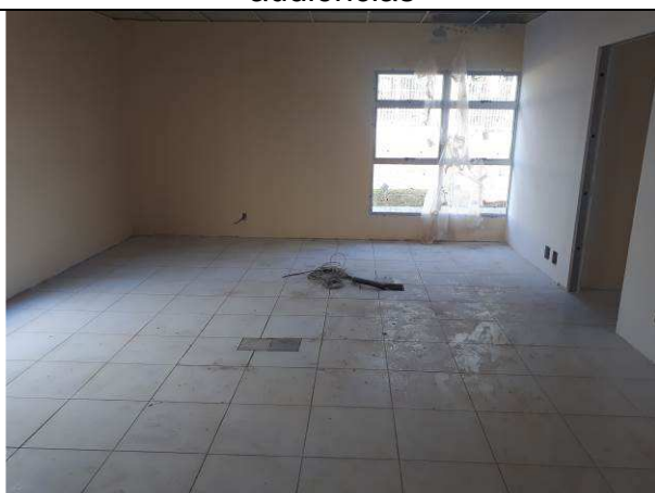
Figura 05E: infraestrutura - salas de audiências
