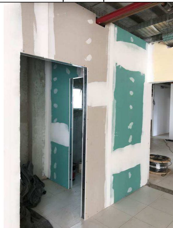
Figura 11C: Paredes de gesso acartonado - sala de apoio administrativo - hall Fórum.
