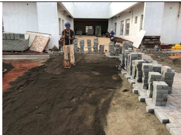
Figura 66C: Pavimentação intertravada - estacionamentos.
