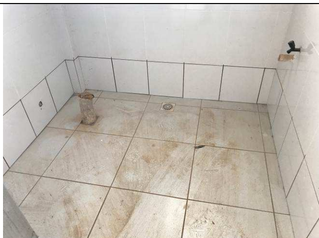
Figura 32C: Azulejos - banheiro da secretaria da 3ª Vara.
