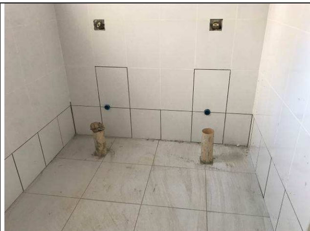
Figura 25C: Azulejos - banheiros públicos.
