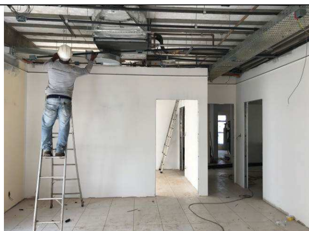
Figura 88C: Emassamento das paredes internas - 2ª Vara.
