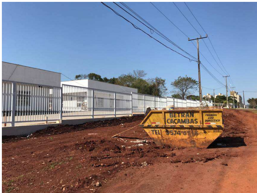
Figura 01C: Caçamba para retirada de entulhos.
