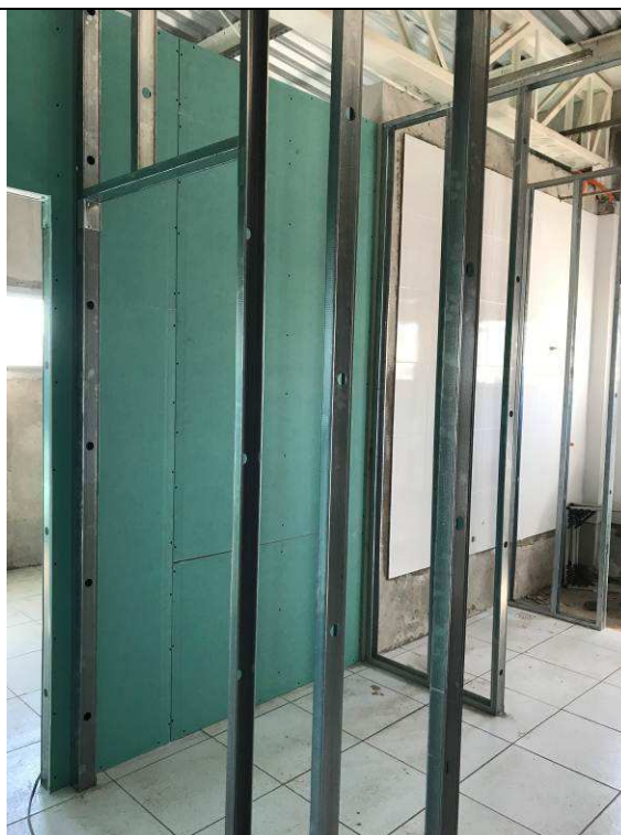
Figura 09C: Paredes de gesso acartonado - copa do Arquivo.
