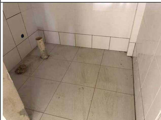
Figura 38C: Piso cerâmico - bwc público.
