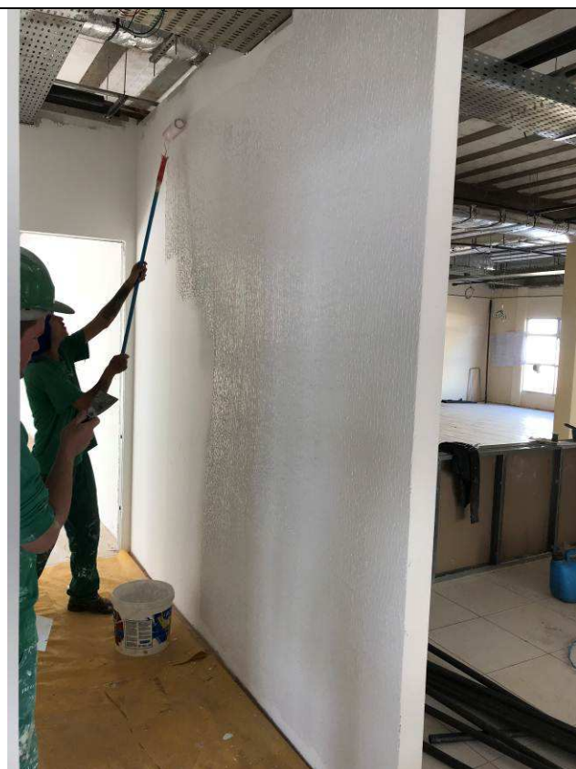
Figura 84C: Emassamento das paredes internas - 2ª Vara.
