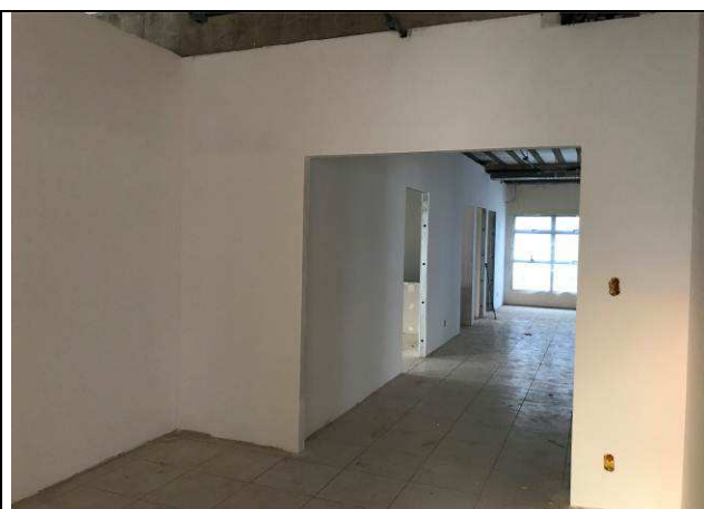
Figura 81C: Emassamento das paredes internas - sala de Espera.
