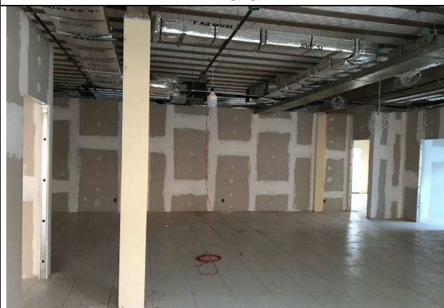
Figura 06C: Paredes de gesso acartonado - 2ª Vara.
