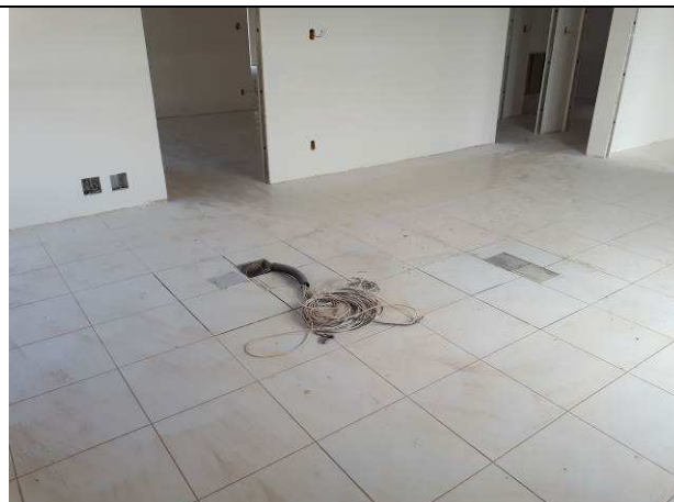
Figura 04E: infraestrutura - salas de audiências
