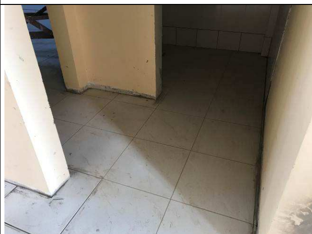
Figura 37C: Piso cerâmico - banheiros públicos.
