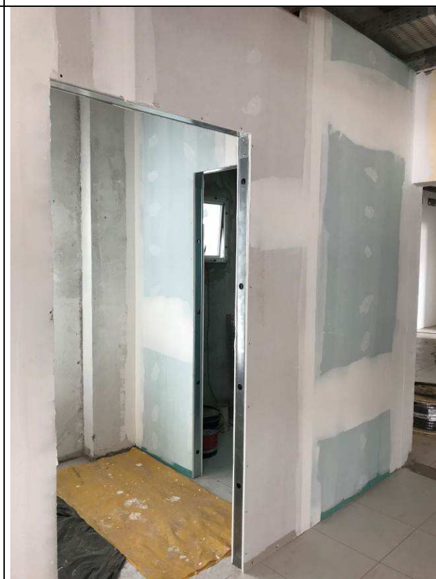
Figura 85C: Emassamento das paredes internas - sala de apoio adm. hall.
