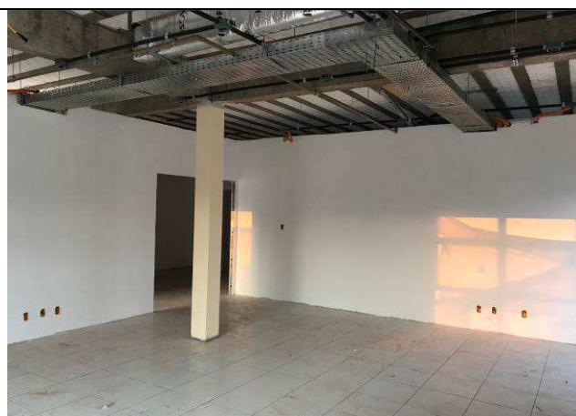
Figura 80C: Emassamento das paredes internas - sala Múltiplo Uso.
