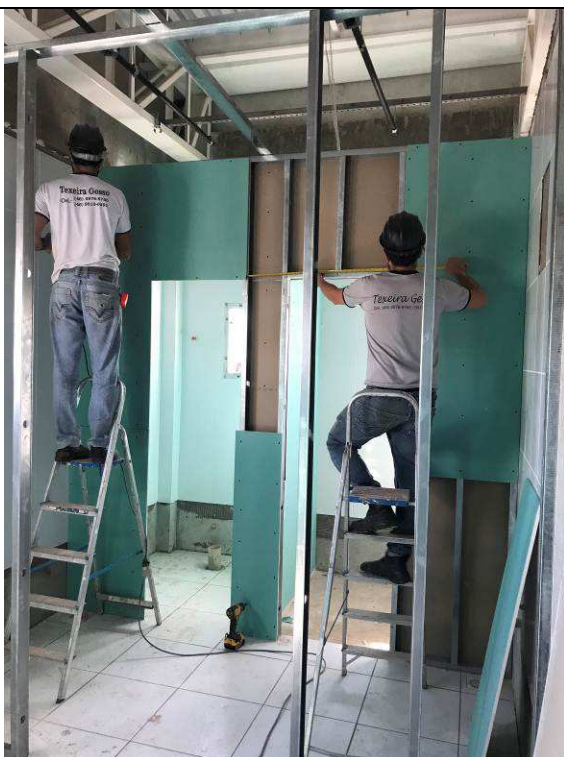
Figura 08C: Paredes de gesso acartonado - sanitários do Arquivo.
