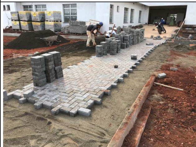
Figura 67C: Pavimentação intertravada - estacionamentos.
