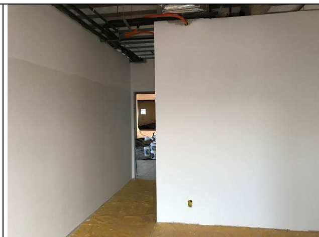
Figura 83C: Emassamento das paredes internas - sala de Perícias.
