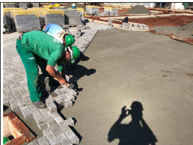
Figura 77C: Pavimentação intertravada - estacionamentos.
