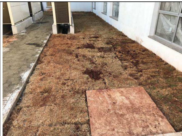
Figura 59C: Grama plantada - área das condensadoras de ar condicionado.
