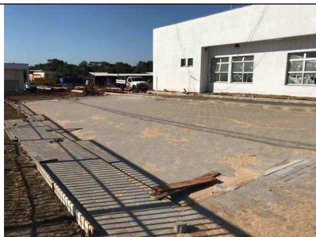
Figura 76C: Pavimentação intertravada - estacionamentos.
