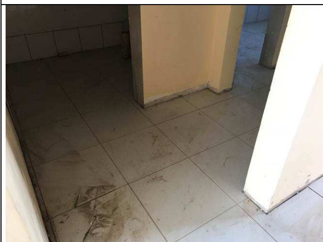
Figura 36C: Piso cerâmico - banheiros públicos.
