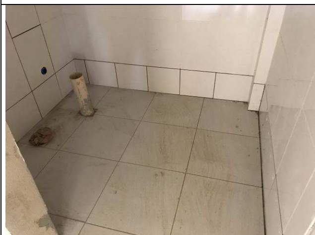
Figura 26C: Azulejos - banheiros públicos.
