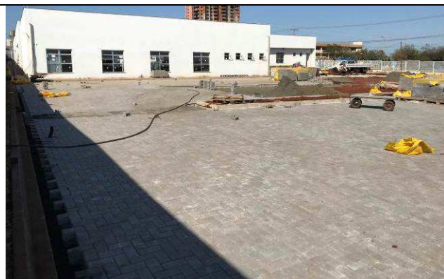
Figura 78C: Pavimentação intertravada - estacionamentos.
