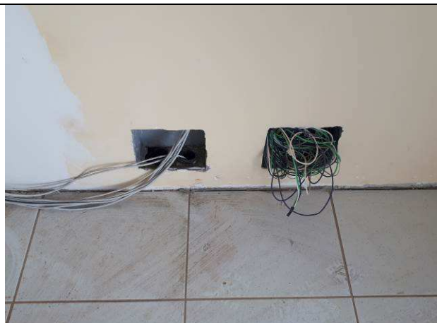
Figura 03E: infraestrutura - salas de audiências
