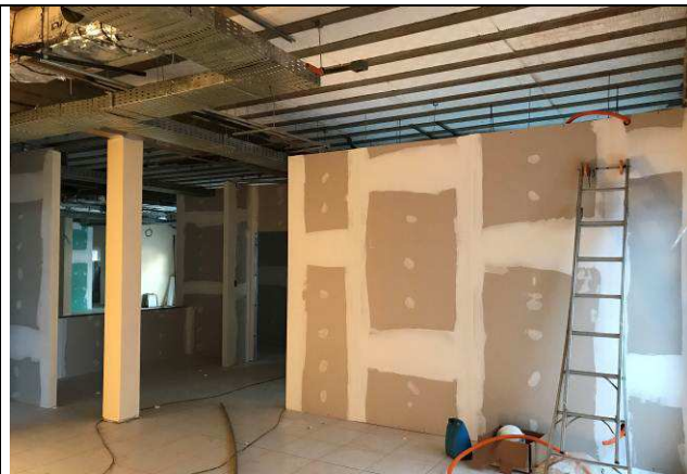
Figura 02C: Paredes de gesso acartonado - 2ª Vara.
