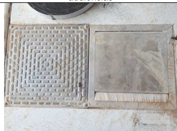
Figura 06E: infraestrutura - salas de audiências
