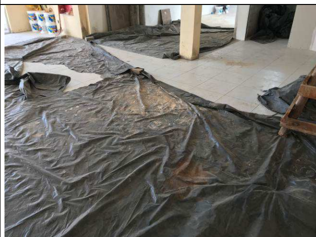
Figura 39C: Piso cerâmico - hall Fórum.
