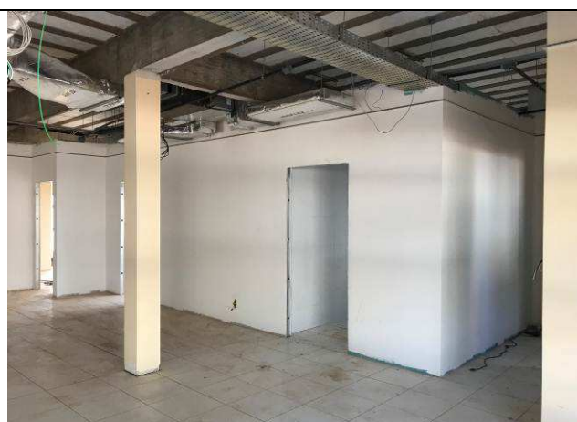
Figura 90C: Emassamento das paredes internas - 2ª Vara.
