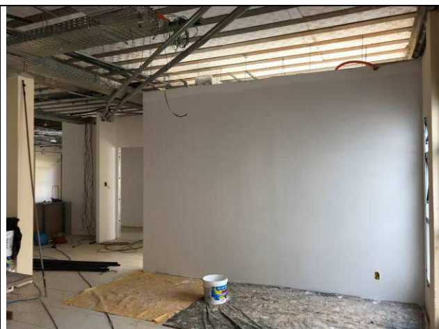
Figura 87C: Emassamento das paredes internas - 2ª Vara.
