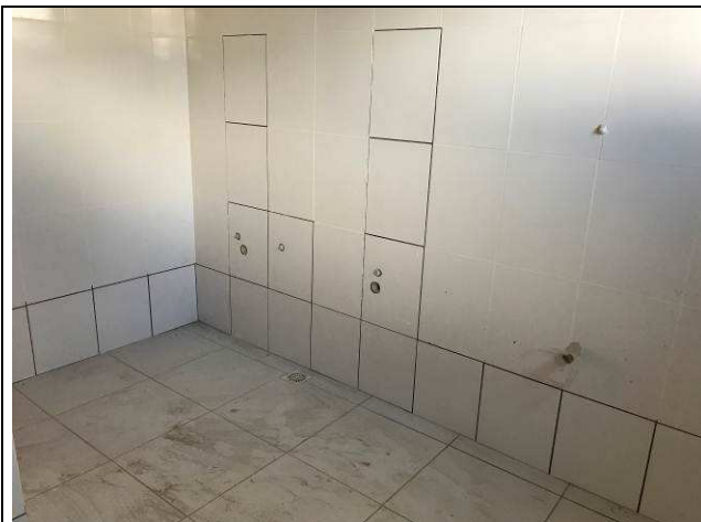
Figura 24C: Azulejos - banheiros públicos.
