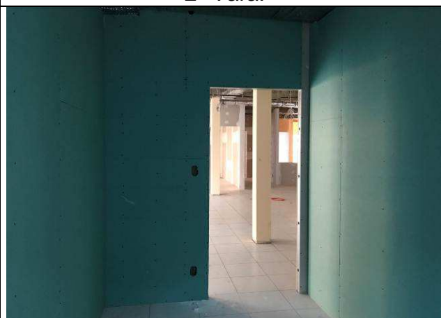
Figura 05C: Paredes de gesso acartonado - 2ª Vara.
