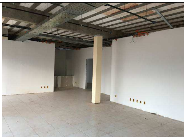
Figura 82C: Emassamento das paredes internas - sala Distribuição / Oficiais.
