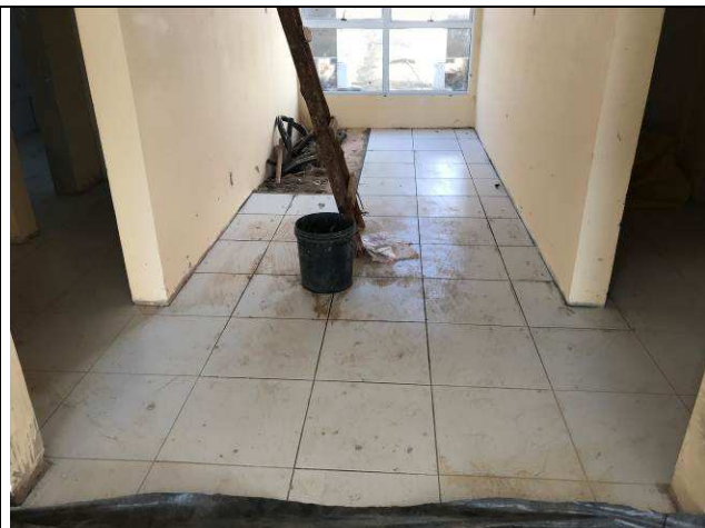
Figura 35C: Piso cerâmico - hall Fórum.
