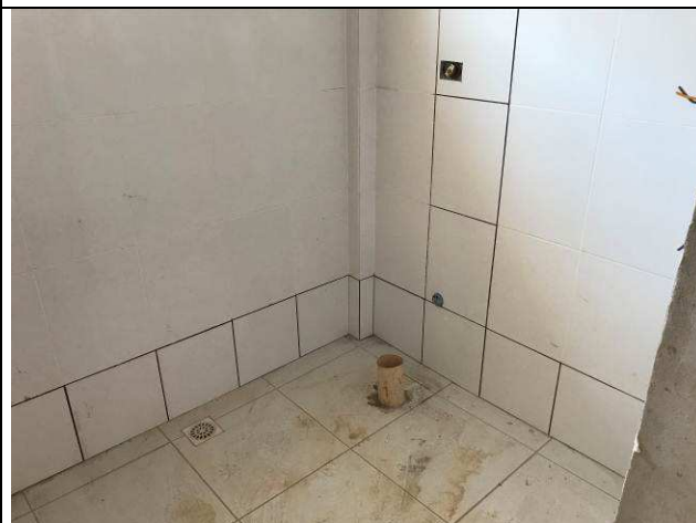
Figura 33C: Azulejos - banheiro da secretaria da 3ª Vara.
