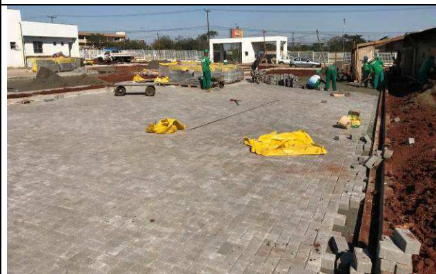
Figura 79C: Pavimentação intertravada - estacionamentos.
