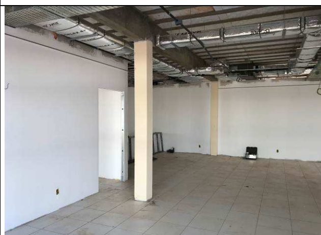
Figura 91C: Emassamento das paredes internas - 2ª Vara.
