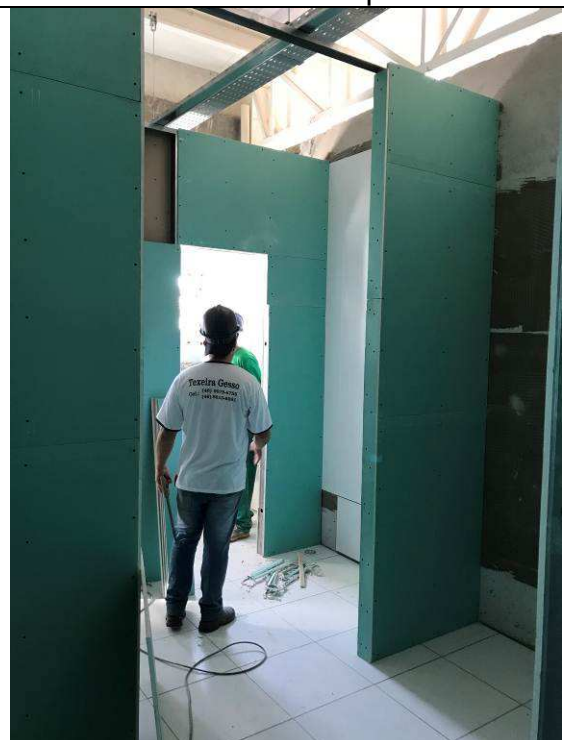
Figura 10C: Paredes de gesso acartonado - sanitários do Arquivo.
