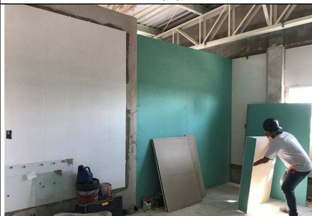
Figura 07C: Paredes de gesso acartonado - copa do Arquivo.
