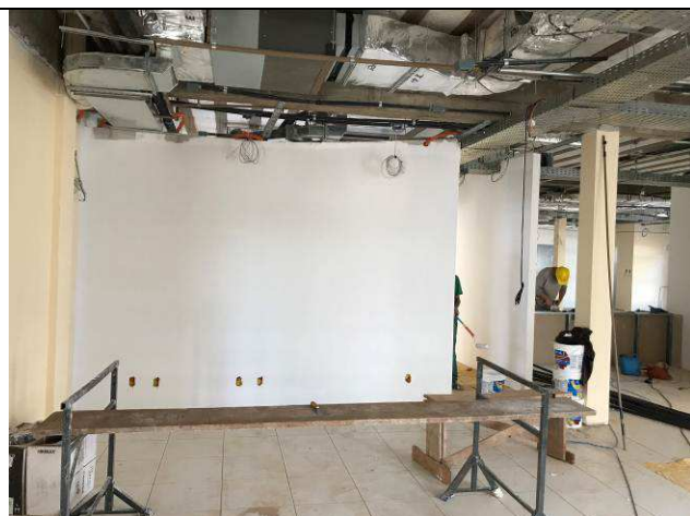
Figura 86C: Emassamento das paredes internas - 2ª Vara.
