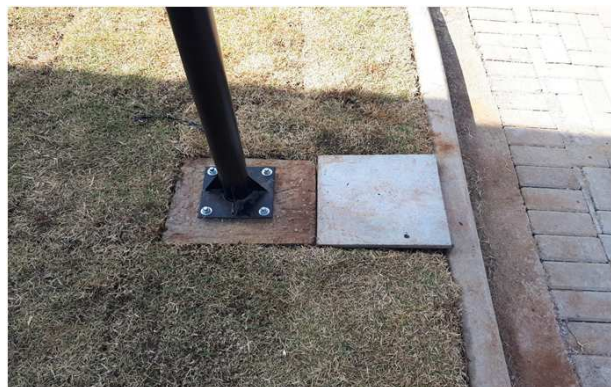
Figura 03E: Infraestrutura externa
