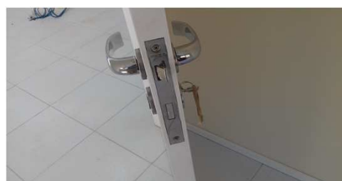
Figura 05C: detalhe de fechadura
