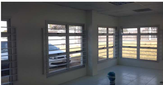
Figura 09C: grade de proteção de janelas - sala de audiência 1
