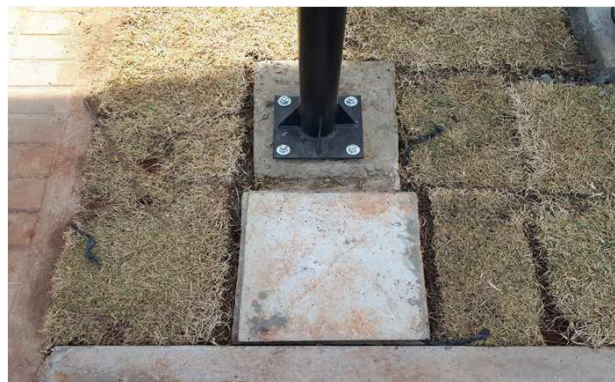
Figura 02E: Infraestrutura externa
