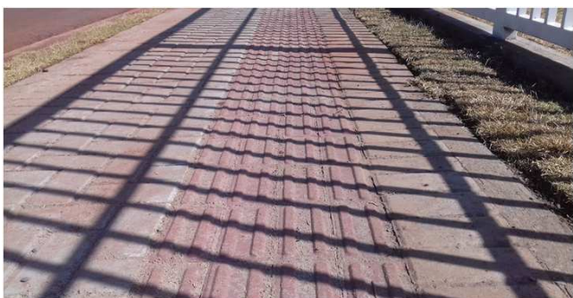
Figura 47C: detalhe de passeio com paver e piso podotátil
