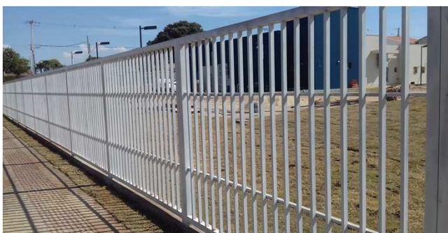
Figura 49C: gradil em metalon e baldrame abaixo
