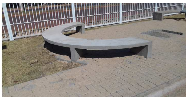
Figura 58C: bancos de concreto
