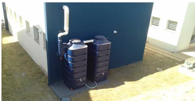
Figura 27C: sistema de reúso
