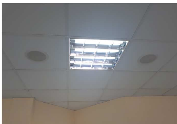
Figura 28E: Caixas de som
