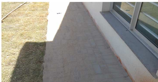
Figura 41C: calçada no entorno do prédio principal
