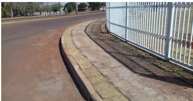
Figura 48C: passeio público em paver e piso podotátil. Também, gradil em metalon
