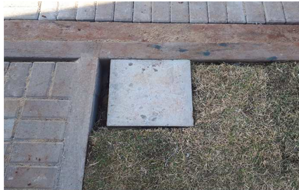
Figura 04E: Infraestrutura externa
