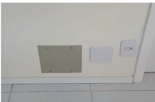
Figura 23E: caixas de passagem
