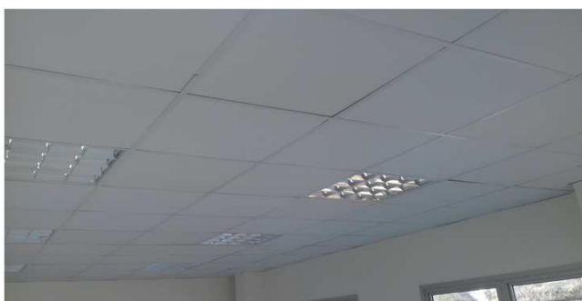
Figura 17C: forro modular instalado na sala de audiência 1
