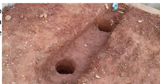
Figura 57C: escavação das brocas, antes da execução do bloco de fundação
