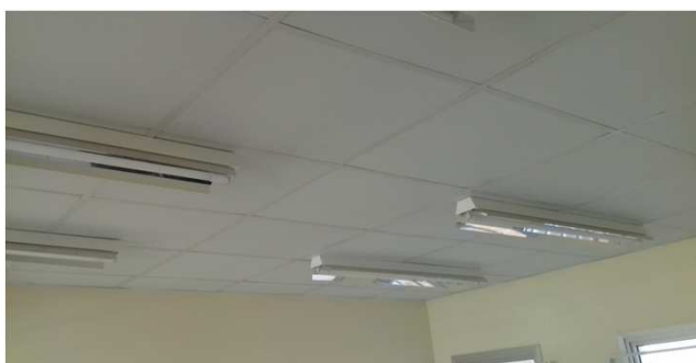
Figura 18C: forro modular instalado no arquivo
