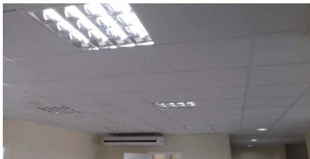
Figura 15C: forro modular instalado no hall de entrada
