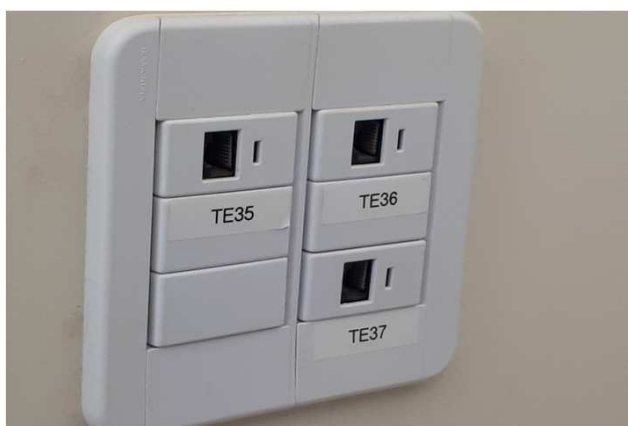
Figura 27E: conectores RJ45
