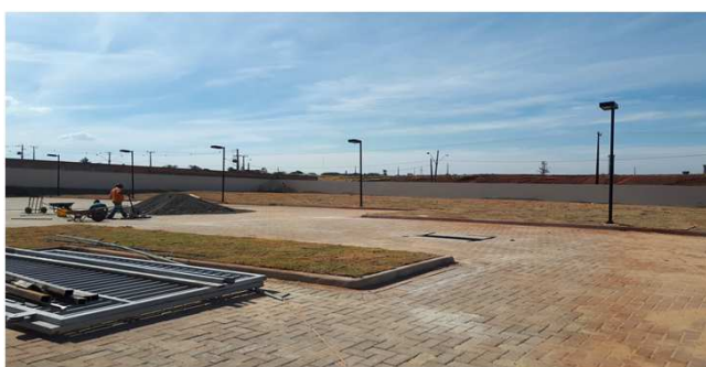
Figura 39C: meio-fio e paver - acesso ao estacionamento privado
