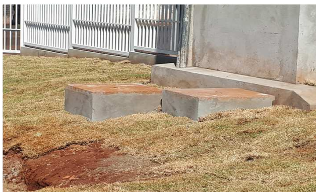
Figura 01E: Infraestrutura externa
