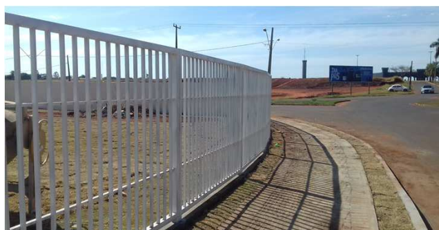
Figura 44C: gradil, grama e calçada externa
