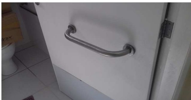
Figura 07C: barra para abertura de porta PNE
