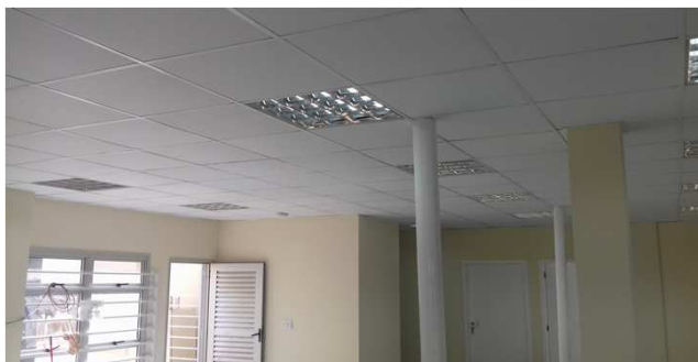
Figura 16C: forro modular instalado na secretaria
