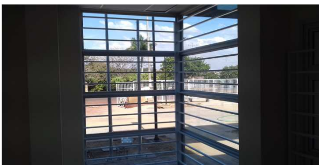
Figura 13C: grade de proteção de janelas -OAB
