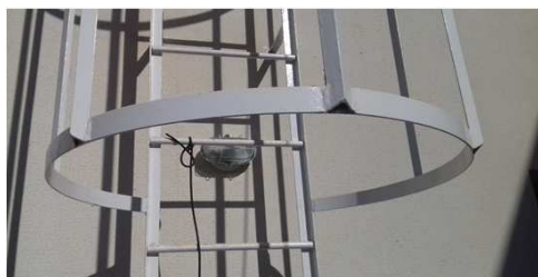
Figura 60C: Pintura de escada marinheiro
