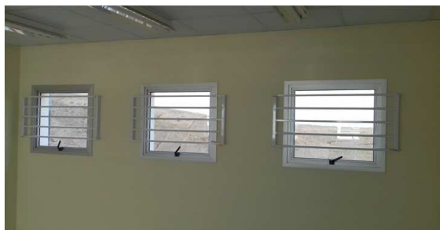
Figura 12C: grade de proteção de janelas - arquivo
