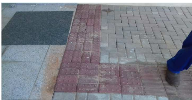
Figura 43C: placas cimentícias podotáteis
