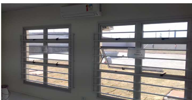
Figura 14C: grade de proteção de janelas - sala de audiência 2
