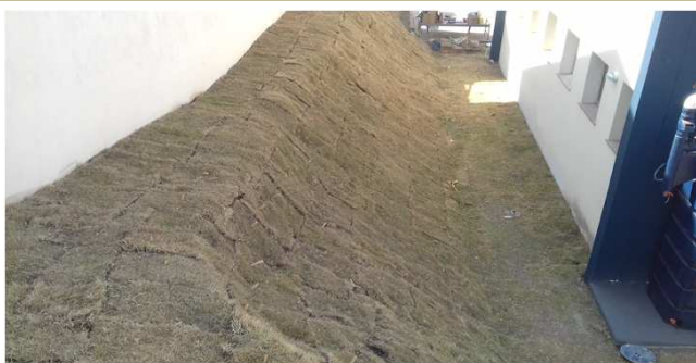
Figura 35C: grama plantada nos taludes - fundos
