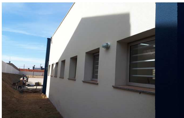
Figura 16E: Luminárias externas
