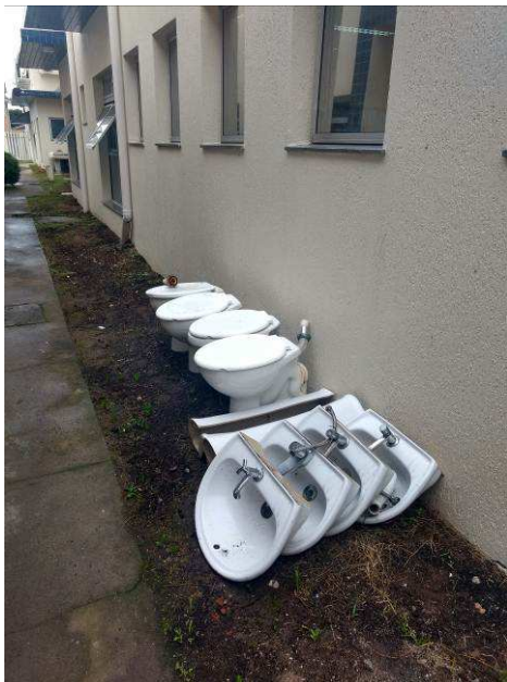
Figura 15c: Louças sanitárias removidas
