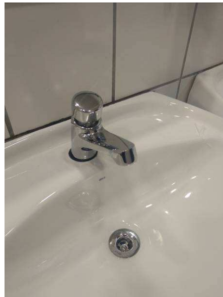
Figura 20c: Torneira de pressão fechamento automático
