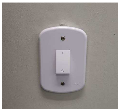
Figura 10E: Interruptor bipolar
