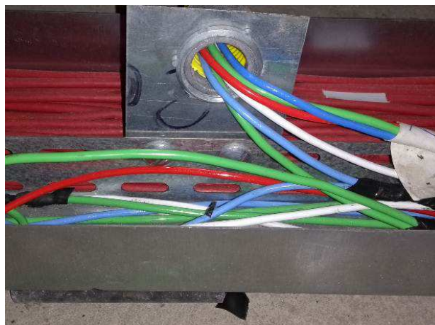
Figura 08E: Cabo de cobre 2,5 mm 2
