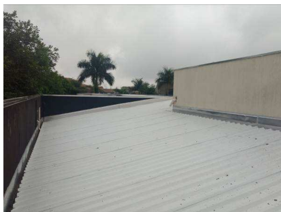
Figura 06c: Telhamento, calhas, rufos e contrarrufos.
