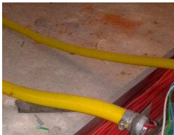
Figura 06E: Eletroduto PVC 32 mm
