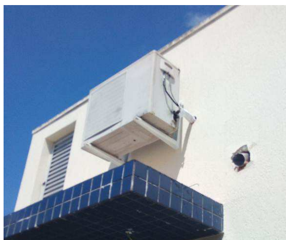
Figura 02E: Revisão de circuitos elétricos de climatização
