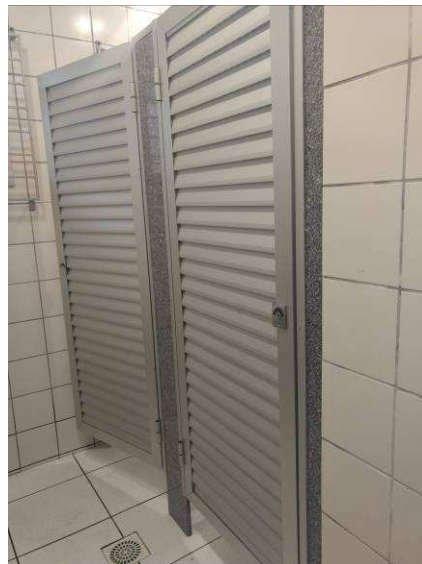
Figura 12c: Porta em alumínio acessos aos boxes sanitários
