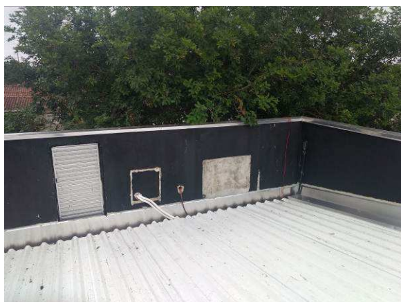
Figura 05c: Telhamento, calhas, rufos e contrarrufos.
