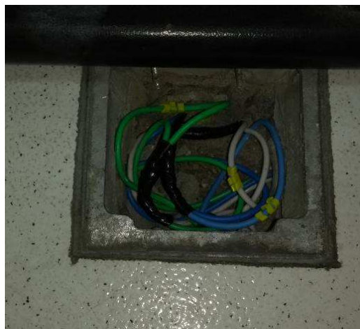
Figura 07E: Cabo de cobre 2,5 mm 2
