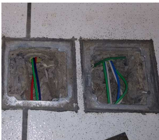
Figura 03E: Retirada de pontos elétricos desativados
