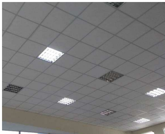
Figura 14E: Luminárias de embutir com aletas
