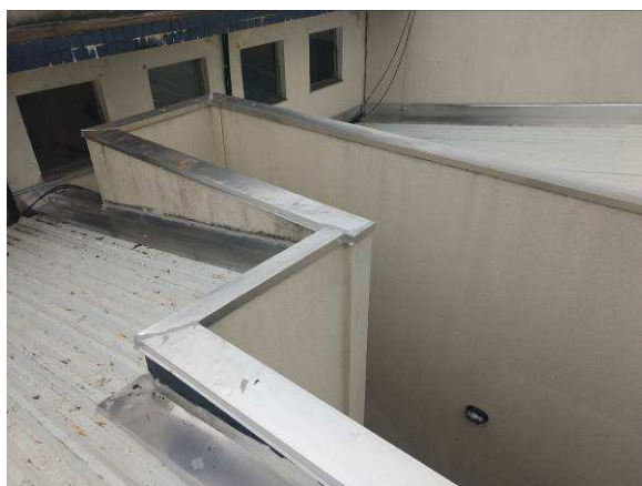
Figura 01c: Telhas e arremates de cobertura
