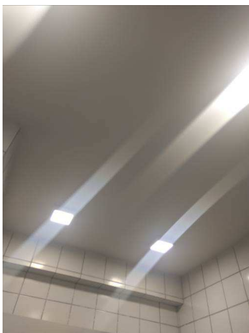
Figura 21c: tetos dos banheiros - emassamento e pintura
