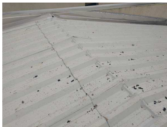
Figura 02c: Telhas termoacústicas
