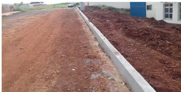
Figura 38C: meio-fio instalado na área externa - lateral esquerda
