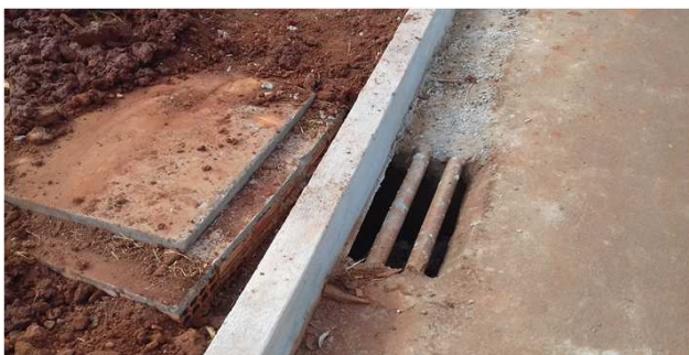
Figura 41C: meio-fio instalado na área externa - detalhe do acabamento junto a boca-de-lobo
