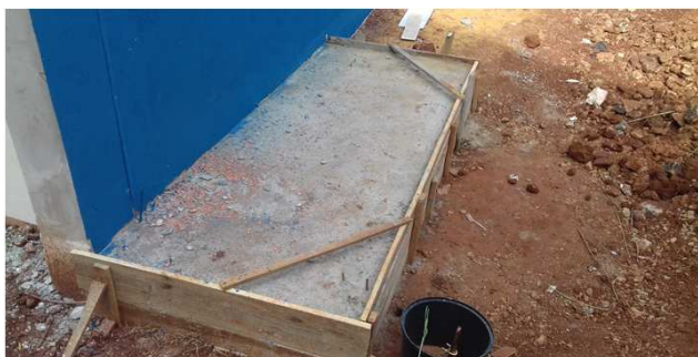
Figura 27C: base de concreto para acomodação do reservatório de reúso
