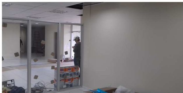
Figura 16C: caixilho de alumínio e fechamento com vidro - atendimento
