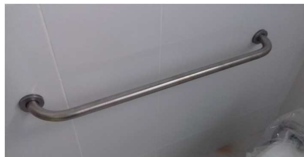
Figura 34C: barra de apoio para vaso sanitário - sanitário PNE público
