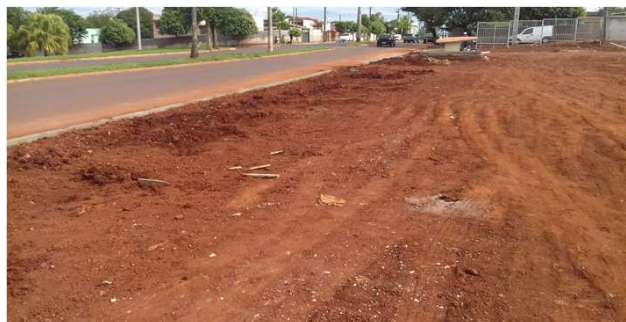
Figura 06C: região de aterro onde será o passeio público
