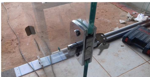
Figura 09C: detalhe de fechadura da porta de vidro - entrada principal
