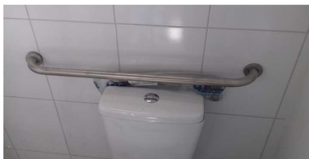
Figura 35C: barra de apoio para vaso sanitário - sanitário PNE da secretaria
