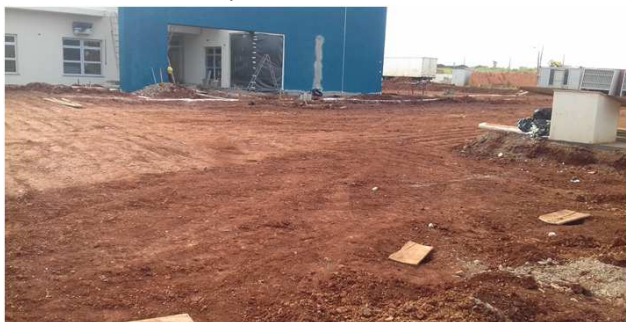
Figura 04C: terraplenagem realizada na região do estacionamento público
