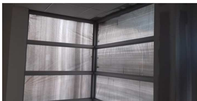
Figura 63C: Janela com caixilho em alumínio e vidro fixo, na sala OAB (antigo PAB)
