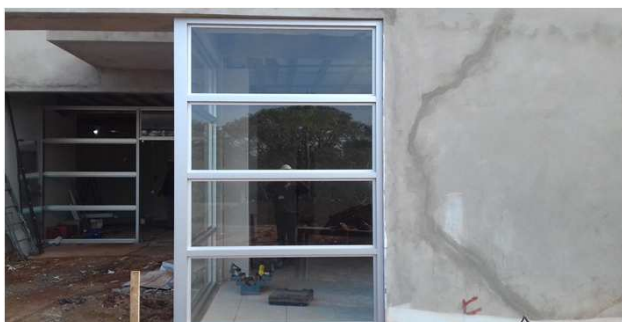
Figura 66C: Janela com caixilho em alumínio e vidro fixo, na sala OAB (antigo PAB)
