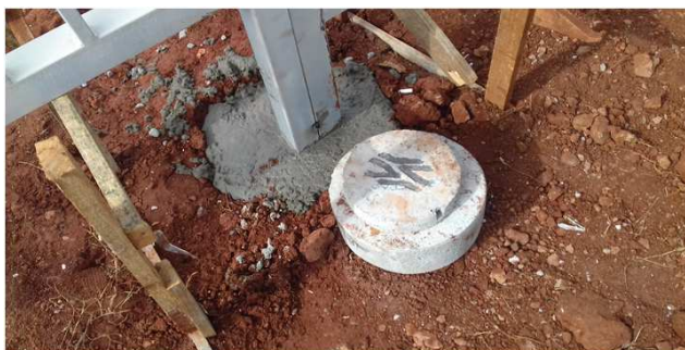
Figura 46C: pé de gradil chumbado em estaca
