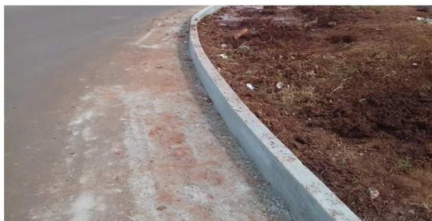
Figura 40C: meio-fio instalado na área externa - lateral direita
