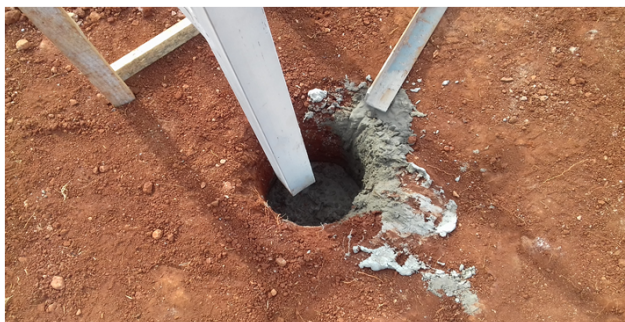
Figura 45C: pé do gradil e estaca sendo cheia com concreto
