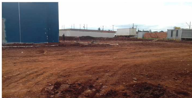
Figura 02C: terraplenagem realizada na região do estacionamento público
