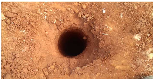
Figura 43C: broca perfurada para execução de estaca de sustentação do gradil
