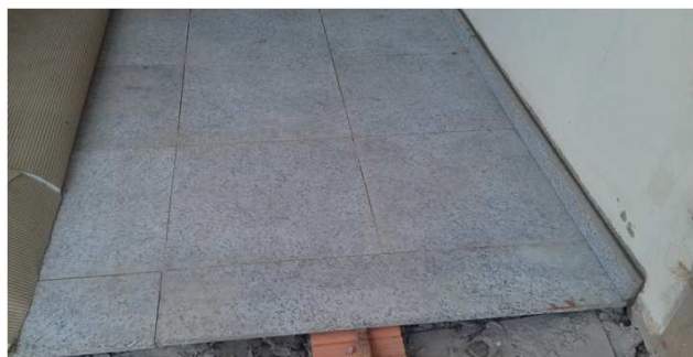
Figura 21C: piso em granito andorinha, instalado no hall de entrada (externo)
