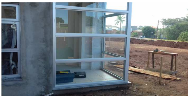
Figura 65C: Janela com caixilho em alumínio e vidro fixo, na sala OAB (antigo PAB)
