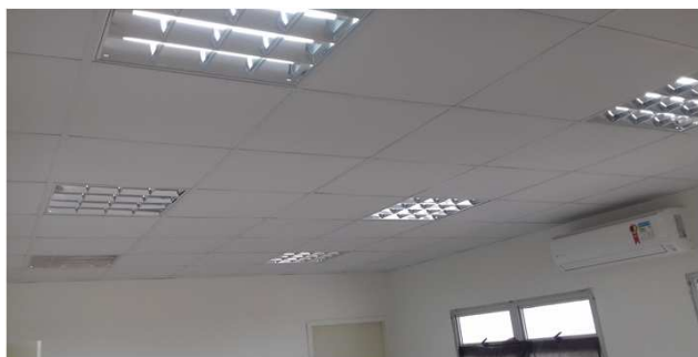
Figura 19C: forro modular instalado na sala de audiência 1
