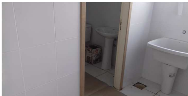
Figura 67C: paredes de gesso acartonado - arquivo
