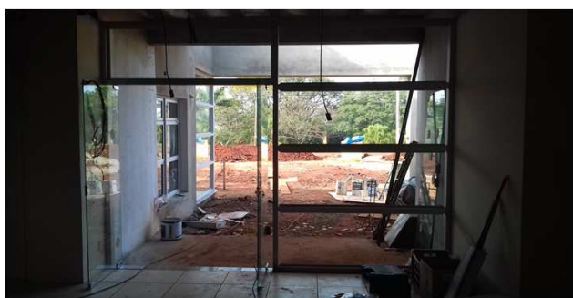
Figura 13C: caixilho de alumínio e fechamento com vidro - entrada principal
