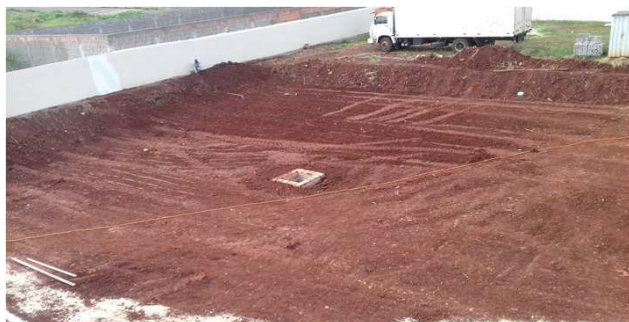
Figura 05C: região de corte, no estacionamento privativo.
