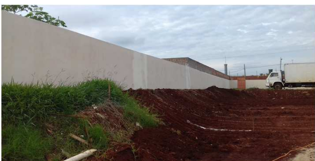
Figura 52C: primeira demão de pintura do muro nos fundos do imóvel
