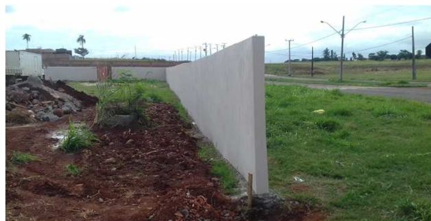
Figura 51C: primeira demão de pintura do muro lateral (direita) - face interna
