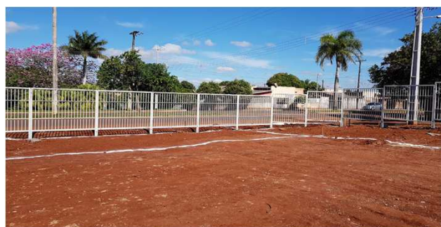
Figura 49C: gradil instalado na porção frontal e esquina
