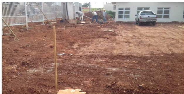
Figura 01C: aterro de trecho da lateral esquerda e terrapleno do estacionamento público
