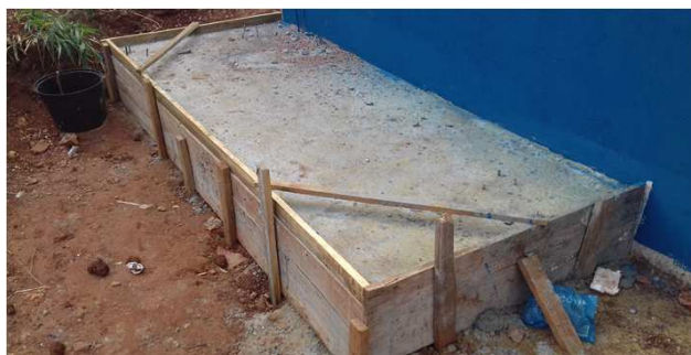
Figura 28C: base de concreto para acomodação do reservatório de reúso
