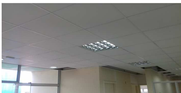
Figura 17C: forro modular instalado no hall de entrada
