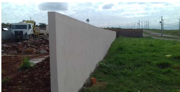
Figura 50C: primeira demão de pintura do muro lateral (direita) - face externa
