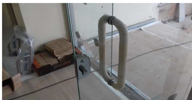
Figura 14C: detalhe de puxador - porta de vidro na entrada principal
