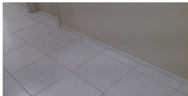
Figura 22C: rodapé Santa Luzia, instalado no hall de entrada
