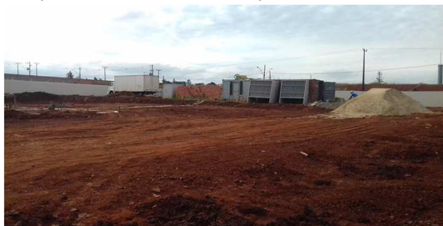
Figura 03C: terraplenagem realizada na região do estacionamento privativo
