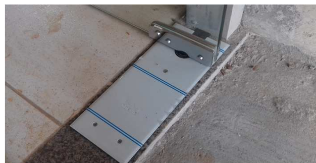
Figura 10C: detalhe de mola da porta de vidro - entrada principal
