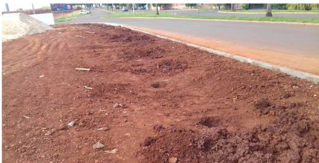
Figura 44C: diversas brocas perfuradas, aguardando concretagem
