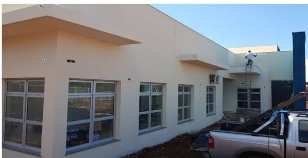
Figura 59C: pintura externa texturizada, na cor doric white - fachada frontal
