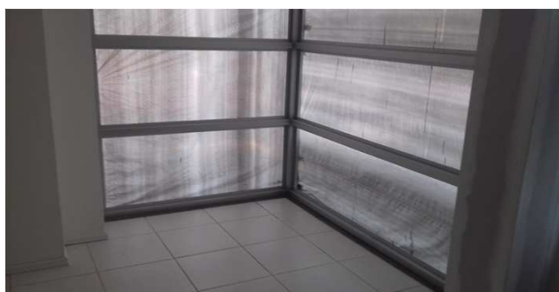
Figura 64C: Janela com caixilho em alumínio e vidro fixo, na sala OAB (antigo PAB)
