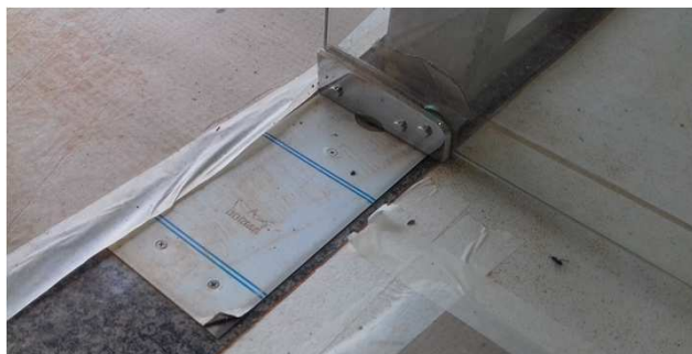
Figura 11C: detalhe de mola da porta de vidro - entrada principal
