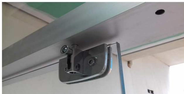
Figura 12C: detalhe de fechadura de engate - porta da entrada principal
