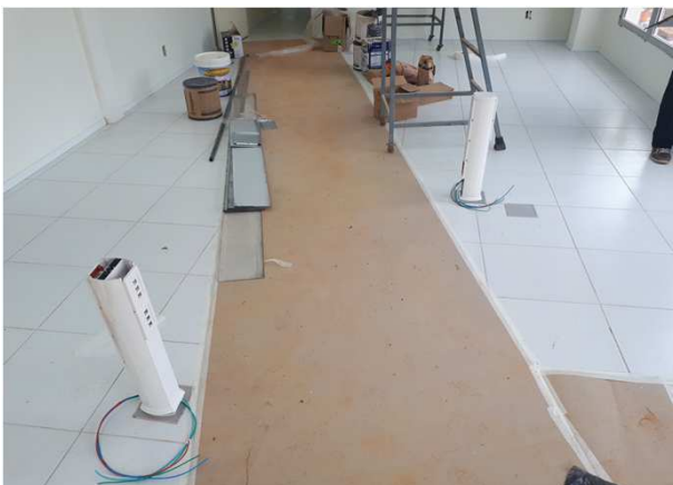
Figura 13E: Totens Dutotec, tomadas e porta equipamentos
