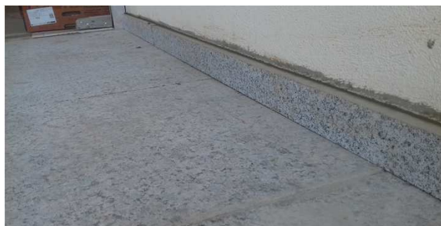
Figura 26C: rodapé em granito andorinha, instalado no hall de entrada (externo)
