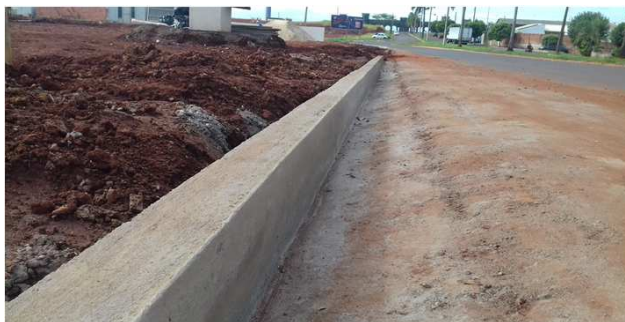
Figura 39C: meio-fio instalado na área externa - frontal
