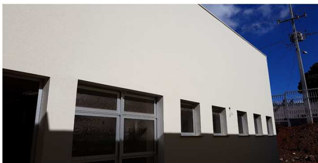
Figura 62C: detalhe de pintura texturizada
