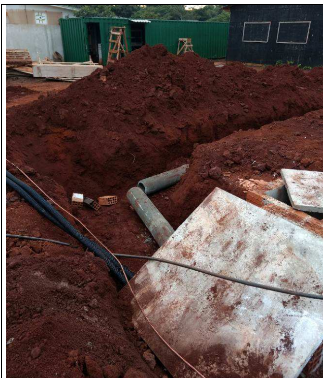
Figura 01C: Escavações de valas para tubulações.
