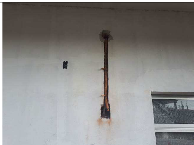
Figura 11E: caixas 2x4" e 4x4" embutidas em alvenaria.
