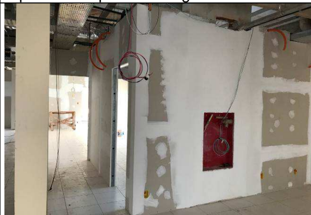
Figura 08C: Paredes de gesso acartonado - sala de conciliação - 1ª Vara.
