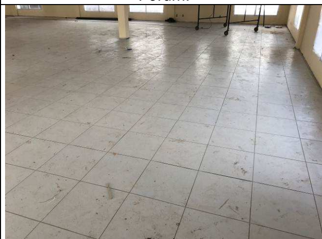
Figura 56C: Piso cerâmico - Área de apoio - Fórum.
