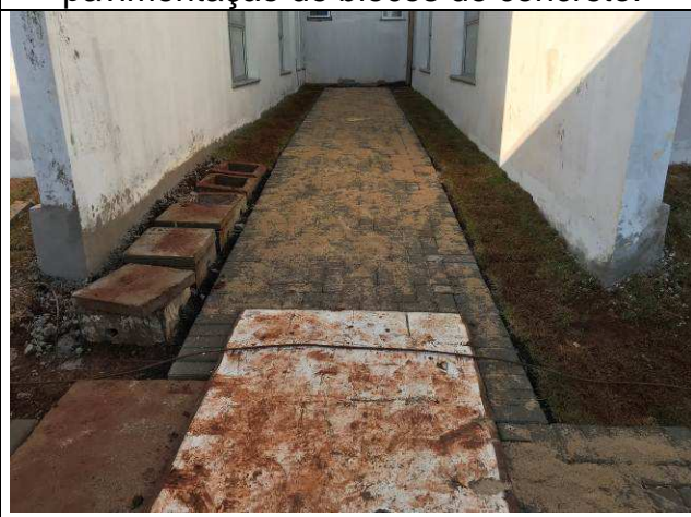
Figura 108C: Calçadas internas - pavimentação de blocos de concreto.
