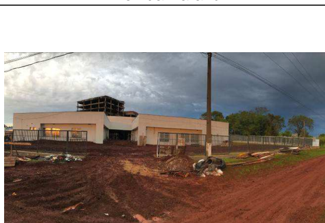
Figura 119C: Gradil frontal - paralelo à Avenida Paraná.
