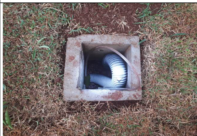
Figura 06E: infraestrutura externa para rede de iluminação.
