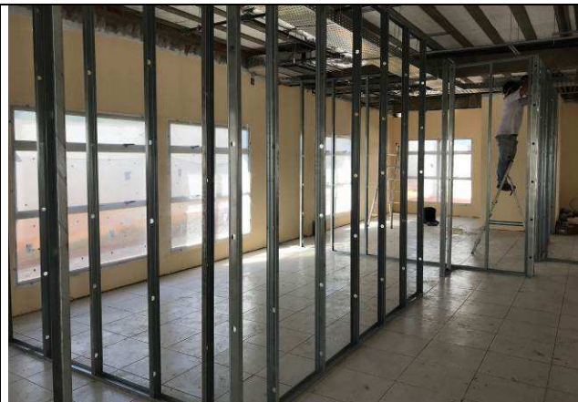
Figura 04C: Montagem dos perfis metálicos das paredes de gesso acartonado.
