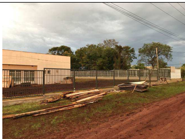
Figura 115C: Gradil frontal - paralelo à Avenida Paraná.
