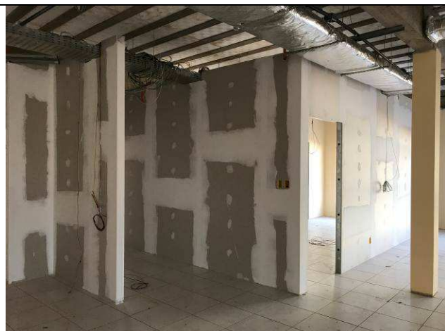
Figura 11C: Paredes de gesso acartonado - gabinete de juiz - 1ª Vara.
