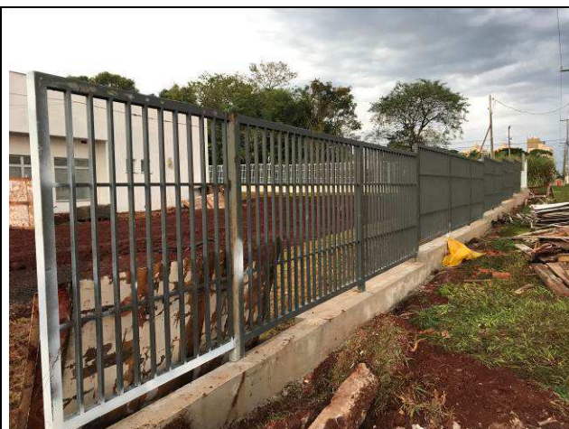
Figura 116C: Gradil frontal - paralelo à Avenida Paraná.
