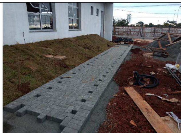
Figura 106C: Calçadas internas - pavimentação de blocos de concreto.
