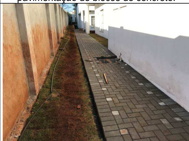
Figura 109C: Calçadas internas - pavimentação de blocos de concreto.
