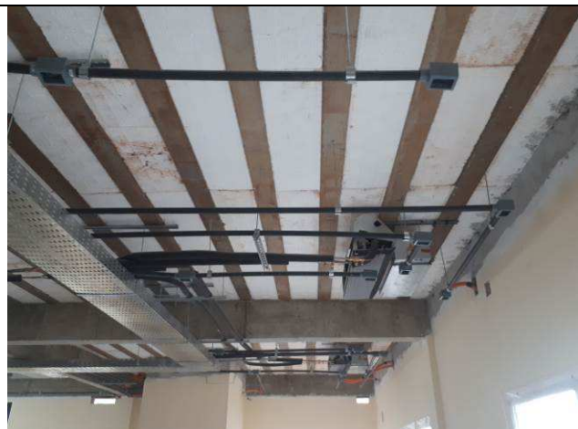
Figura 15E: eletrodutos rígidos, eletrodutos corrugados, unidut, condulettes.
