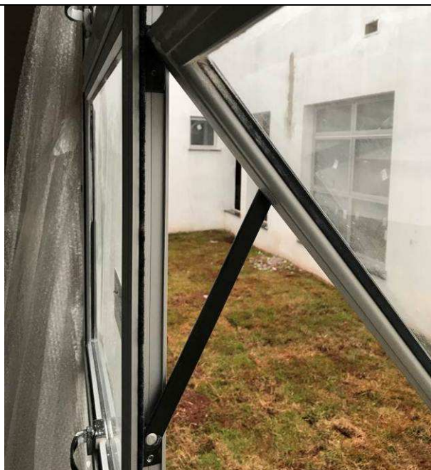
Figura 41C: Janelas em alumínio - braços em alumínio - Fórum.
