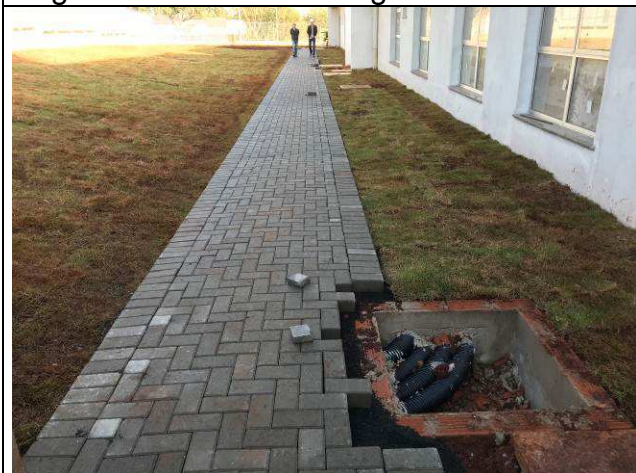
Figura 103C: Calçadas internas - pavimentação de blocos de concreto.
