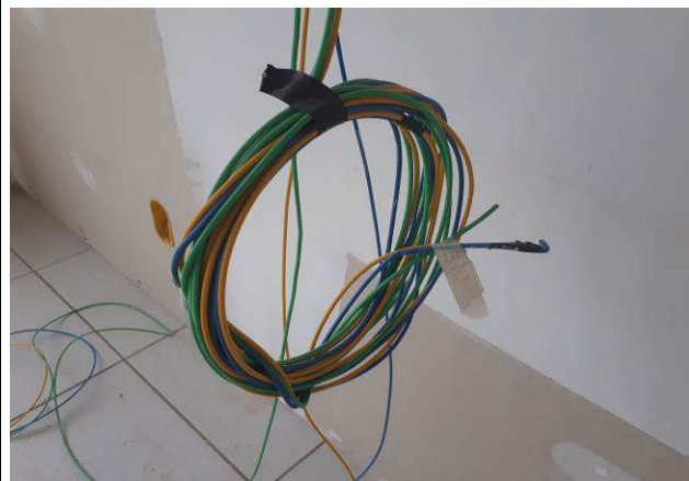
Figura 26E: cabearno elétrico #2,5mm 2 quadrante frontal lado direito.
