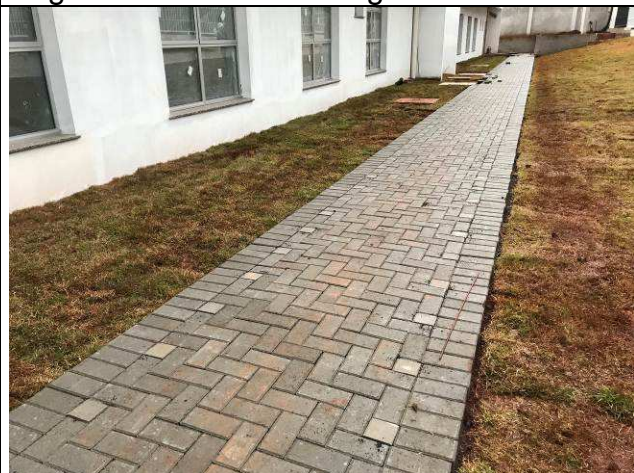
Figura 104C: Calçadas internas - pavimentação de blocos de concreto.
