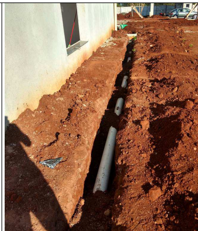
Figura 02C: Escavações de valas para tubulações.
