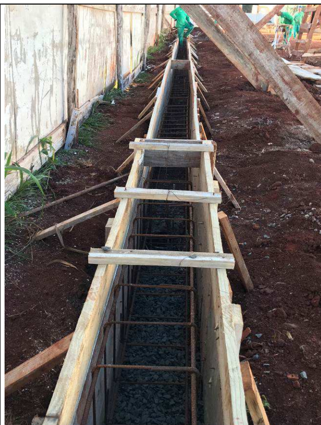
Figura 112C: Gradil frontal - viga baldrame (formas e armações).
