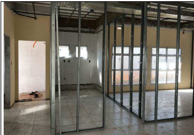
Figura 03C: Montagem dos perfis metálicos das paredes de gesso acartonado.
