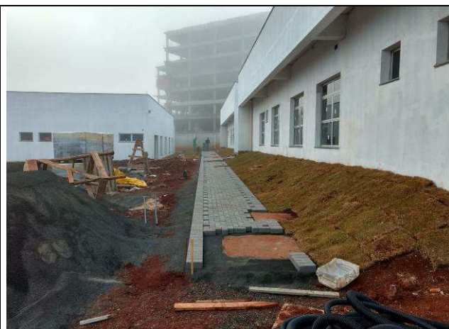
Figura 105C: Calçadas internas - pavimentação de blocos de concreto.
