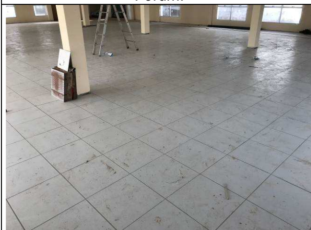
Figura 55C: Piso cerâmico - Área de apoio - Fórum.
