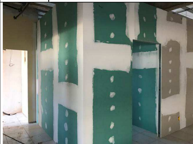
Figura 12C: Paredes de gesso acartonado - copa (placas verdes) - 1ª Vara.
