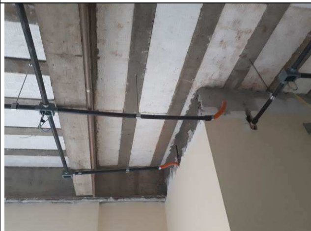
Figura 16E: eletrodutos rígidos, eletrodutos corrugados, unidut, condulettes.
