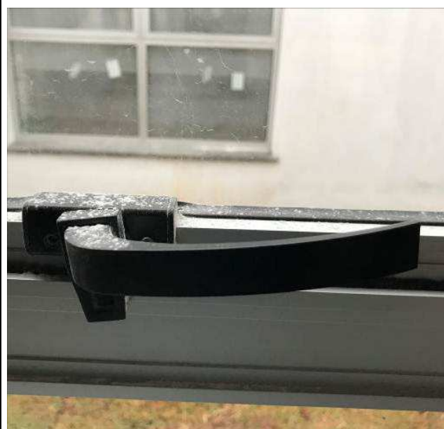
Figura 42C: Janelas em alumínio - trinco em alumínio - Fórum.
