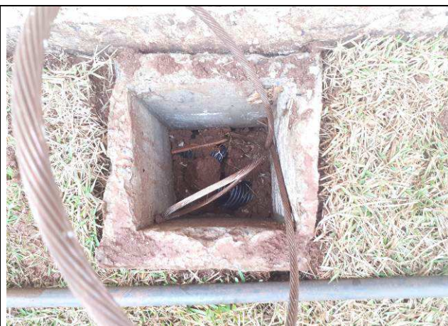
Figura 08E: infraestrutura externa para rede de iluminação.
