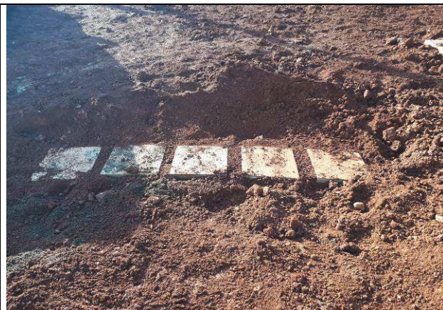
Figura 02E: execução de valas para infraestrutura externa.
