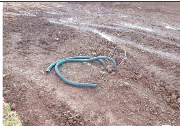
Figura 01E: execução de valas para infraestrutura externa.
