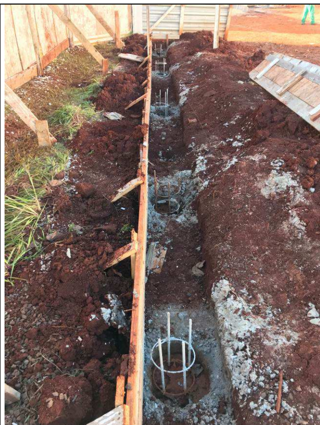
Figura 111C: Gradil frontal - estacas concretadas.
