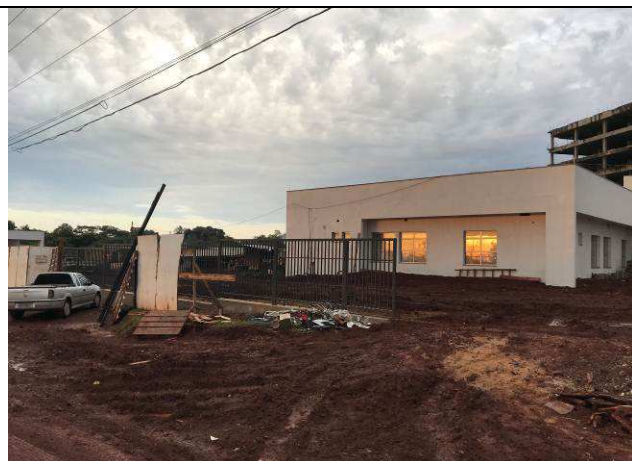
Figura 117C: Gradil frontal - paralelo à Avenida Paraná.
