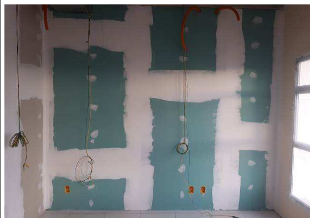
Figura 28E: cabearno elétrico #2,5mm 2 quadrante frontal lado direito.
