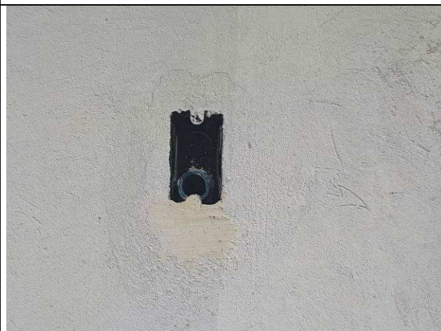
Figura 12E: caixas 2x4" e 4x4" embutidas em alvenaria.
