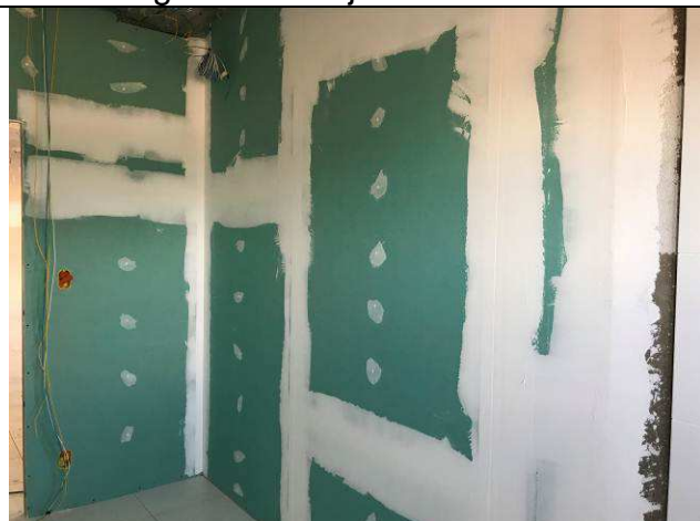
Figura 13C: Paredes de gesso acartonado verde (RU - resistente à umidade).
