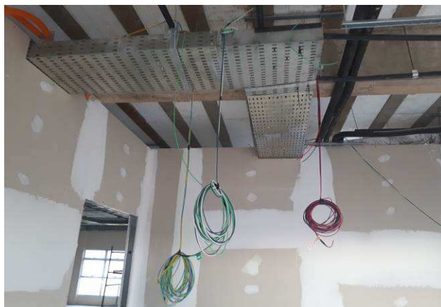
Figura 25E: cabearno elétrico #2,5mm 2 quadrante frontal lado direito.
