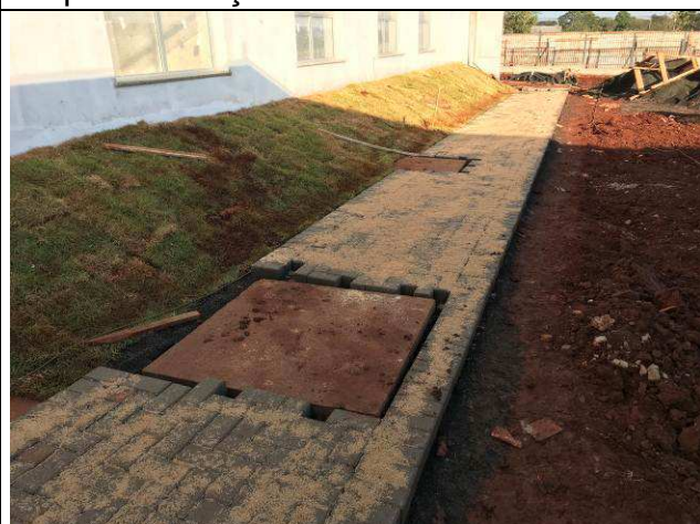
Figura 107C: Calçadas internas - pavimentação de blocos de concreto.
