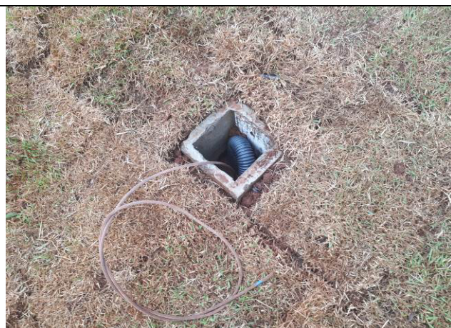
Figura 07E: infraestrutura externa para rede de iluminação.
