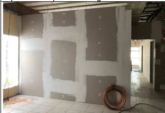
Figura 07C: Paredes de gesso acartonado - sala de conciliação - 1ª Vara.
