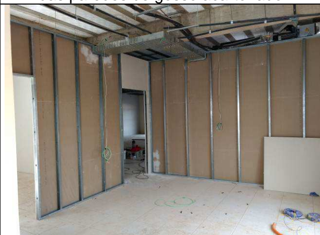
Figura 06C: Montagem dos perfis metálicos e placas das paredes de gesso acartonado.
