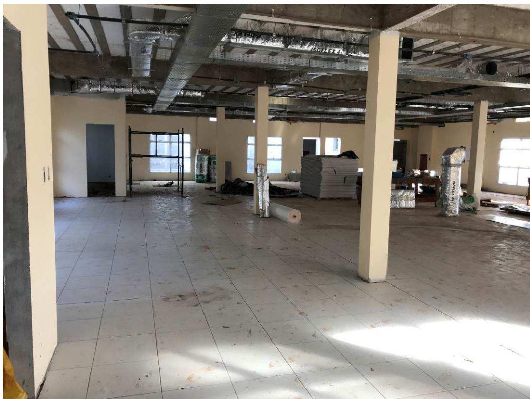
Figura 6 – Prédio do Fórum – vista interna.
