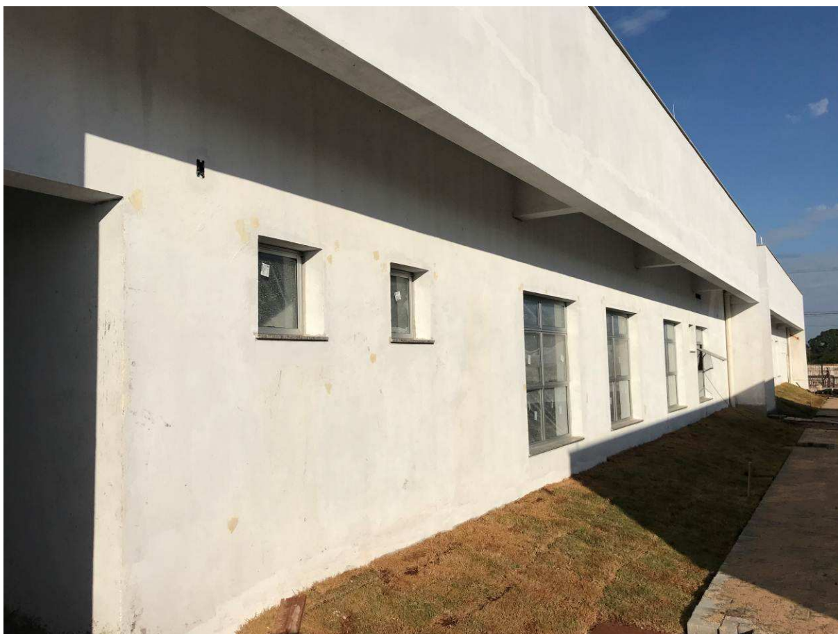
Figura 3 – Prédio do Fórum – vista externa.
