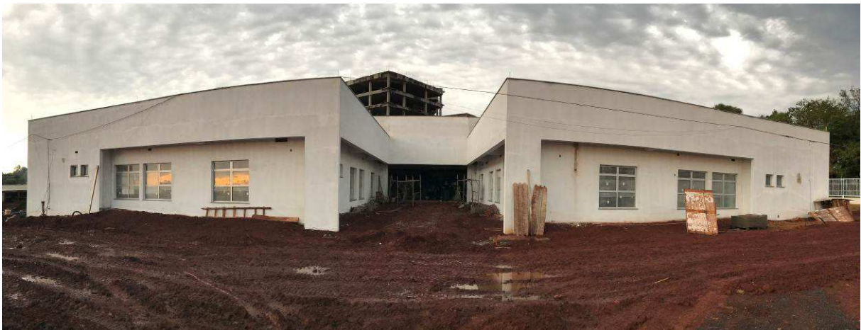
Figura 1 – Prédio do Fórum – vista externa.
