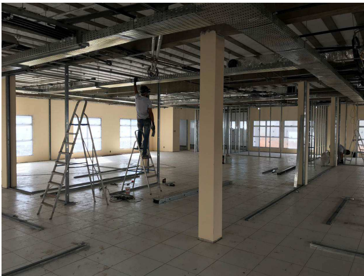
Figura 5 – Prédio do Fórum – vista interna.
