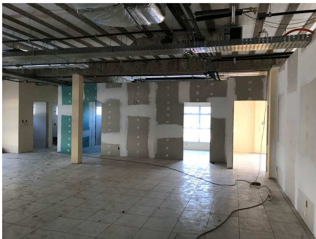
Figura 7 – Prédio do Fórum – vista interna.
