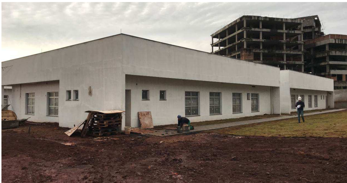
Figura 2 – Prédio do Fórum – vista externa.
