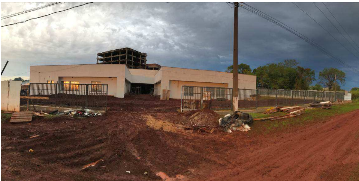
Figura 4 – Prédio do Fórum – vista externa.
