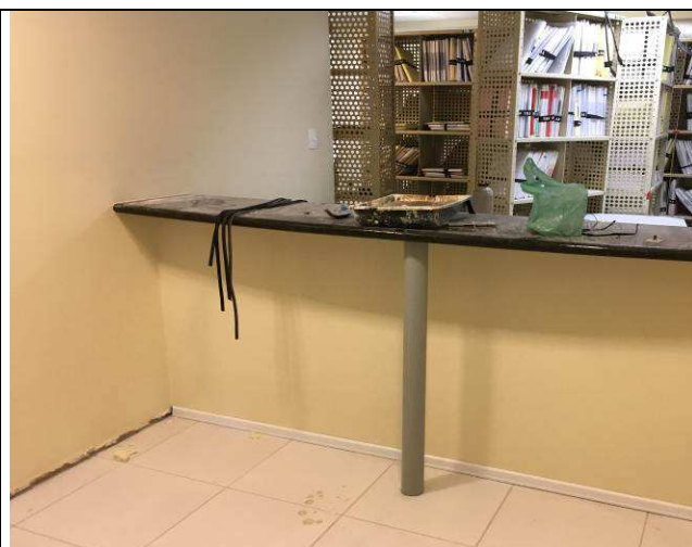
Figura 02C: Adequação e instalação do balcão de atendimento
