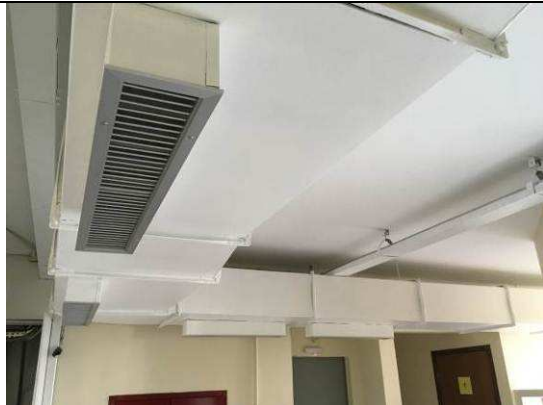
Figura 10C: Pintura nos dutos de insuflamento
