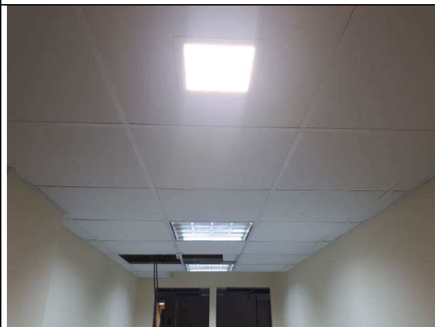
Figura 18E: Instalação luminárias 4x16W e painel plafon LED.
