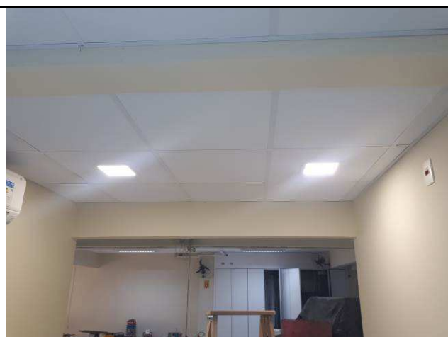
Figura 19E: luminárias painel plafon LED
