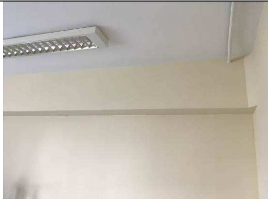
Figura 09C: Pintura em paredes e tetos
