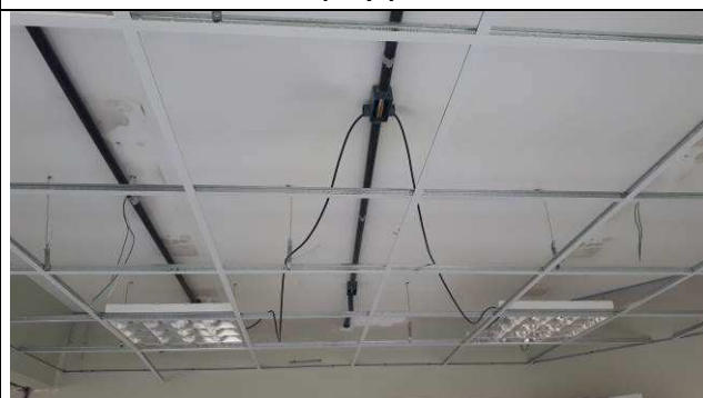
Figura 14E: Instalação luminárias 4x16W
