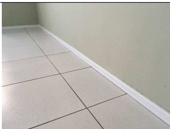
Figura 07C: Instalação rodapé em poliuretano.
