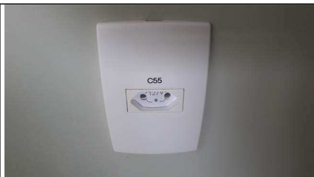
Figura 10E: Tomadas e interruptores padrão modular Pial Plus.
