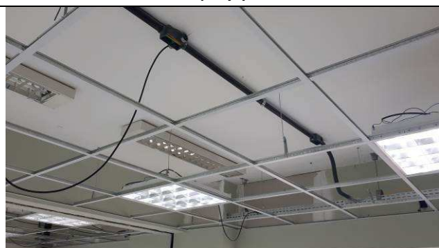
Figura 13E: Instalação luminárias 4x16W
