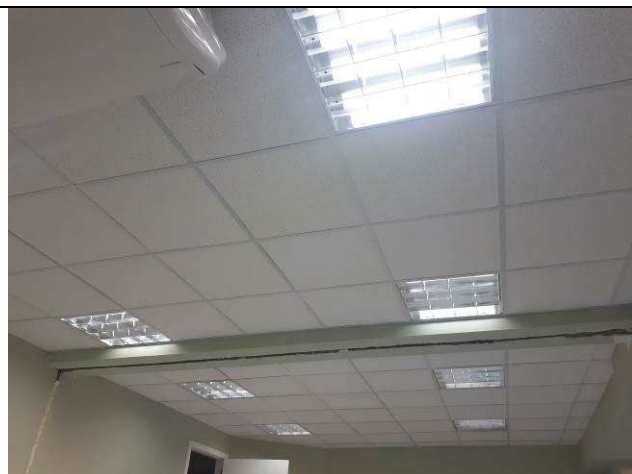
Figura 17E: Instalação luminárias 4x16W
