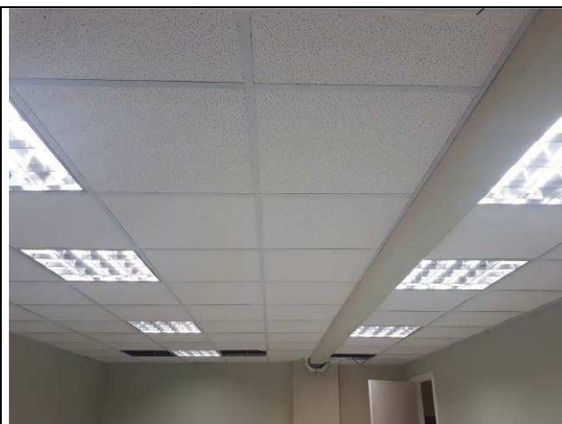
Figura 16E: Instalação luminárias 4x16W
