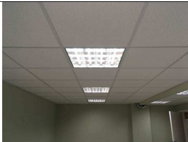
Figura 06C: Instalação de forros.
