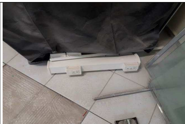
Figura 01E: Retirada e movimentação material elétrico almoxarifado.
