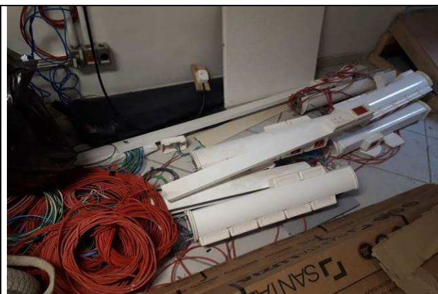
Figura 02E: Retirada e movimentação material elétrico almoxarifado.
