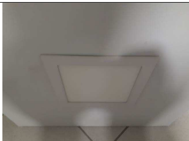
Figura 21E: luminárias painel plafon LED
