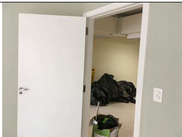
Figura 04C: Instalação de portas e pintura
