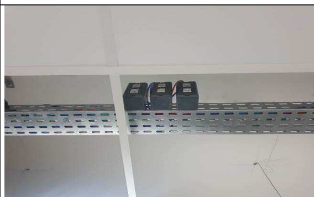
Figura 32E: Pontos RJ45, condutes padrão genérico
