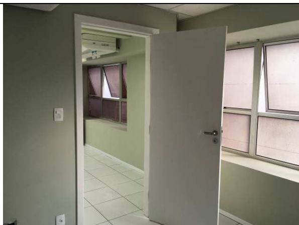
Figura 03C: Instalação de portas e pintura
