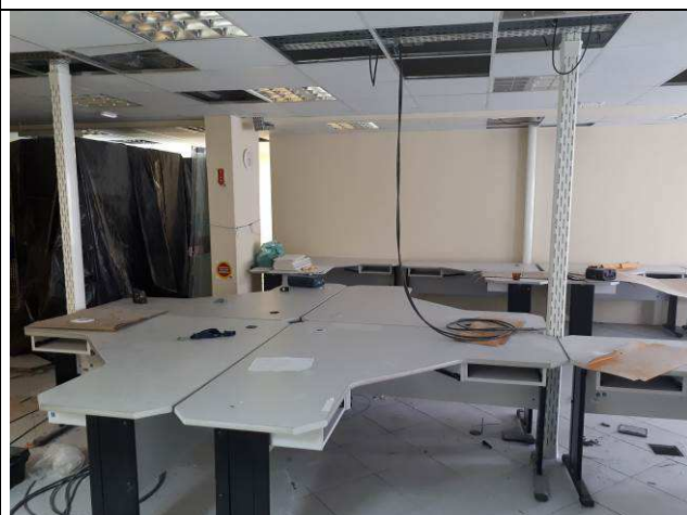
Figura 12E: Colunas técnicas Dutotec - 1ª VT
