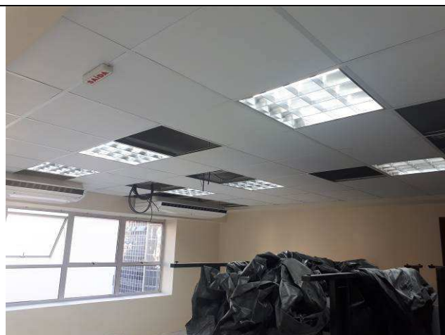
Figura 15E: Instalação luminárias 4x16W
