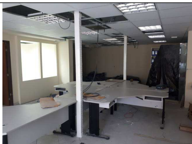
Figura 11E: Colunas técnicas Dutotec - 1ª VT
