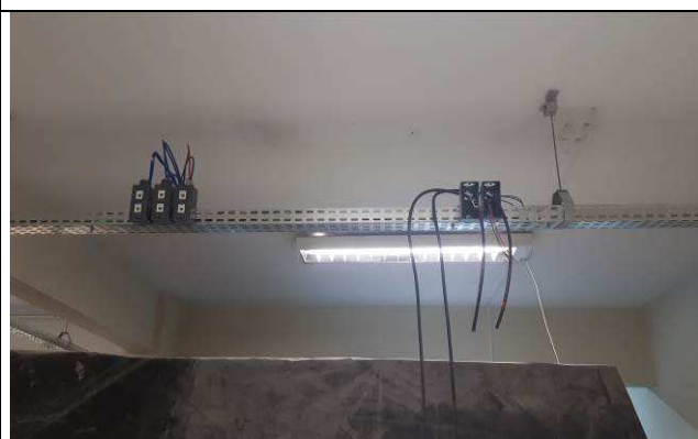
Figura 31E: Pontos RJ45, condutes padrão genérico
