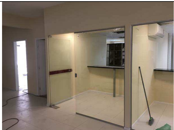
Figura 05C: Instalação de portas de vidro temperado e painel de vidro fixo.
