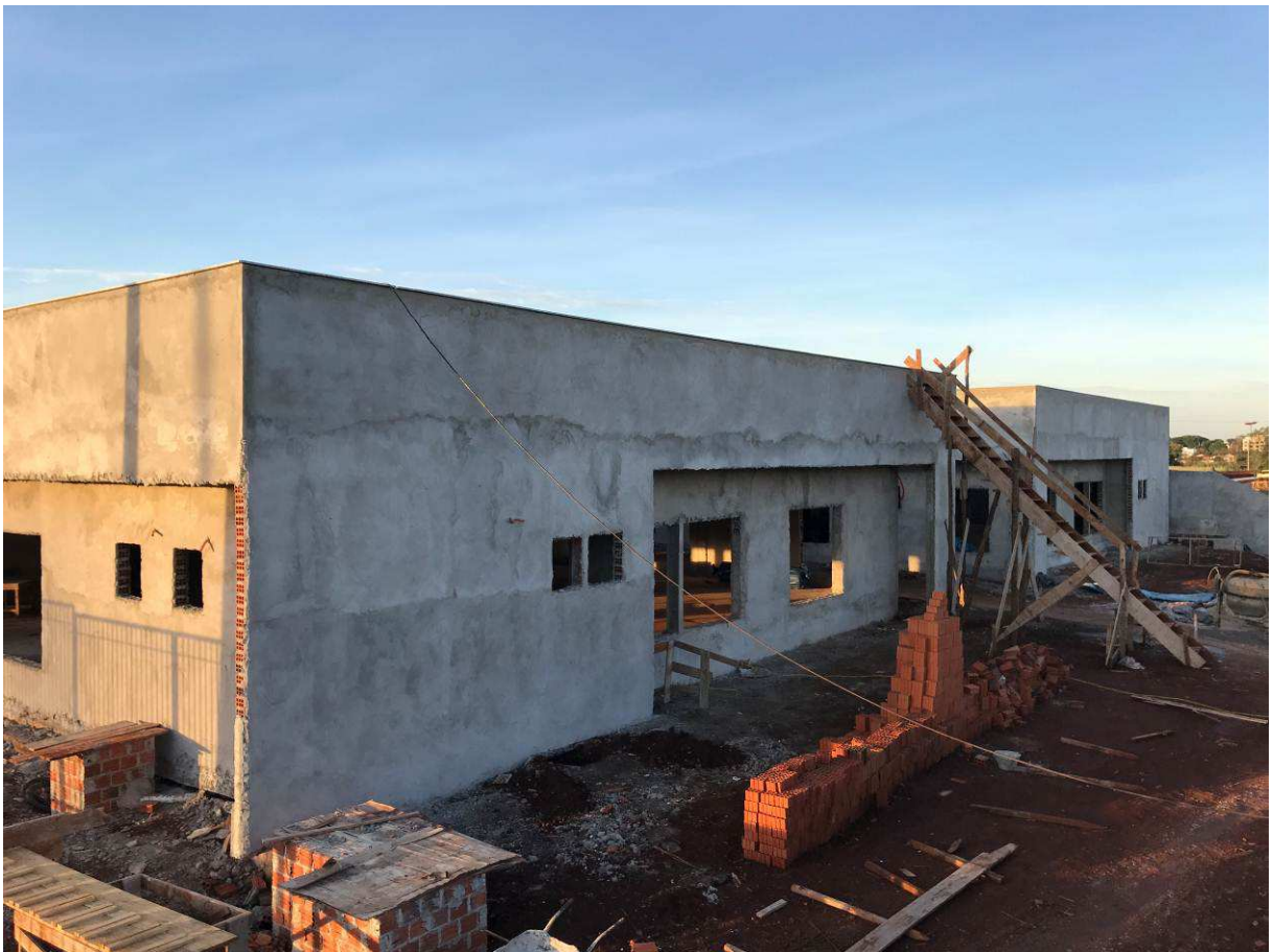
Figura 3 – Fórum - Vista externa.
