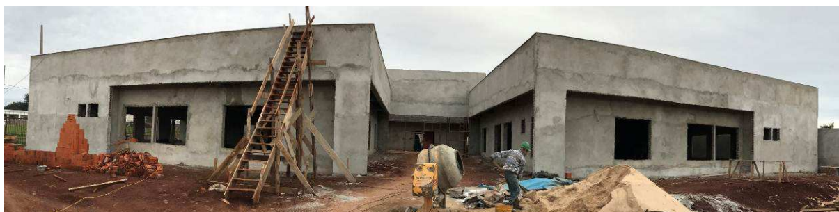
Figura 1 – Fórum - Vista externa.
