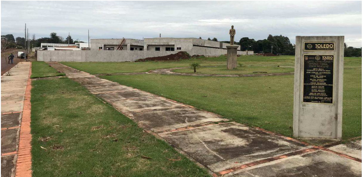
Figura 2 – Fórum - Vista externa.
