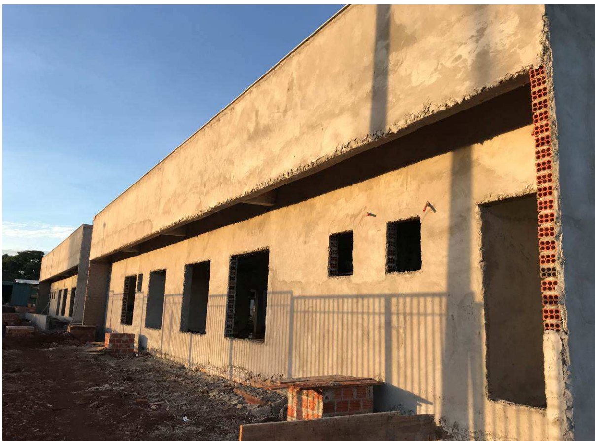
Figura 4 – Fórum - Vista externa.
