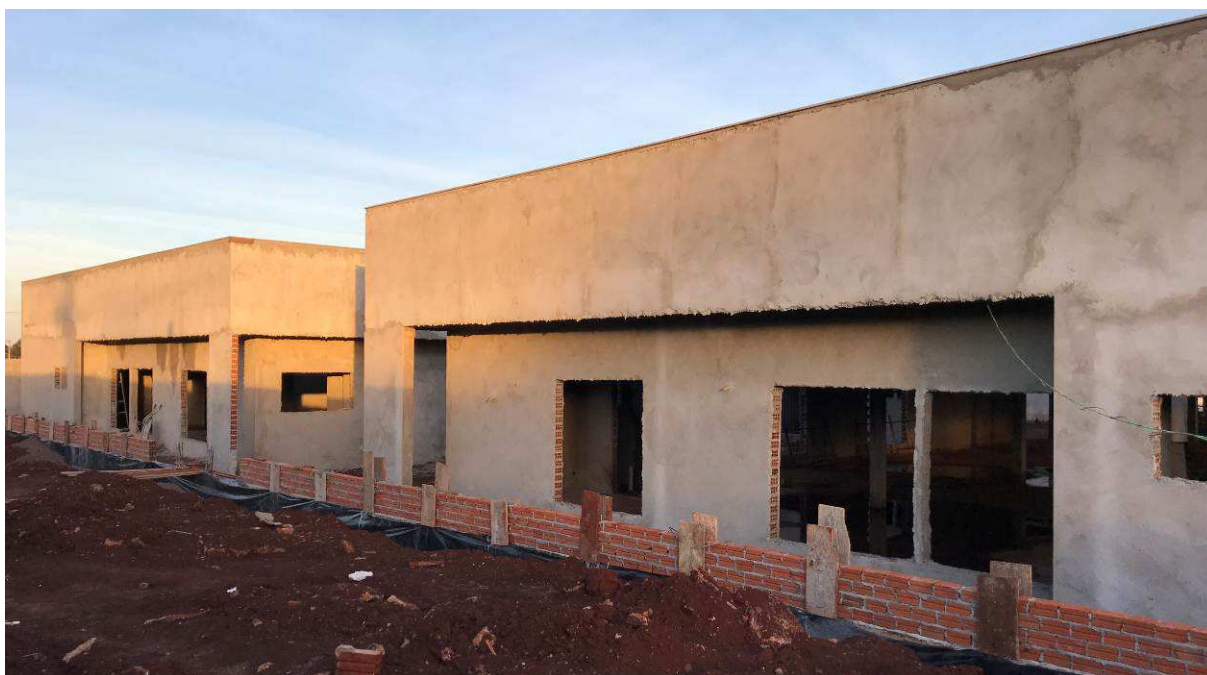
Figura 5 – Fórum - Vista externa.
