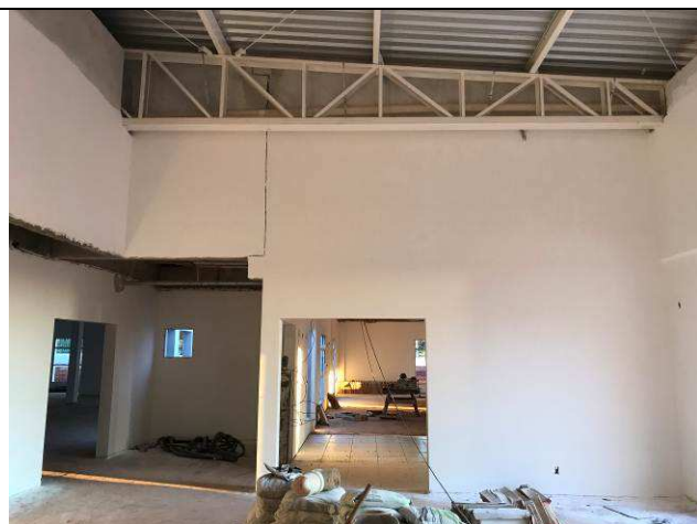
Figura 75C: Paredes com massa PVA - Hall central - Fórum.
