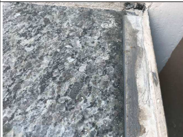
Figura 14C: Vedação com selante elástico entre o peitoril e o contramarco.
