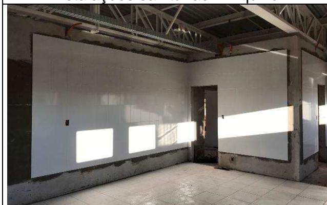
Figura 19C: Azulejos assentados - copa - Arquivo.
