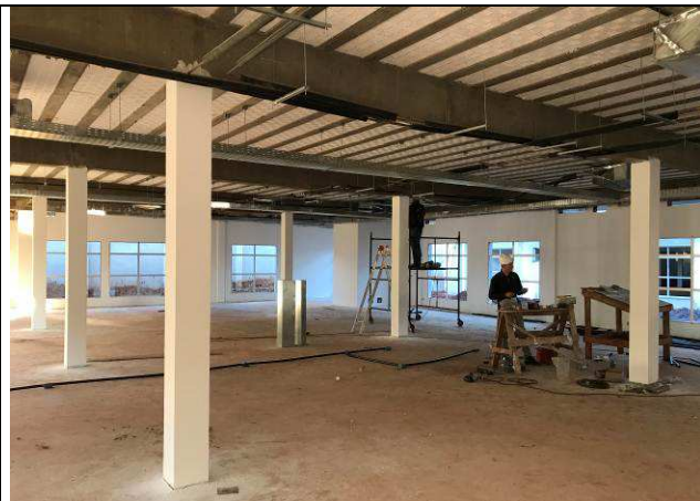
Figura 70C: Paredes com massa PVA - 3ª Vara - Fórum.
