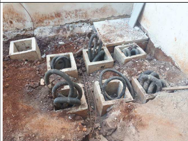
Figura 06E: Infraestrutura externa dutos 2"
