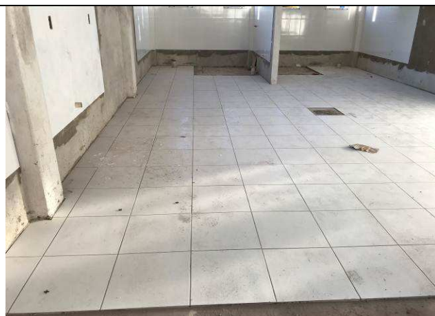
Figura 25C: Piso cerâmico - instalações sanitárias, vestiários e copa - Arquivo.
