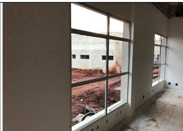
Figura 15C: Quadros fixos das esquadrias de 1,80x1,80m - Fórum.
