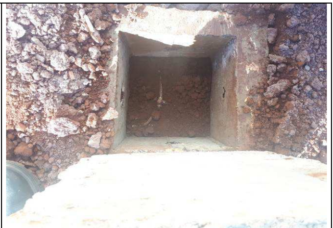
Figura 32E: malha de aterramento - cabos cobre nu, haste, caixa, solda
