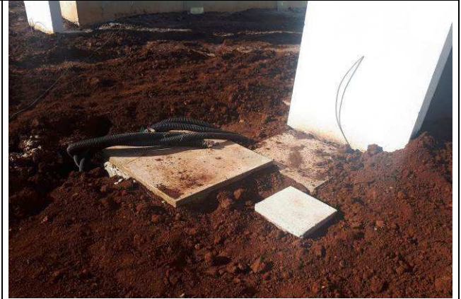
Figura 30E: Infraestrutura externa dutos 2"
