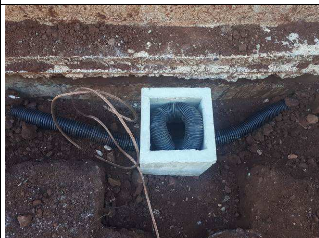
Figura 05E: Infraestrutura externa dutos 2"
