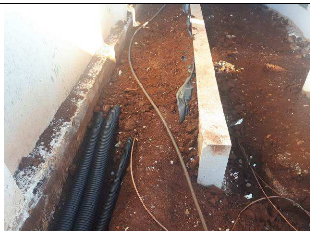
Figura 03E: Infraestrutura externa dutos 2"
