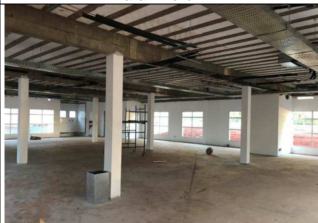
Figura 73C: Paredes com massa PVA - 2ª Vara - Fórum.
