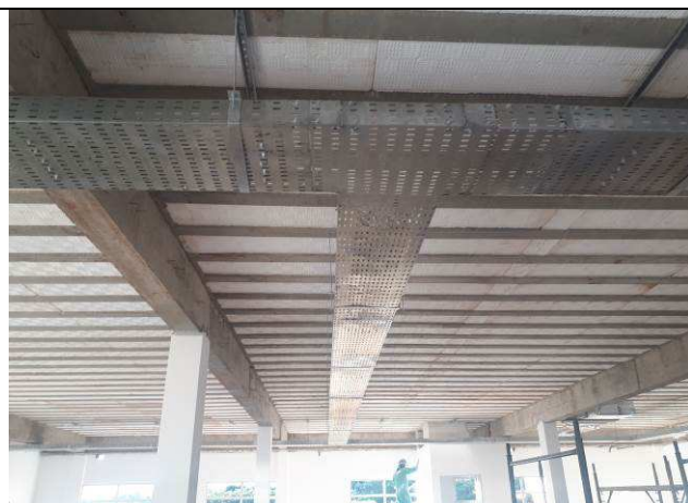
Figura 23E: eletrocalhas #400x100, curvas, cruzetas, tês - quadrante 4
