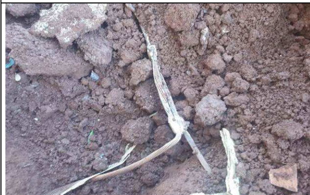
Figura 33E: malha de aterramento - cabos cobre nu, haste, caixa, solda
