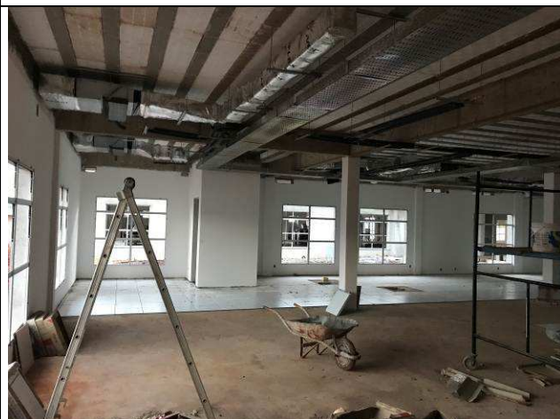
Figura 78C: Paredes com massa PVA - 1ª Vara - Fórum.
