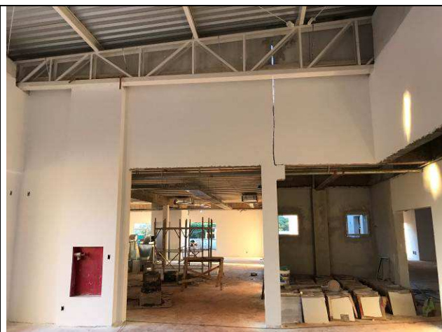
Figura 76C: Paredes com massa PVA - Hall central - Fórum.
