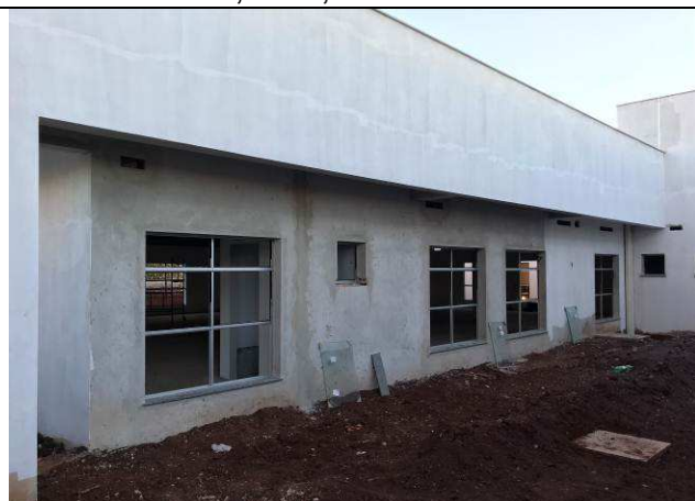
Figura 11C: Quadros fixos das esquadrias de 1,80x1,80m - Fórum.
