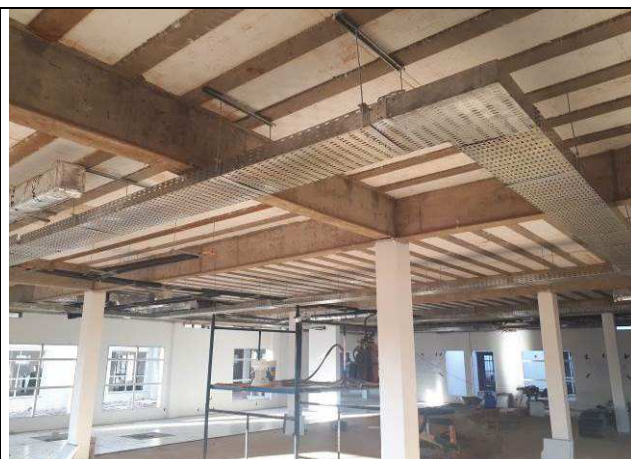
Figura 14E: eletrocalhas #400x100, curvas, cruzetas, tês - quadrante 1
