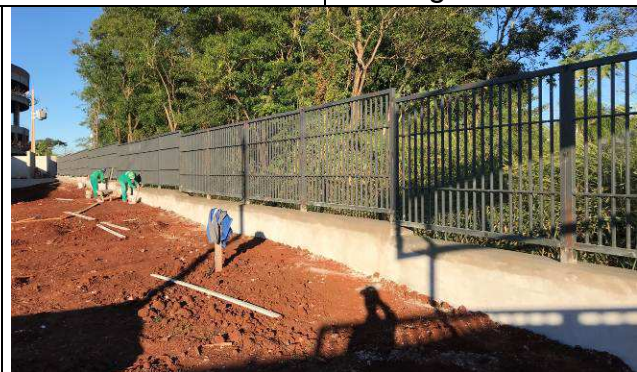
Figura 68C: Gradil de fechamento.
