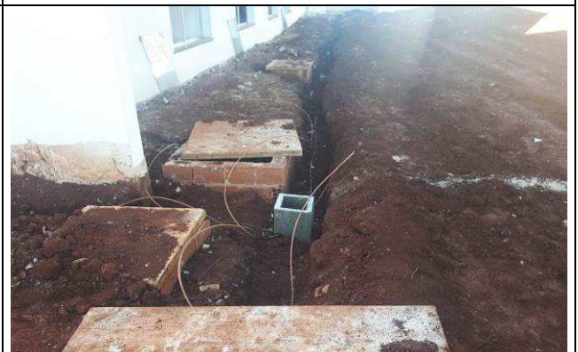
Figura 34E: malha de aterramento - cabos cobre nu, haste, caixa, solda
