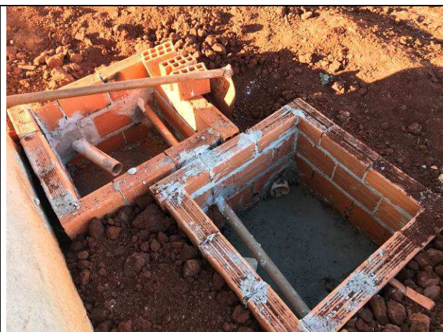
Figura 42C: Caixas águas pluviais e esgoto - Guarita.
