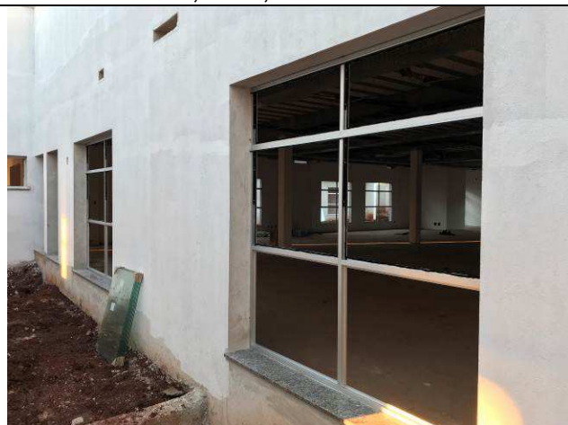
Figura 13C: Quadros fixos das esquadrias de 1,80x1,80m - Fórum.
