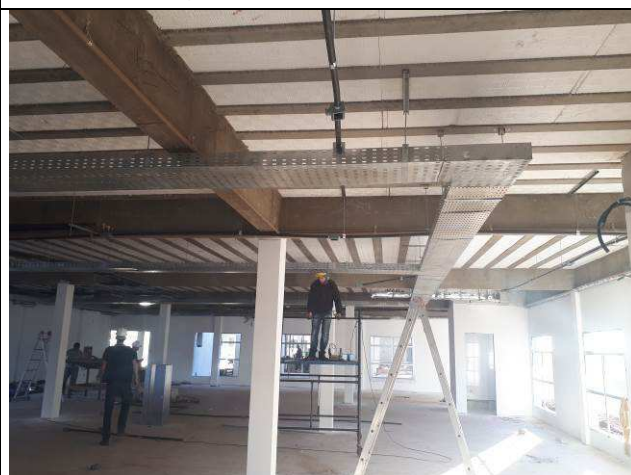
Figura 10E: eletrodutos rígidos roscáveis - derivação para iluminação
