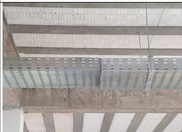
Figura 22E: eletrocalhas #400x100, curvas, cruzetas, tês - quadrante 4
