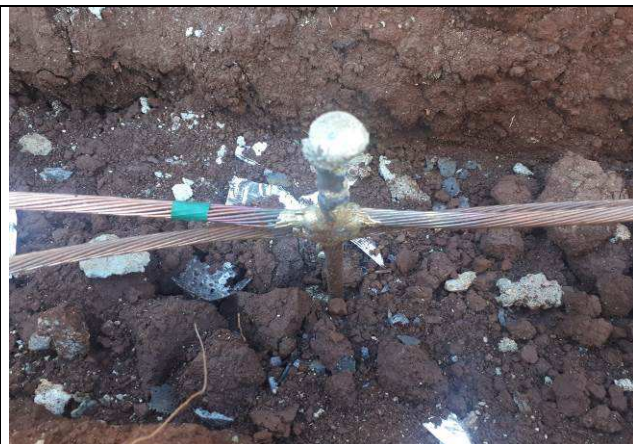
Figura 36E: malha de aterramento - cabos cobre nu, haste, caixa, solda
