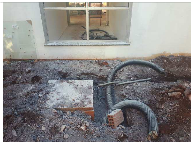
Figura 04E: Infraestrutura externa dutos 2"
