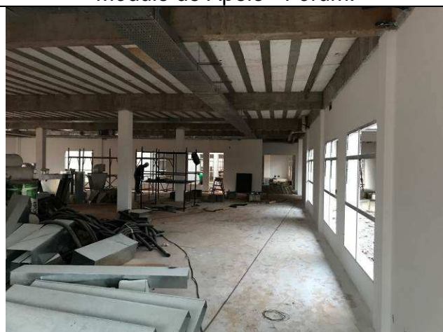
Figura 83C: Paredes com massa PVA - Módulo de Apoio - Fórum.
