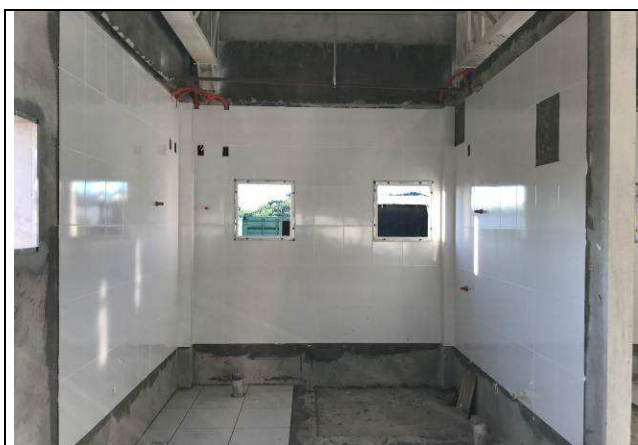
Figura 17C: Azulejos assentados - instalações sanitárias - Arquivo.
