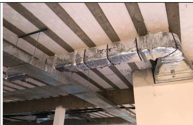
Figura 45C: Dutos de insuflamento instalados - 3ª Vara.
