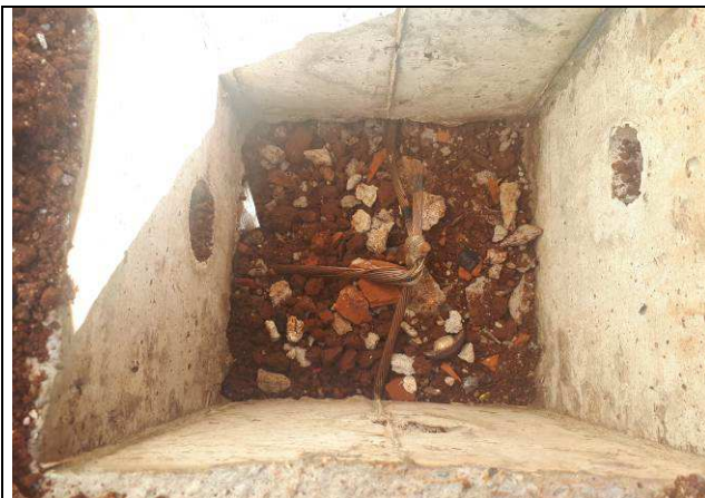
Figura 31E: malha de aterramento - cabos cobre nu, haste, caixa, solda
