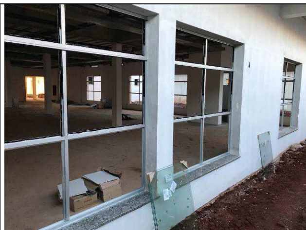
Figura 10C: Quadros fixos das esquadrias de 1,80x1,80m - Fórum.
