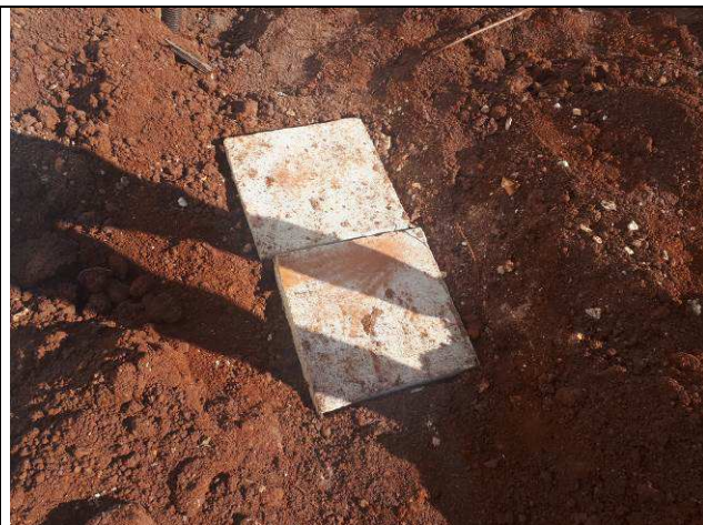
Figura 01E: Infraestrutura externa dutos 2"
