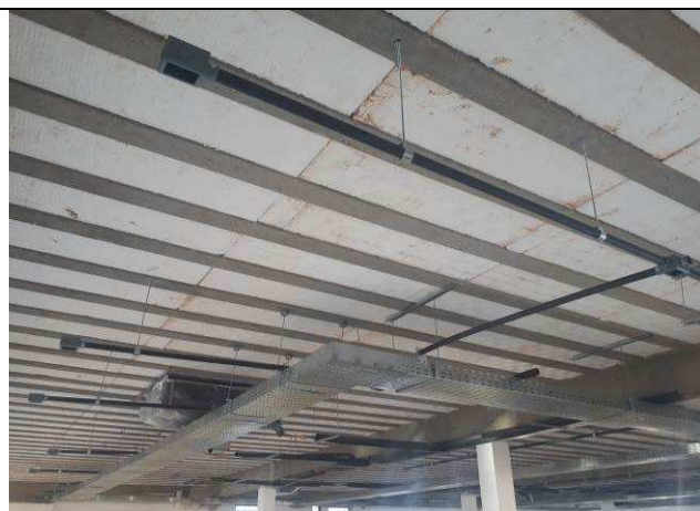
Figura 17E: eletrocalhas #400x100, curvas, cruzetas, tês - quadrante 2
