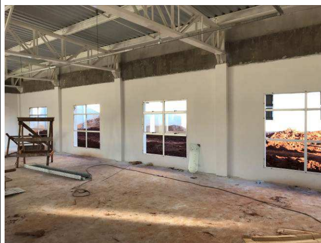
Figura 02C: Quadros fixos das esquadrias de 1,80x1,80m - Arquivo.
