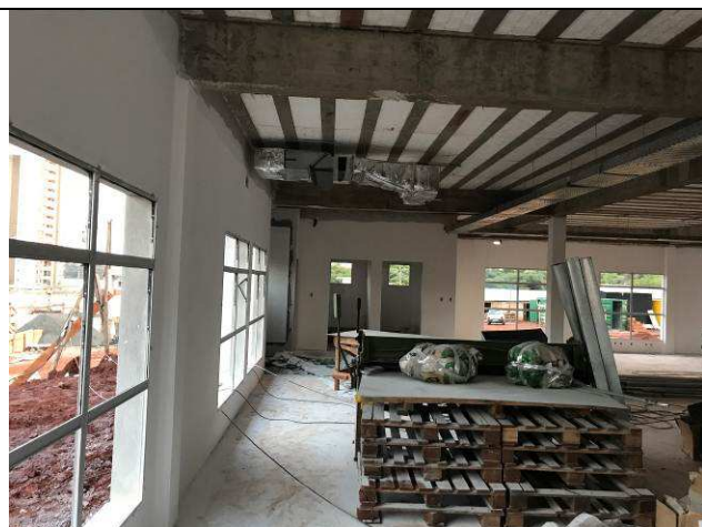
Figura 81C: Paredes com massa PVA - Módulo de Apoio - Fórum.
