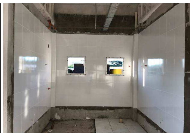
Figura 18C: Azulejos assentados - instalações sanitárias - Arquivo.
