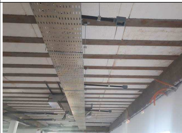
Figura 18E: eletrocalhas #400x100, curvas, cruzetas, tês - quadrante 2
