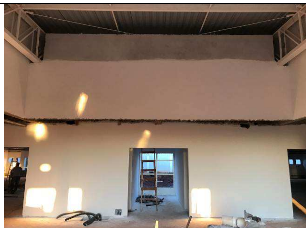
Figura 77C: Paredes com massa PVA - Hall central - Fórum.
