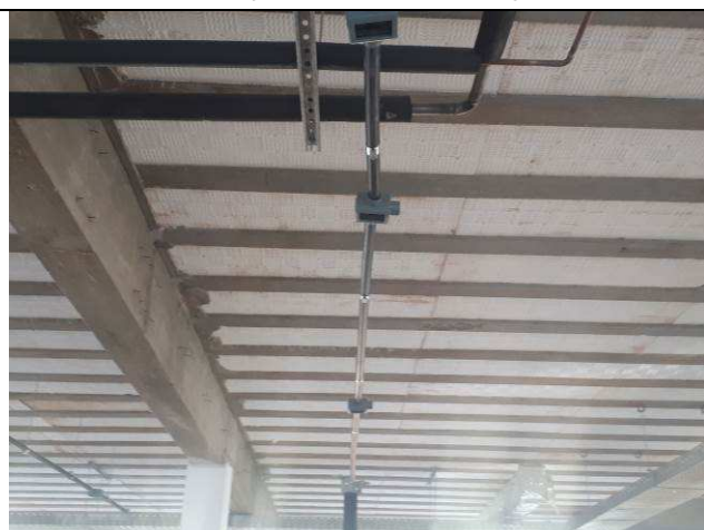
Figura 11E: eletrodutos rígidos roscáveis - derivação para iluminação
