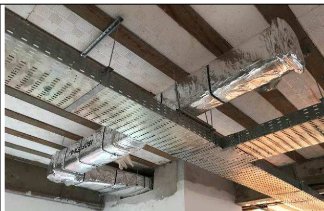
Figura 46C: Dutos de insuflamento instalados - 2ª Vara.
