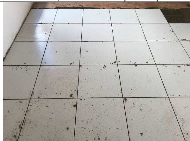
Figura 28C: Assentamento piso cerâmico - 1ª Vara - Fórum.
