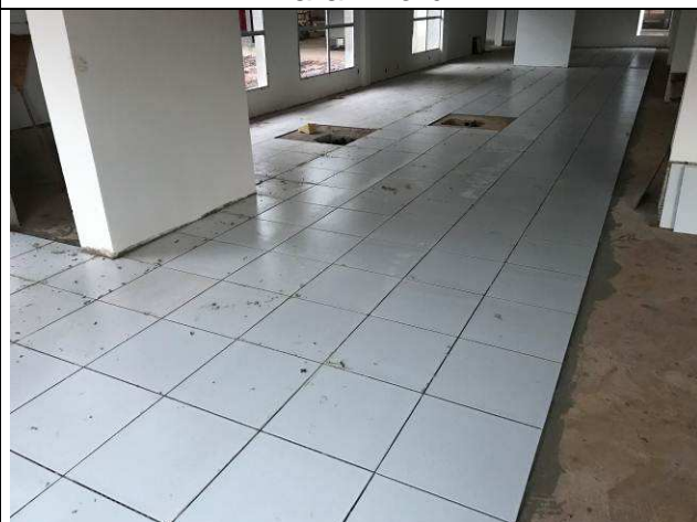
Figura 30C: Assentamento piso cerâmico - 1ª Vara - Fórum.
