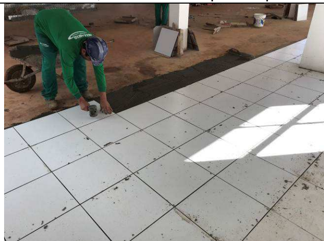
Figura 27C: Assentamento piso cerâmico - 1ª Vara - Fórum.
