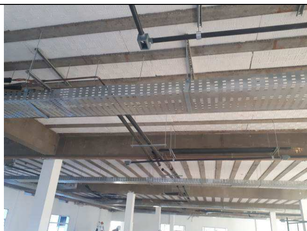
Figura 09E: eletrodutos rígidos roscáveis - derivação para iluminação
