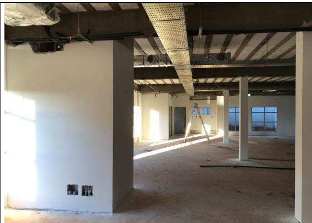
Figura 69C: Paredes com massa PVA - 3ª Vara - Fórum.
