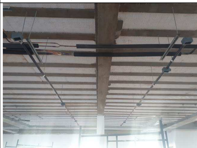
Figura 12E: eletrodutos rígidos roscáveis - derivação para iluminação
