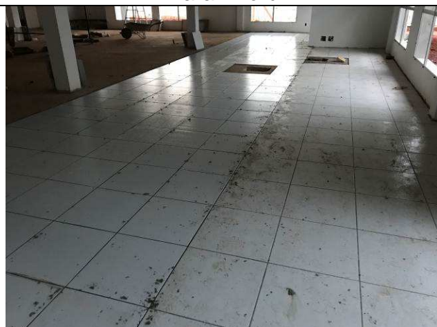
Figura 29C: Assentamento piso cerâmico - 1ª Vara - Fórum.
