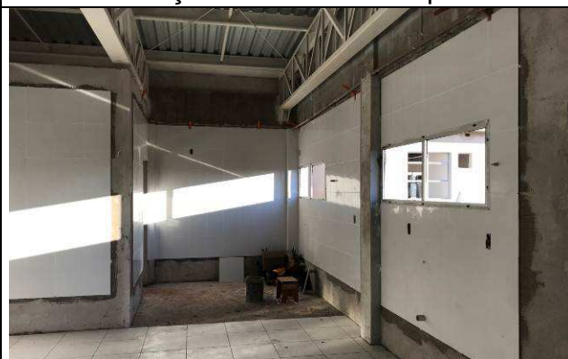
Figura 20C: Azulejos assentados - copa e área de serviço - Arquivo.
