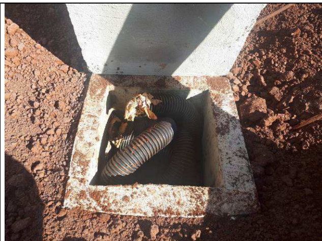
Figura 02E: Infraestrutura externa dutos 2"
