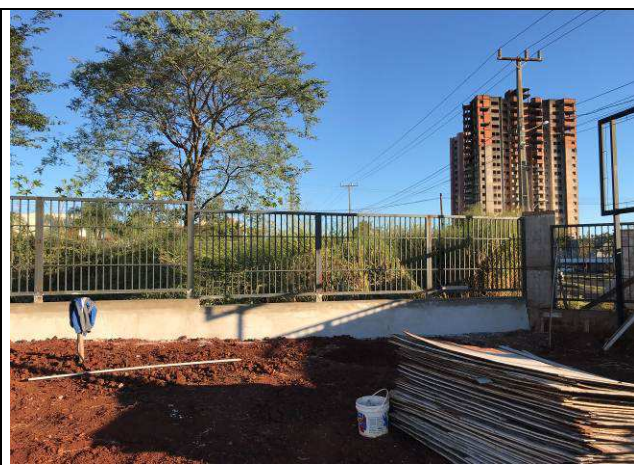
Figura 67C: Gradil de fechamento.
