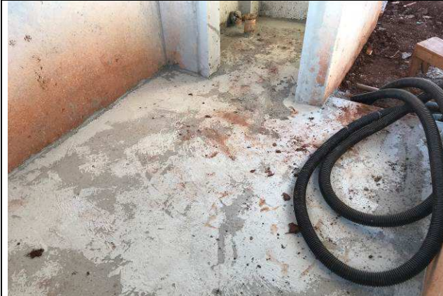
Figura 29E: Infraestrutura externa dutos 2"
