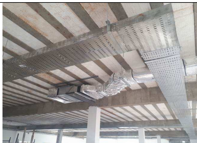
Figura 21E: eletrocalhas #400x100, curvas, cruzetas, tês - quadrante 4
