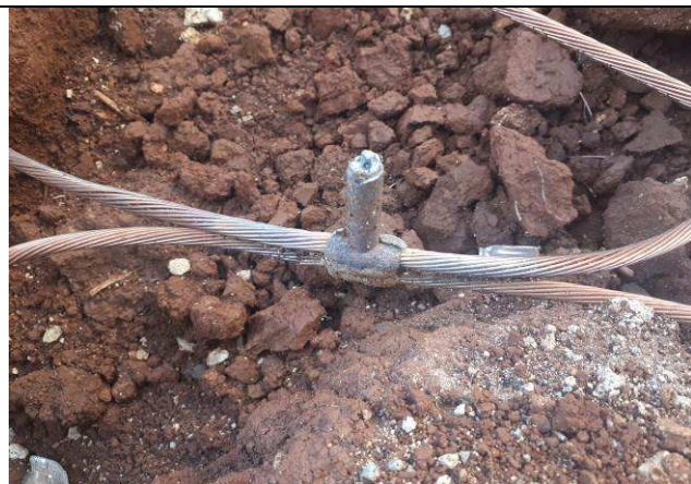
Figura 35E: malha de aterramento - cabos cobre nu, haste, caixa, solda
