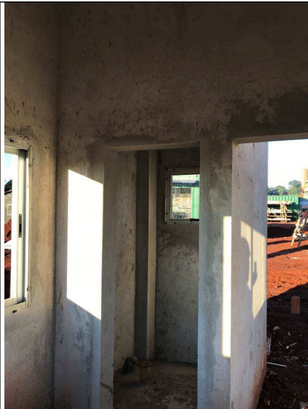
Figura 21C: Revestimento argamassado - Guarita.
