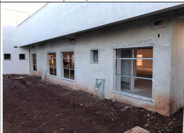
Figura 12C: Quadros fixos das esquadrias de 1,80x1,80m - Fórum.
