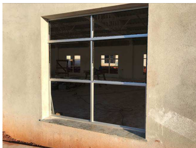
Figura 01C: Quadros fixos das esquadrias de 1,80x1,80m - Arquivo.
