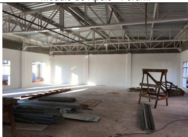
Figura 85C: Paredes com massa PVA - Módulo de Apoio - Arquivo.
