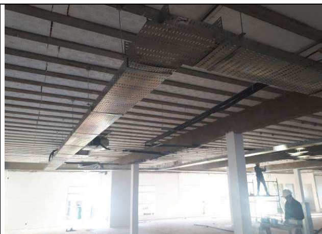
Figura 20E: eletrocalhas #400x100, curvas, cruzetas, tês - quadrante 3
