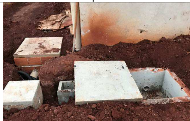
Figura 43C: Caixas águas pluviais e esgoto - Arquivo.
