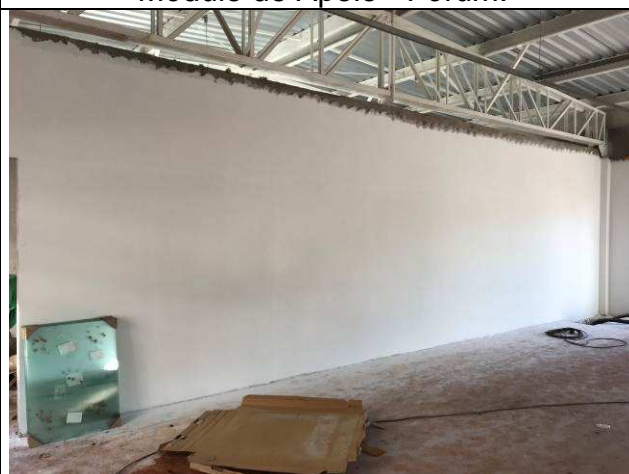
Figura 84C: Paredes com massa PVA - Arquivo.
