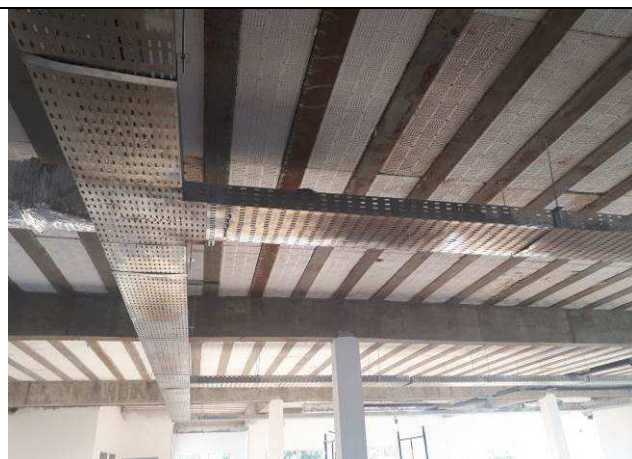
Figura 13E: eletrocalhas #400x100, curvas, cruzetas, tês - quadrante 1
