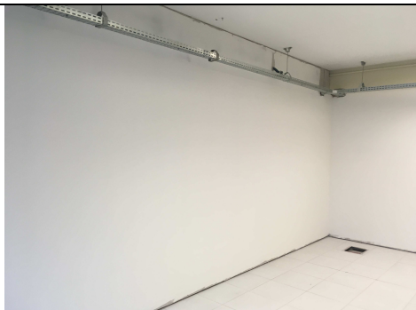
Figura 15C: Foi aplicado fundo selador látex pva em paredes, uma demão em divisória de gesso acartonado novo, e emassamento com massa pva em divisória de gesso acartonado nova.
