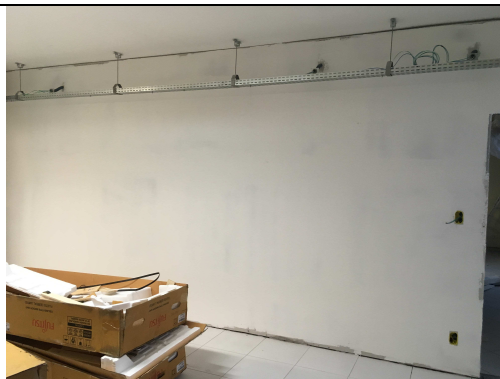
Figura 16C: Foi aplicado fundo selador látex pva em paredes, uma demão em divisória de gesso acartonado novo, e emassamento com massa pva em divisória de gesso acartonado nova.
