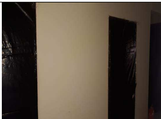
Figura 03C: Fornecimento de lona plástica preta, para proteção.
