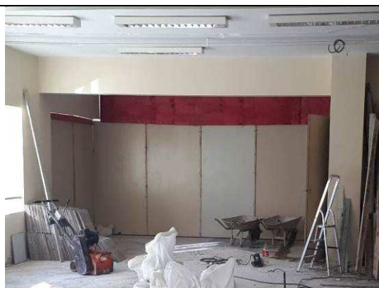
Figura 02C: Execução de tapume de chapa de madeira compensada, e= 6mm.
