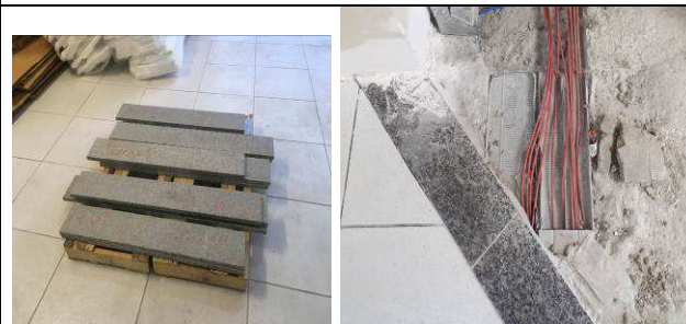
Figura 12C: Foram instaladas soleiras de granito polido, sob as portas
