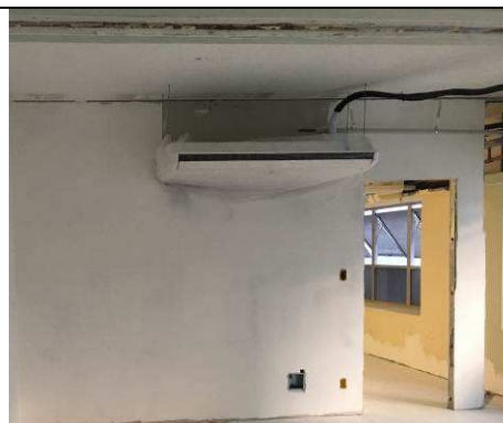
Figura 14C: Foram removidos todos os equipamentos de ar condicionado e reinstalados os equipamentos de ar condicionado, inclusive os drenos de 25 mm e 32 mm.
