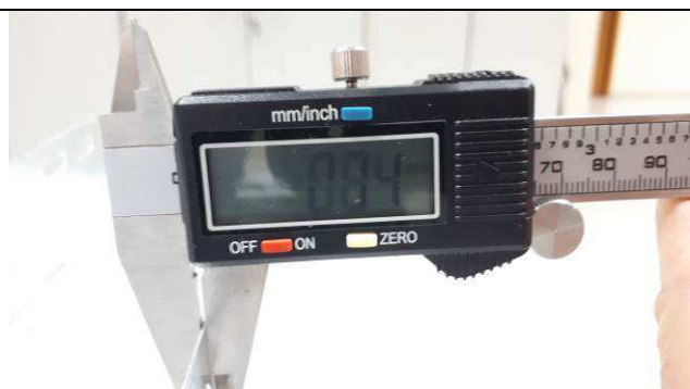
Figura 11E: Infraestrutura de eletrocalhas - espessura calha (foto 100x50)
