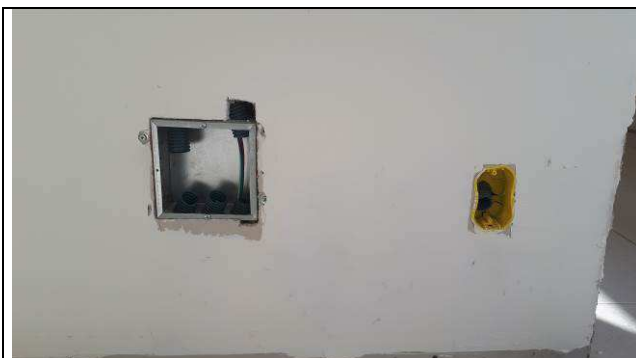
Figura 27E: Caixas de passagem - salas de audiências
