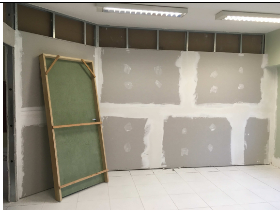
Figura 11C: Esquadrias trazidas do imóvel do Cajuru.
