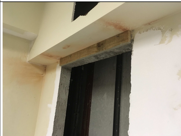
Figura 10C: Execução de vergas e contravergas, além dos requadros de vãos.
