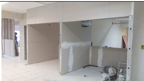
Figura 09C: Foram fornecidas placas para execução de parede em gesso acartonado simples (e= 100 mm) e dupla (e=125 mm)
