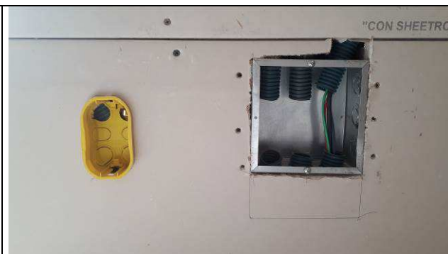
Figura 28E: Caixas de passagem - salas de audiências
