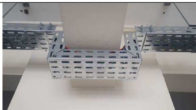
Figura 07E: Infraestrutura de eletrocalhas - desvios nas vigas
