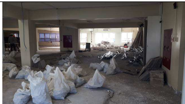
Figura 01E: Retirada das instalações a serem desativadas
