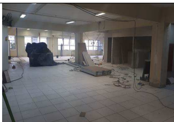
Figura 06C: Assentamento de pisos cerâmico 45x 45, assentado com argamassa colante ACI e rejunte flexível.
