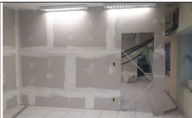
Figura 08C: Foram fornecidas placas para execução de parede em gesso acartonado simples (e= 100 mm) e dupla (e=125 mm)
