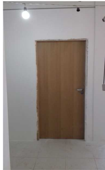
Figura 09C: Porta de acesso à sala técnica
