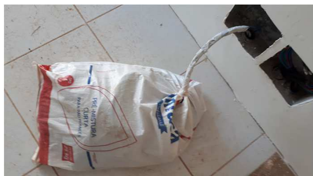
Figura 22E: infraestrutura interna: eletrodutos, caixas
