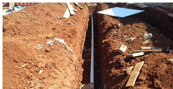
Figura 04C: vala aberta na lateral direita
