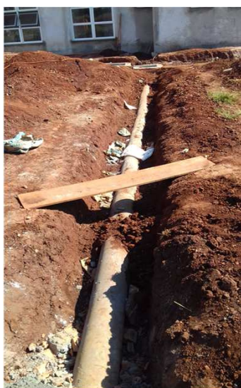
Figura 45C: tubo de concreto 200mm
