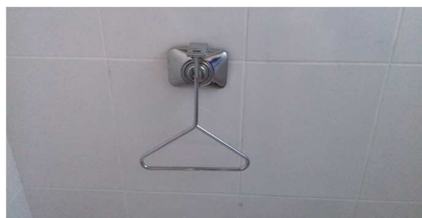
Figura 56C: acabamento de válvula de descarga PNE, no sanitário PNE público
