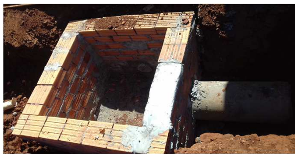
Figura 48C: caixa de inspeção 80x80xm pluvial
