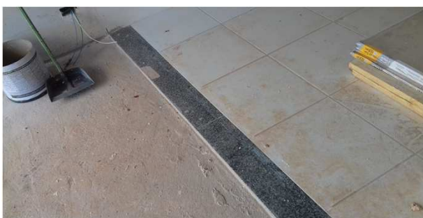
Figura 32C: soleira na entrada principal do imóvel
