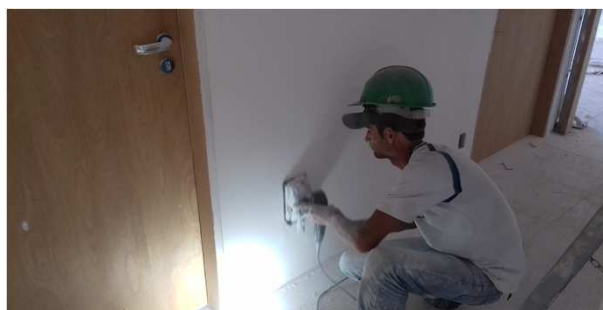
Figura 60C: operário realizando o lixamento de massa corrida
