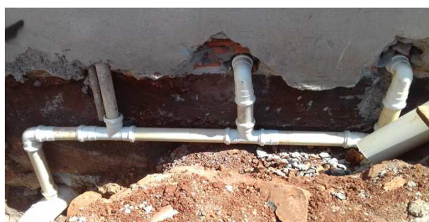
Figura 03C: valas abertas para passagem de esgoto, junto aos sanitários públicos
