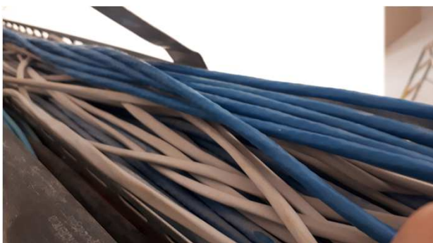
Figura 24E: infraestrutura interna: eletrodutos, caixas
