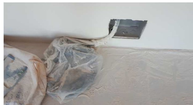
Figura 25E: infraestrutura interna: eletrodutos, caixas
