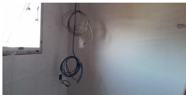
Figura 26C: azulejo instalado em sanitário PNE
