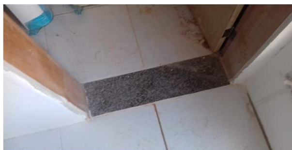
Figura 31C: soleira junto a sanitário do juiz auxiliar
