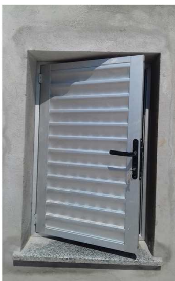
Figura 15C: porta de acesso ao reservatório
