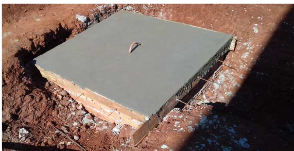
Figura 47C: caixa de inspeção 90x90cm pluvial
