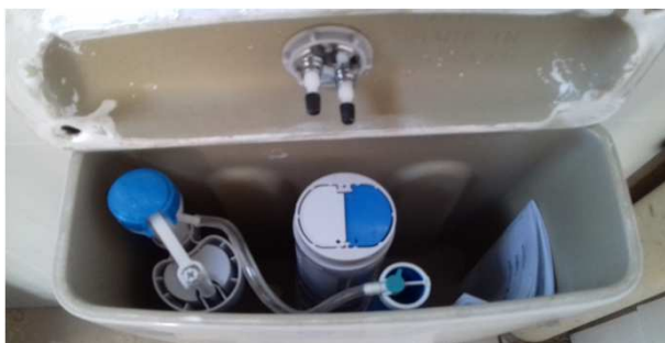
Figura 51C: detalhe do sistema de acionamento e alimentação da caixa
