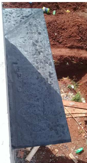
Figura 17C: marquize de canto, impermeabilizada
