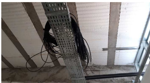
Figura 23E: infraestrutura interna: eletrodutos, caixas
