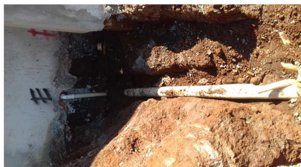
Figura 02C: vala aberta e tubulação de esgoto assentada, nos fundos
