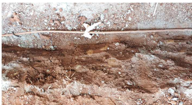
Figura 15E: Sistema de captação SPDA - fitas de alumínio.
