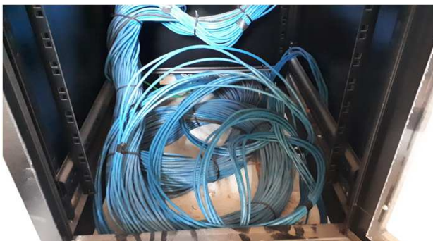
Figura 26E: infraestrutura interna: eletrodutos, caixas de piso
