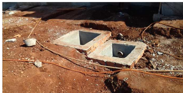
Figura 42C: caixa de inspeção de 60x60cm de esgoto e outra de pluvial
