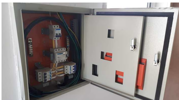
Figura 13E: infraestrutura interna - eletrocalhas, eletrodutos
