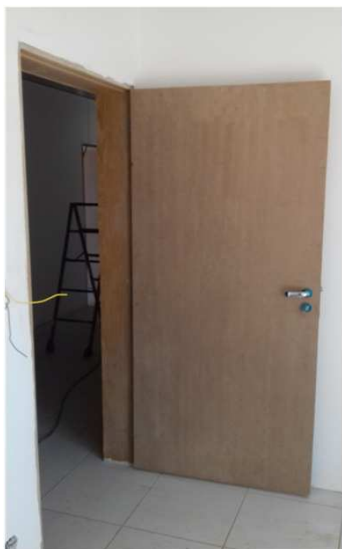
Figura 07C: Porta de acesso à OAB
