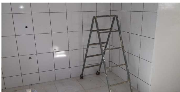
Figura 25C: azulejo instalado na copa do arquivo
