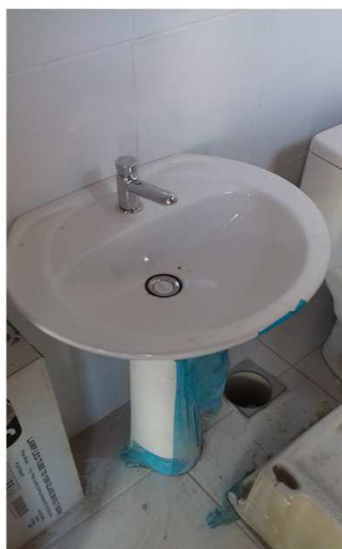
Figura 53C: lavatório em sanitário da secretaria
