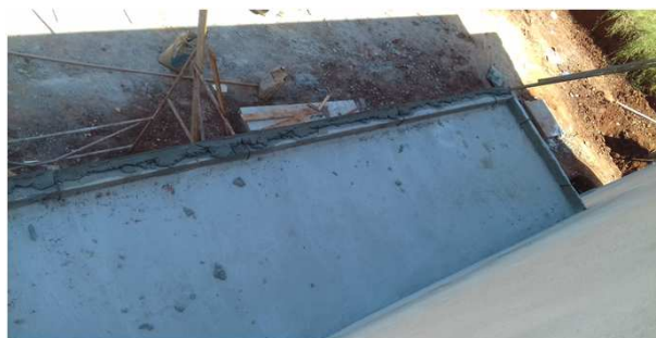
Figura 21C: marquize frontal, após proteção mecânica executada
