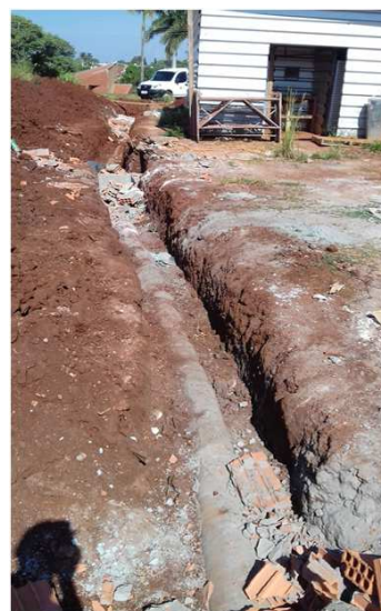
Figura 46C: tubo de concreto 300mm
