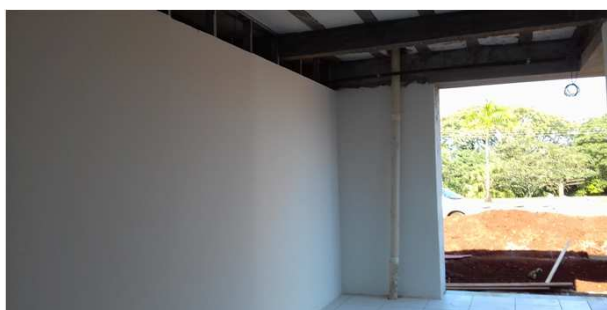
Figura 59C: massa corrida aplicada e lixada - OAB
