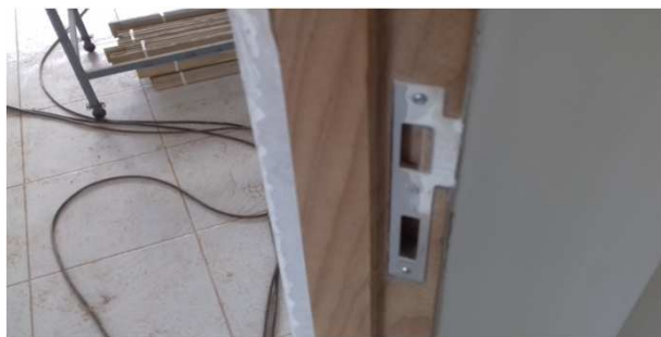
Figura 10C: detalhe de espelho de travamento da porta
