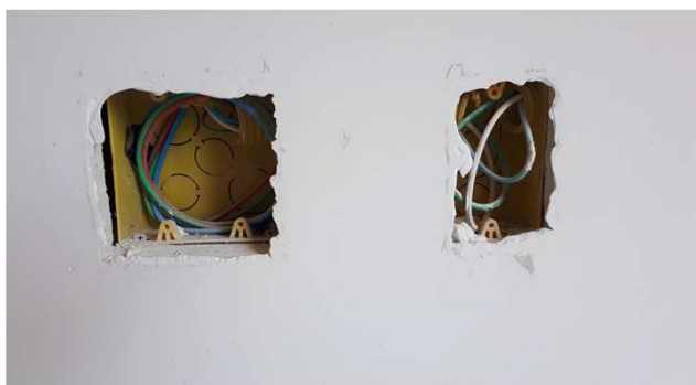
Figura 03E: entrada de energia elétrica e telecomunicações
