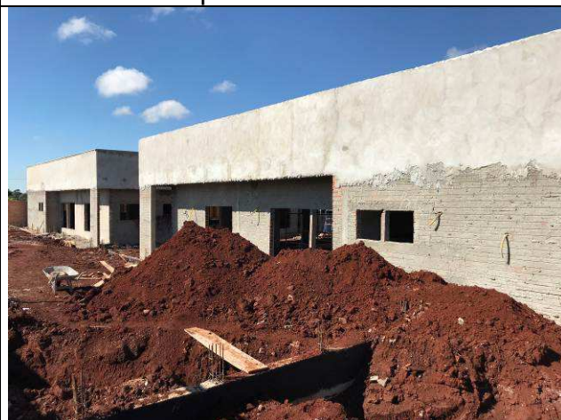
Figura 47C: Revestimento argamassado das paredes externas.
