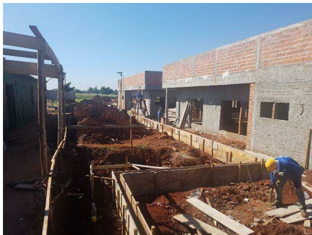
Figura 03C: Muro de arrimo.
