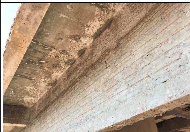
Figura 34C: Entelamento para prevenção de trincas.
