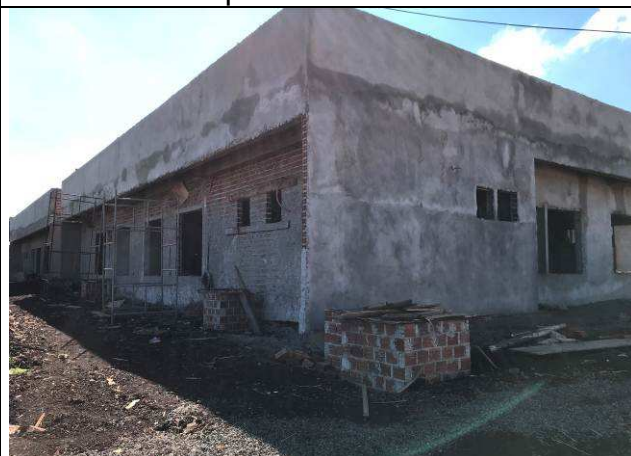
Figura 45C: Revestimento argamassado das paredes externas.
