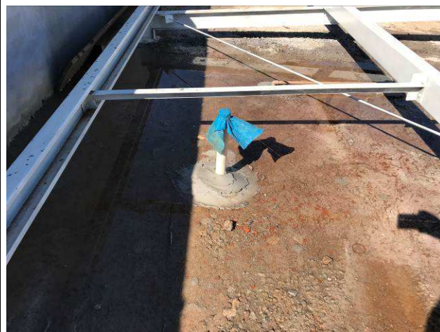
Figura 66C: Pontos de esgoto - tubulação de ventilação na laje de cobertura.
