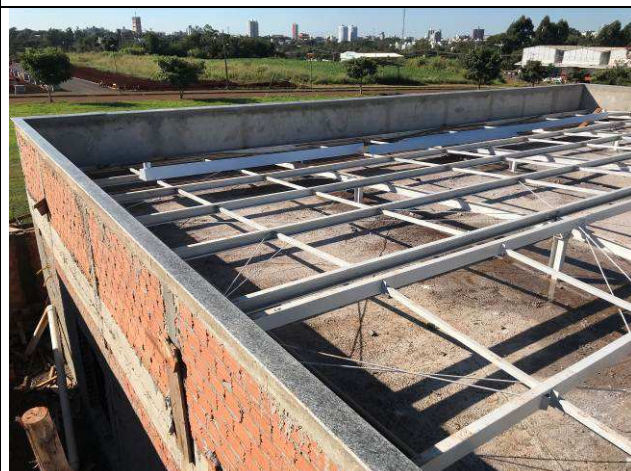
Figura 24C: Capeamento da platibanda.
