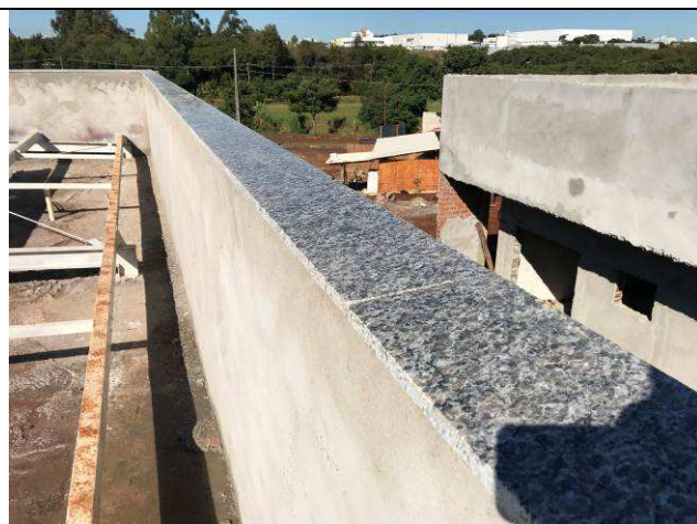
Figura 25C: Copeamento da platibanda.
