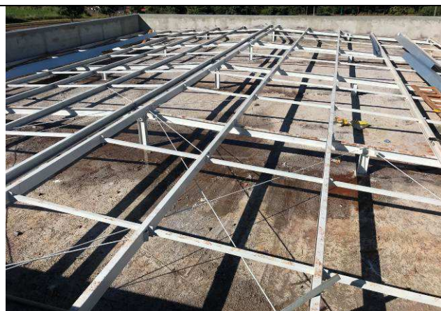
Figura 19C: Estrutura metálica de cobertura.
