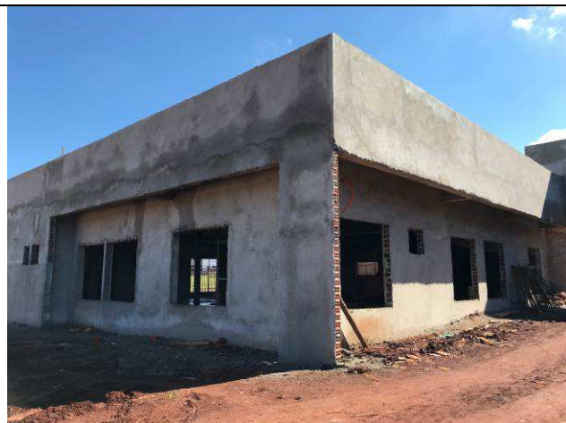
Figura 42C: Revestimento argamassado das paredes externas.
