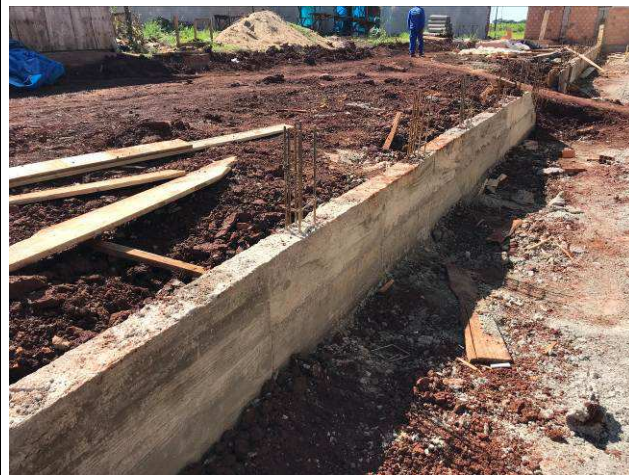
Figura 06C: Muro de arrimo.
