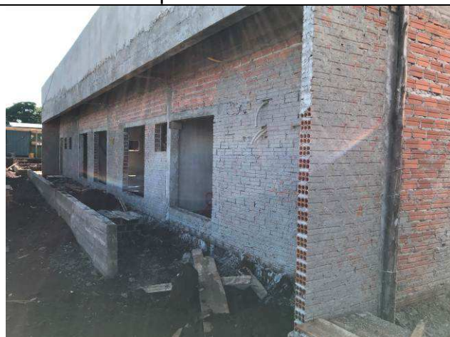
Figura 46C: Revestimento argamassado das paredes externas.
