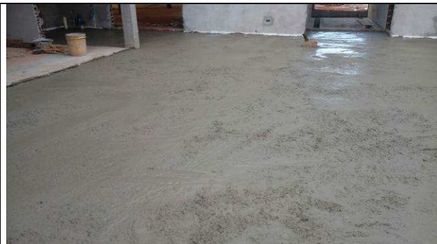
Figura 53C: Contrapiso hall central.
