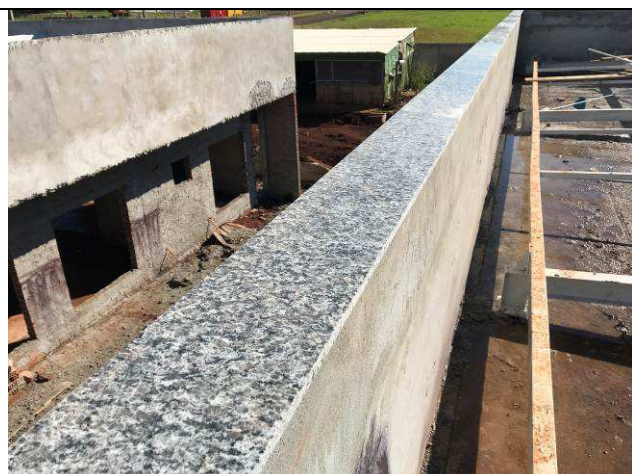
Figura 27C: Copeamento da platibanda.
