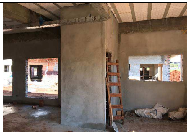
Figura 13C: Paredes de alvenaria.
