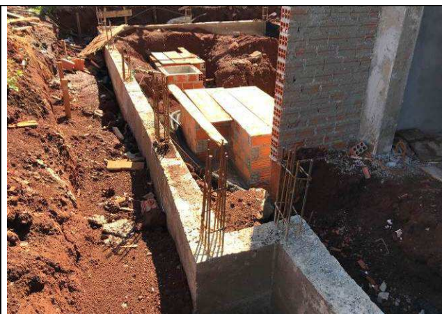
Figura 08C: Muro de arrimo.
