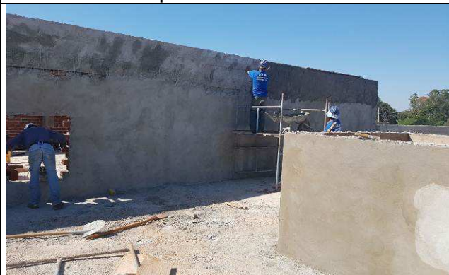
Figura 40C: Revestimento argamassado das paredes externas.
