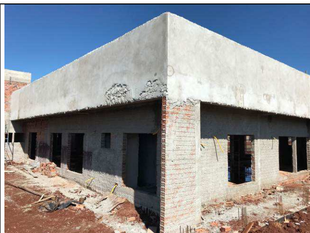
Figura 49C: Revestimento argamassado das paredes externas.
