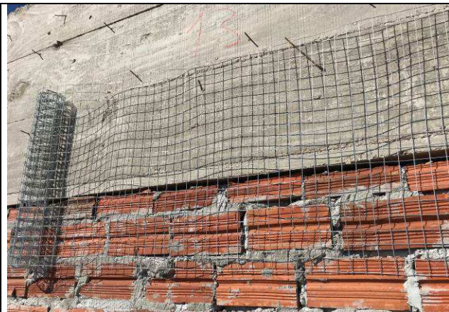
Figura 32C: Entelamento para prevenção de trincas.
