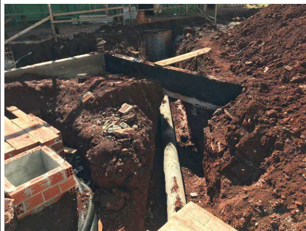
Figura 02C: Escavação de valas para tubulações externas de águas pluviais.
