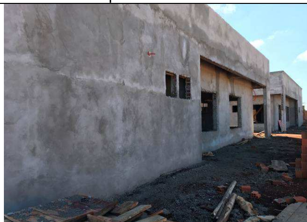
Figura 44C: Revestimento argamassado das paredes externas.
