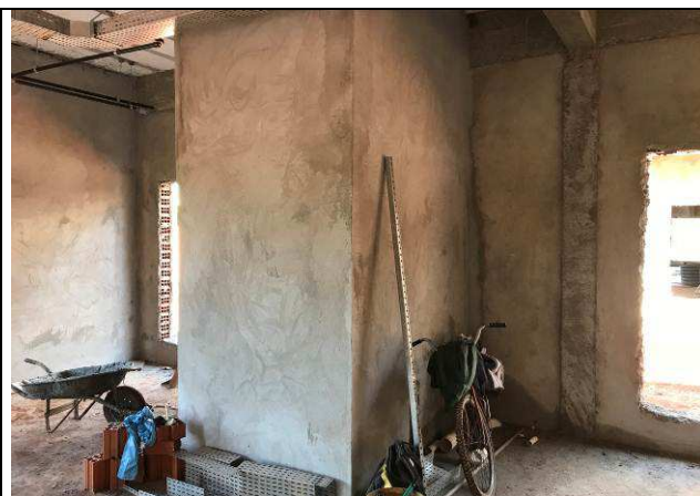
Figura 14C: Paredes de alvenaria.
