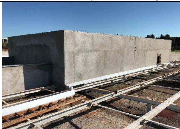
Figura 52C: Revestimento argamassado das paredes externas.
