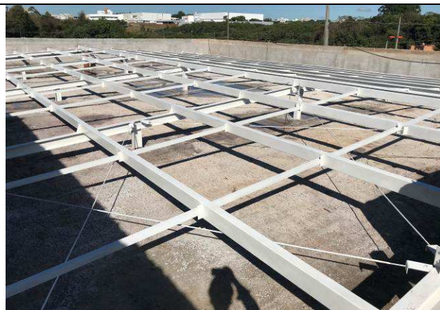
Figura 21C: Estrutura metálica de cobertura.
