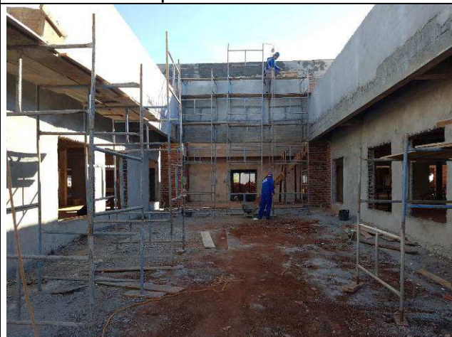
Figura 39C: Revestimento argamassado das paredes externas.
