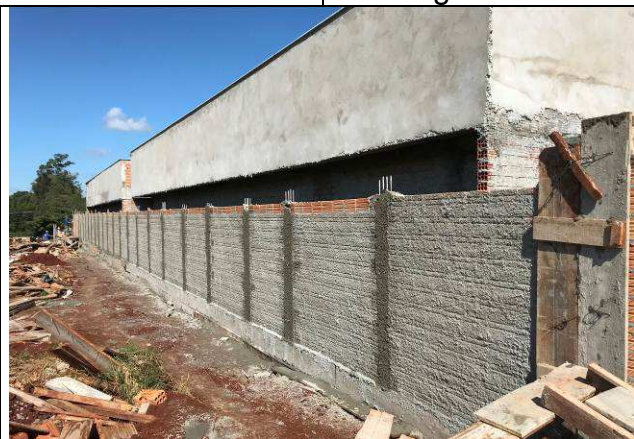
Figura 73C: Muro de fechamento.
