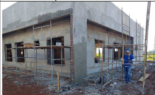
Figura 41C: Revestimento argamassado das paredes externas.
