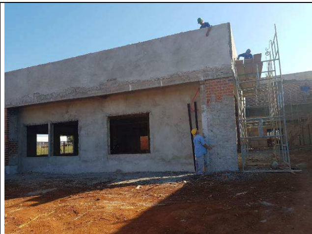
Figura 36C: Revestimento argamassado das paredes externas.
