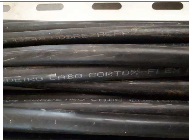
Figura 15E: especificações cabos alimentadores
