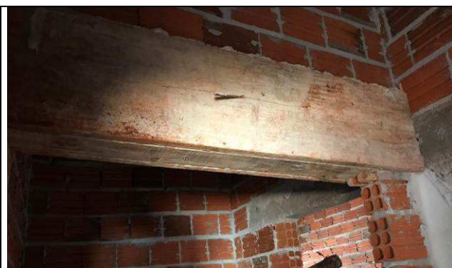
Figura 10C: Vergas e contravergas.
