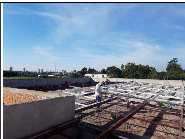
Figura 18C: Estrutura metálica de cobertura.
