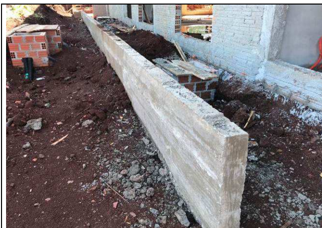
Figura 07C: Muro de arrimo.
