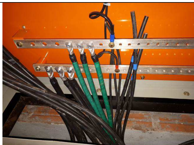
Figura 13E: Ramal alimentador principal medição-QDG
