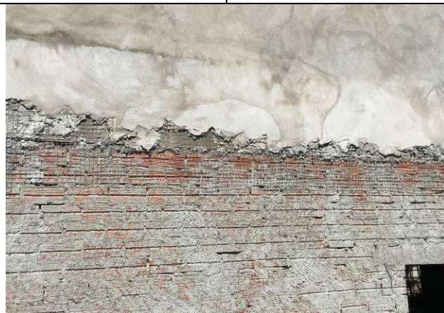
Figura 35C: Entelamento para prevenção de trincas.
