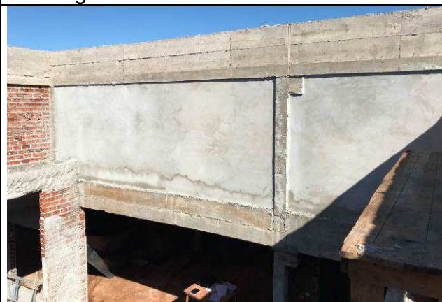
Figura 16C: Paredes de alvenaria.
