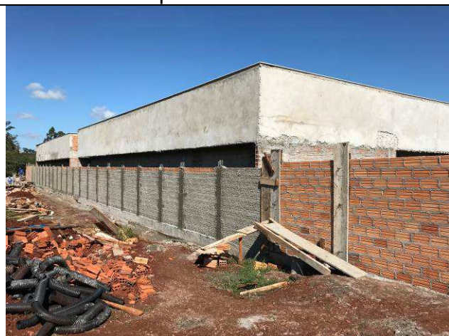
Figura 50C: Revestimento argamassado das paredes externas.
