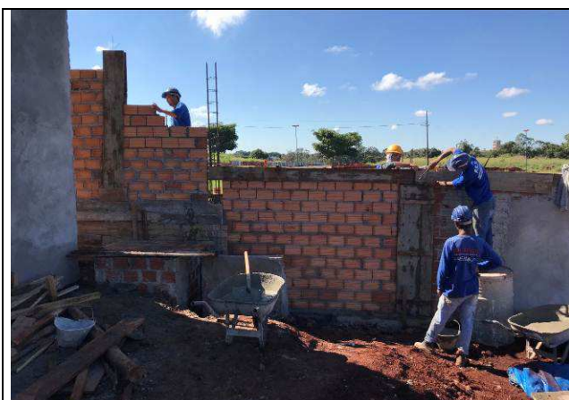
Figura 71C: Muro de fechamento.
