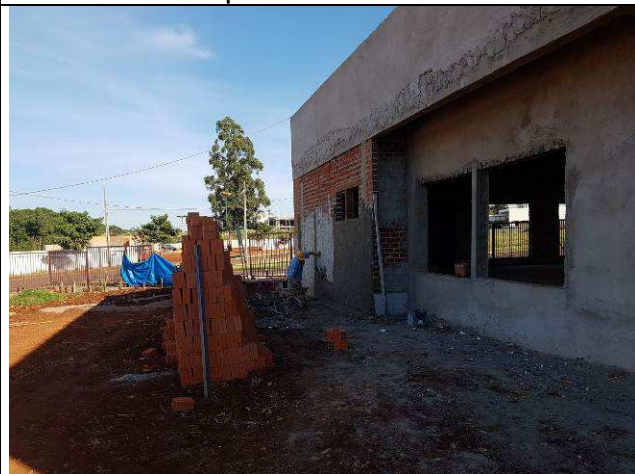
Figura 38C: Revestimento argamassado das paredes externas.
