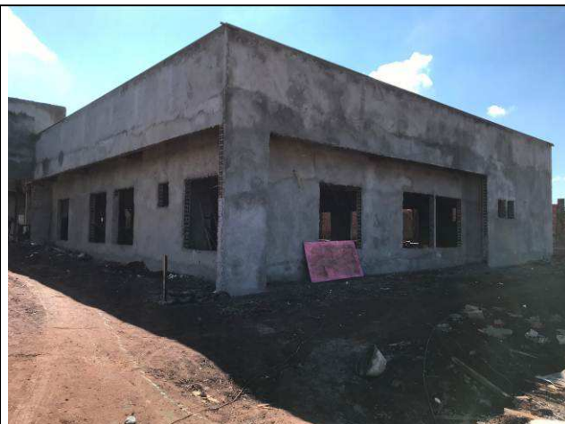
Figura 43C: Revestimento argamassado das paredes externas.
