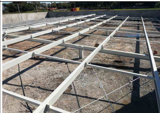
Figura 22C: Estrutura metálica de cobertura.
