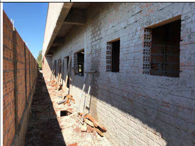
Figura 51C: Revestimento argamassado das paredes externas.
