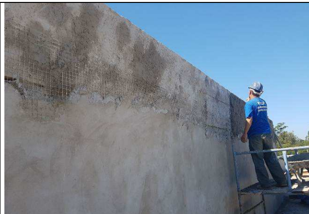
Figura 31C: Entelamento para prevenção de trincas.
