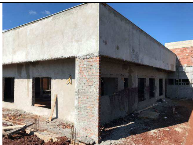
Figura 48C: Revestimento argamassado das paredes externas.
