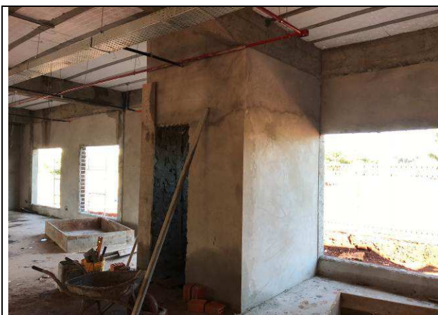
Figura 11C: Paredes de alvenaria.
