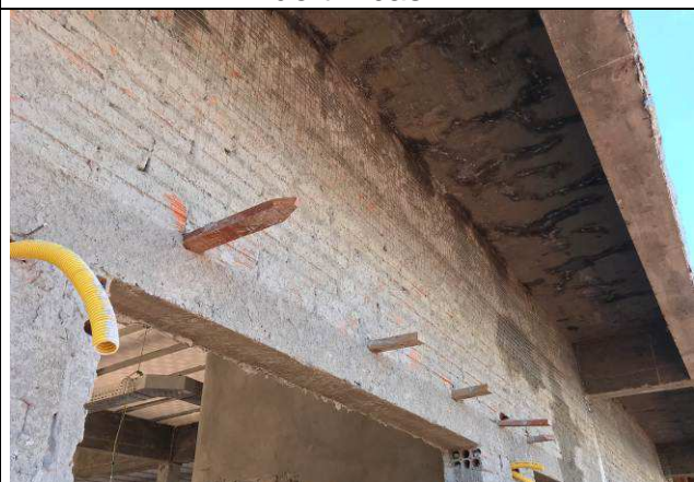
Figura 33C: Entelamento para prevenção de trincas.
