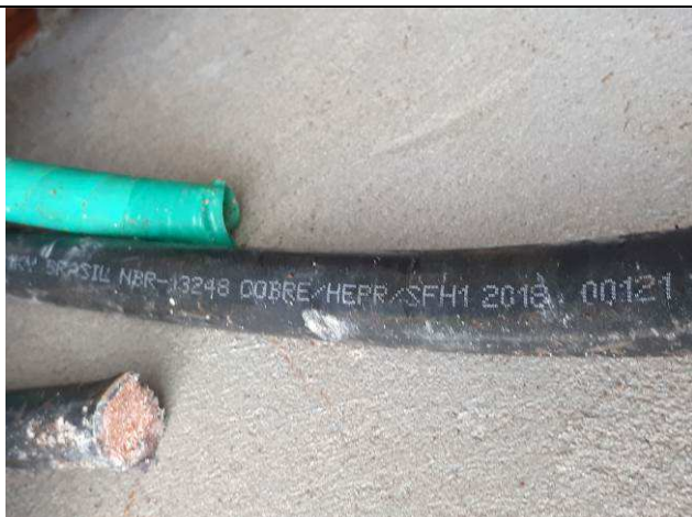
Figura 16E: especificações cabos alimentadores
