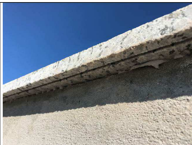
Figura 26C: Copeamento da platibanda.
