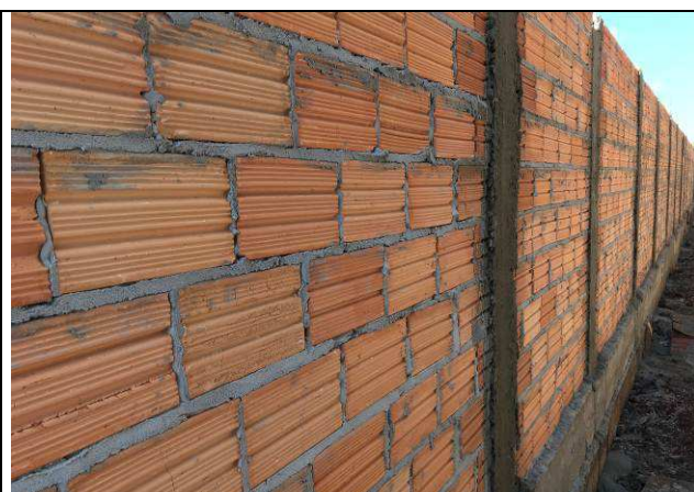
Figura 72C: Muro de fechamento.
