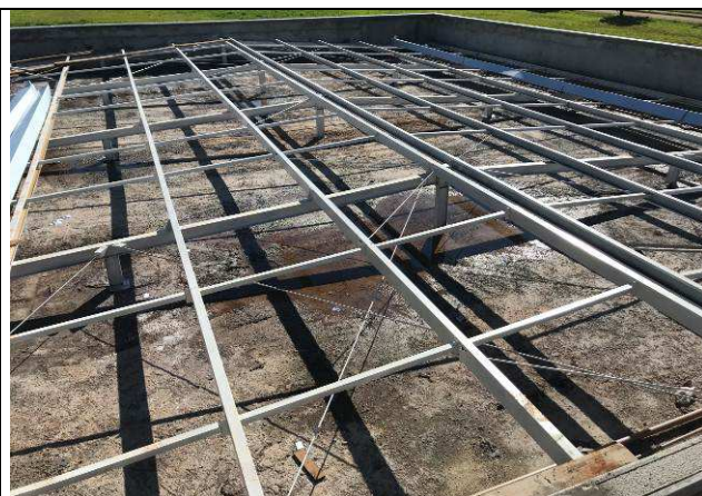
Figura 20C: Estrutura metálica de cobertura.
