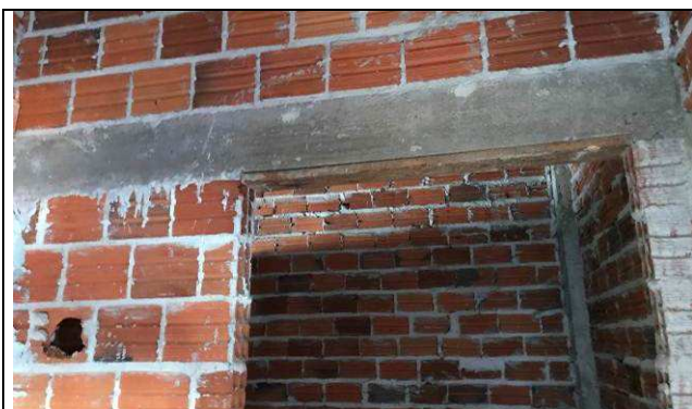
Figura 09C: Vergas e contravergas.
