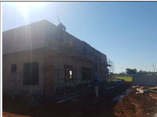
Figura 37C: Revestimento argamassado das paredes externas.
