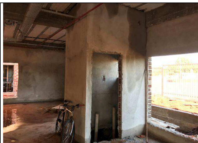
Figura 12C: Paredes de alvenaria.
