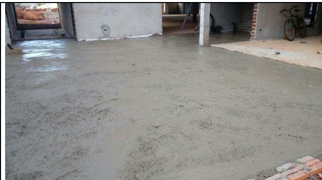
Figura 54C: Contrapiso hall central.
