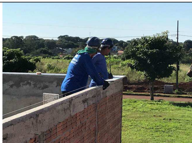
Figura 23C: Assentamento do capeamento da platibanda.
