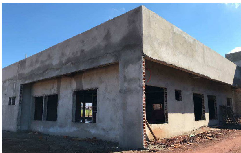
Figura 1 – Fórum - Vista externa.
