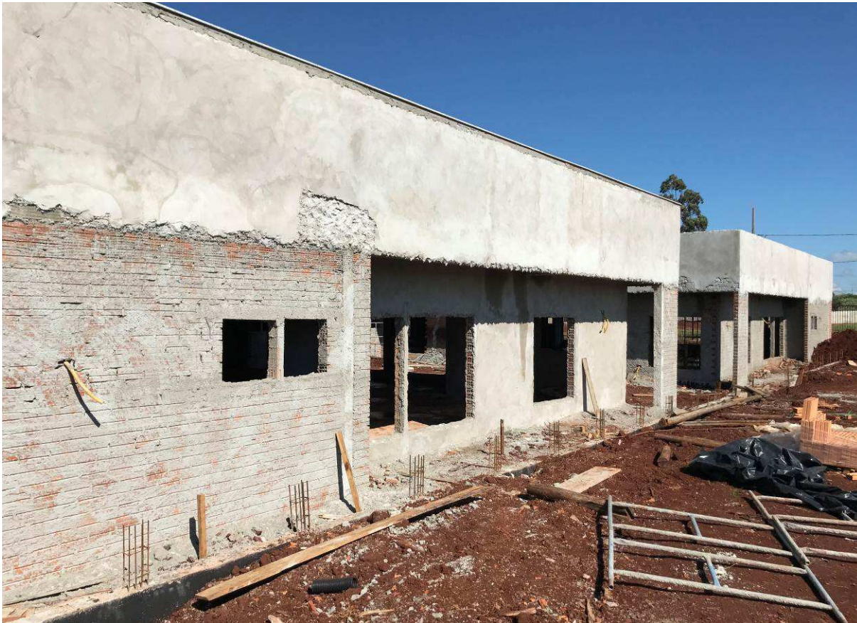
Figura 3 – Fórum - Vista externa.
