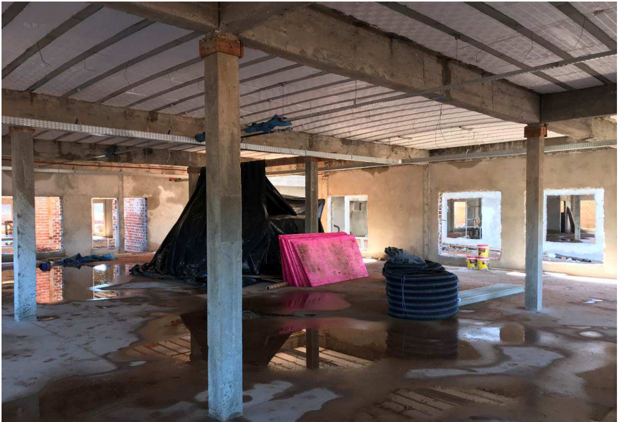
Figura 4 – Fórum - Vista interna.
