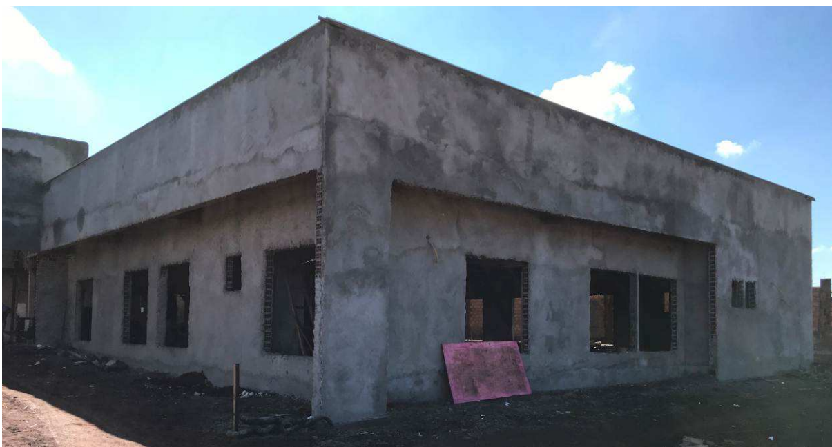
Figura 2 – Fórum - Vista externa.
