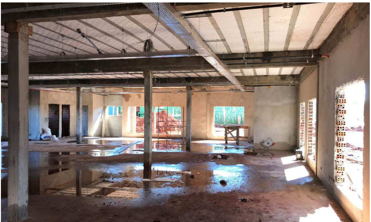
Figura 5 – Fórum - Vista interna.
