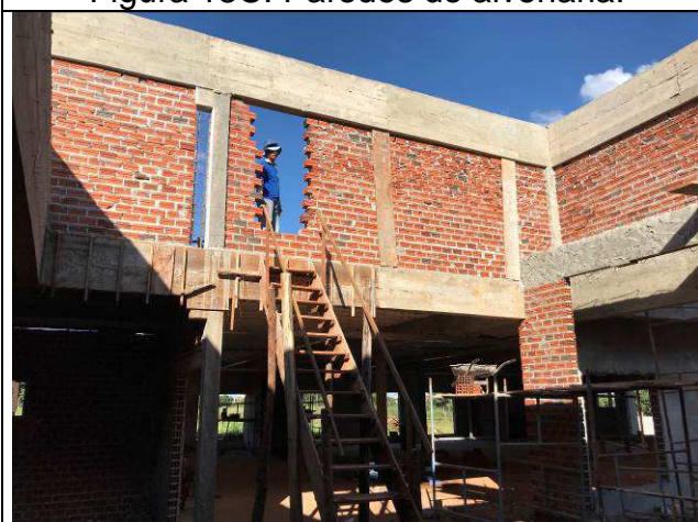
Figura 15C: Paredes de alvenaria.
