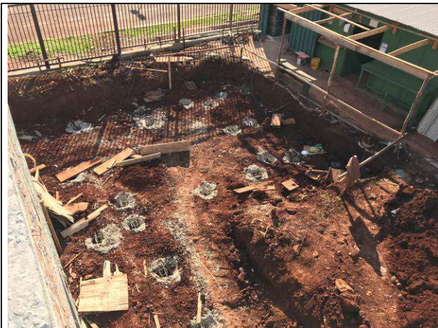
Figura 03C: Estacas - muro de arrimo.
