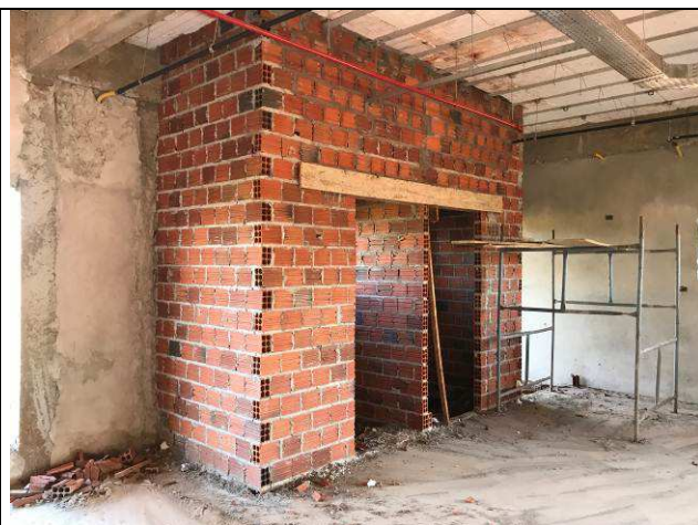
Figura 20C: Paredes de alvenaria.
