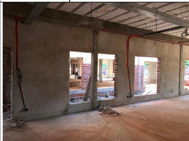
Figura 40C: Revestimento argamassado das paredes internas.
