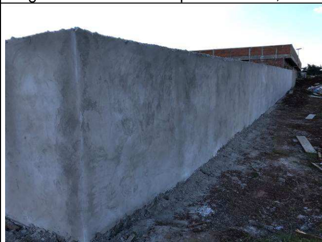
Figura 74C: Muro de fechamento.
