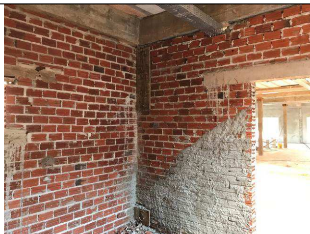
Figura 23C: Paredes de alvenaria.
