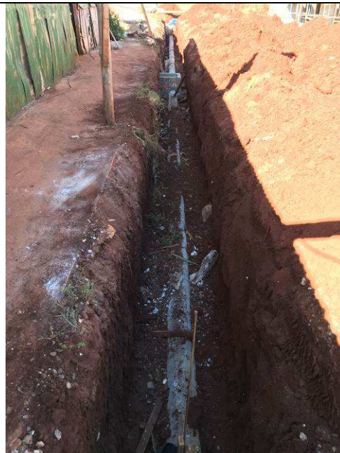
Figura 02C: Escavação de valas para tubulações externas de águas pluviais.
