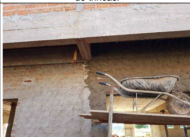
Figura 48C: Entelamento para prevenção de trincas.
