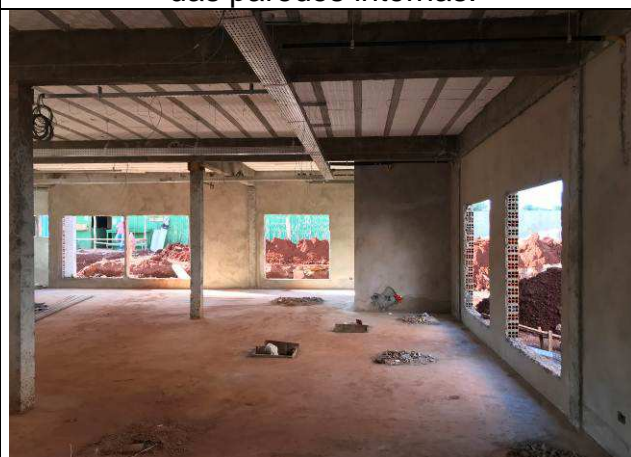
Figura 42C: Revestimento argamassado das paredes internas.
