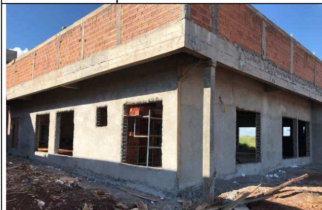
Figura 53C: Revestimento argamassado das paredes externas.
