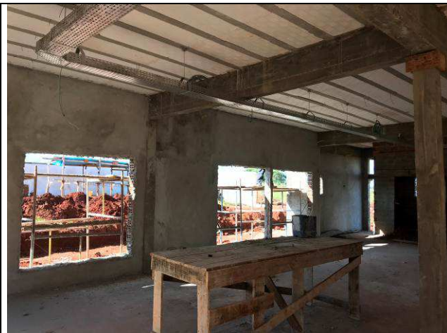
Figura 26C: Revestimento argamassado das paredes internas.
