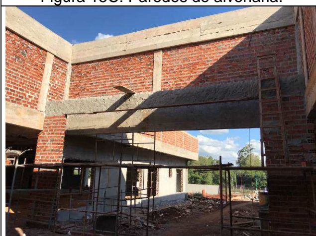
Figura 17C: Paredes de alvenaria.
