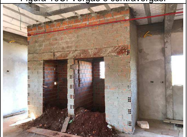
Figura 12C: Vergas e contravergas.
