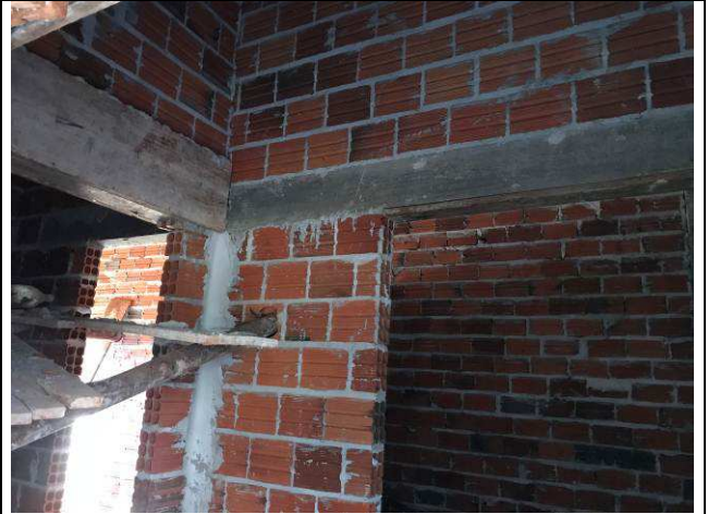
Figura 08C: Vergas e contravergas.
