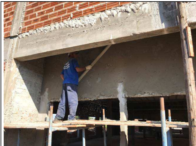
Figura 49C: Revestimento argamassado das paredes externas.
