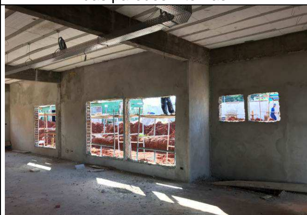
Figura 30C: Revestimento argamassado das paredes internas.
