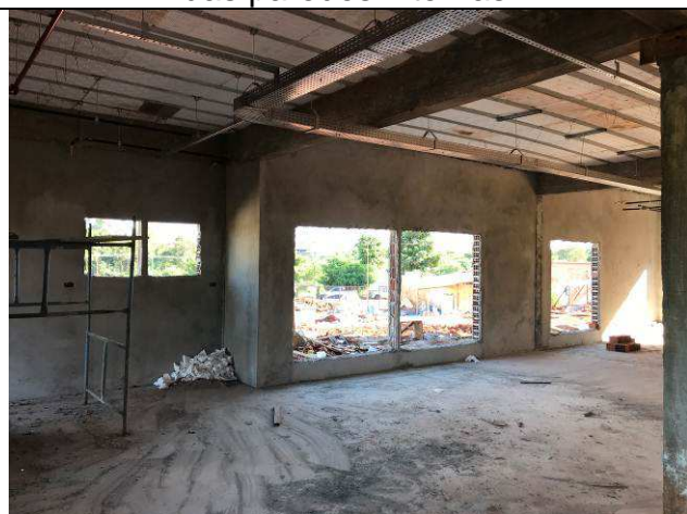
Figura 35C: Revestimento argamassado das paredes internas.
