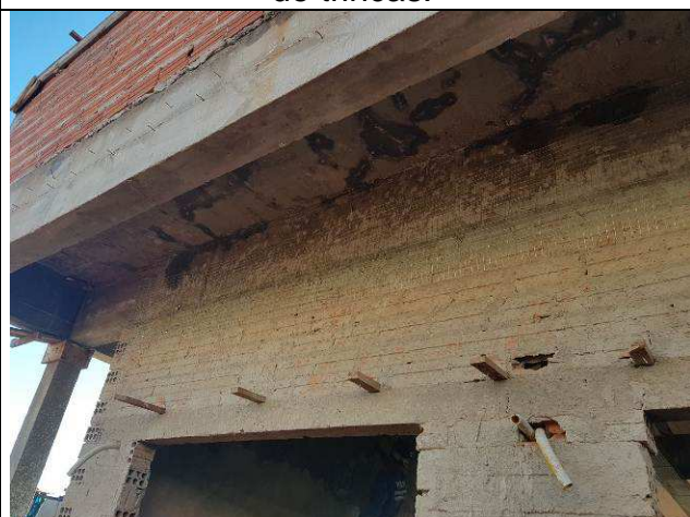
Figura 45C: Entelamento para prevenção de trincas.
