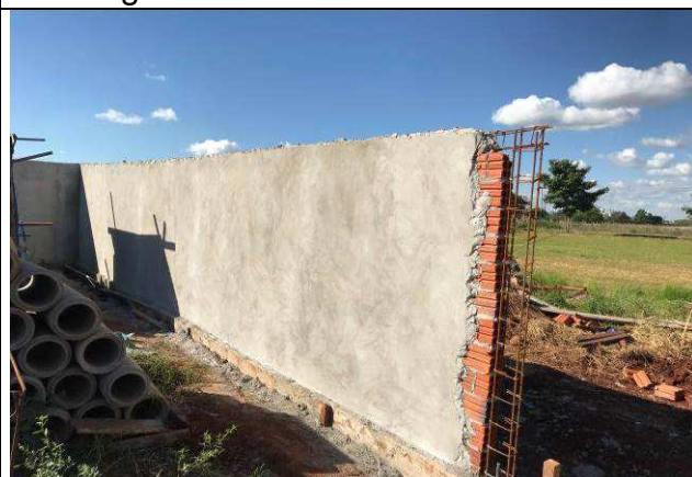
Figura 80C: Muro de fechamento.
