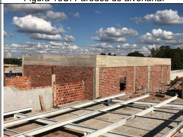
Figura 18C: Paredes de alvenaria.
