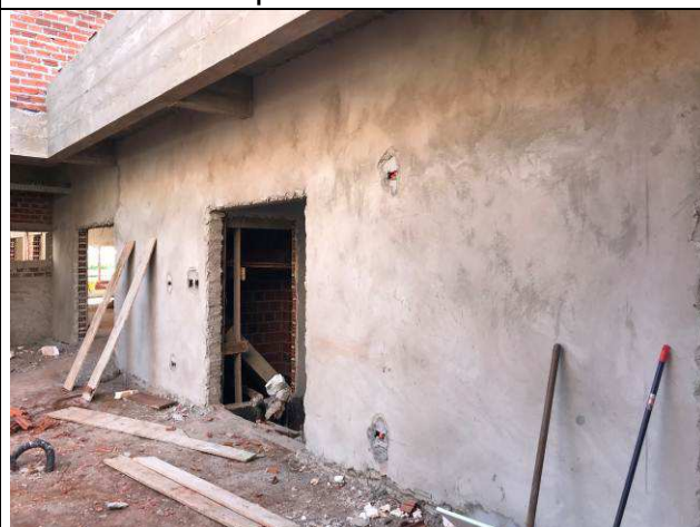
Figura 36C: Revestimento argamassado das paredes internas.
