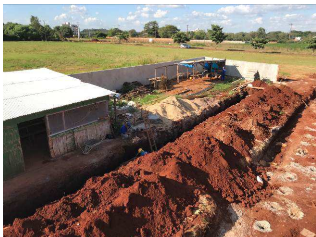
Figura 01C: Escavação de valas para tubulações externas de águas pluviais.
