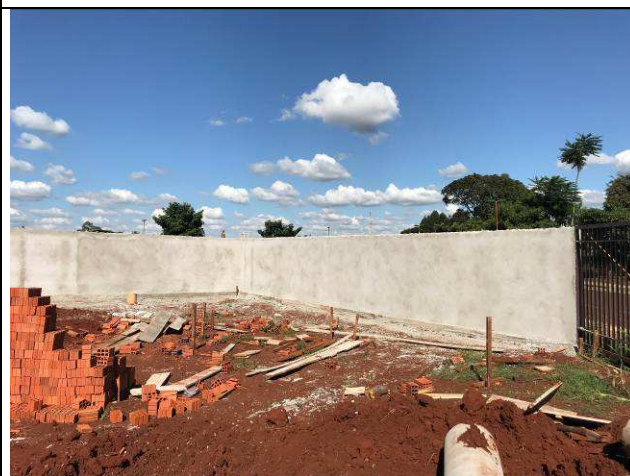
Figura 76C: Muro de fechamento.
