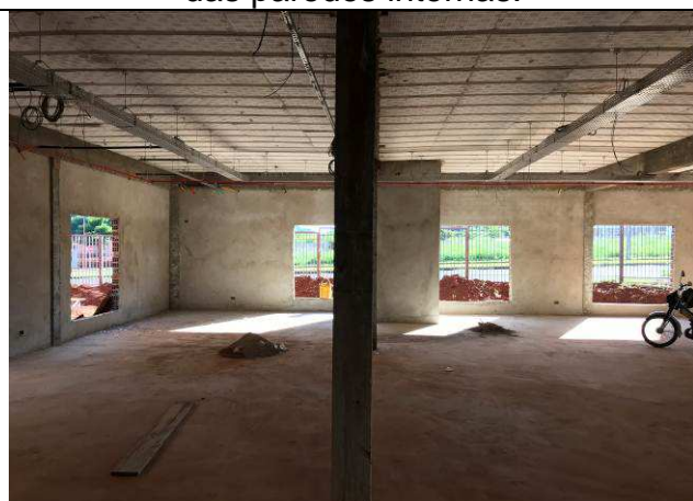
Figura 41C: Revestimento argamassado das paredes internas.
