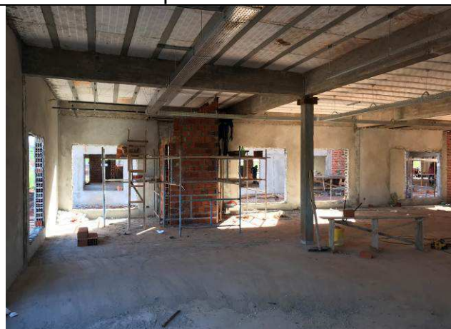
Figura 33C: Revestimento argamassado das paredes internas.
