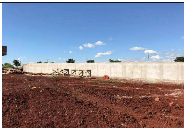
Figura 77C: Muro de fechamento.
