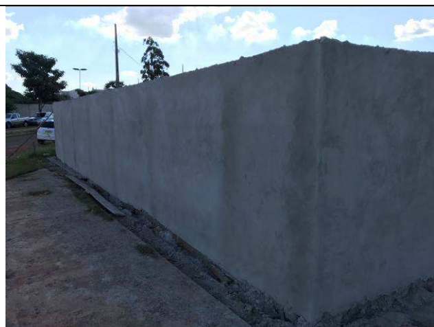
Figura 75C: Muro de fechamento.
