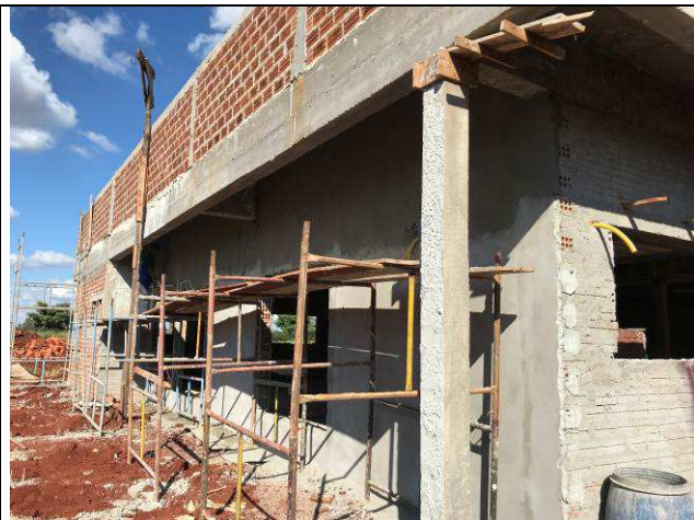
Figura 50C: Revestimento argamassado das paredes externas.
