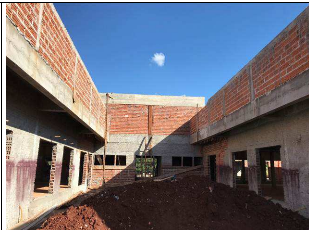
Figura 14C: Paredes de alvenaria.
