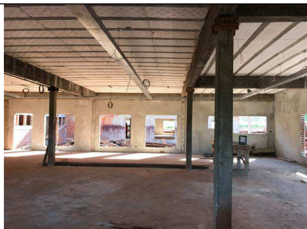
Figura 31C: Revestimento argamassado das paredes internas.
