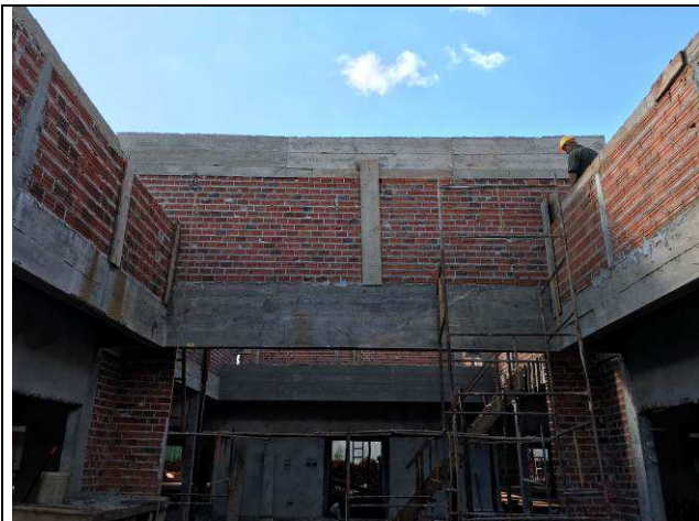
Figura 13C: Paredes de alvenaria.
