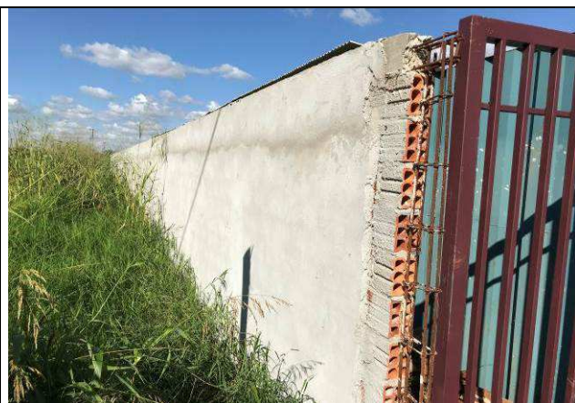
Figura 78C: Muro de fechamento.
