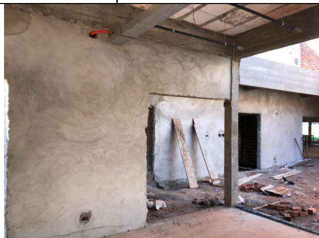
Figura 39C: Revestimento argamassado das paredes internas.
