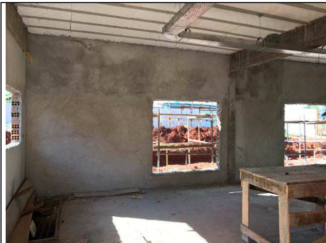
Figura 25C: Revestimento argamassado das paredes internas.
