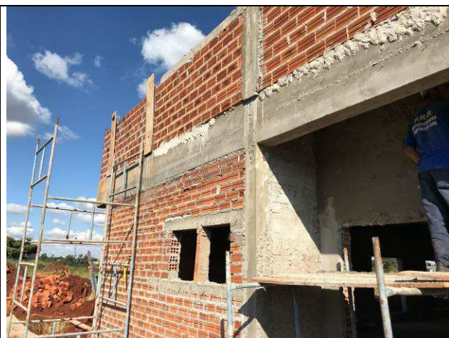
Figura 44C: Entelamento para prevenção de trincas.
