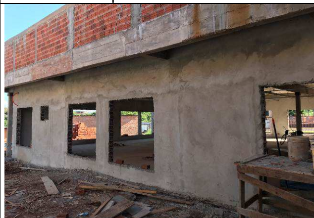
Figura 52C: Revestimento argamassado das paredes externas.
