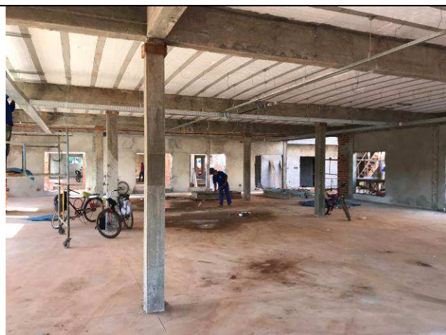
Figura 37C: Revestimento argamassado das paredes internas.
