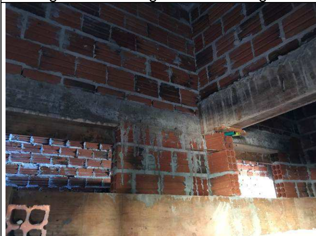
Figura 09C: Vergas e contravergas.
