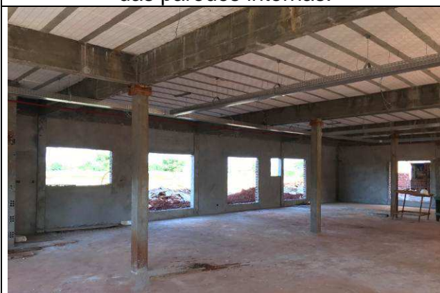
Figura 27C: Revestimento argamassado das paredes internas.
