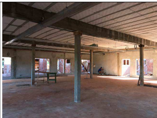
Figura 32C: Revestimento argamassado das paredes internas.
