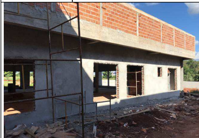
Figura 51C: Revestimento argamassado das paredes externas.
