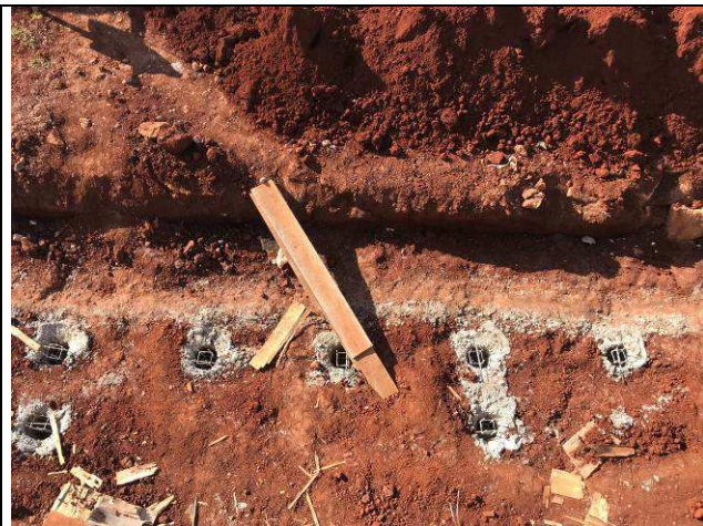
Figura 04C: Estacas - muro de arrimo.
