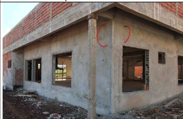
Figura 54C: Revestimento argamassado das paredes externas.
