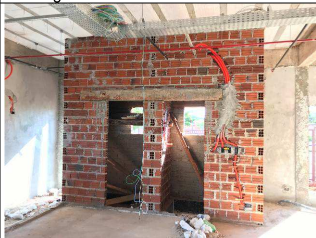
Figura 22C: Paredes de alvenaria.
