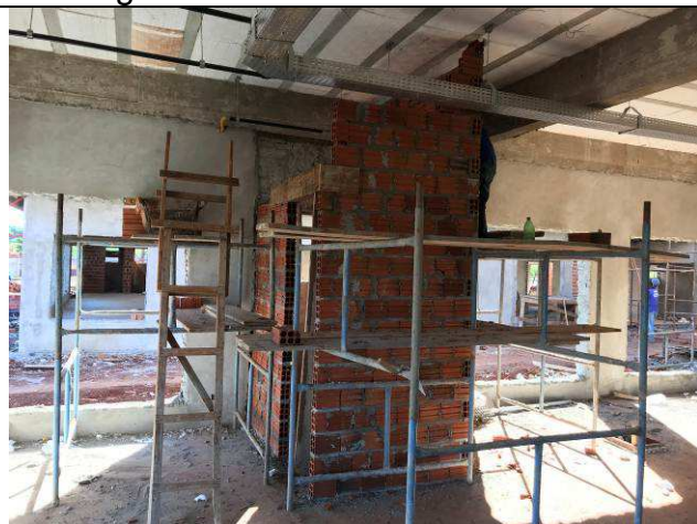
Figura 21C: Paredes de alvenaria.
