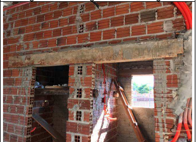
Figura 10C: Vergas e contravergas.
