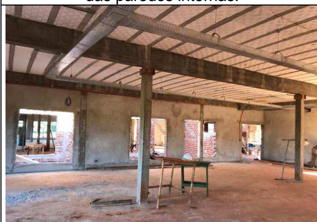
Figura 29C: Revestimento argamassado das paredes internas.
