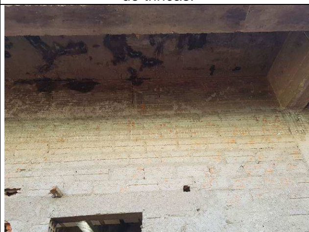
Figura 46C: Entelamento para prevenção de trincas.
