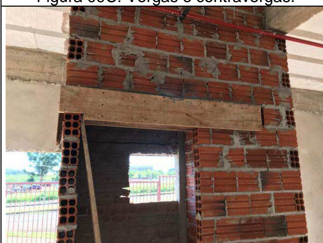
Figura 11C: Vergas e contravergas.
