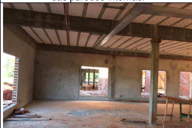
Figura 28C: Revestimento argamassado das paredes internas.
