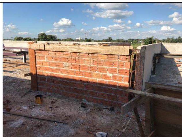
Figura 24C: Paredes de alvenaria.
