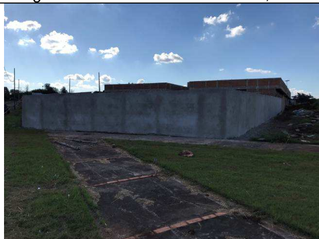
Figura 73C: Muro de fechamento.
