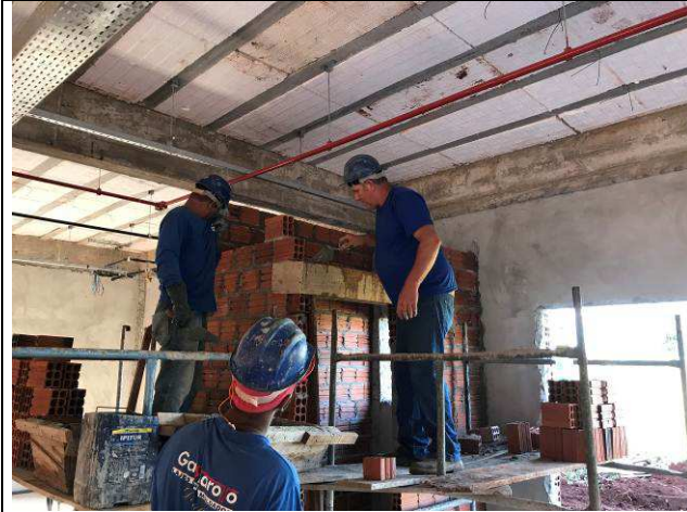
Figura 07C: Vergas e contravergas.
