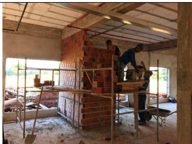
Figura 19C: Paredes de alvenaria.
