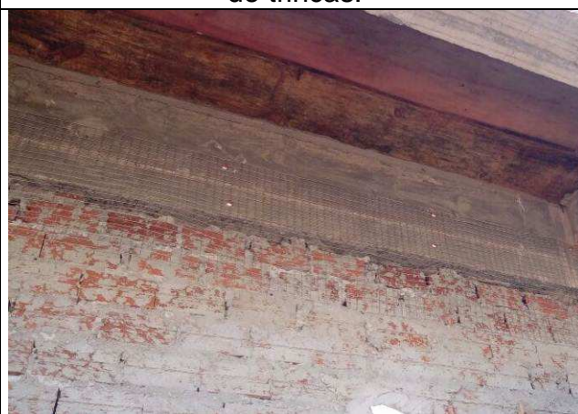
Figura 47C: Entelamento para prevenção de trincas.
