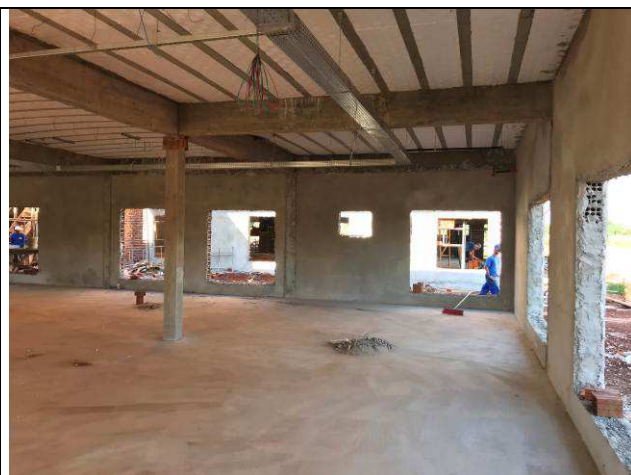
Figura 38C: Revestimento argamassado das paredes internas.
