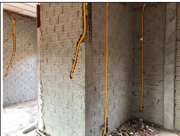
Figura 77C: Chapisco das paredes internas.
