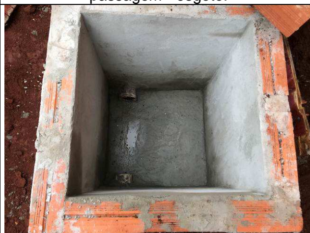
Figura 97C: Tubos de PVC em caixa de passagem - esgoto.
