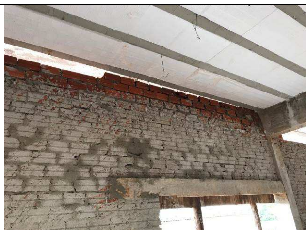
Figura 75C: Chapisco das paredes internas.
