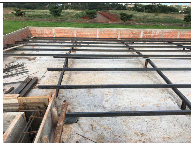
Figura 57C: Estrutura metálica de cobertura.
