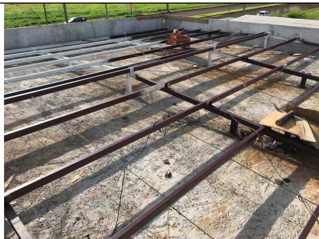
Figura 59C: Estrutura metálica de cobertura.
