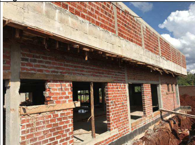
Figura 52C: Paredes de alvenaria externas.
