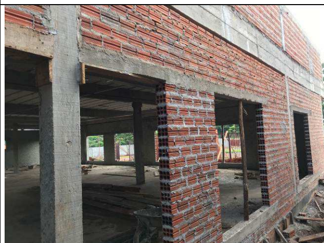
Figura 38C: Vergas e contravergas.
