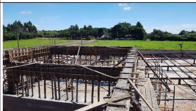
Figura 32C: Concretagem dos pilares e vigas - cobertura barrilete.
