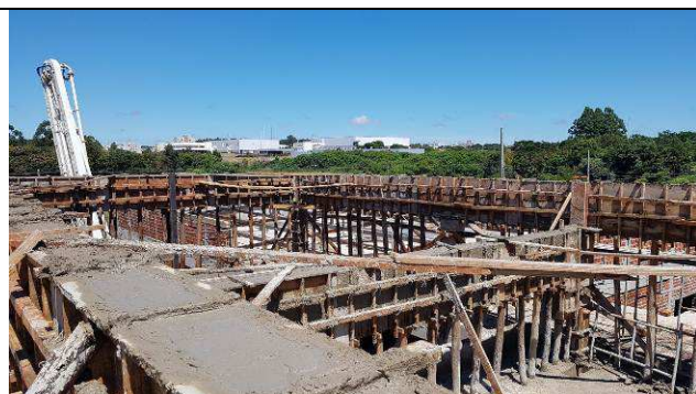
Figura 31C: Concretagem dos pilares e vigas - cobertura barrilete.
