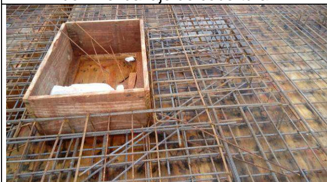
Figura 11C: Montagem das lajes maciças
