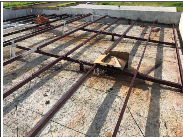
Figura 60C: Estrutura metálica de cobertura.
