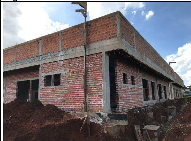
Figura 51C: Paredes de alvenaria externas.
