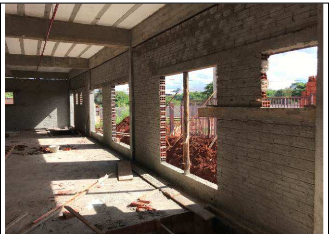
Figura 67C: Chapisco das paredes internas.
