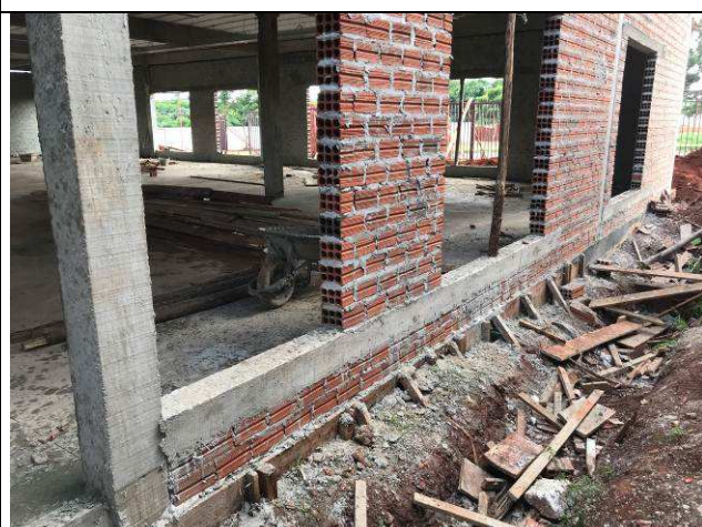
Figura 39C: Vergas e contravergas.
