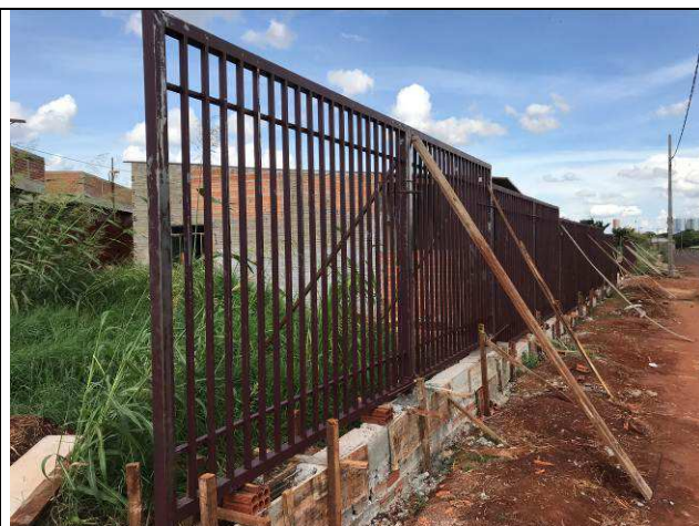
Figura 105C: Gradil de fechamento - Rua Estefano Secchi.
