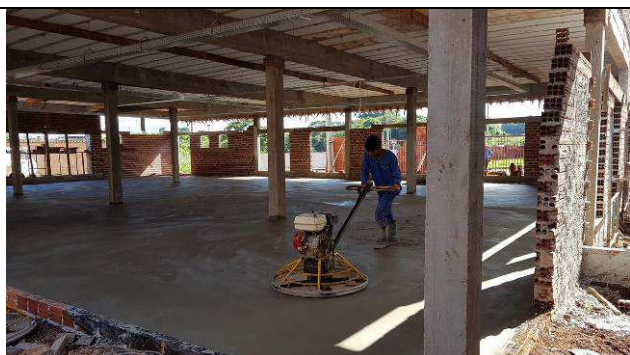
Figura 87C: Concretagem do contrapiso.
