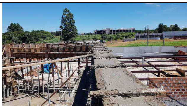
Figura 33C: Concretagem dos pilares e vigas - cobertura barrilete.
