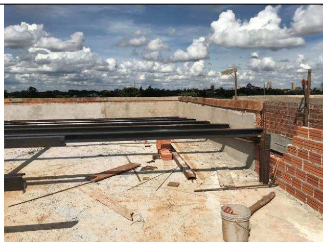
Figura 80C: Chapisco e emboço da face interna das platibandas.
