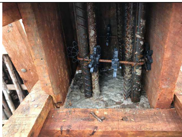
Figura 19C: Formas e armaduras - pilar P45.
