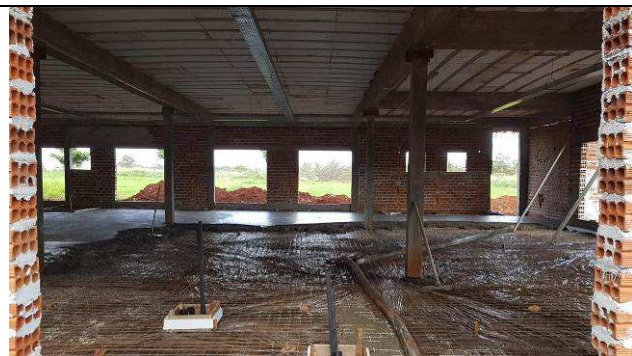
Figura 84C: Concretagem do contrapiso.
