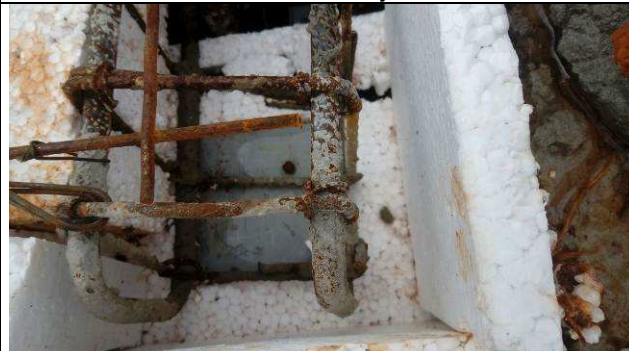
Figura 14C: Montagem das vigas do nível da laje de cobertura - aparelho de apoio.
