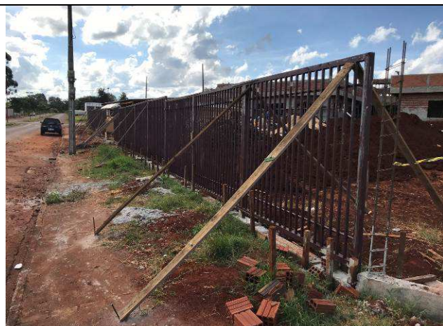
Figura 106C: Gradil de fechamento - Rua Estefano Secchi.
