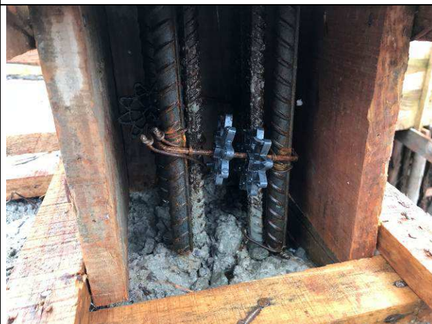
Figura 18C: Formas e armaduras - pilar P44.
