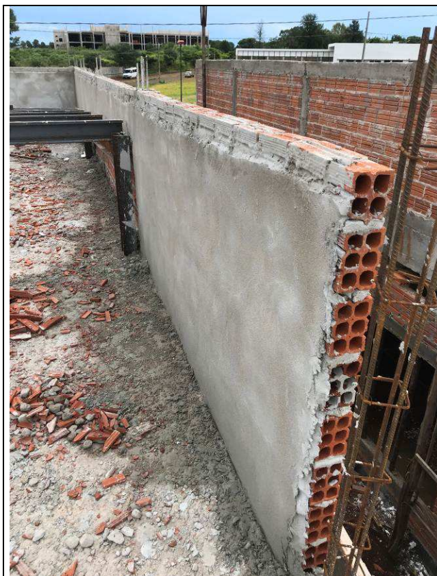
Figura 78C: Chapisco e emboço da face interna das platibandas.
