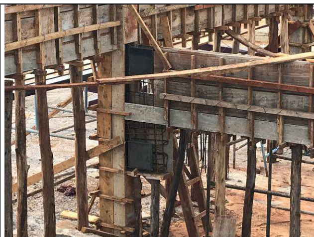
Figura 30C: Instalação dos insertes metálicos na viga V02.
