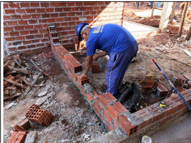
Figura 47C: Paredes de alvenaria externas.
