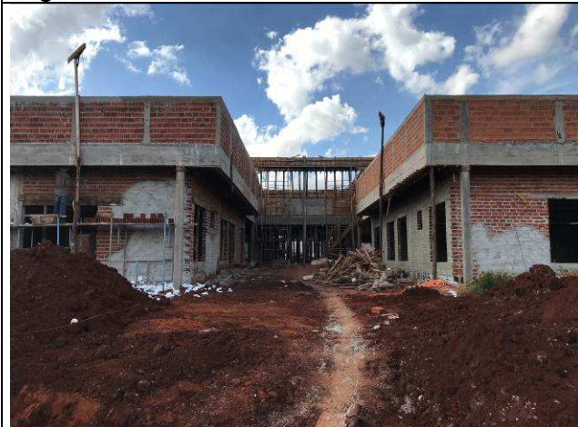
Figura 49C: Paredes de alvenaria externas.
