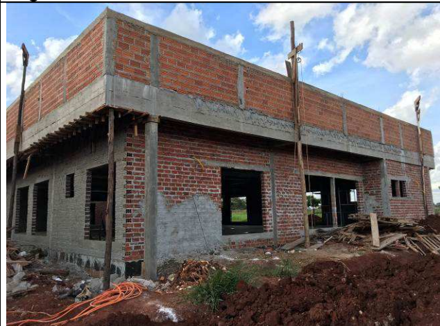
Figura 50C: Paredes de alvenaria externas.
