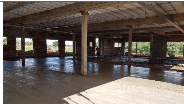
Figura 85C: Concretagem do contrapiso.
