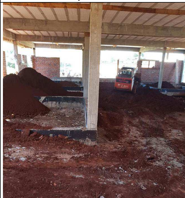
Figura 06C: Reaterro compactado entre baldrame.
