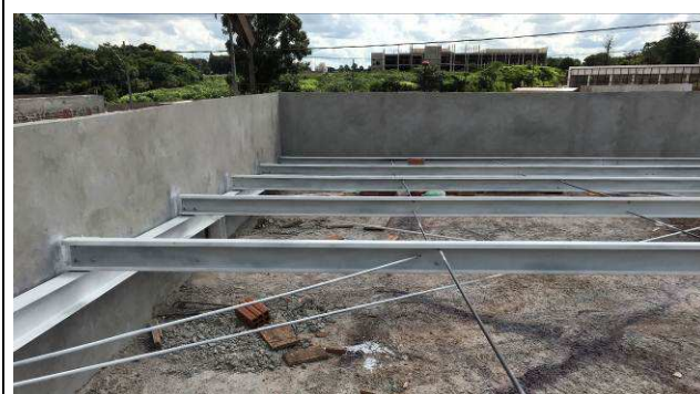
Figura 79C: Chapisco e emboço da face interna das platibandas.
