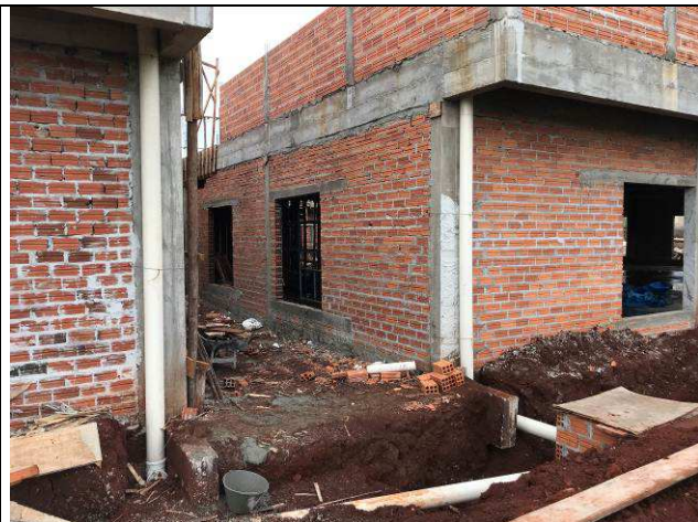
Figura 92C: Prumadas das calhas - águas pluviais.
