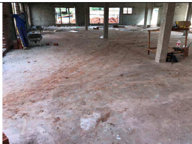
Figura 88C: Contrapiso concretado.
