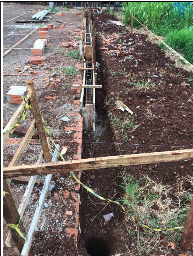
Figura 101C: Estacas e viga baldrame - gradil de fechamento.
