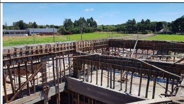
Figura 34C: Concretagem dos pilares e vigas - cobertura barrilete.
