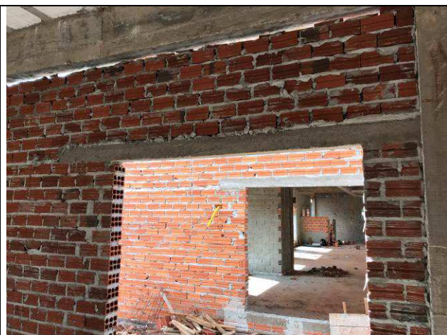
Figura 36C: Vergas e contravergas.
