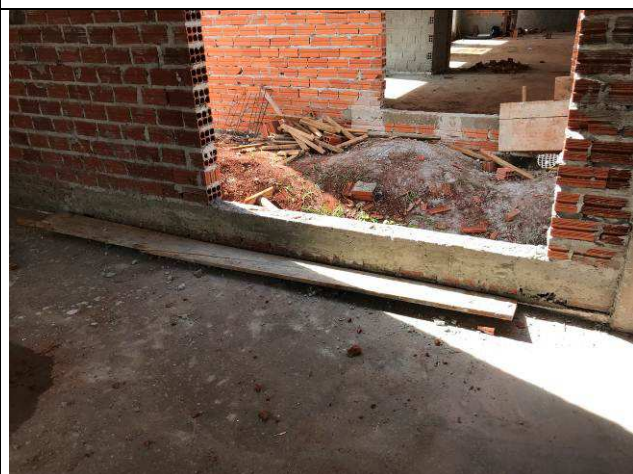
Figura 37C: Vergas e contravergas.
