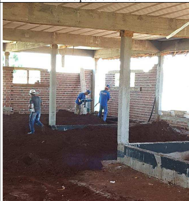
Figura 05C: Reaterro compactado entre baldrame.
