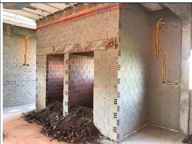
Figura 73C: Chapisco das paredes internas.
