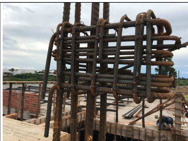
Figura 20C: Formas e armaduras - pilar P45 - console.
