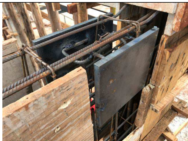
Figura 29C: Instalação dos insertes metálicos na viga V02.
