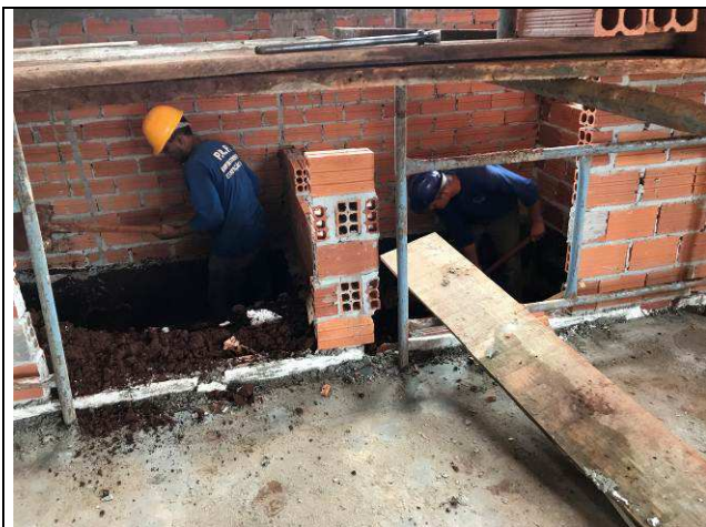
Figura 01C: Escavação de valas para tubulações internas de esgoto.
