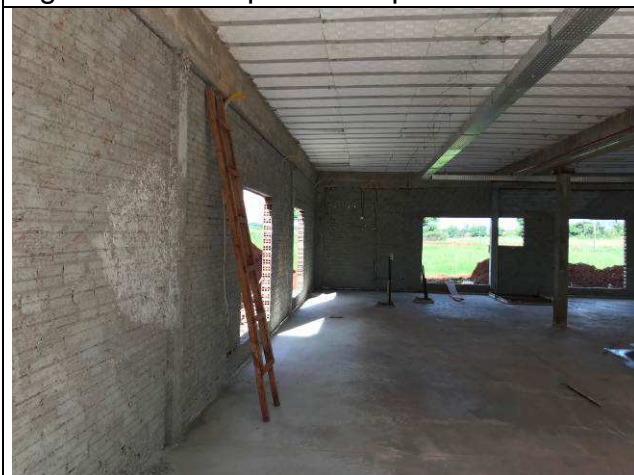
Figura 68C: Chapisco das paredes internas.
