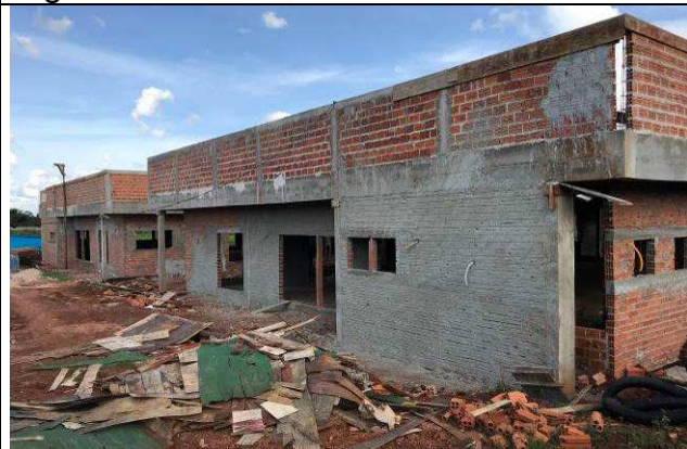
Figura 55C: Paredes de alvenaria externas.
