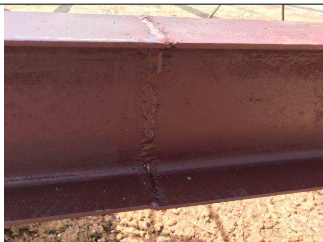
Figura 63C: Estrutura metálica de cobertura - soldas.
