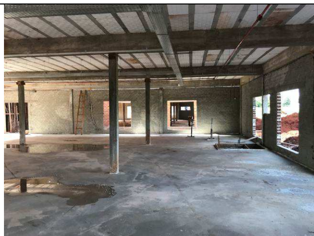
Figura 70C: Chapisco das paredes internas.
