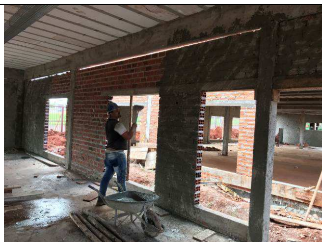
Figura 74C: Chapisco das paredes internas.
