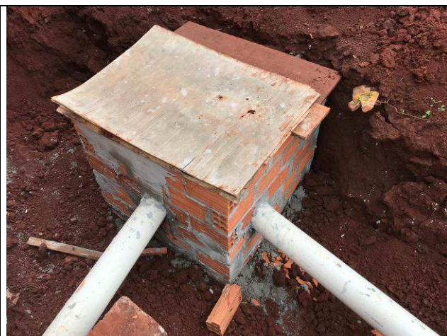
Figura 97C: Tubos de PVC em caixa de passagem - esgoto.
