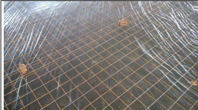
Figura 65C: Lona plástica para impermeabilização do contra piso.
