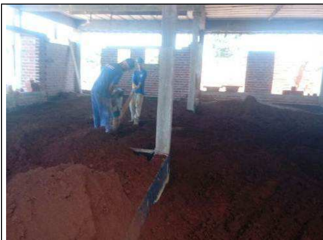
Figura 07C: Reaterro compactado entre baldrames.
