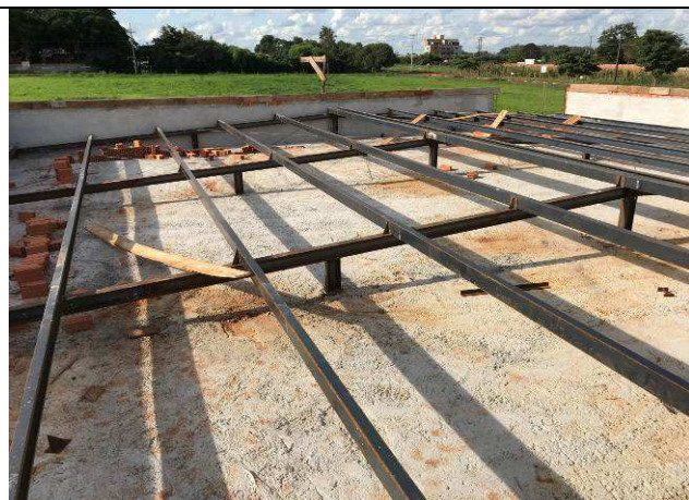
Figura 61C: Estrutura metálica de cobertura.
