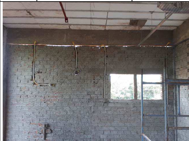
Figura 08E: Eletrodutos e caixas 2x4" - quadrante frontal à direita.
