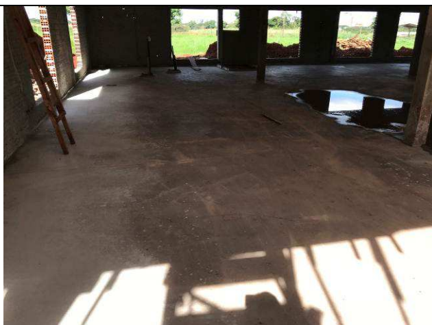
Figura 89C: Contrapiso concretado.
