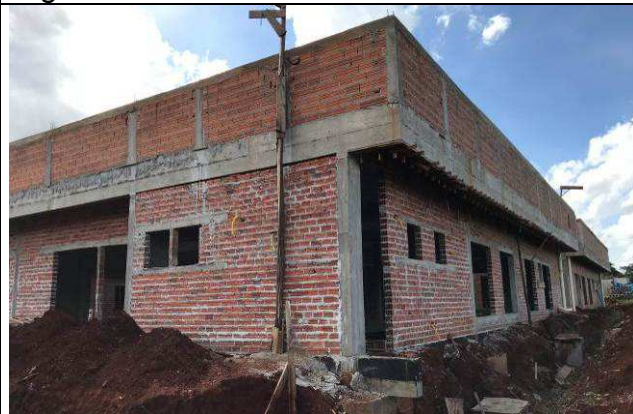
Figura 56: Paredes de alvenaria externas.
