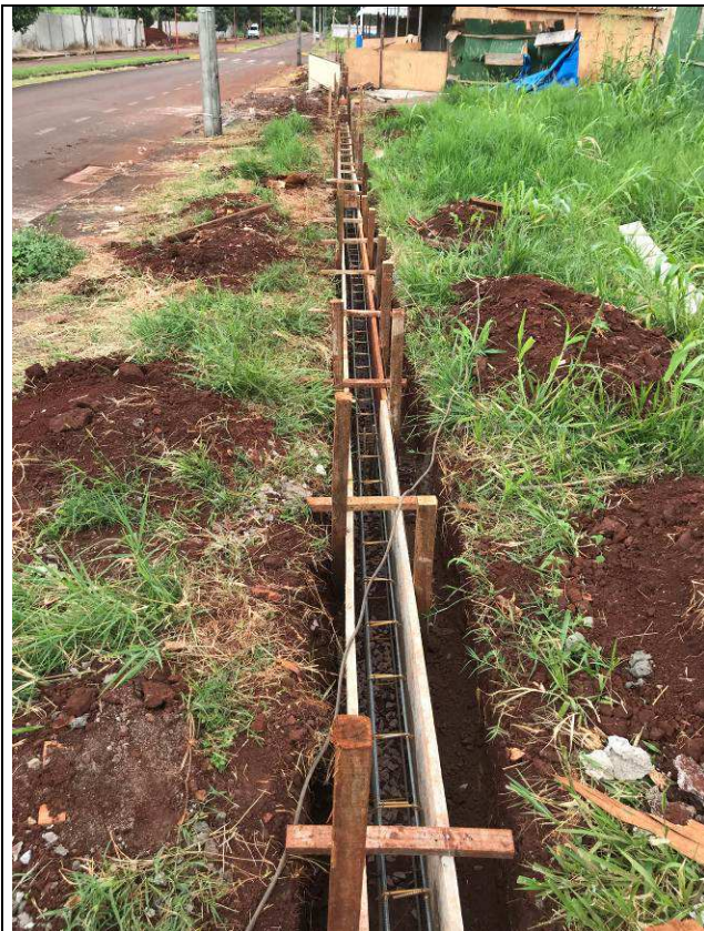
Figura 100C: Viga baldrame - gradil de fechamento.
