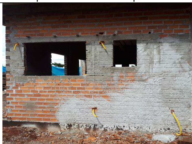
Figura 15E: Eletrodutos e caixas 2x4" - paredes externas.
