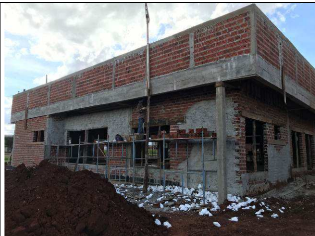
Figura 48C: Paredes de alvenaria externas.
