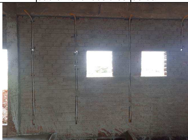
Figura 09E: Eletrodutos e caixas 2x4" - quadrante frontal à direita.
