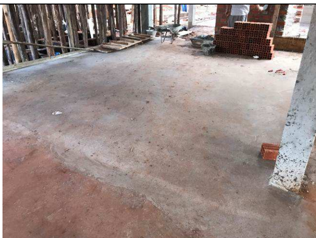
Figura 91C: Contrapiso concretado.
