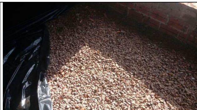
Figura 83C: Camada de brita de 5 cm abaixo da lona de impermeabilização.
