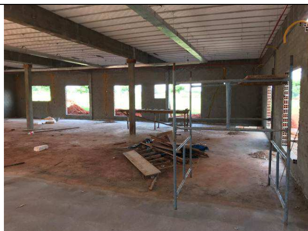
Figura 72C: Chapisco das paredes internas.
