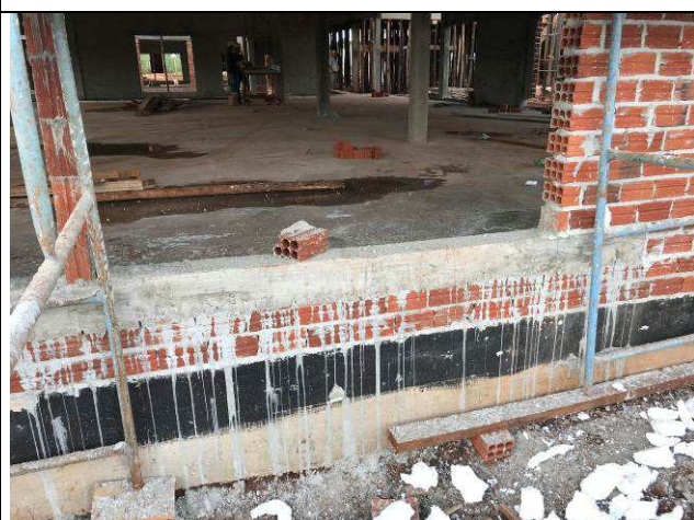
Figura 40C: Vergas e contravergas.
