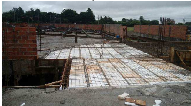
Figura 13C: Montagem das lajes pré-moldadas do nível da laje de cobertura.
