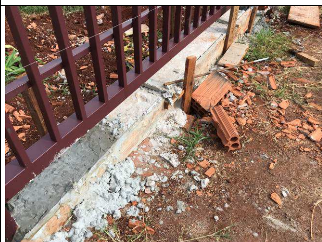
Figura 103C: Viga baldrame e gradil de fechamento.
