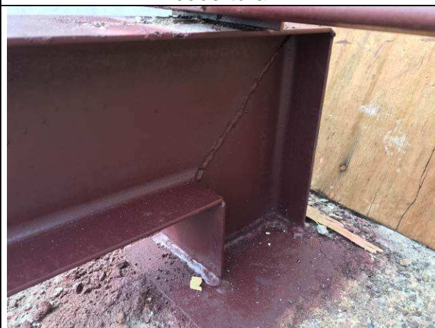
Figura 64C: Estrutura metálica de cobertura - soldas.
