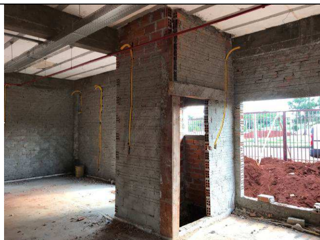
Figura 76C: Chapisco das paredes internas.
