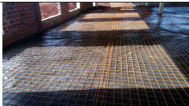
Figura 82C: Lona de impermeabilização e armação em tela soldada.
