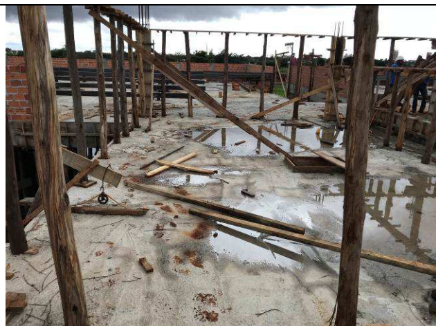
Figura 17C: Vigas e lajes do nível da laje de cobertura concretadas.
