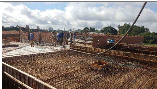
Figura 15C: Concretagem das vigas e lajes do nível da laje de cobertura.
