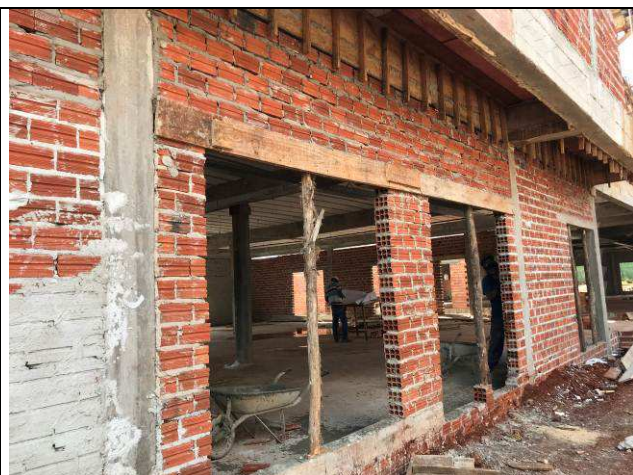
Figura 35C: Vergas e contravergas.
