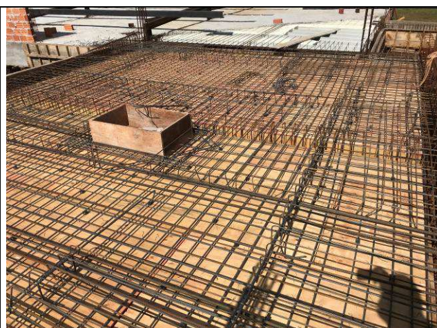
Figura 10C: Montagem das lajes maciças do nível da laje de cobertura.
