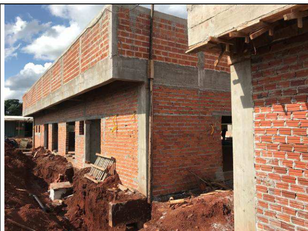
Figura 53C: Paredes de alvenaria externas.
