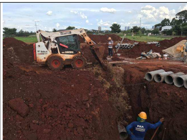
Figura 08C: Reaterro compactado de valas.
