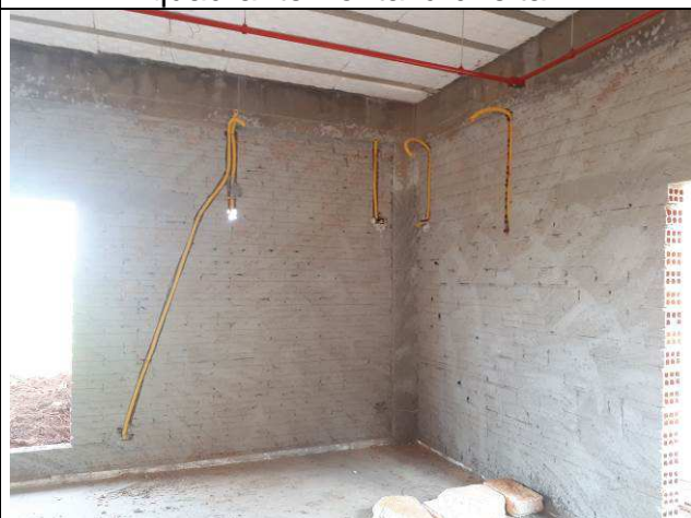
Figura 10E: Eletrodutos e caixas 2x4" - quadrante frontal à direita.
