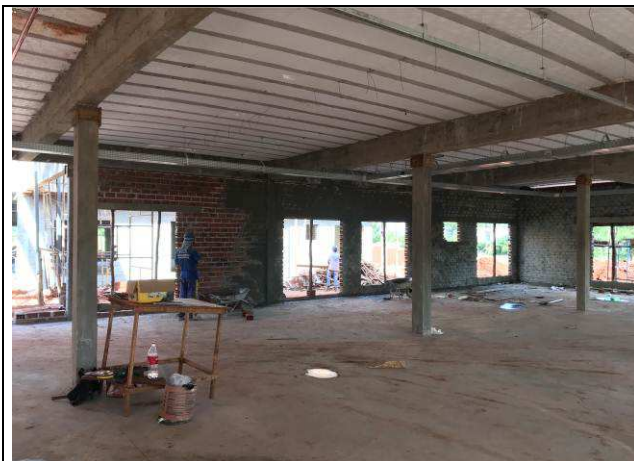
Figura 66C: Chapisco das paredes internas.
