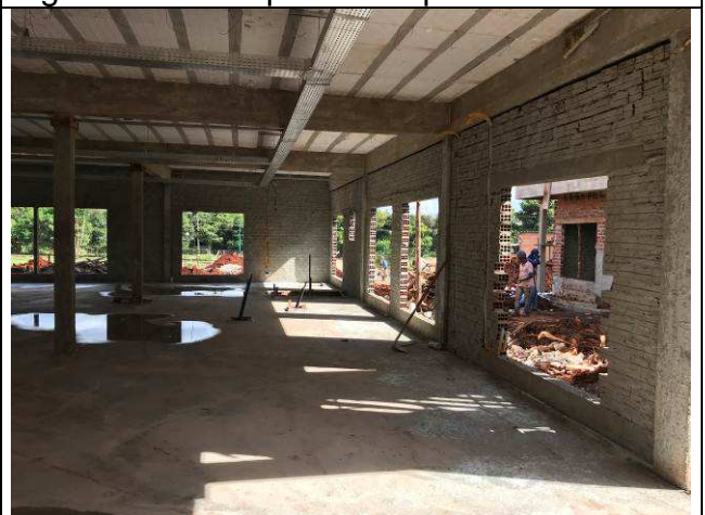
Figura 69C: Chapisco das paredes internas.
