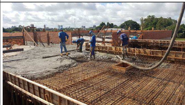
Figura 16C: Concretagem das vigas e lajes do nível da laje de cobertura.
