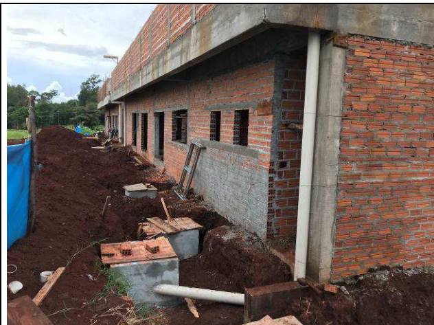
Figura 93C: Prumadas das calhas - águas pluviais.
