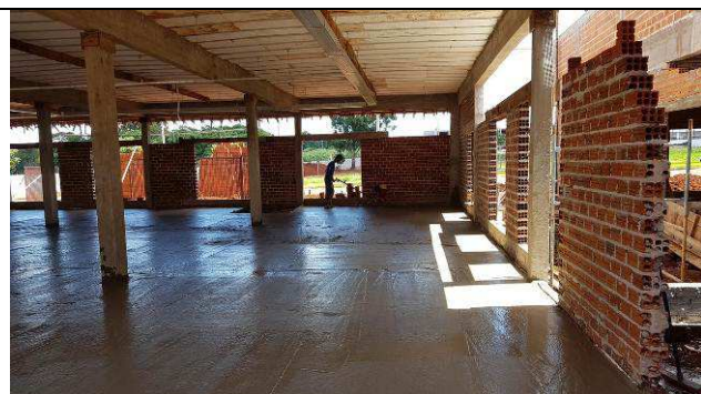
Figura 86C: Concretagem do contrapiso.
