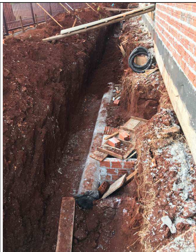
Figura 03C: Escavação de valas para tubulações externas.
