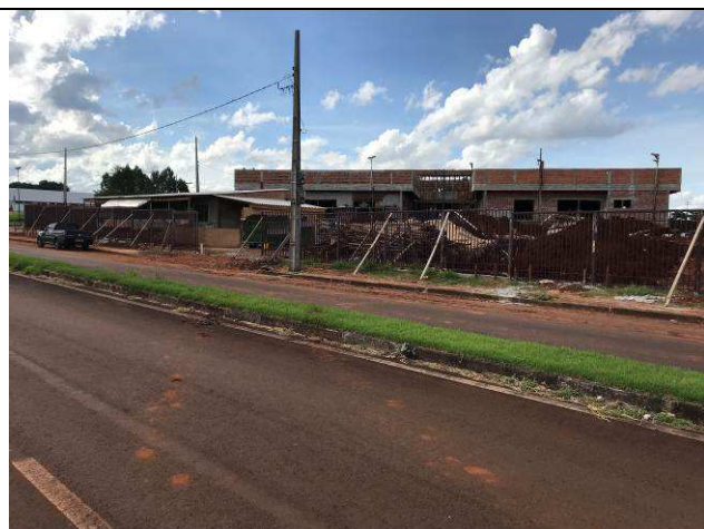
Figura 104C: Gradil de fechamento - Rua Estefano Secchi.
