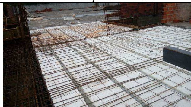
Figura 12C: Montagem das lajes pré-
