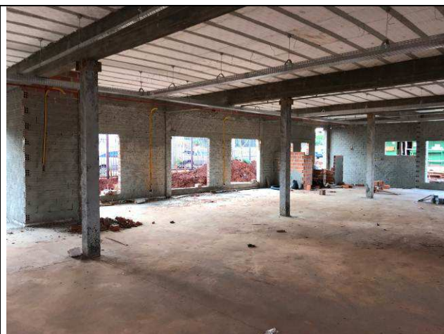
Figura 71C: Chapisco das paredes internas.
