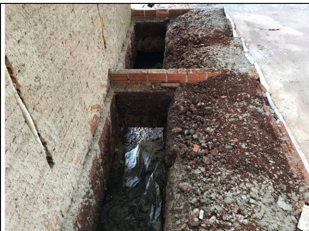
Figura 02C: Escavação de valas para tubulações internas de esgoto.
