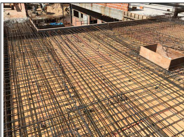
Figura 09C: Montagem das lajes maciças do nível da laje de cobertura.
