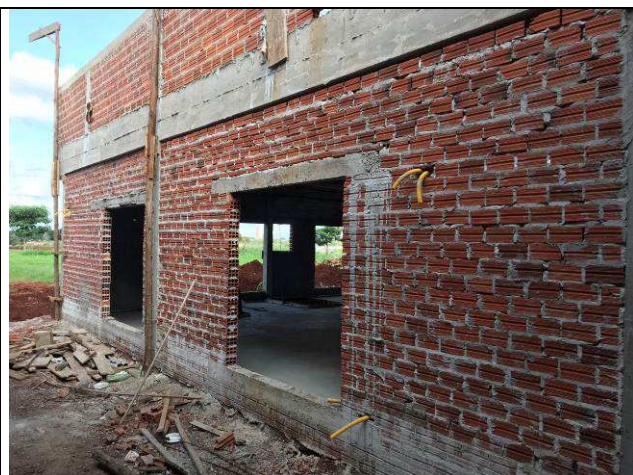
Figura 54C: Paredes de alvenaria externas.
