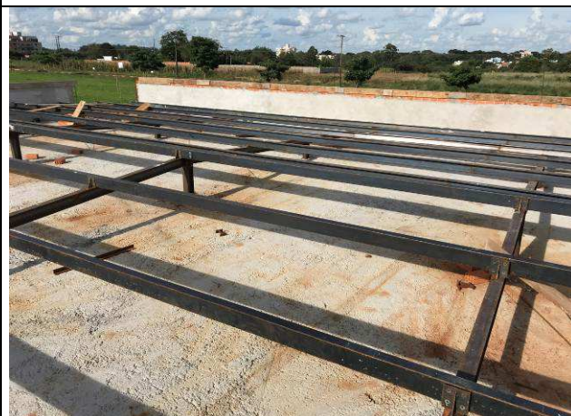
Figura 62C: Estrutura metálica de cobertura.
