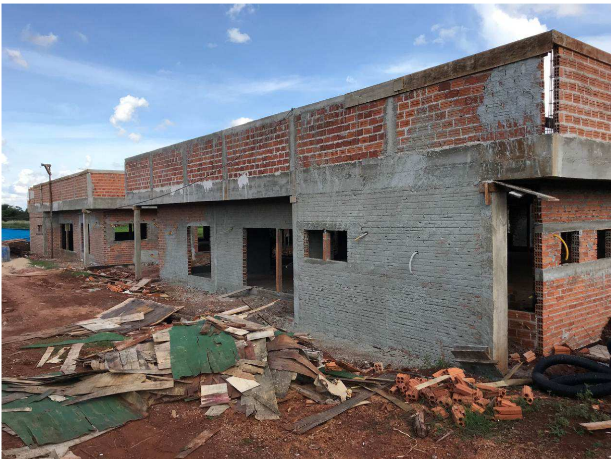
Figura 3 – Fórum - Vista externa.
