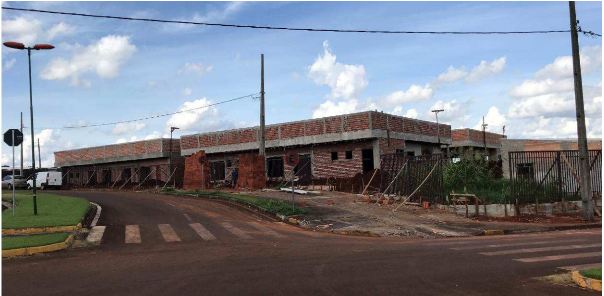
Figura 2 – Fórum - Vista externa.
