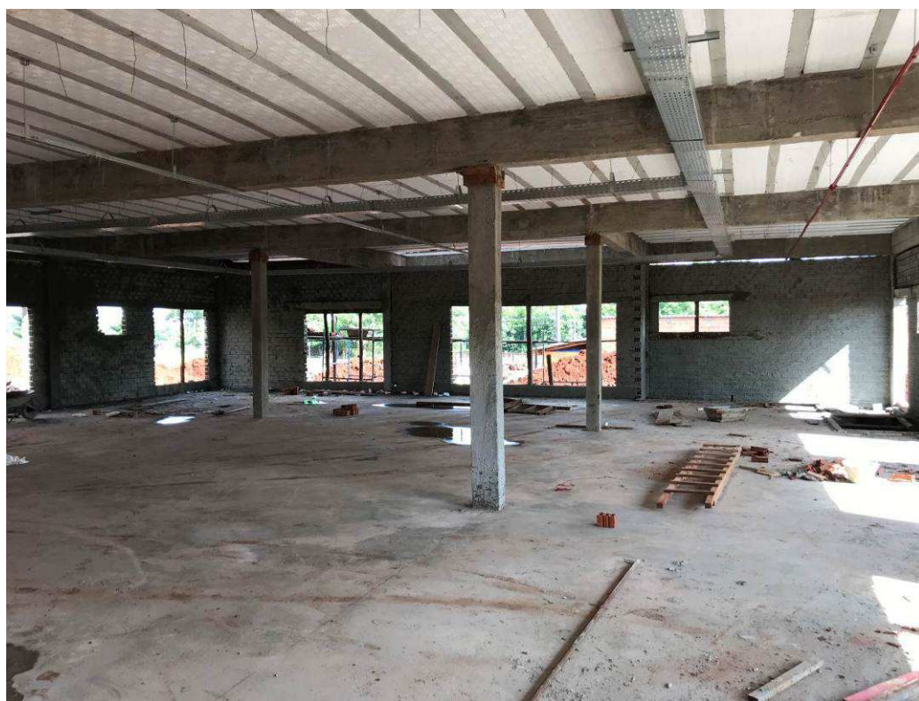
Figura 4 – Fórum - Vista interna.
