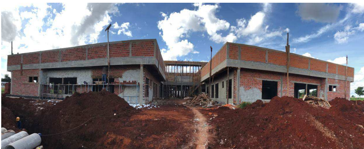
Figura 1 – Fórum - Vista externa.
