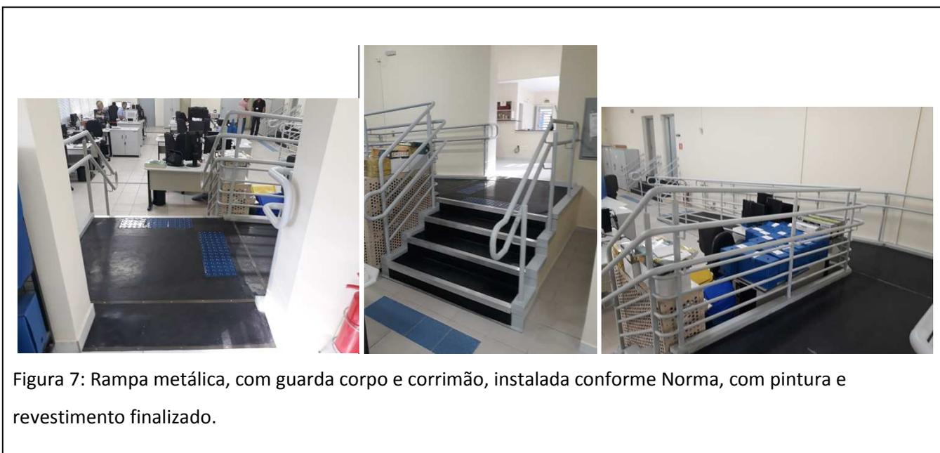
Figura 7: Rampa metálica, com guarda corpo e corrimão, instalada conforme Norma, com pintura e revestimento finalizado.
