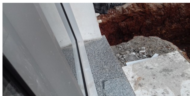
Figura 79C: detalhe do vidro e assentamento da esquadria no vão
