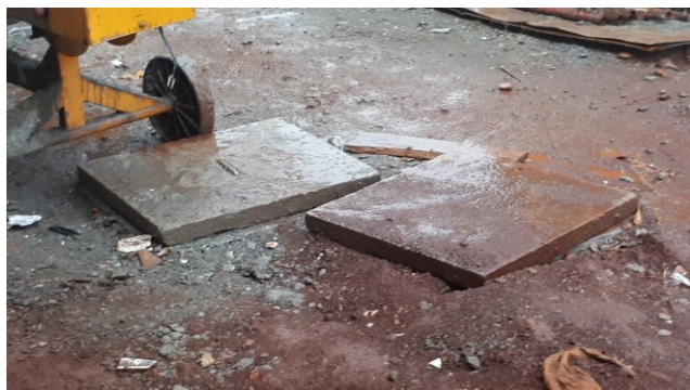
Figura 47E: infraestrutura externa
