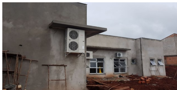
Figura 27C: rebôco das marquizes - lateral direita
