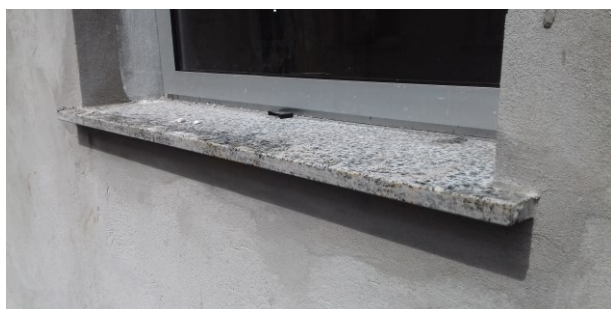
Figura 34C: peitoril em granito, instalado em janela da copa
