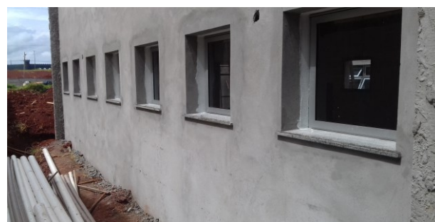
Figura 35C: peitoris em granito, instalados no arquivo
