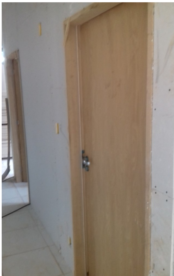
Figura 17C: portas de madeira instaladas em gabinete
