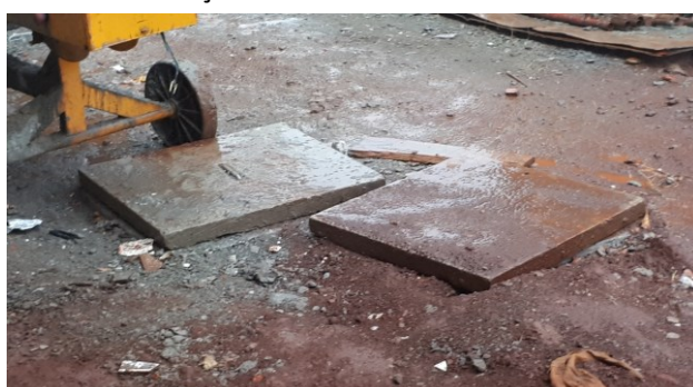
Figura 10E: infraestrutura externa
