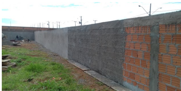
Figura 69C: alvenaria do muro, vista do muro da lateral direita
