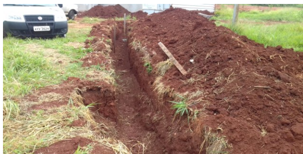
Figura 01C: abertura de vala no local de ligação da rede interna com externa - pluvial
