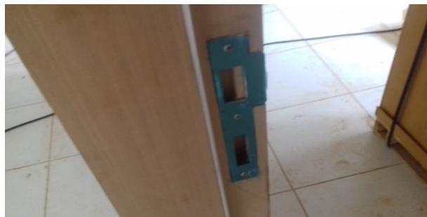
Figura 16C: detalhe de espelho de fechadura, instalado em porta de madeira
