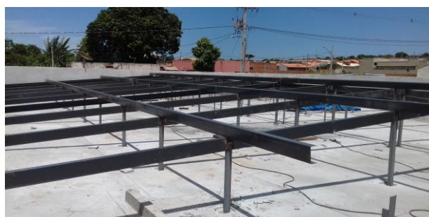
Figura 70C: estrutura metálica da cobertura, com pintura executada
