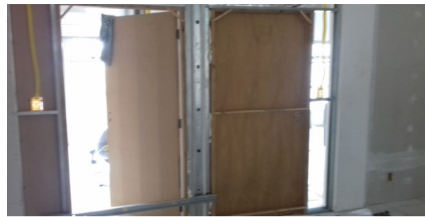
Figura 20C: portas instaladas no hall público
