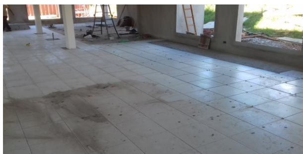
Figura 32C: piso sendo instalado na secretaria
