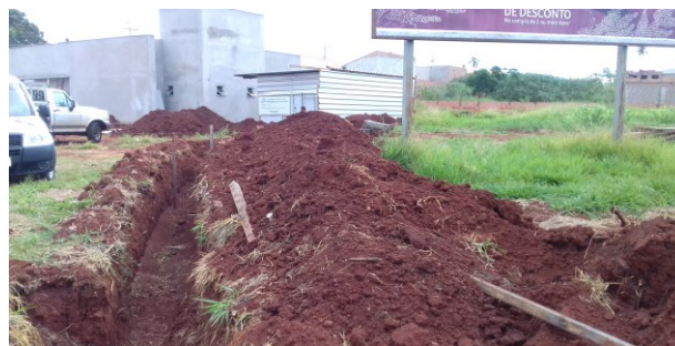
Figura 02C: abertura de vala no local de ligação da rede interna com externa - pluvial
