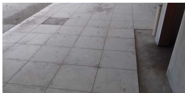
Figura 31C: piso sendo instalado no hall público
