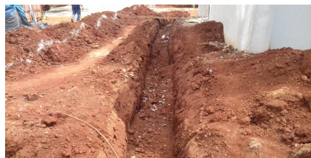
Figura 04C: abertura de vala para execução da rede pluvial - parte frontal
