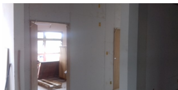
Figura 09C: paredes de gesso acartonado duplo - sala de pré-acordo
