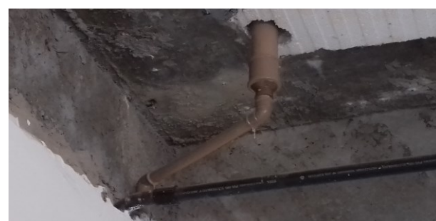
Figura 46C: aplicação de prumada de água fria
