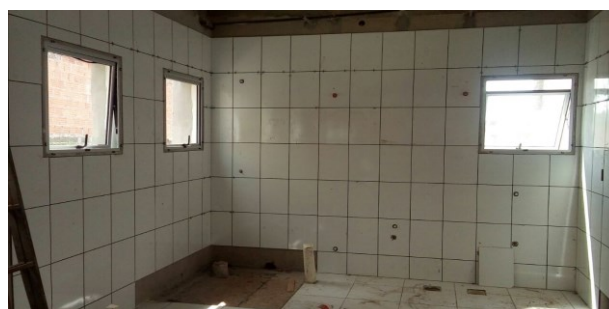
Figura 26C: aplicação de revestimento de parede na área de serviço - arquivo
