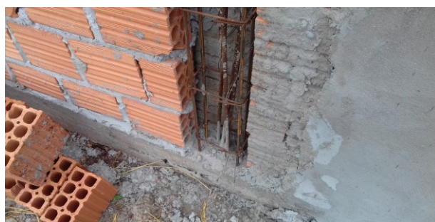
Figura 66C: armaduras de um pilarete de travamento do muro
