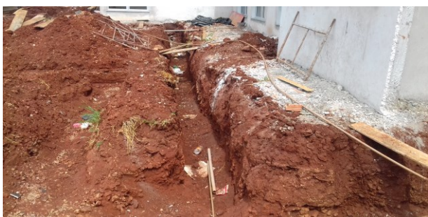
Figura 03C: abertura de vala para execução da rede de esgoto - lateral direita
