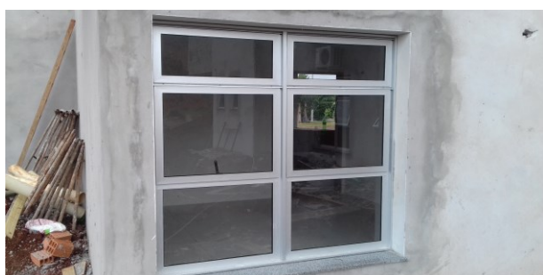
Figura 36C: peitoril em granito instalado em janela de 180cm - gabinete juiz titular
