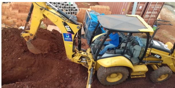
Figura 05C: maquinário realizando abertura de vala para execução de galeria pluvial
