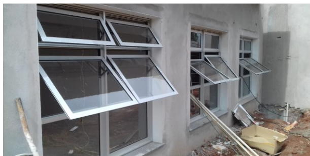
Figura 72C: janelas de 180cm x 180cm instaladas na lateral direita
