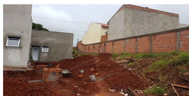
Figura 67C: alvenaria do muro, vista do muro dos fundos
