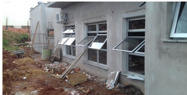
Figura 73C: janelas de 180cm x 180cm instaladas na lateral esquerda
