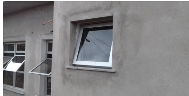
Figura 75C: janela de 60cm x 60cm instalada na copa
