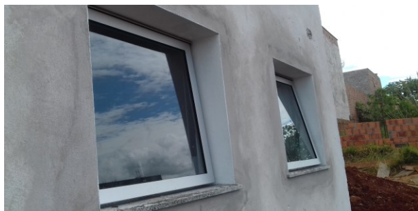
Figura 76C: janelas de 60cm x 60cm instaladas nos sanitários públicos
