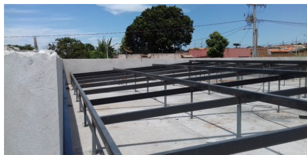
Figura 71C: estrutura metálica da cobertura, com pintura executada
