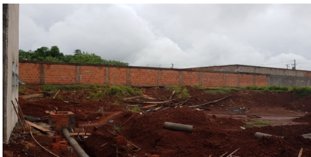
Figura 68C: alvenaria do muro, vista do muro dos fundos
