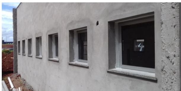
Figura 74C: janelas de 80cm x 80cm instaladas no arquivo
