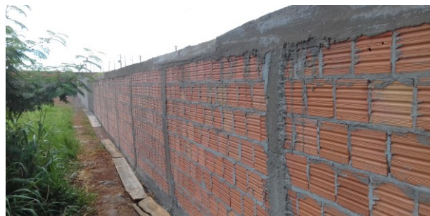
Figura 65C: detalhe de pilaretes de travamento do muro
