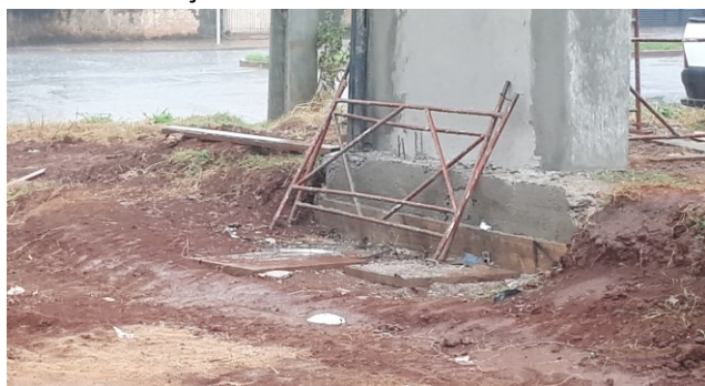
Figura 09E: infraestrutura externa
