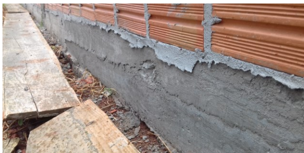
Figura 64C: viga baldrame do muro
