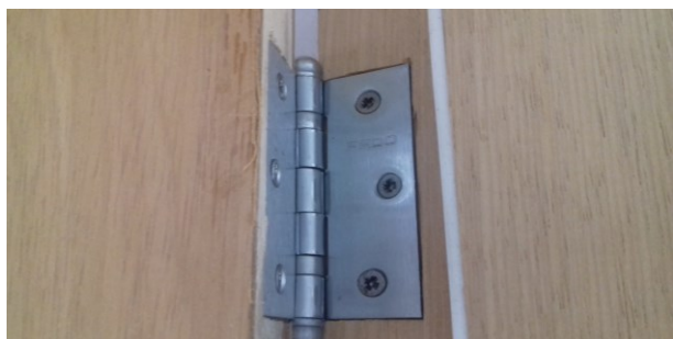
Figura 15C: detalhe de dobradiça instalada em porta de madeira
