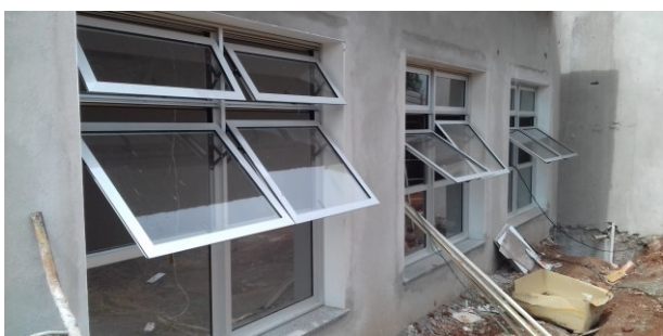
Figura 38C: peitoris em granito instalados em janelas da secretaria
