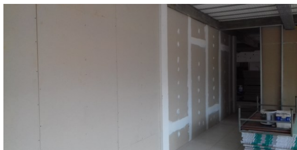
Figura 07C: paredes de gesso acartonado simples - secretaria
