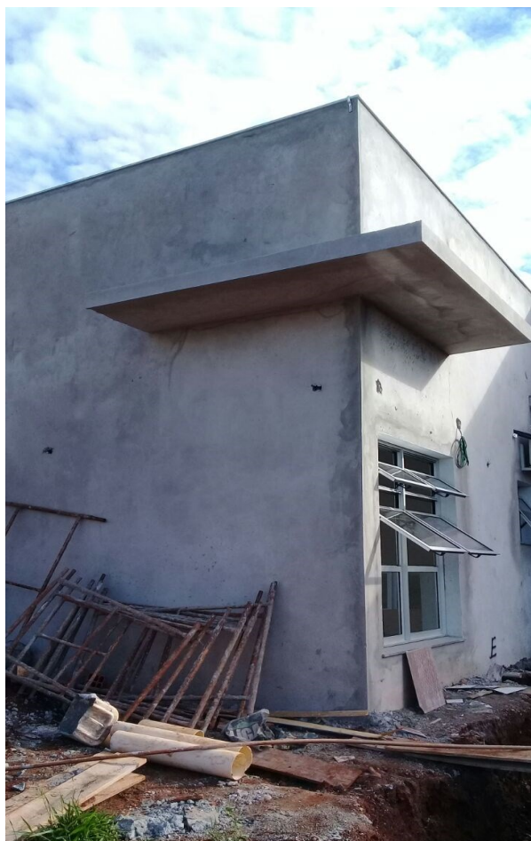
Figura 29C: rebôco das marquizes - detalhe
