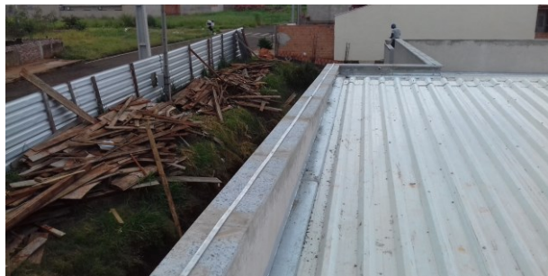
Figura 22C: capeamento da platibanda em granito cinza andorinha
