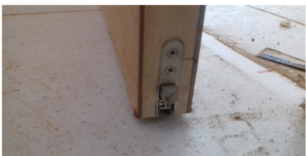
Figura 19C: detalhe do acionador do friso de vedação acústica
