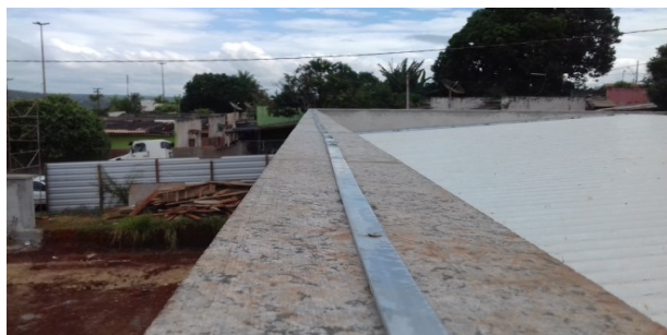
Figura 21C: capeamento da platibanda - detalhe
