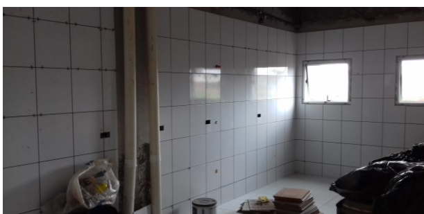
Figura 25C: aplicação de revestimento de parede na copa - prédio principal
