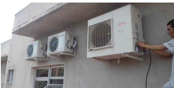
Figura 61C: técnico realizando a instalação de condensador de 30.000 BTU
