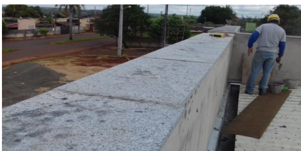
Figura 23C: capeamento da platibanda sendo executado
