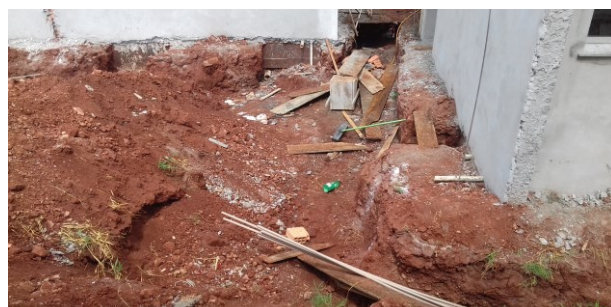
Figura 06C: valas abertas na região do arquivo - rede de esgoto
