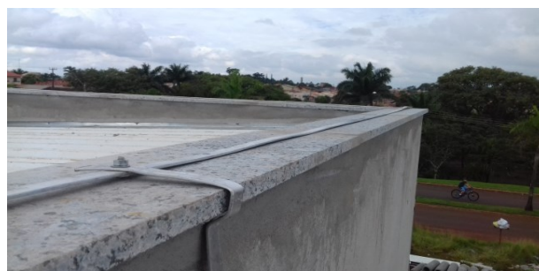
Figura 24C: detalhe do capeamento da platibanda
