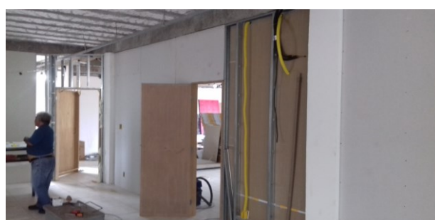
Figura 10C: paredes de gesso acartonado simples - hall público
