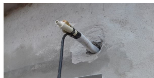
Figura 53C: rede frigorígena aguardando a instalação do condensador
