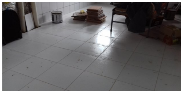
Figura 33C: piso instalado na copa - prédio principal
