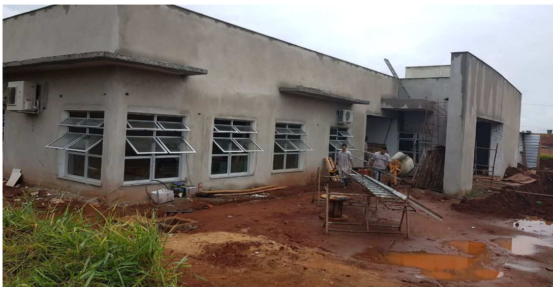
visão geral da obra
