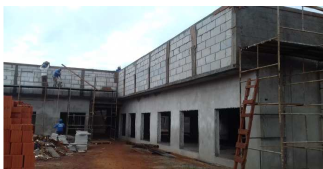
Figura 24C: emboço em parede frontal - secretaria da primeira vara
