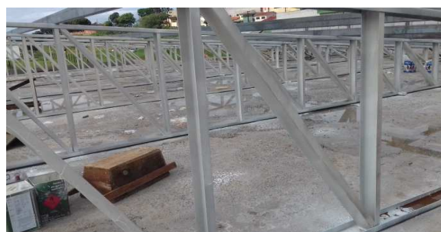
Figura 45C: estrutura metálica de cobertura, com pintura executada - bloco da direita
