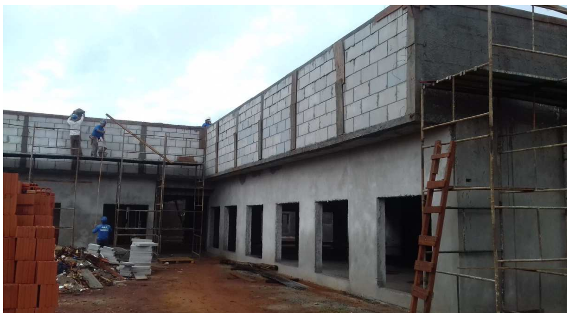
Figura 01C: Visão geral da obra
