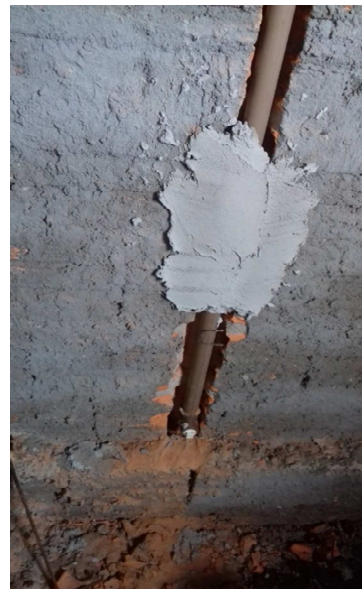
Figura 28C: ponto de água fria em sanitário - 1ª VT
