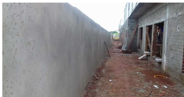
Figura 39C: Emboço/Rebôco do muro dos fundos - face interna
