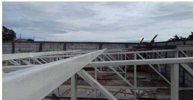
Figura 47C: estrutura metálica de cobertura, executada no vão central - parte frontal
