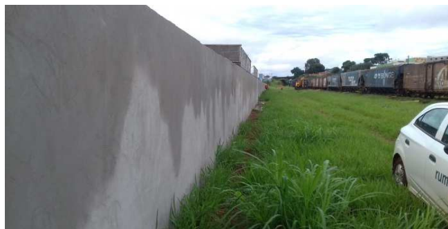
Figura 40C: Reboco da face externa do muro - fundos
