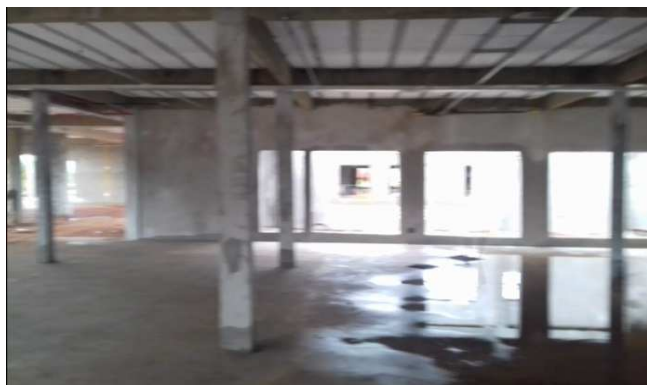
Figura 20C: emboço de parede na secretaria - bloco da direita
