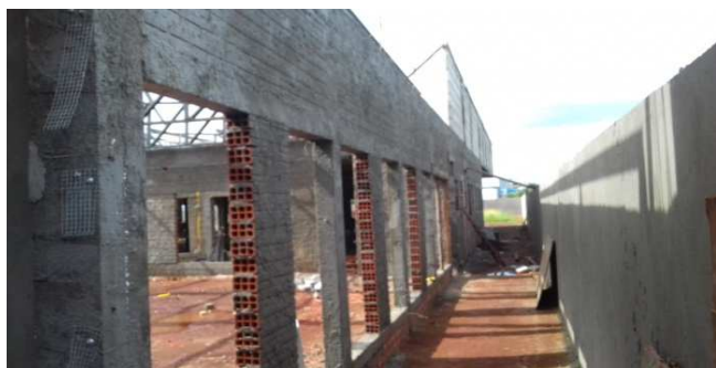
Figura 10C: chapisco na parede dos fundos do bloco central
