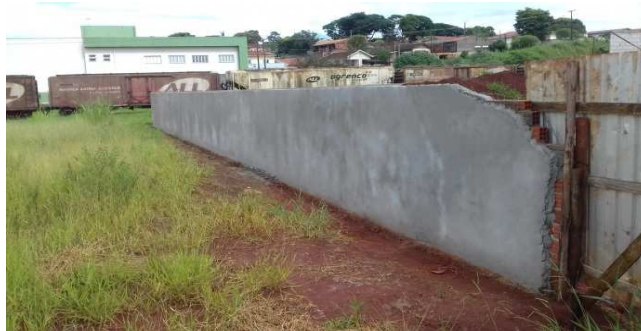
Figura 41C: Rebôco do muro da lateral esquerda (face externa)
