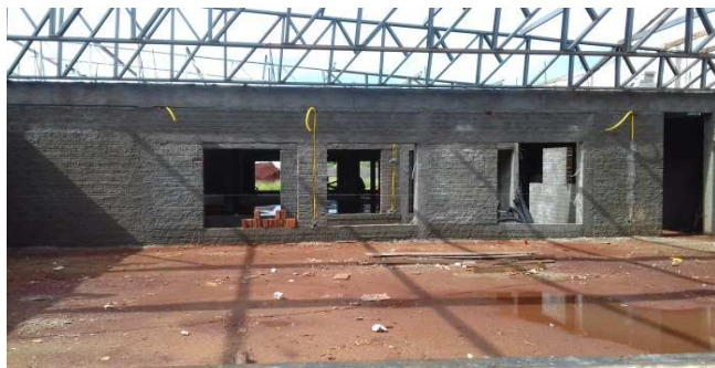
Figura 46C: estrutura metálica de cobertura, executada no vão central - fundos
