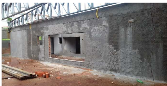
Figura 16C: chapisco de parede do bloco central - lado direito da sala múltiplo uso
