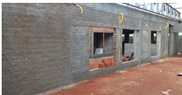
Figura 17C: chapisco de parede do bloco central - lado esquerdo da sala múltiplo uso
