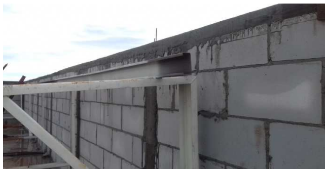
Figura 03C: pilaretes de travamento da platibanda e vigas cinta de amarração - fundos
