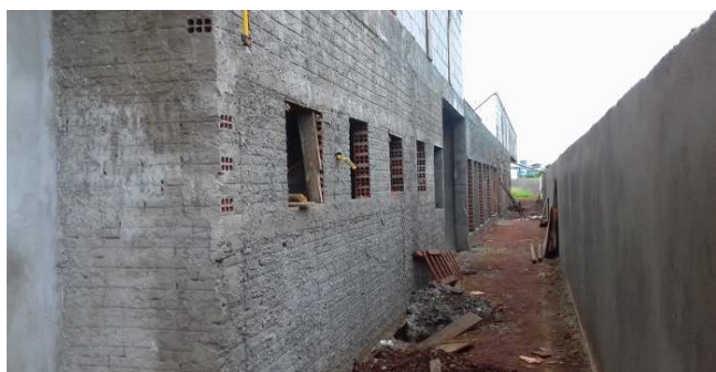
Figura 22C: chapisco na parede dos fundos - sanitários das varas
