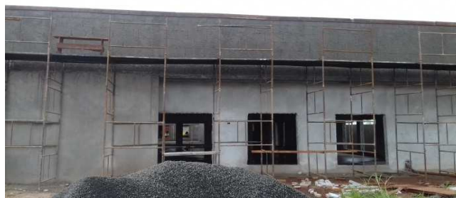
Figura 25C: emboço em parede lateral - bloco da direita
