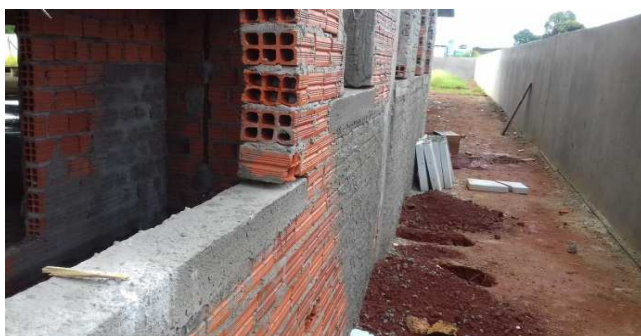
Figura 07C: contravergas em janelas, nos fundos - copa e sanitários do bloco esquerdo
