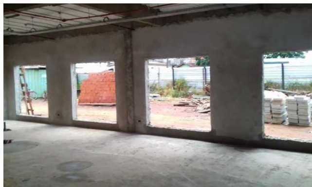
Figura 21C: emboço de parede na secretaria - bloco da esquerda
