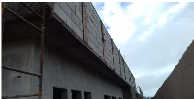
Figura 14C: fechamento da platibanda - bloco da esquerda - fundos
