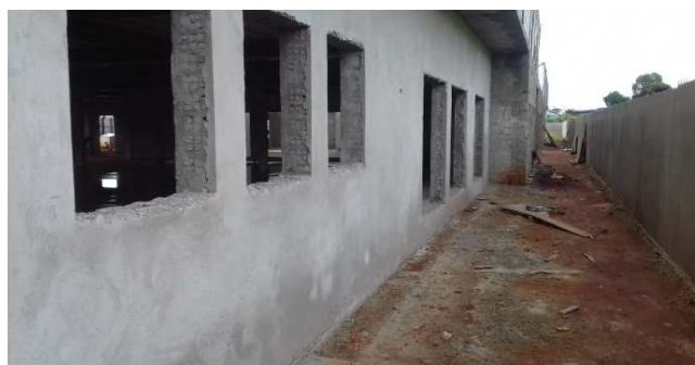
Figura 23C: emboço na parede dos fundos - secretaria da primeira vara
