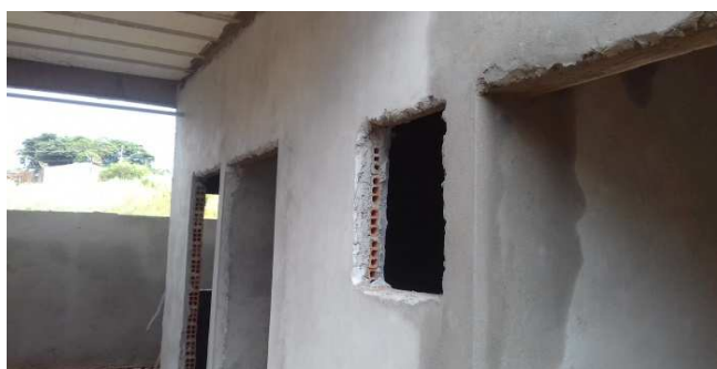
Figura 18C: emboço de parede na região da copa - bloco da direita
