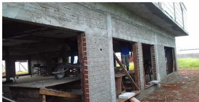
Figura 09C: vergas e contravergas em vãos de janelas, no bloco esquerdo - fundos
