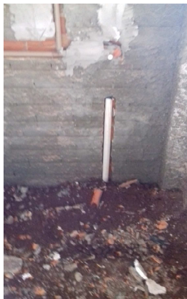
Figura 35C: pontos de esgoto secundário e da água fria, em sanitário da 2ª VT
