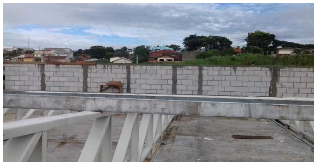
Figura 15C: fechamento da platibanda - bloco da esquerda - fundos
