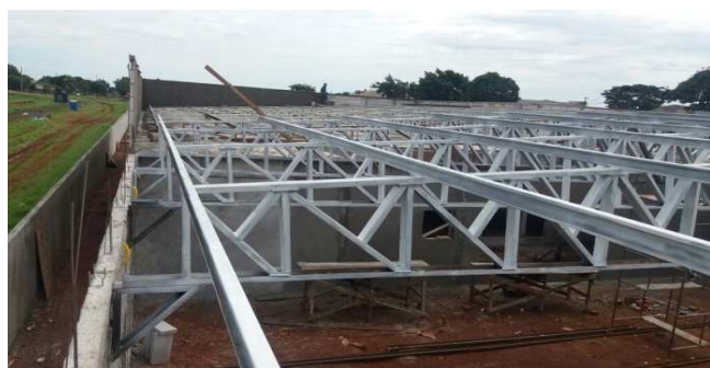
Figura 42C: estrutura metálica de cobertura, com pintura executada - bloco central
