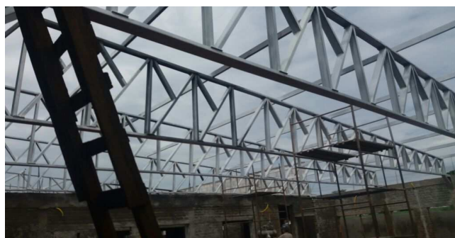
Figura 43C: estrutura metálica de cobertura, com pintura executada - bloco central
