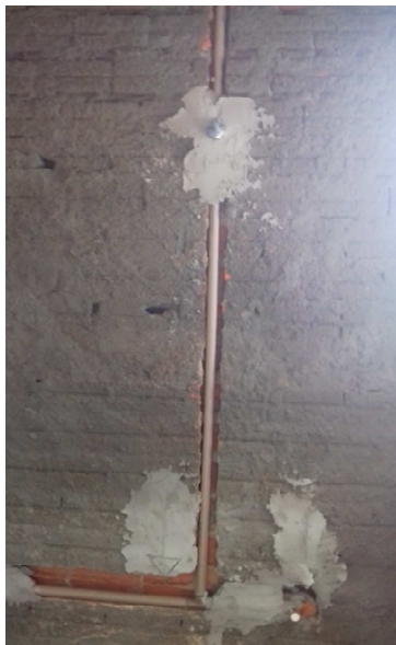
Figura 27C: ponto de água fria em sanitário - 2ª VT
