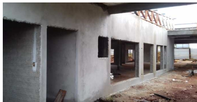
Figura 19C: emboço de parede na região da copa - bloco da direita
