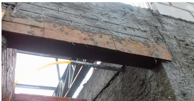
Figura 05C: verga sobre vão de porta - porção frontal do imóvel
