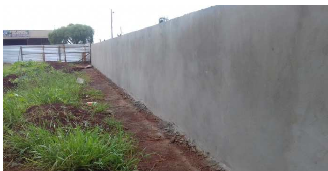
Figura 38C: emboço do interior do muro - divisa esquerda do imóvel
