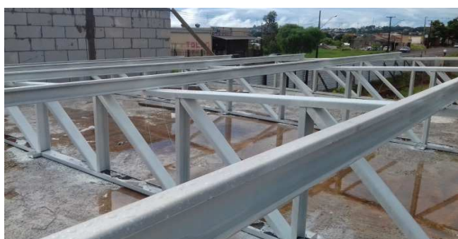
Figura 44C: estrutura metálica de cobertura, com pintura executada - bloco da esquerda
