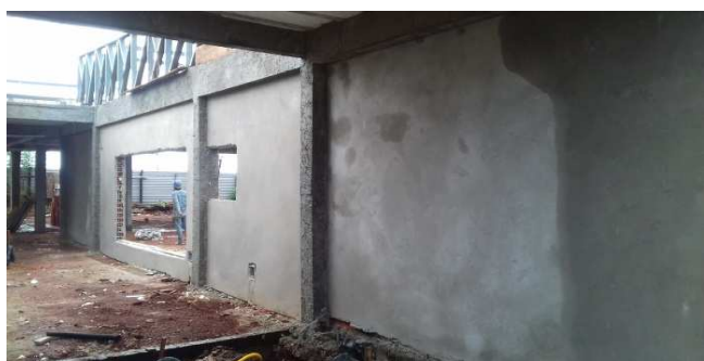
Figura 12C: parede da sala múltiplo uso
