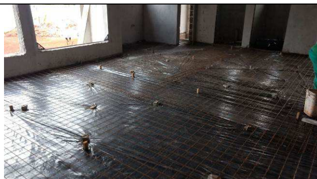
Figura 77C: Aplicação da lona e da tela metálica - contrapiso Fórum.
