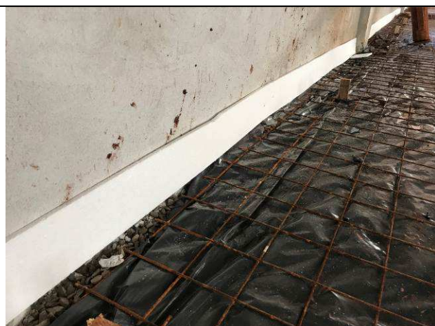
Figura 79C: Isopor de dilatação nas paredes - contrapiso Fórum.
