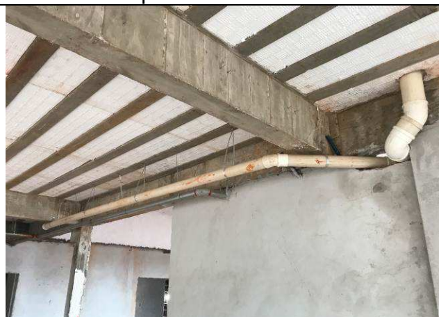
Figura 111C: Rede de drenagem e águas pluviais - Fórum.
