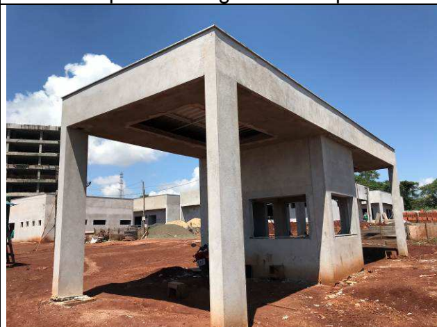
Figura 24C: Capeamento da platibanda com peitoris de granito - Guarita.
