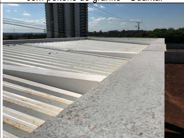
Figura 26C: Capeamento da platibanda com peitoris de granito - Guarita.
