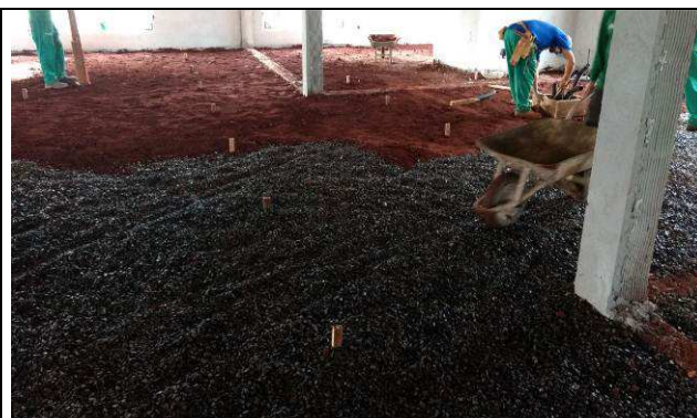
Figura 68C: Camada de brita - contrapiso Fórum.
