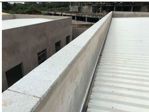
Figura 15C: Capeamento da platibanda com peitoris de granito - Fórum.
