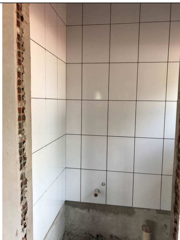
Figura 47C: Revestimento cerâmico - assentamento dos azulejos.
