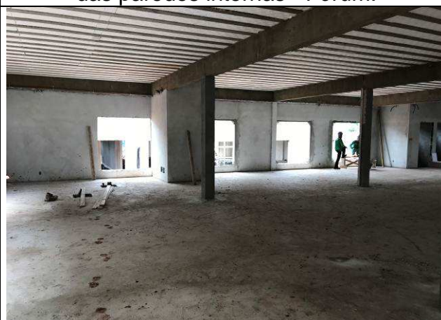
Figura 44C: Revestimento argamassado das paredes internas - Fórum.
