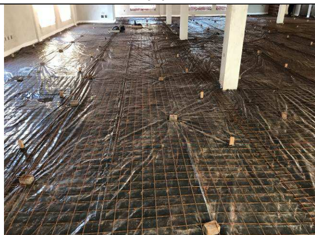
Figura 73C: Aplicação da lona e da tela metálica - contrapiso Fórum.
