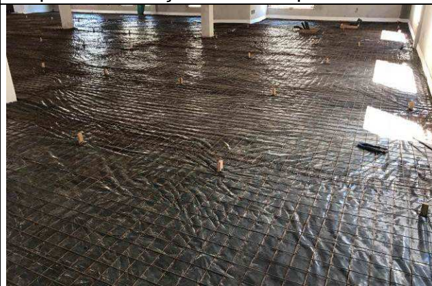
Figura 30C: Lona plástica para impermeabilização do contrapiso - Fórum.
