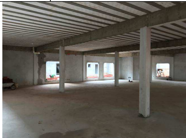
Figura 35C: Revestimento argamassado das paredes internas - Fórum.
