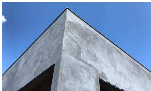
Figura 11C: Capeamento da platibanda com peitoris de granito - Fórum.
