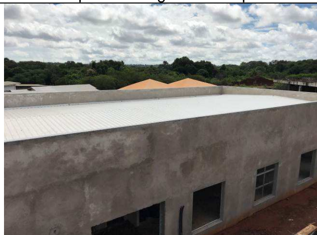
Figura 23C: Capeamento da platibanda com peitoris de granito - Arquivo.
