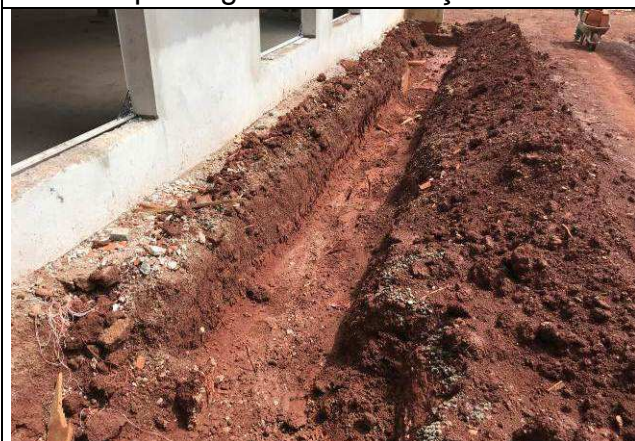
Figura 05C: Abertura de valas para passagem das tubulações.
