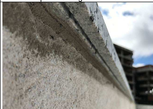
Figura 14C: Capeamento da platibanda com peitoris de granito - Fórum.
