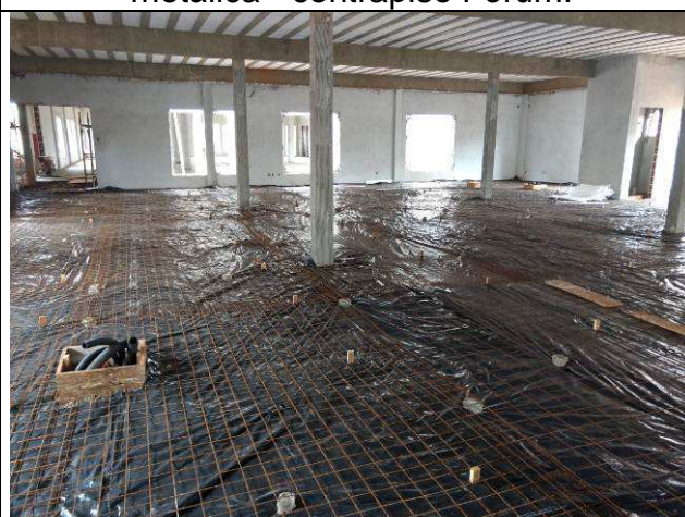
Figura 76C: Aplicação da lona e da tela metálica - contrapiso Fórum.
