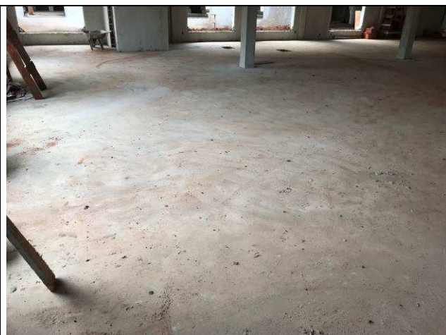
Figura 81C: Contrapiso concretado - Fórum.
