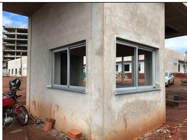
Figura 09C: Janelas de alumínio, tipo de correr, instaladas na guarita.
