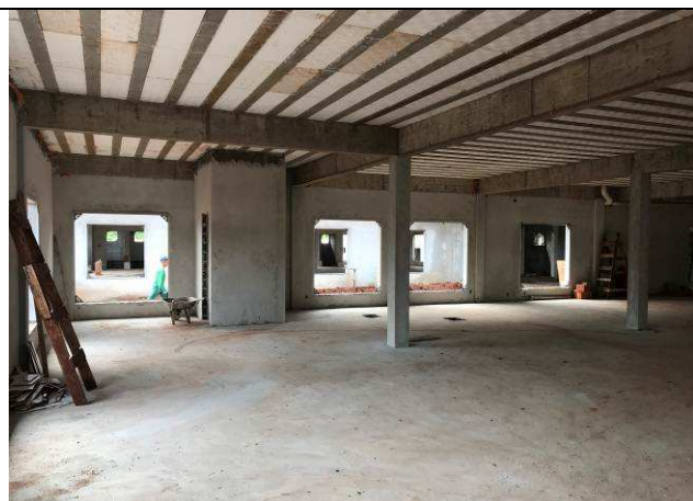
Figura 33C: Revestimento argamassado das paredes internas - Fórum.
