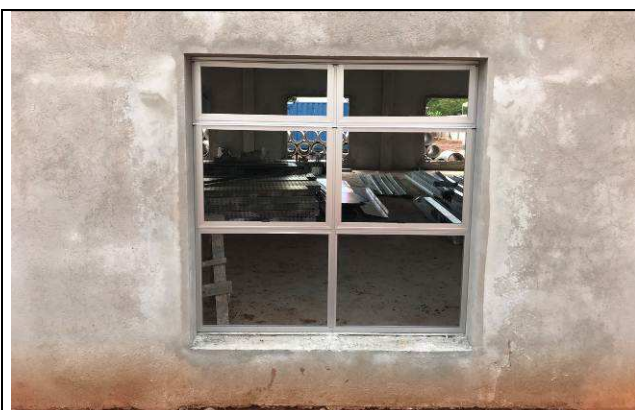
Figura 07C: Janela de alumínio, tipo máximo ar, instalada no arquivo.
