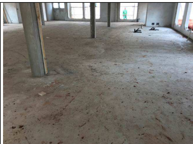
Figura 88C: Contrapiso concretado - Fórum.
