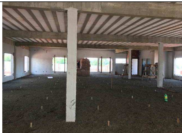
Figura 71C: Camada de brita - contrapiso Fórum.
