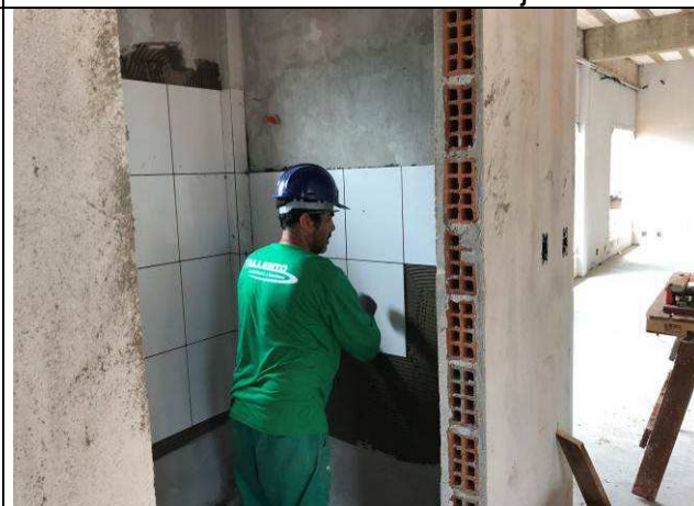
Figura 56C: Revestimento cerâmico - assentamento dos azulejos.
