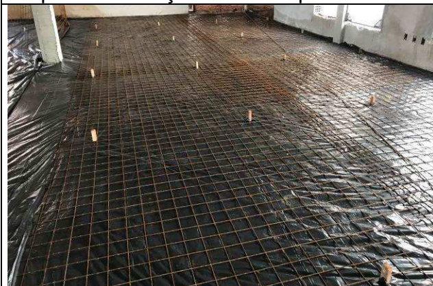
Figura 29C: Lona plástica para impermeabilização do contrapiso - Fórum.
