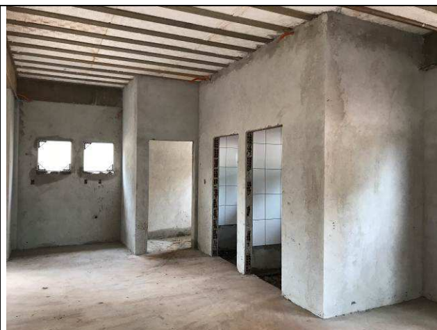
Figura 40C: Revestimento argamassado das paredes internas - Fórum.
