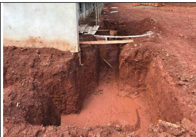
Figura 04C: Abertura de valas para passagem das tubulações.
