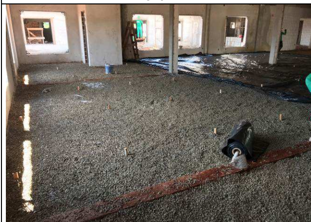
Figura 69C: Camada de brita - contrapiso Fórum.
