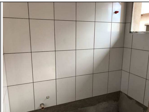
Figura 50C: Revestimento cerâmico - assentamento dos azulejos.
