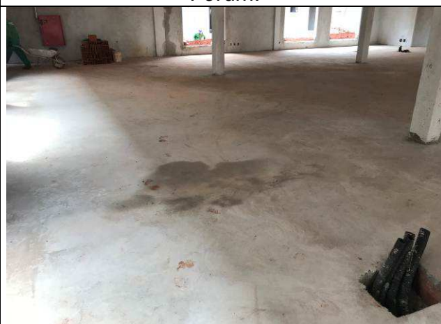
Figura 83C: Contrapiso concretado - Fórum.
