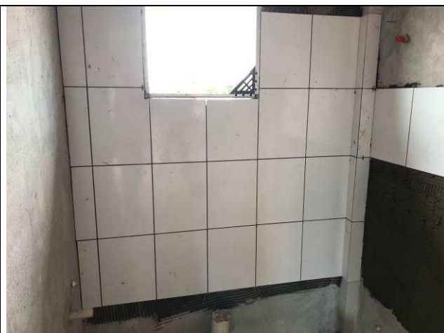
Figura 53C: Revestimento cerâmico - assentamento dos azulejos.
