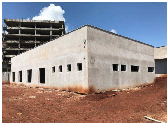
Figura 21C: Capeamento da platibanda com peitoris de granito - Arquivo.
