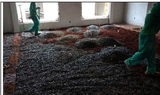
Figura 67C: Camada de brita - contrapiso Fórum.
