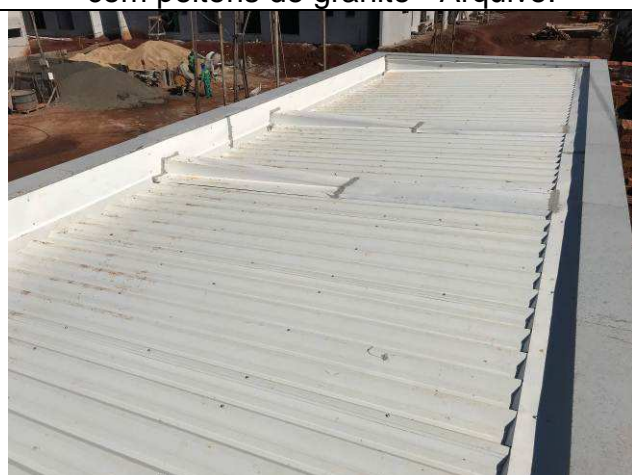
Figura 25C: Capeamento da platibanda com peitoris de granito - Guarita.
