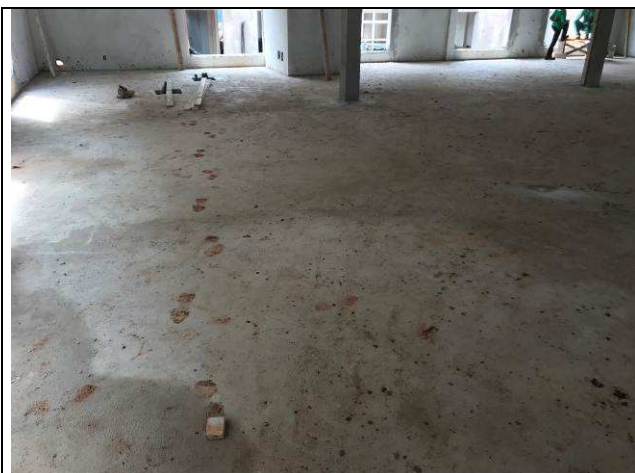
Figura 87C: Contrapiso concretado - Fórum.
