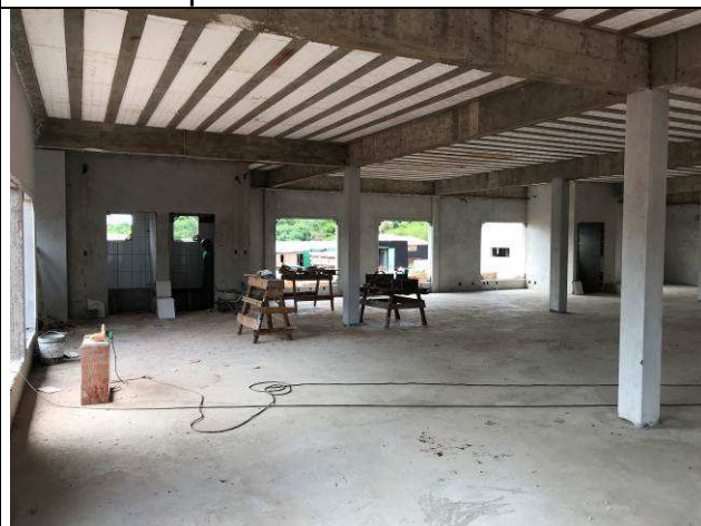
Figura 42C: Revestimento argamassado das paredes internas - Fórum.
