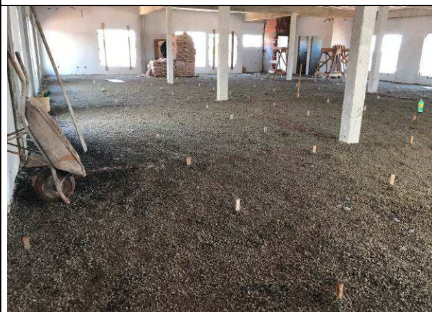
Figura 70C: Camada de brita - contrapiso Fórum.
