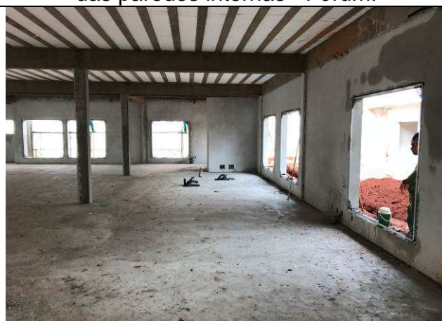
Figura 43C: Revestimento argamassado das paredes internas - Fórum.
