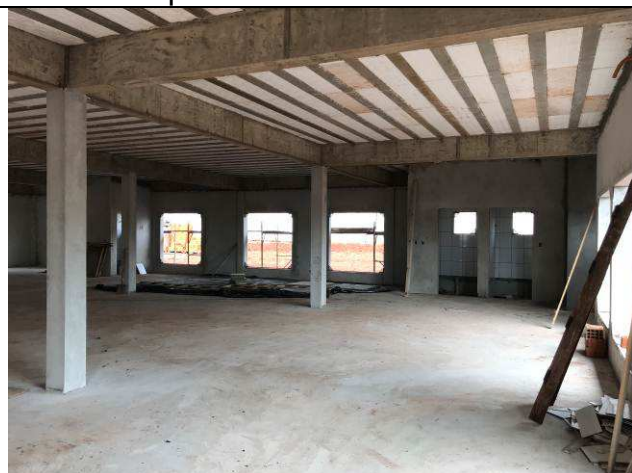
Figura 37C: Revestimento argamassado das paredes internas - Fórum.
