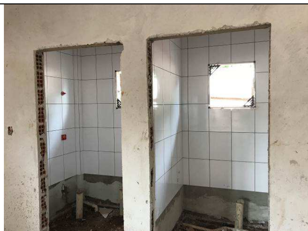
Figura 49C: Revestimento cerâmico - assentamento dos azulejos.
