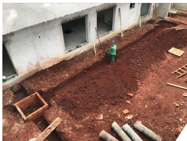
Figura 01C: Abertura de valas para passagem das tubulações.
