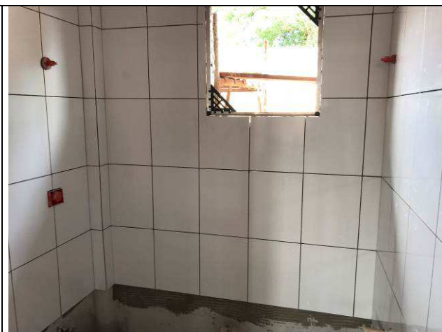
Figura 54C: Revestimento cerâmico - assentamento dos azulejos.
