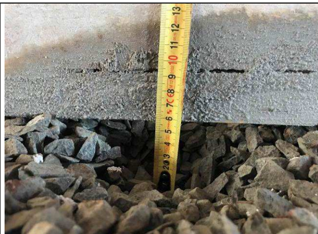
Figura 72C: Camada de brita - contrapiso Fórum.
