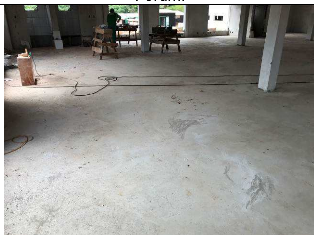
Figura 85C: Contrapiso concretado - Fórum.
