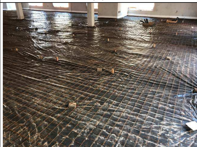
Figura 74C: Aplicação da lona e da tela metálica - contrapiso Fórum.
