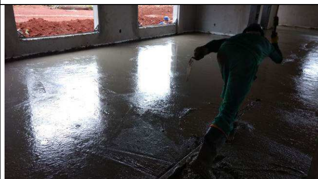
Figura 82C: Concretagem e nivelamento - contrapiso Fórum.
