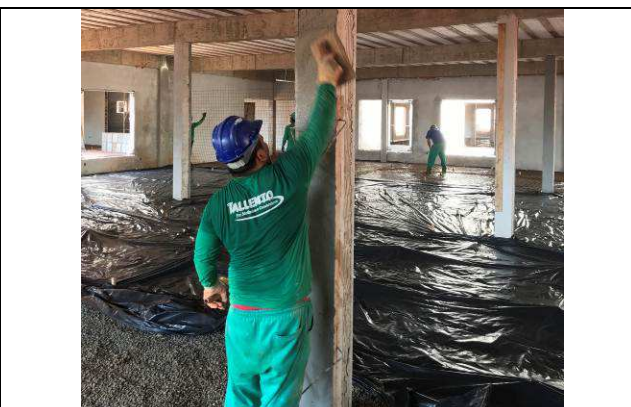
Figura 32C: Revestimento argamassado das paredes internas - Fórum.
