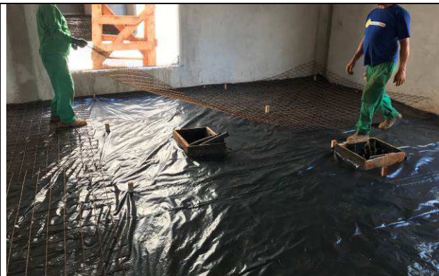
Figura 28C: Lona plástica para impermeabilização do contrapiso - Fórum.
