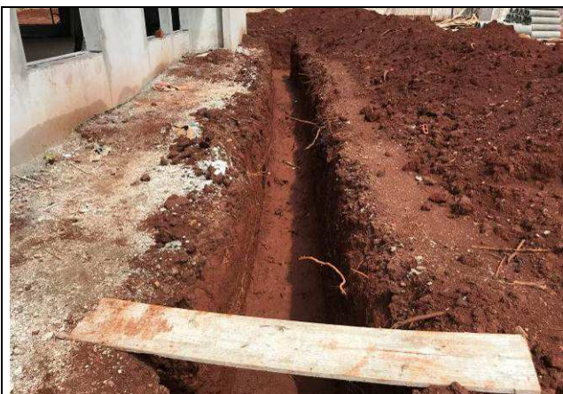
Figura 03C: Abertura de valas para passagem das tubulações.
