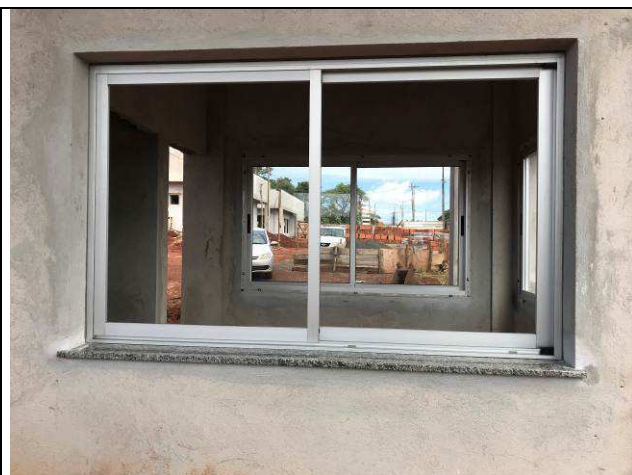
Figura 10C: Janelas de alumínio, tipo de correr, instaladas na guarita.
