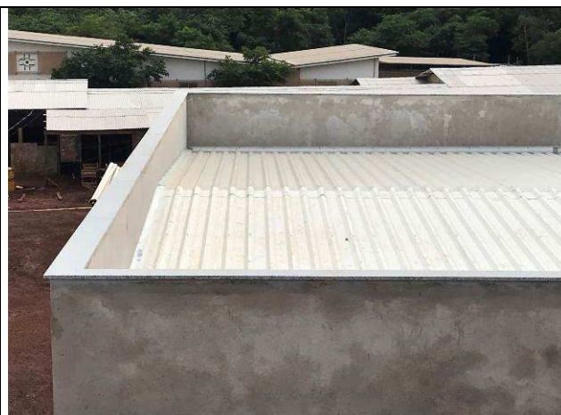
Figura 22C: Capeamento da platibanda com peitoris de granito - Arquivo.
