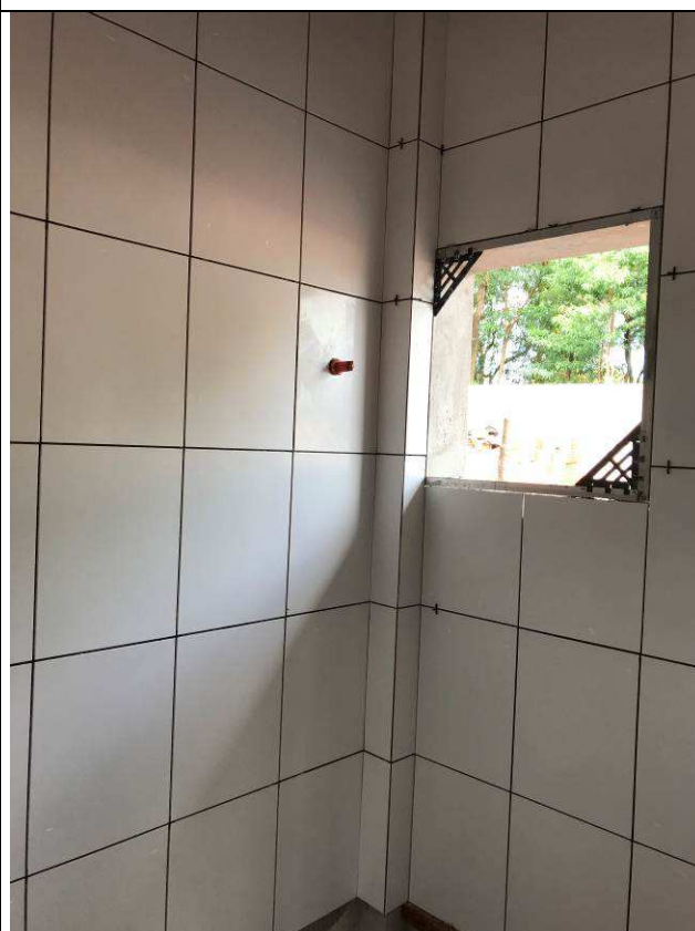
Figura 48C: Revestimento cerâmico - assentamento dos azulejos.
