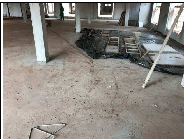
Figura 82C: Contrapiso concretado - Fórum.
