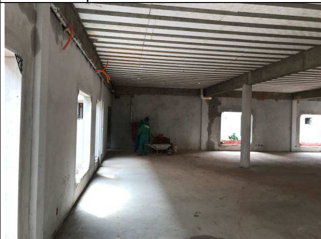
Figura 36C: Revestimento argamassado das paredes internas - Fórum.
