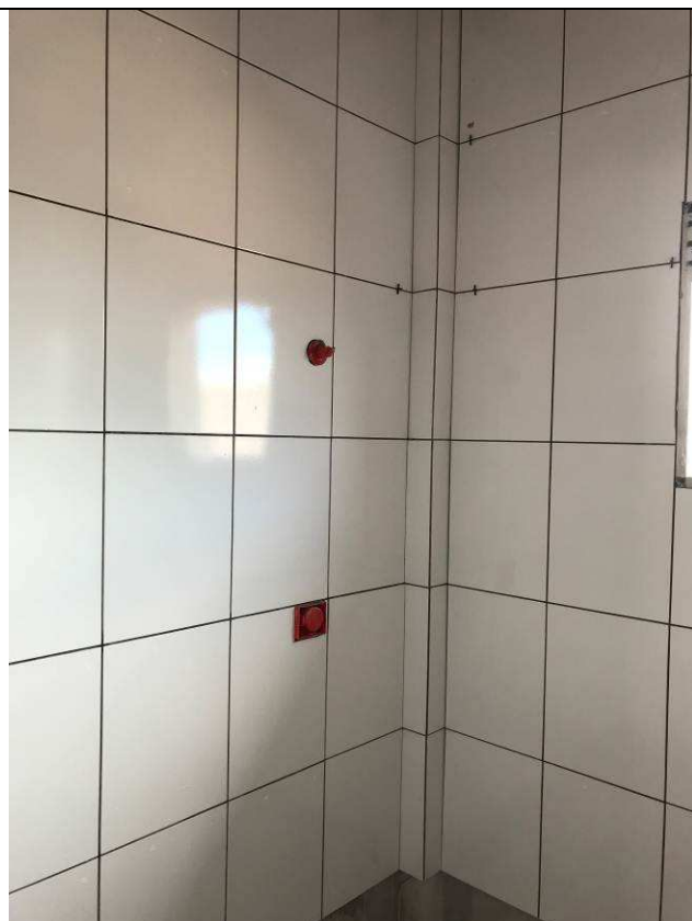
Figura 51C: Revestimento cerâmico - assentamento dos azulejos.
