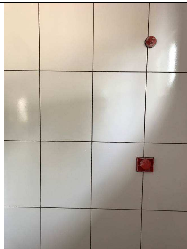
Figura 52C: Revestimento cerâmico - assentamento dos azulejos.
