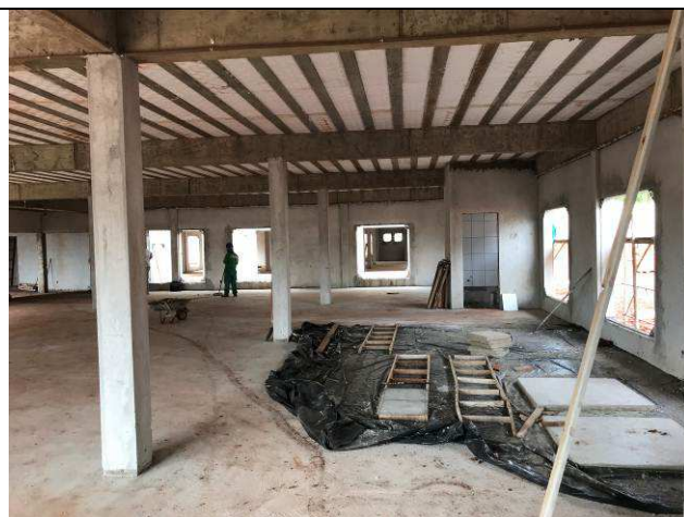
Figura 39C: Revestimento argamassado das paredes internas - Fórum.
