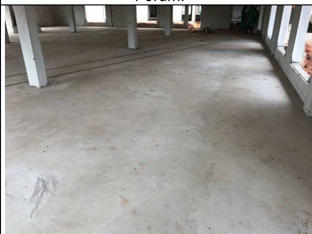
Figura 86C: Contrapiso concretado - Fórum.
