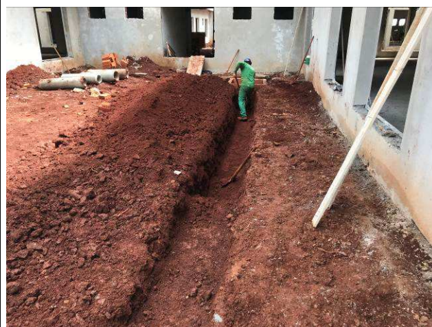
Figura 02C: Abertura de valas para passagem das tubulações.
