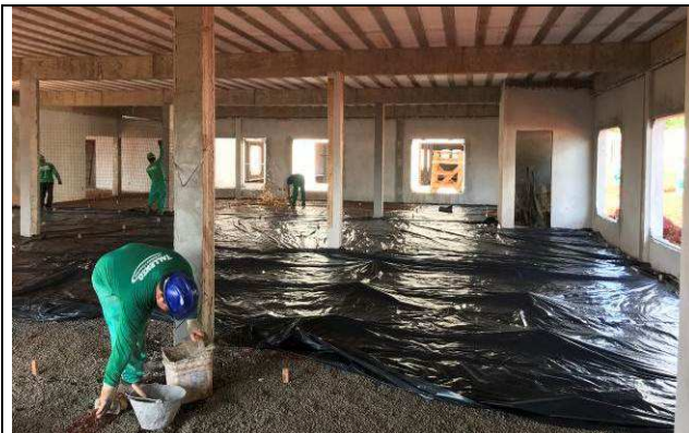
Figura 27C: Lona plástica para impermeabilização do contrapiso - Fórum.
