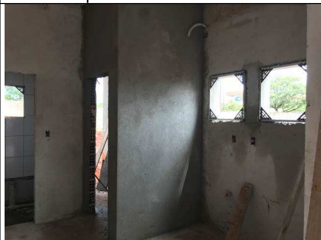
Figura 38C: Revestimento argamassado das paredes internas - Fórum.
