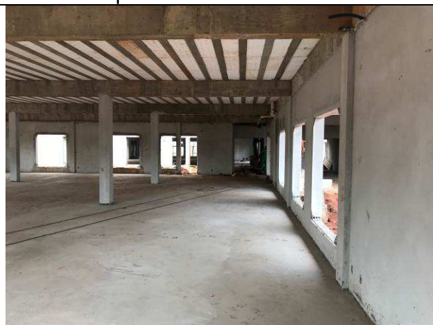
Figura 41C: Revestimento argamassado das paredes internas - Fórum.
