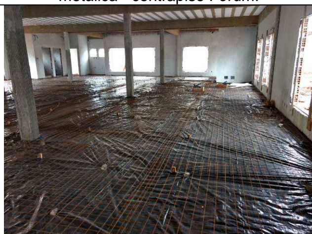
Figura 75C: Aplicação da lona e da tela metálica - contrapiso Fórum.
