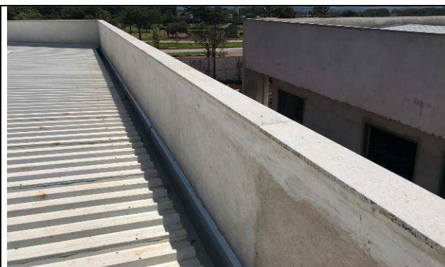
Figura 12C: Capeamento da platibanda com peitoris de granito - Fórum.
