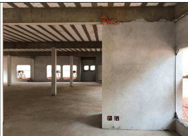
Figura 34C: Revestimento argamassado das paredes internas - Fórum.
