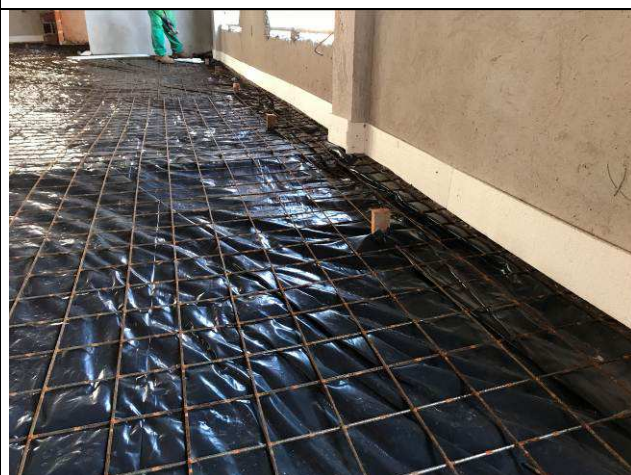
Figura 80C: Concretagem e nivelamento - contrapiso Fórum.
