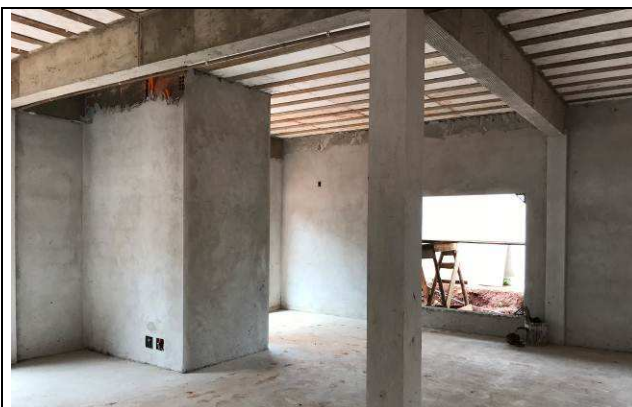
Figura 31C: Revestimento argamassado das paredes internas - Fórum.
