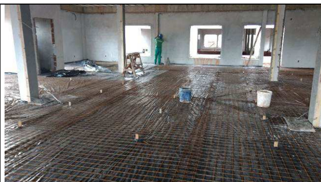
Figura 78C: Aplicação da lona e da tela metálica - contrapiso Fórum.
