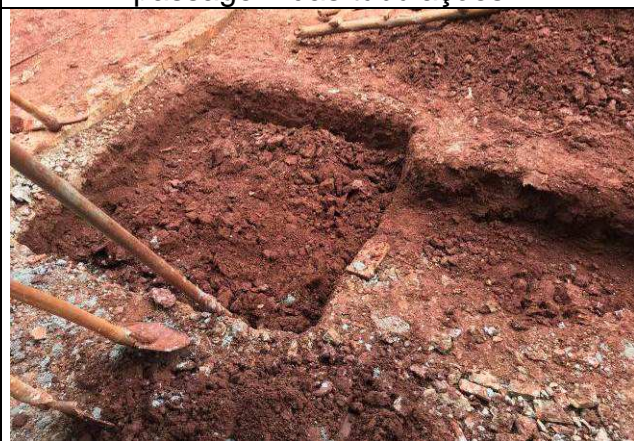
Figura 06C: Abertura de valas para execução de caixas de inspeção.
