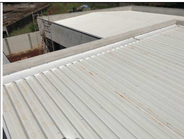
Figura 16C: Capeamento da platibanda com peitoris de granito - Fórum.
