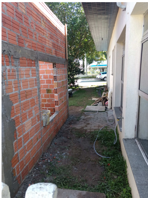
Figura 07c: estruturas e alvenarias - anexo gerador
