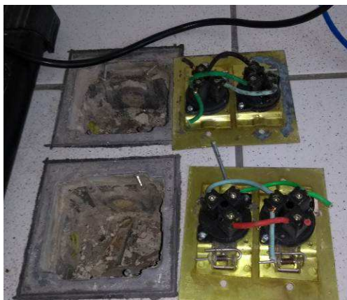
Figura 03E: Retirada de pontos elétricos desativados
