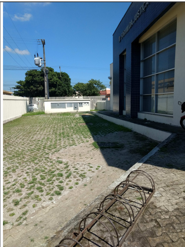
Figura 12c: limpeza de fachadas concluída
