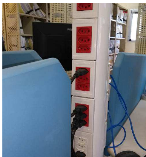
Figura 14E: Acessórios instalados em coluna técnica existente
