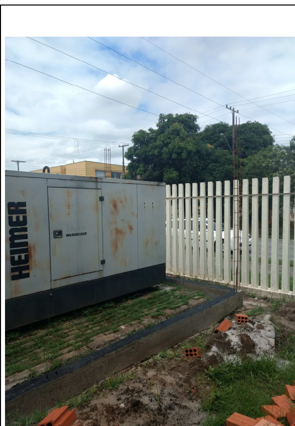
Figura 02c: fundações do anexo gerador
