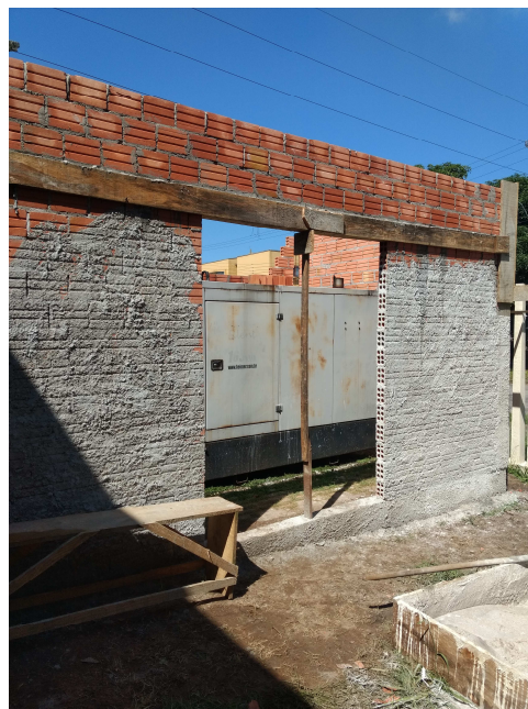
Figura 08c: estruturas e alvenarias - anexo gerador
