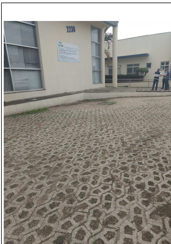
Figura 01c: limpeza da área do estacionamento
