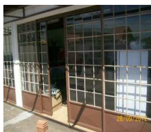
Figura 8 - Remoção de esquadrias metálicas (pantográfica e porta janela copa)
