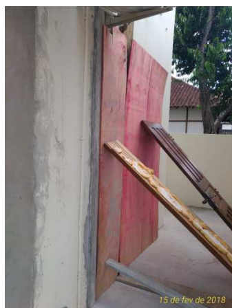
Figura 3 - Instalação de tapume.
