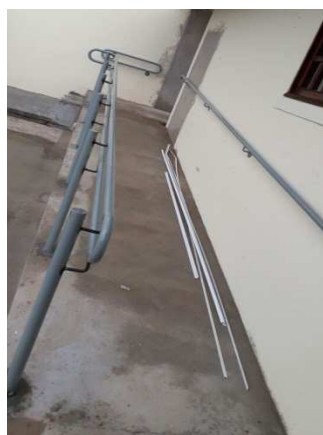
Figura 12 - Execução de alvenaria, aterro, lastro de concreto, armação, grelha e tubo de drenagem. O Corrimão deve ser corrigido.
