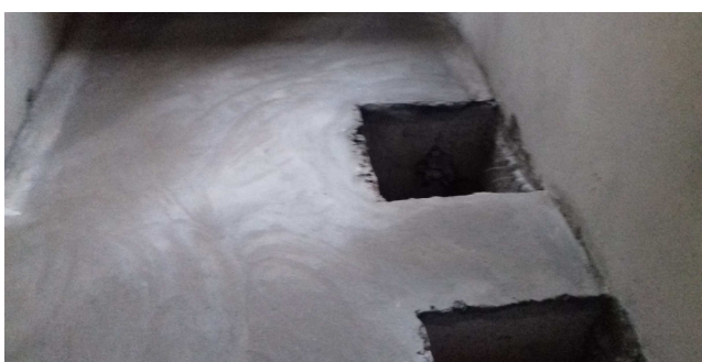
Figura 15C: Contrapiso executado no prédio principal - sala técnica
