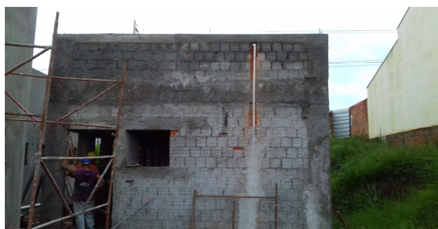
Figura 10C: aplicação de entelamento protetivo - prédio do arquivo
