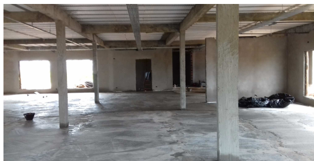
Figura 02C: alvenaria da sala técnica
