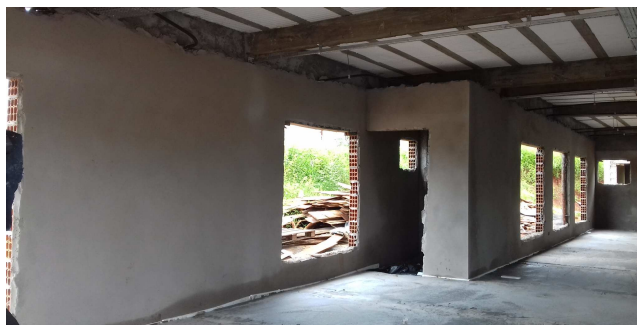
Figura 01C: alvenaria do sanitário do juiz titular
