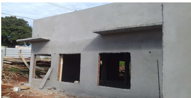
Figura 11C: rebôco externo do prédio principal - frente
