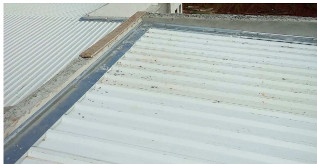
Figura 06C: telhas e rufos - cobertura do reservatório
