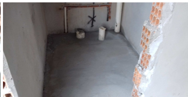
Figura 18C: Contrapiso executado no prédio principal - BWC juiz titular
