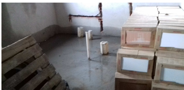
Figura 22C: Pontos de esgoto secundários e primários nos BWCs públicos
