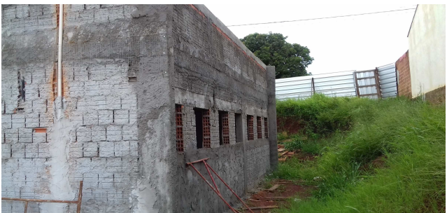
Figura 23C: Tubulação de ventilação subindo à cobertura, no prédio do arquivo
