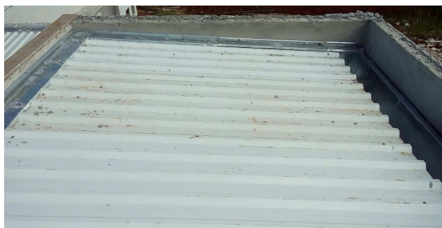
Figura 05C: telhas, calha e rufos - cobertura do reservatório
