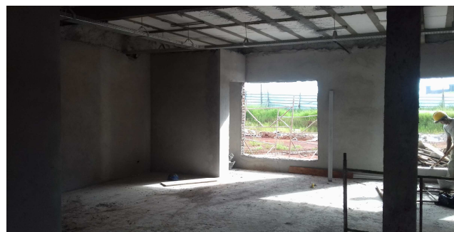
Figura 03C: alvenaria do sanitário do juiz auxiliar
