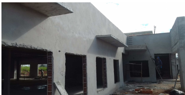
Figura 12C: rebôco externo do prédio principal - frente
