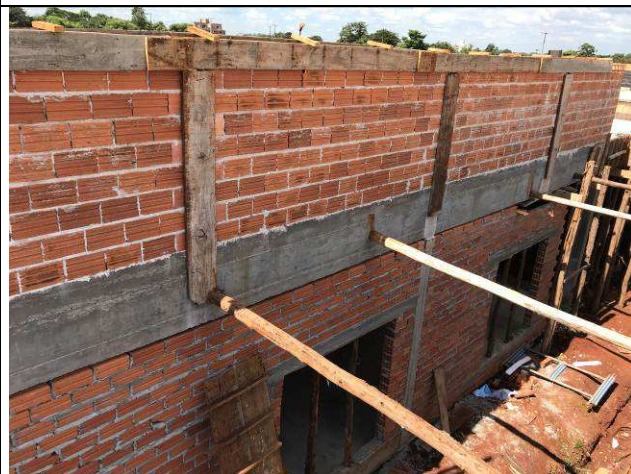
Figura 44C: Paredes de alvenaria externas.
