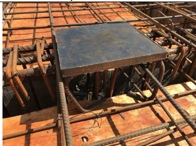
Figura 09C: Formas e armaduras das vigas e lajes da cobertura - insertes metálicos.
