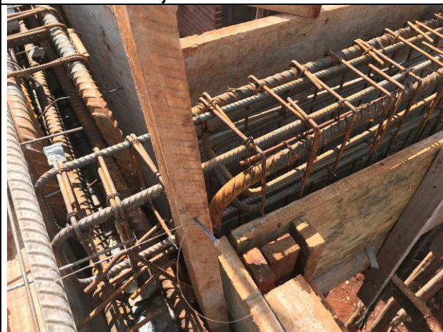
Figura 10C: Formas e armaduras das vigas e lajes da cobertura.
