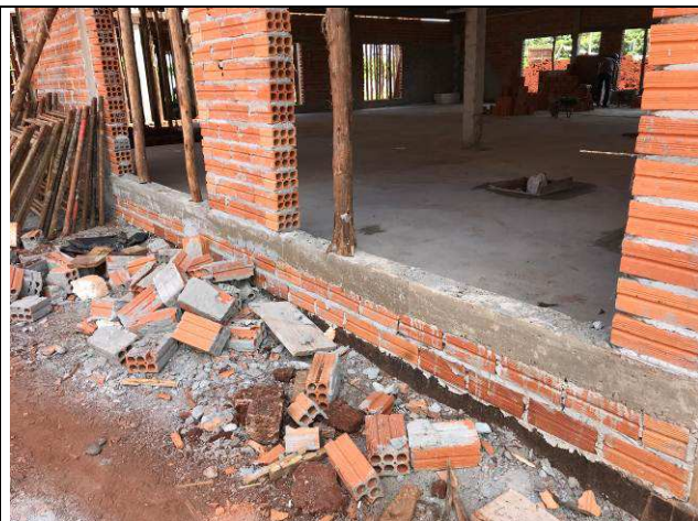
Figura 29C: Vergas e contravergas.
