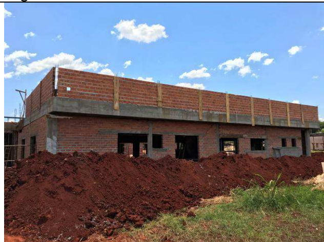
Figura 41C: Paredes de alvenaria externas.
