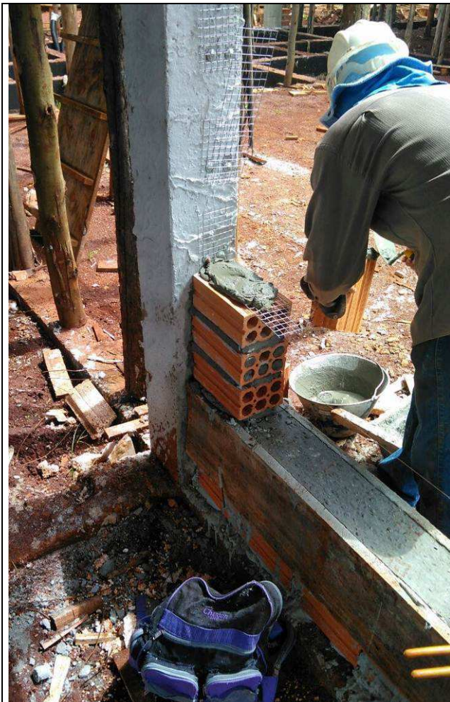
Figura 35C: Execução das paredes de alvenaria externas.
