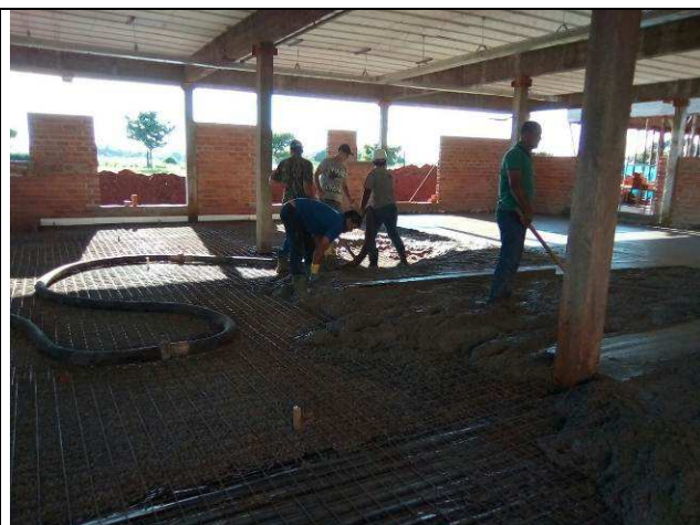
Figura 60C: Concretagem do contra piso.
