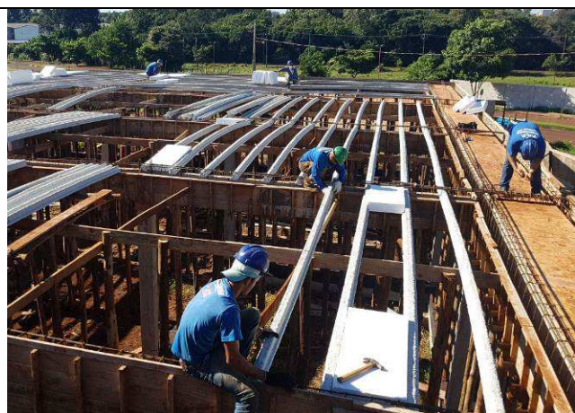
Figura 05C: Montagem das lajes pré fabricadas.
