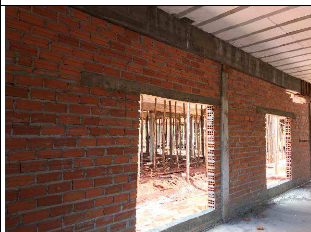
Figura 34C: Vergas e contravergas.
