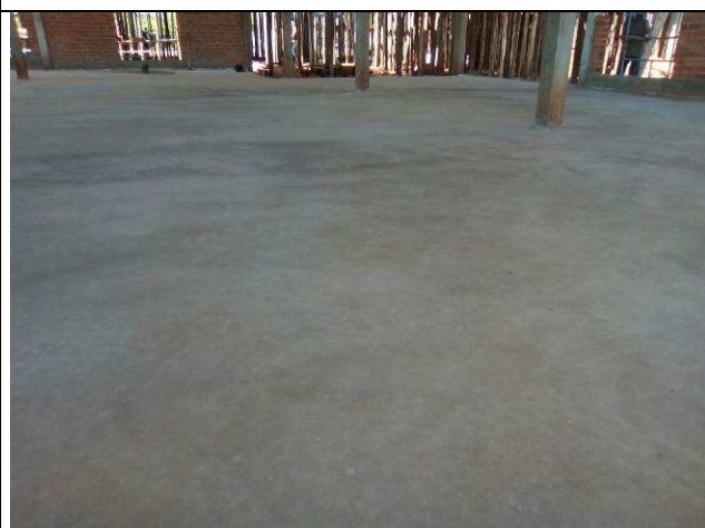
Figura 62C: Contra piso concretado.
