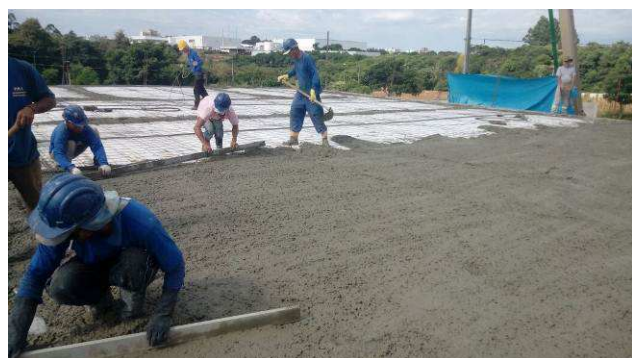
Figura 23C: Concretagem das vigas e lajes da cobertura.
