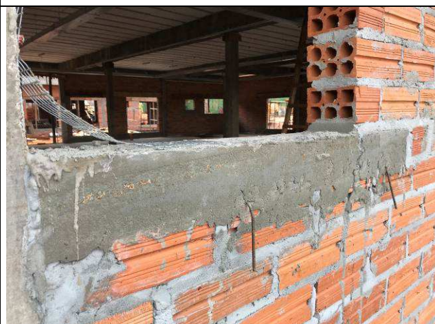
Figura 31C: Vergas e contravergas.
