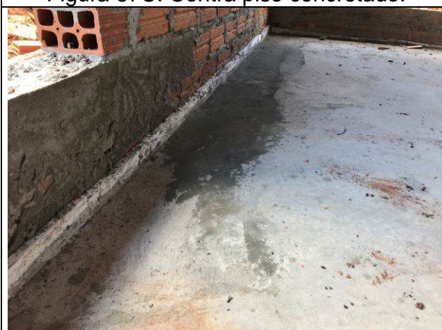
Figura 69C: Contra piso concretado - isopor na junta de dilatação da parede.
