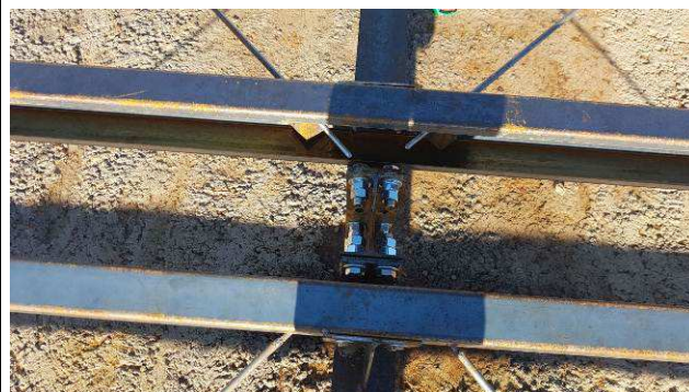
Figura 46C: Estrutura metálica de cobertura - pórticos e terças - ligações.
