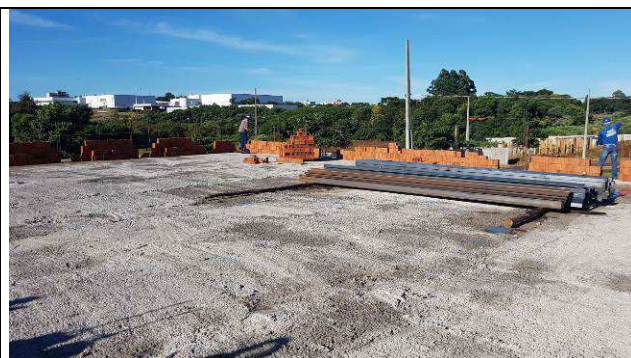
Figura 26C: Vigas e lajes da cobertura concretadas.
