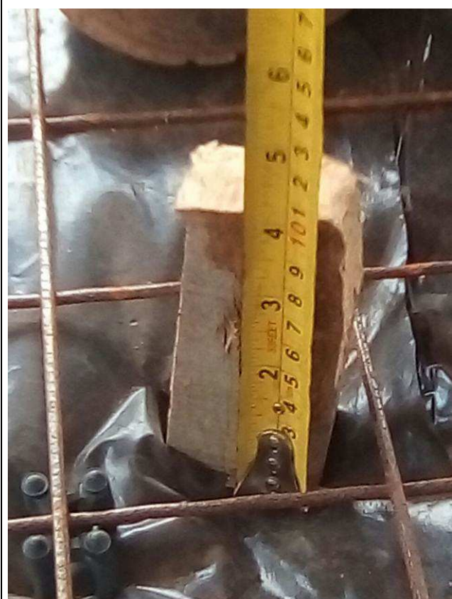
Figura 57C: Instalação da lona plástica e da tela metálica.
