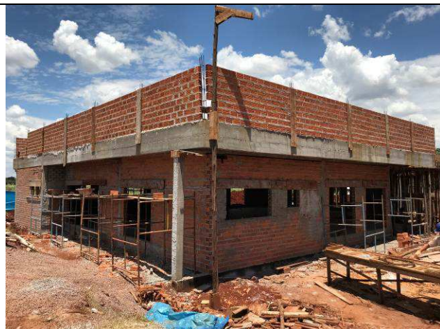
Figura 39C: Paredes de alvenaria externas.
