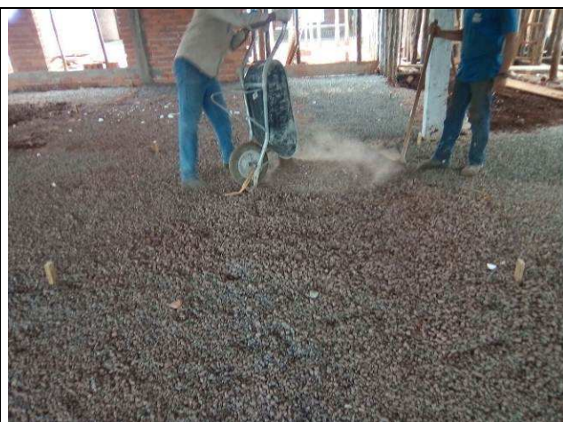
Figura 52C: Camada de brita.
