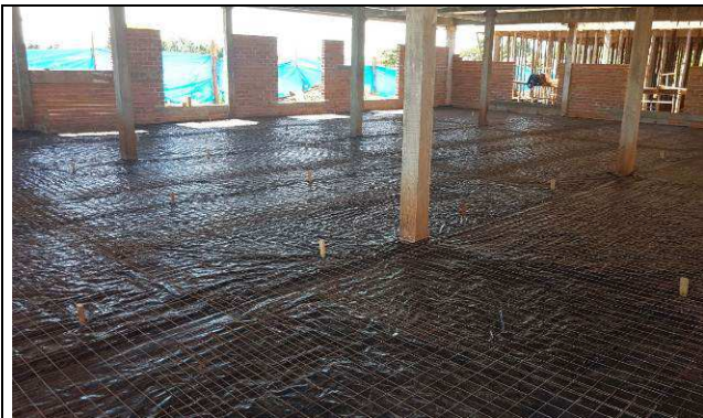
Figura 49C: Lona plástica para impermeabilização do contra piso.
