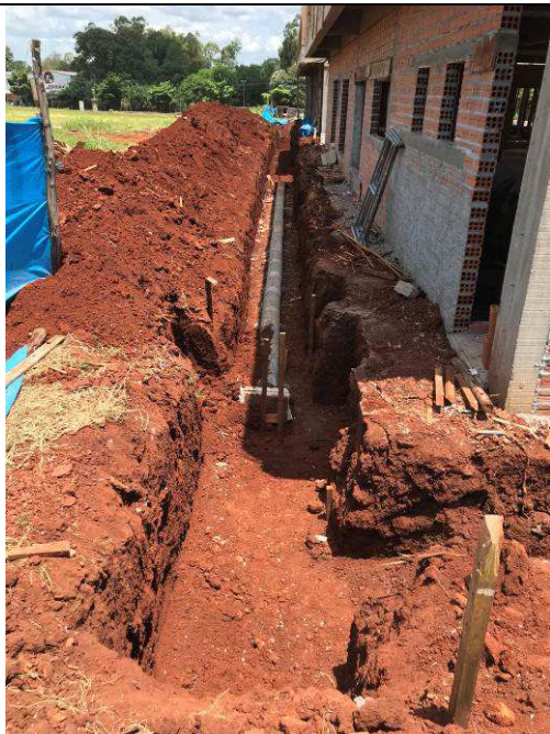
Figura 01C: Escavação de valas para tubulações externas.
