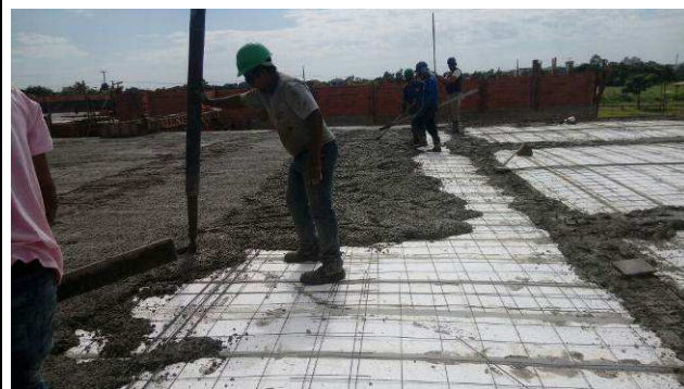
Figura 22C: Concretagem das vigas e lajes da cobertura.
