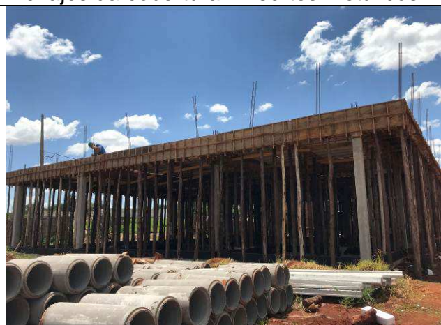
Figura 11C: Formas e armaduras das vigas e lajes da cobertura.
