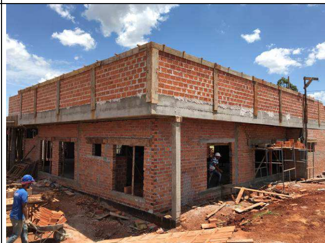
Figura 38C: Paredes de alvenaria externas.
