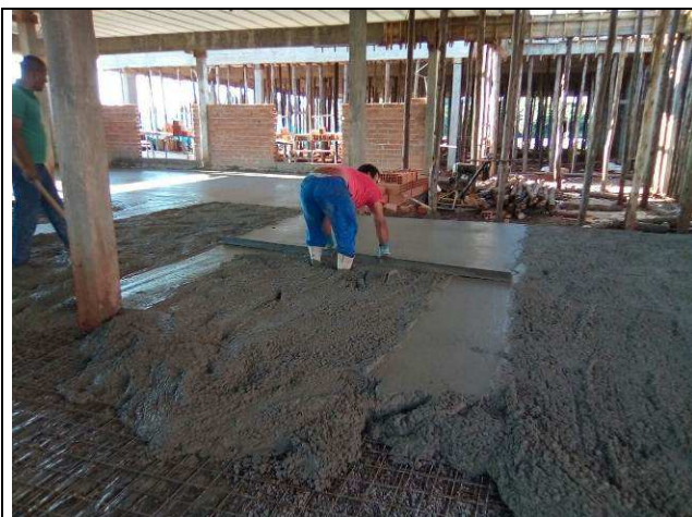
Figura 59C: Concretagem do contra piso.
