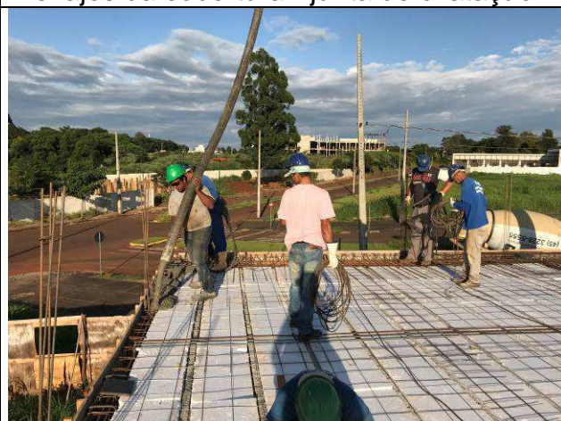
Figura 16C: Concretagem das vigas e lajes da cobertura.
