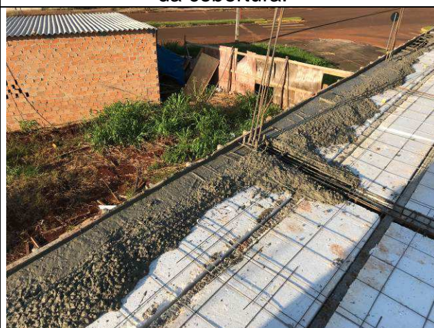
Figura 18C: Concretagem das vigas e lajes da cobertura.
