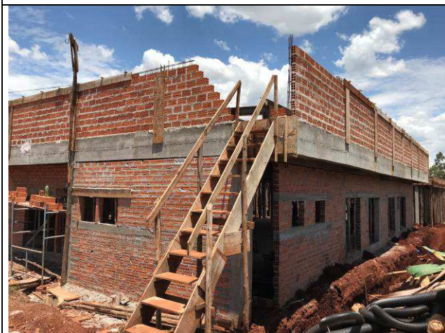
Figura 37C: Paredes de alvenaria externas.
