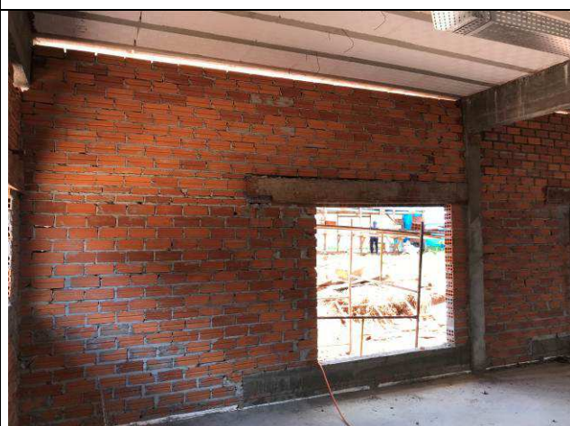
Figura 33C: Vergas e contravergas.
