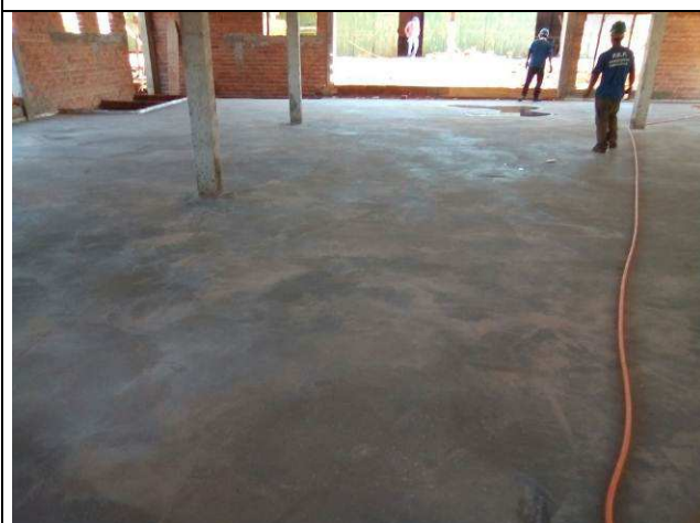
Figura 61C: Contra piso concretado.
