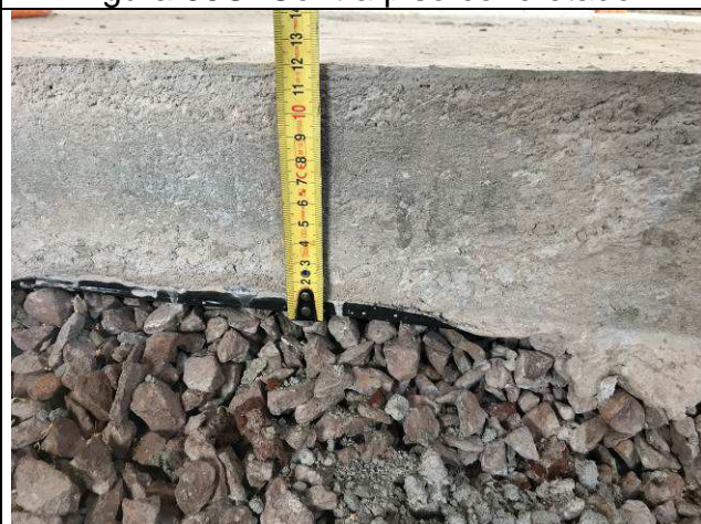
Figura 68C: Contra piso concretado.
