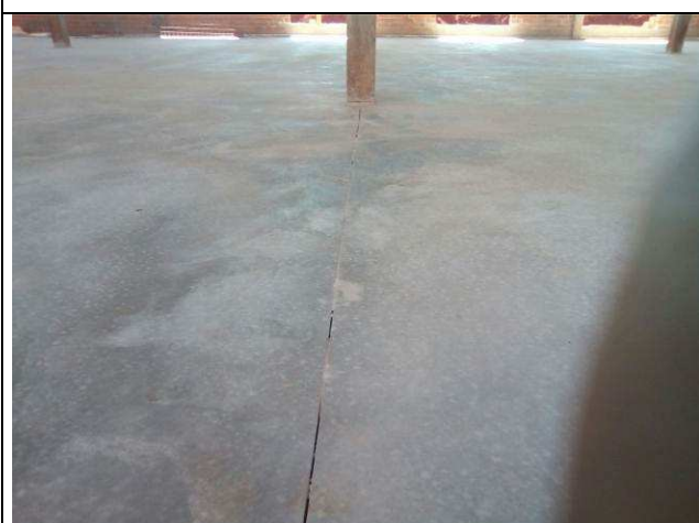
Figura 63C: Contra piso - juntas cortadas.
