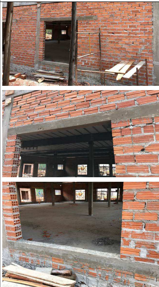
Figura 28C: Vergas e contravergas.
