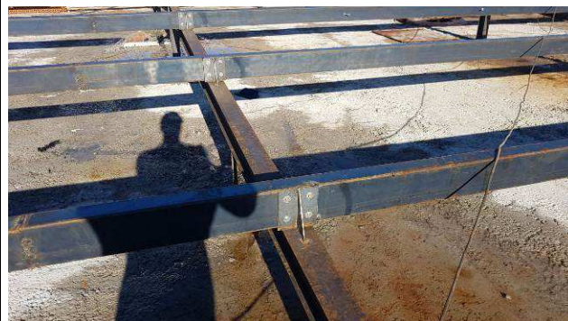
Figura 48C: Estrutura metálica de cobertura - pórticos e terças.
