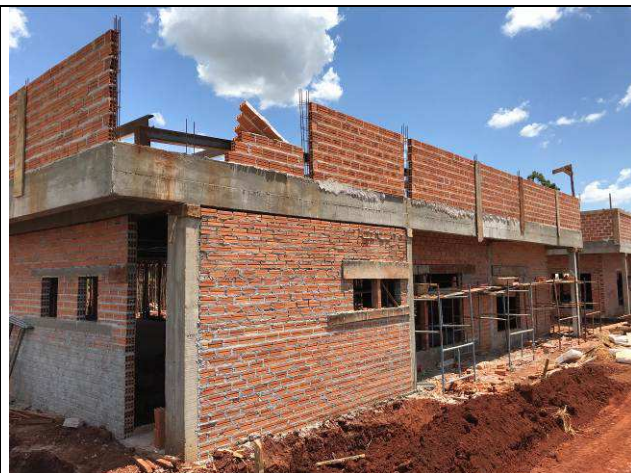
Figura 40C: Paredes de alvenaria externas.
