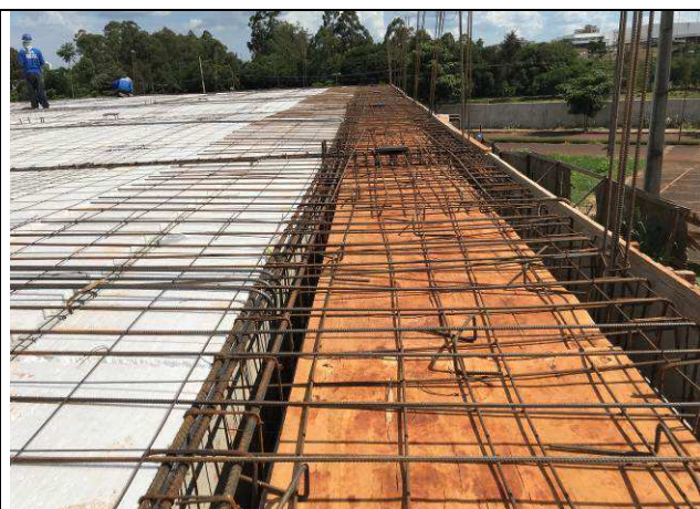
Figura 06C: Formas e armaduras das vigas e lajes da cobertura.
