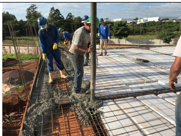
Figura 19C: Concretagem das vigas e lajes da cobertura.
