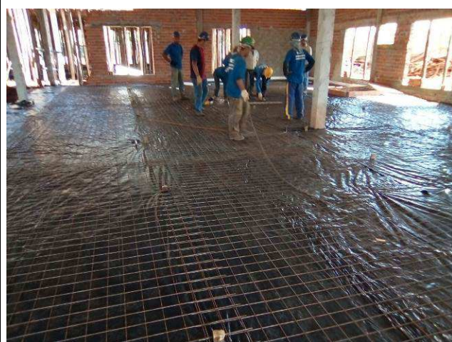
Figura 58C: Instalação da lona plástica e da tela metálica.
