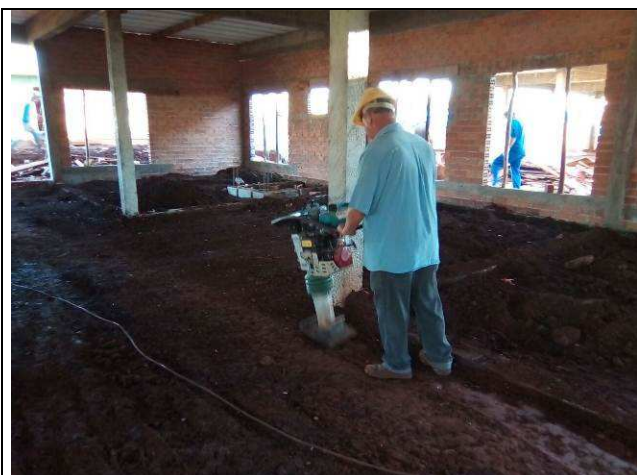
Figura 51C: Compactação da base.
