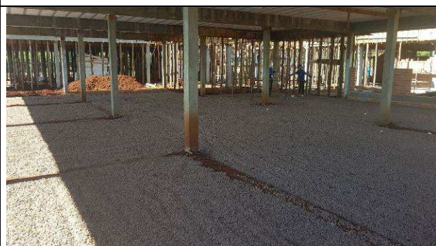
Figura 54C: Camada de brita.
