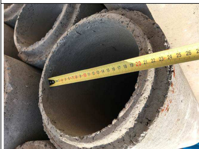
Figura 73C: Tubos de concreto - águas pluviais.
