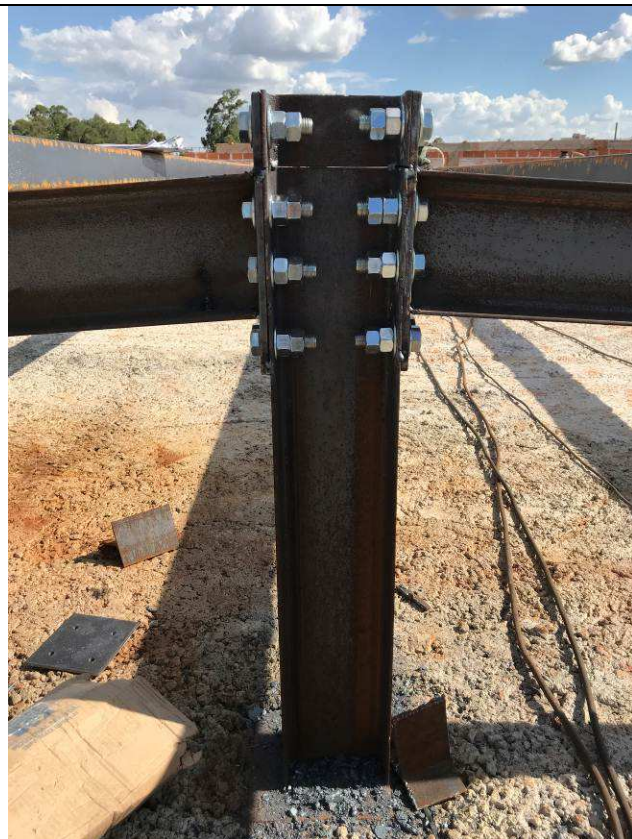
Figura 45C: Estrutura metálica de cobertura - pórticos e terças - ligações.
