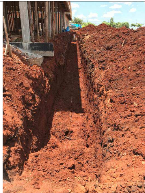
Figura 02C: Escavação de valas para tubulações externas.
