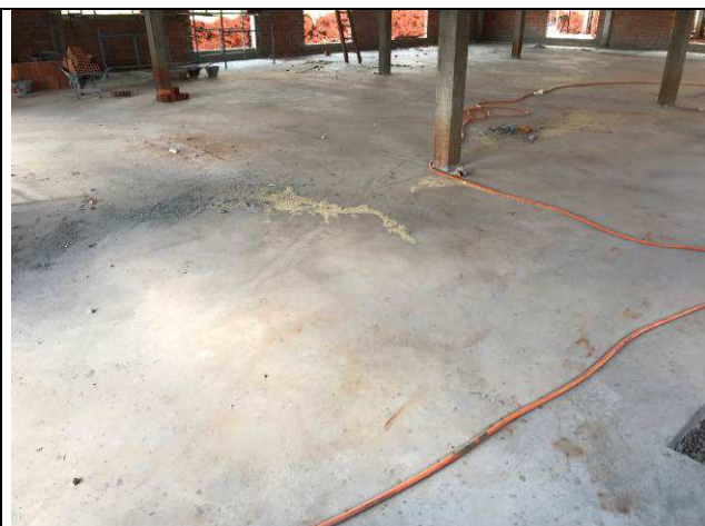
Figura 66C: Contra piso concretado.
