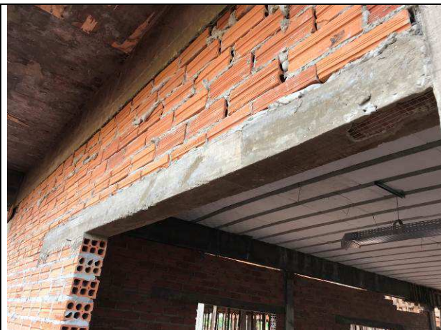
Figura 30C: Vergas e contravergas.
