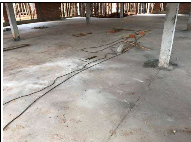
Figura 65C: Contra piso concretado.
