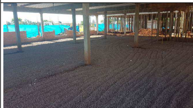
Figura 53C: Camada de brita.
