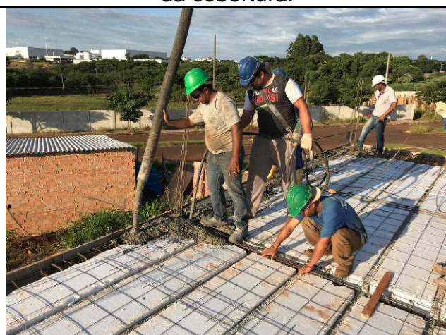
Figura 17C: Concretagem das vigas e lajes da cobertura.
