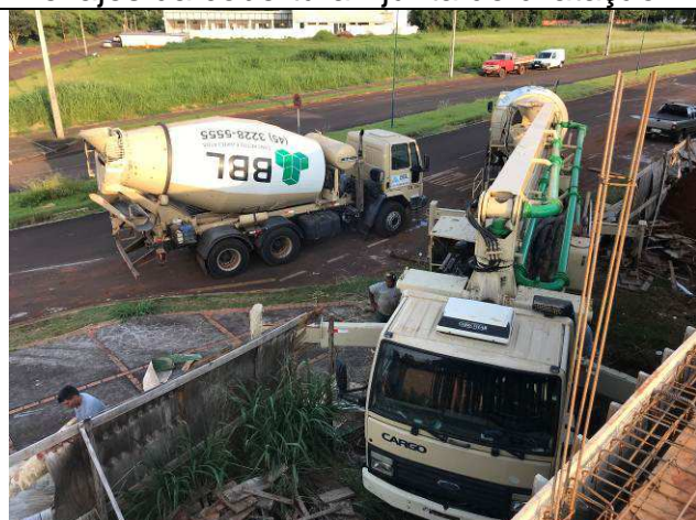
Figura 15C: Concretagem das vigas e lajes da cobertura.
