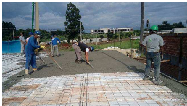
Figura 21C: Concretagem das vigas e lajes da cobertura.
