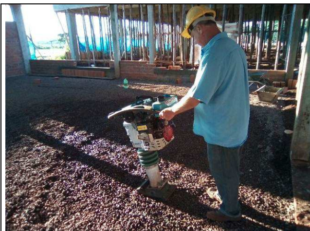
Figura 55C: Compactação da camada de brita.
