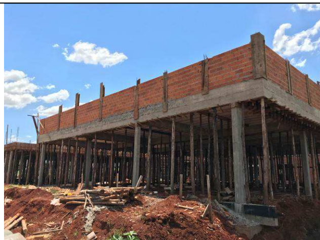
Figura 43C: Paredes de alvenaria externas.
