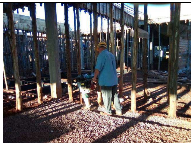
Figura 56C: Compactação da camada de brita.
