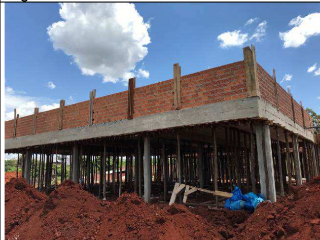
Figura 42C: Paredes de alvenaria externas.
