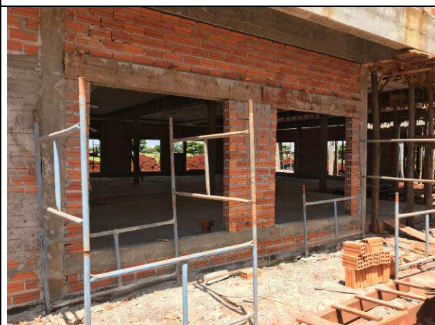
Figura 32C: Vergas e contravergas.
