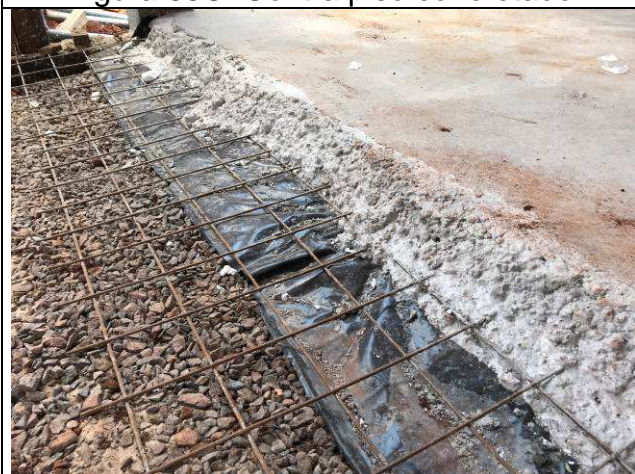
Figura 67C: Contra piso concretado.
