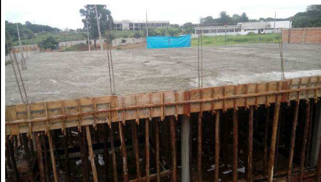
Figura 24C: Concretagem das vigas e lajes da cobertura.
