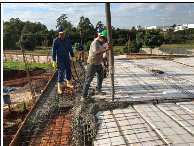
Figura 20C: Concretagem das vigas e lajes da cobertura.
