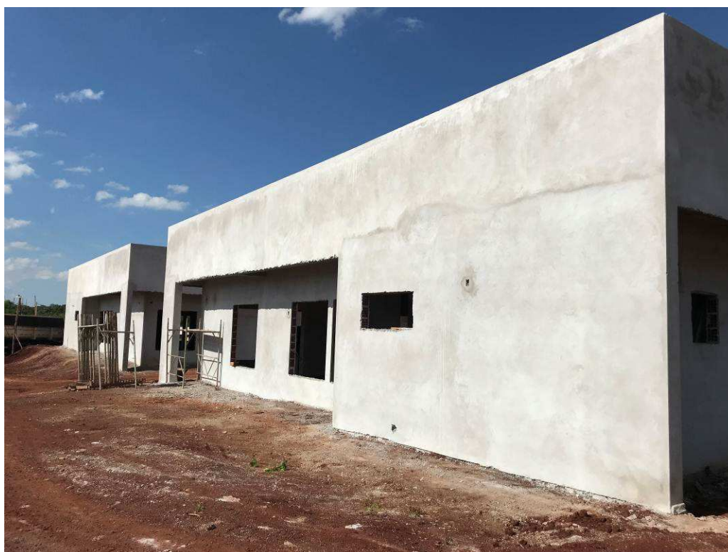
Figura 3 – Prédio do Fórum.
