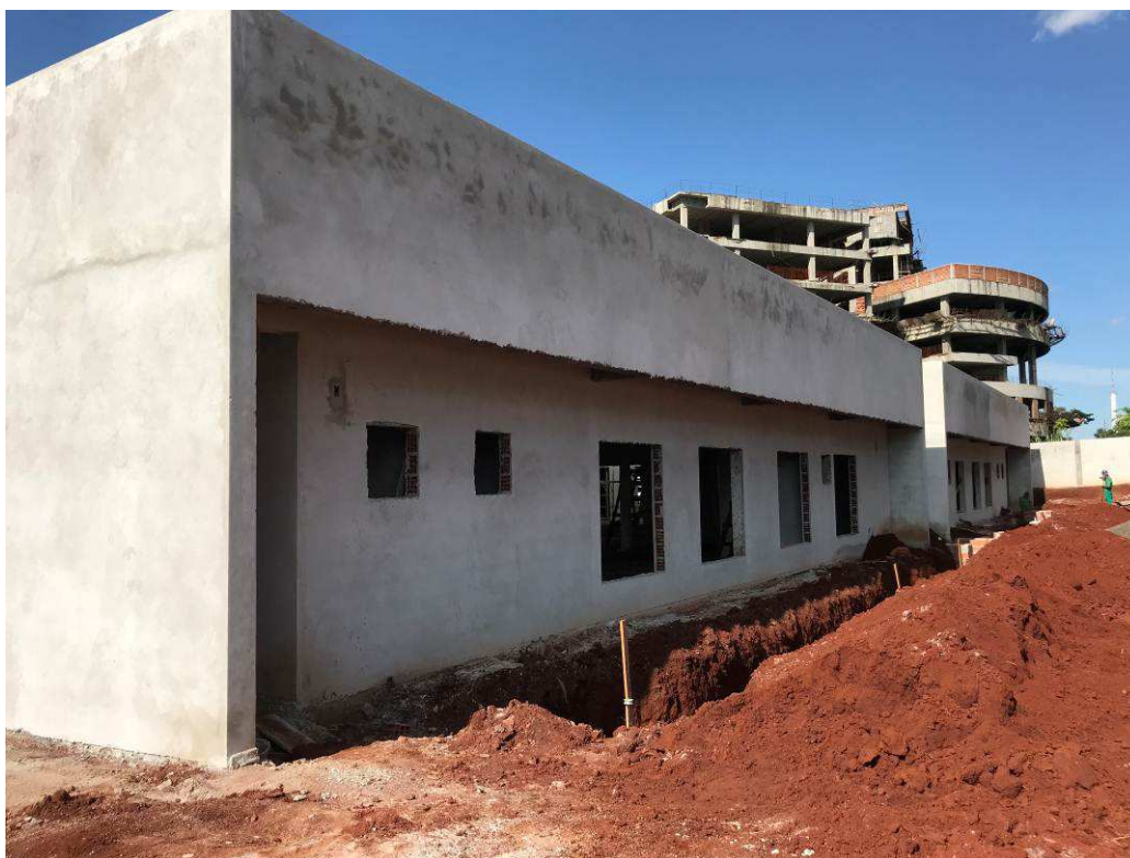
Figura 2 – Prédio do Fórum.
