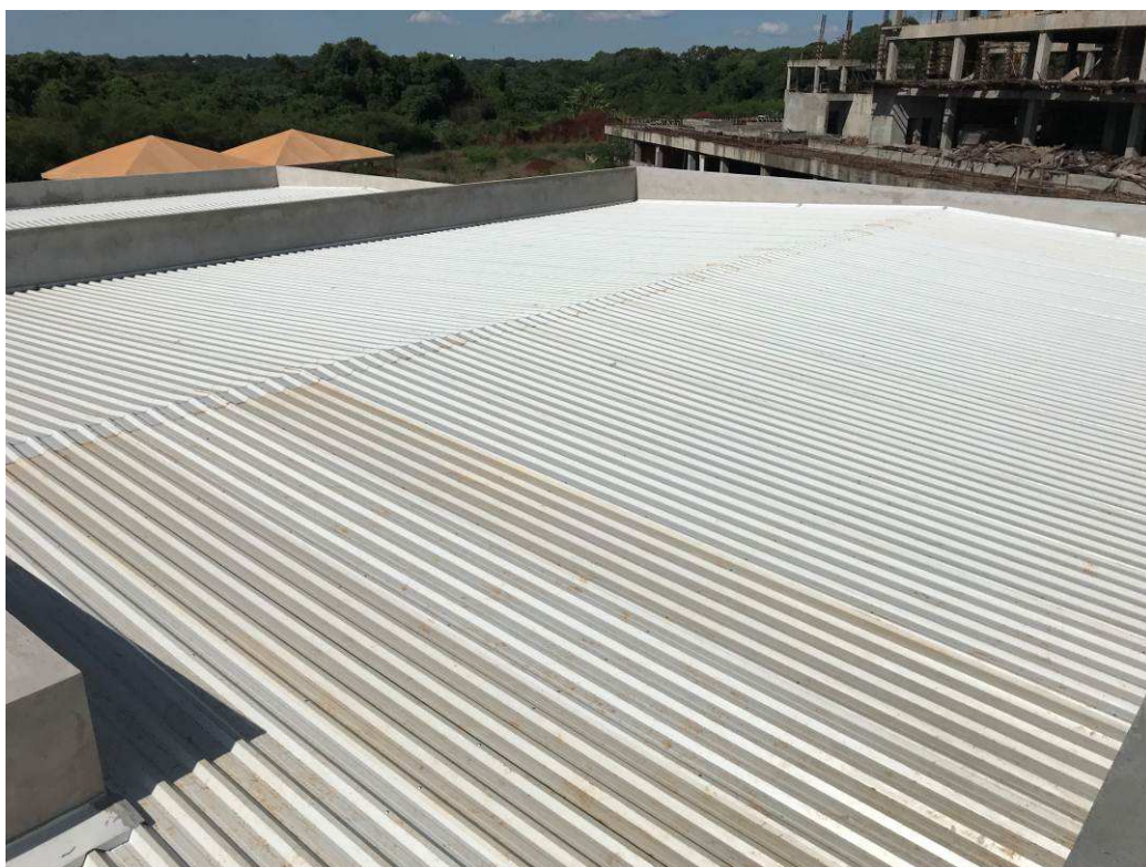
Figura 6 – Prédio do Fórum - cobertura.
