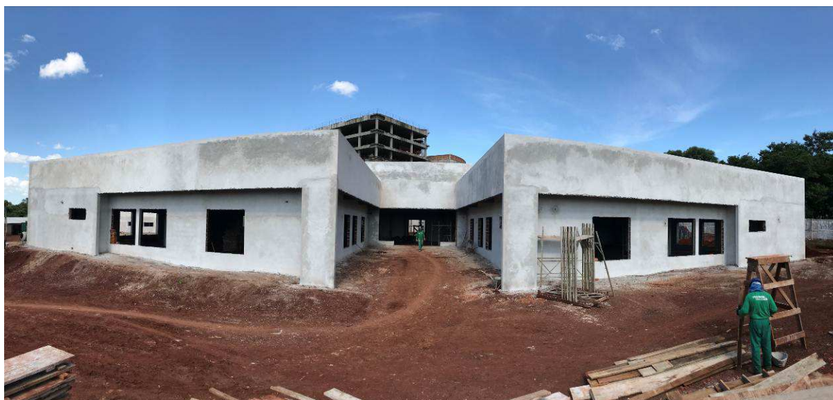
Figura 1 – Vista geral da obra.
