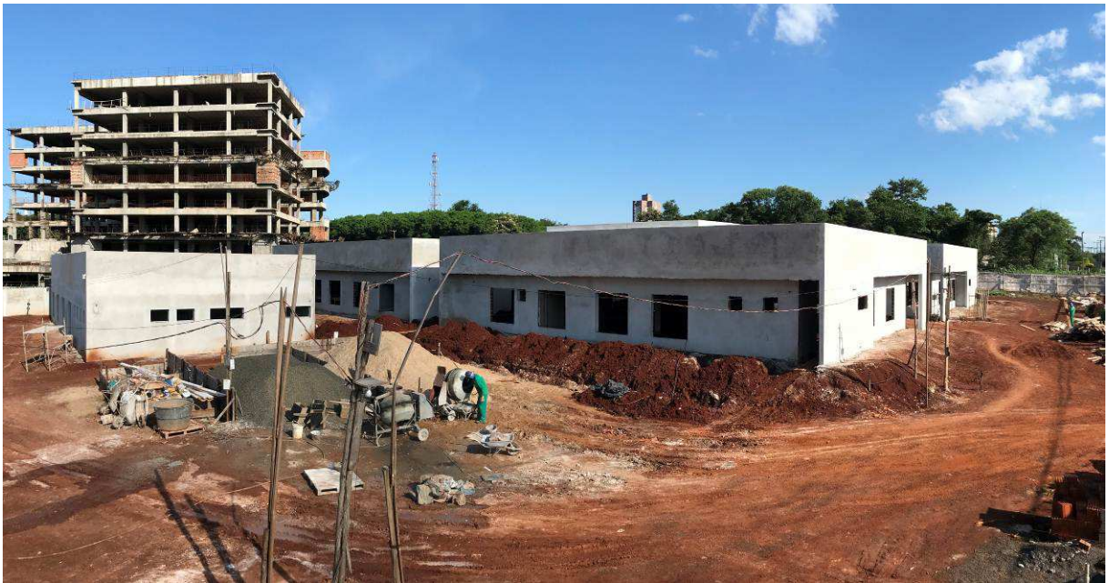
Figura 4 – Canteiro de obras - Prédio do Fórum e arquivo.
