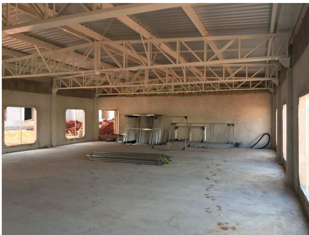
Figura 7 – Arquivo - vista interna.
