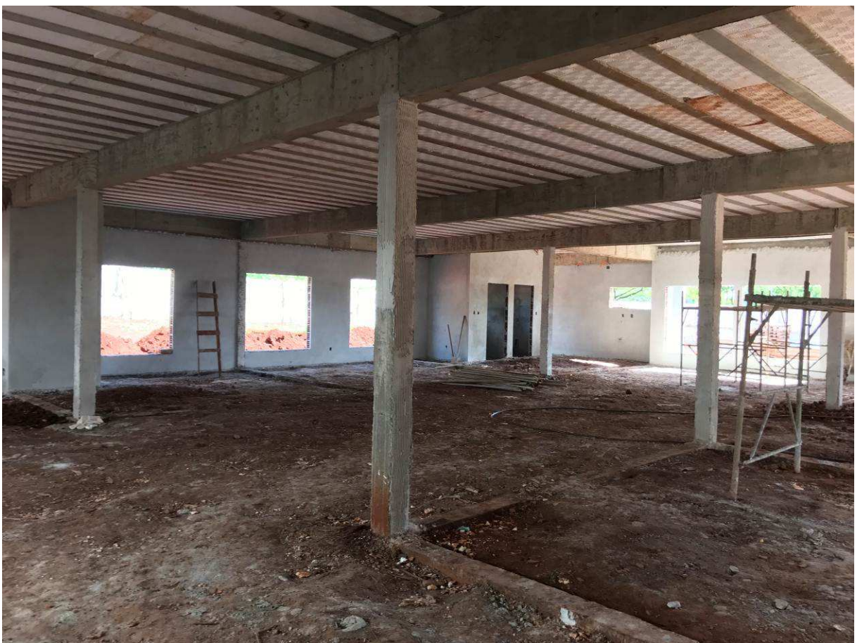
Figura 5 – Prédio do Fórum - vista interna.
