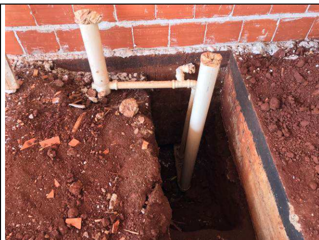
Figura 88C: Pontos de esgoto - BWC distribuição - Fórum.
