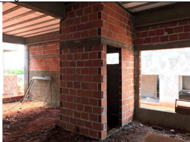
Figura 23C: Alvenarias internas do Fórum.
