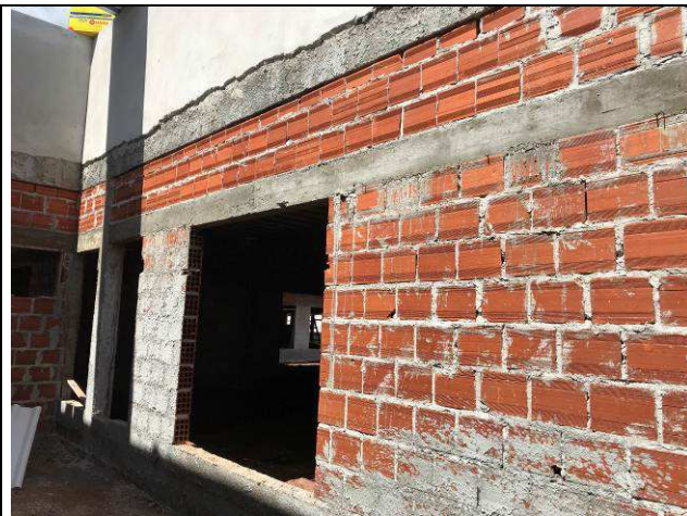
Figura 04C: Vergas e contravergas do Fórum.
