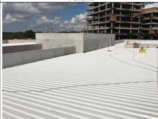
Figura 44C: Telhas metálicas de cobertura - Fórum.
