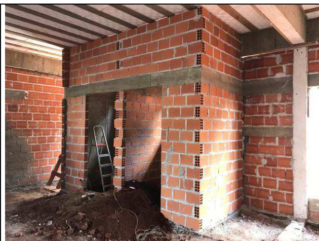
Figura 22C: Alvenarias internas do Fórum.
