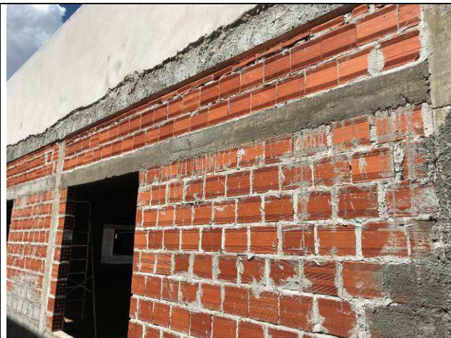
Figura 03C: Vergas e contravergas do Fórum.
