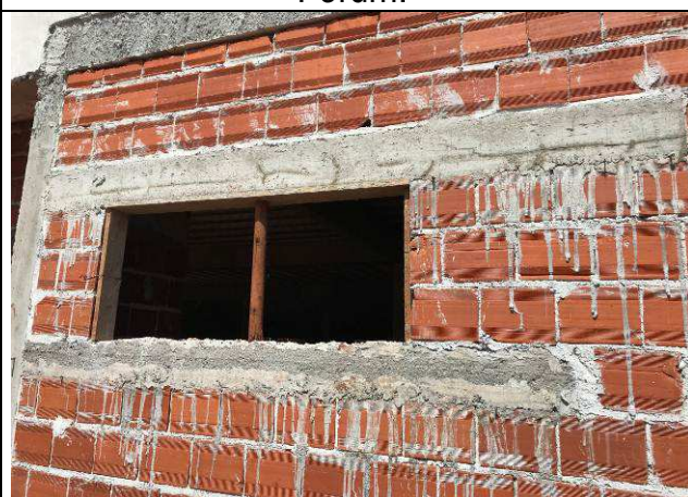
Figura 08C: Vergas e contravergas do Fórum.
