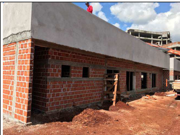
Figura 14C: Alvenarias de vedação do Fórum.
