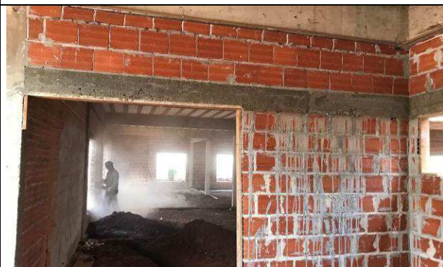
Figura 11C: Vergas e contravergas do Fórum.
