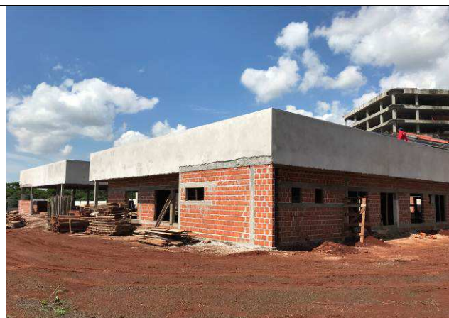
Figura 15C: Alvenarias de vedação do Fórum.
