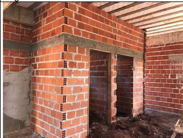
Figura 24C: Alvenarias internas do Fórum.
