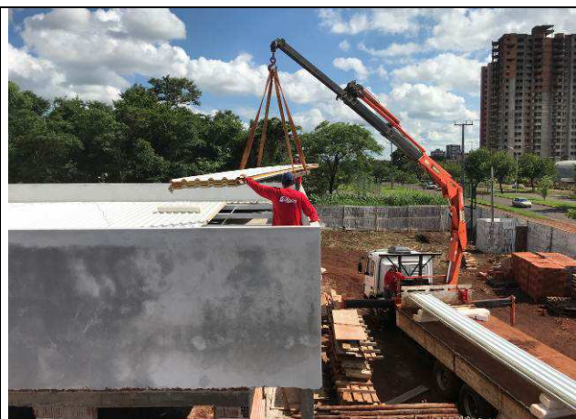
Figura 34C: Montagem das telhas metálicas de cobertura - Fórum.
