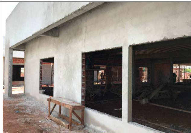
Figura 65C: Revestimento argamassado da face externa - Fórum.
