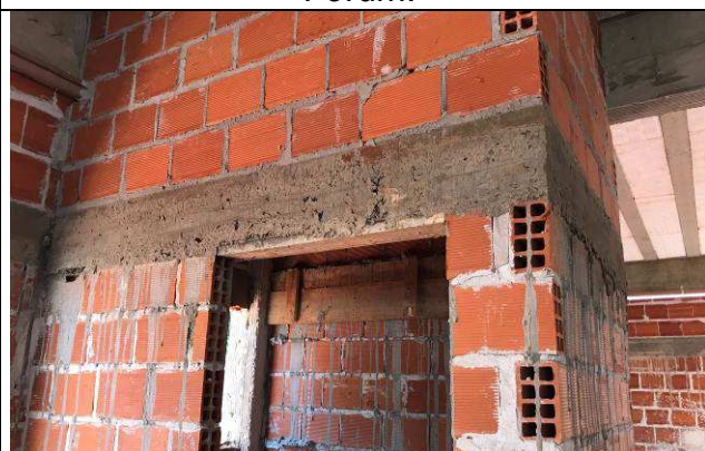
Figura 05C: Vergas e contravergas do Fórum.
