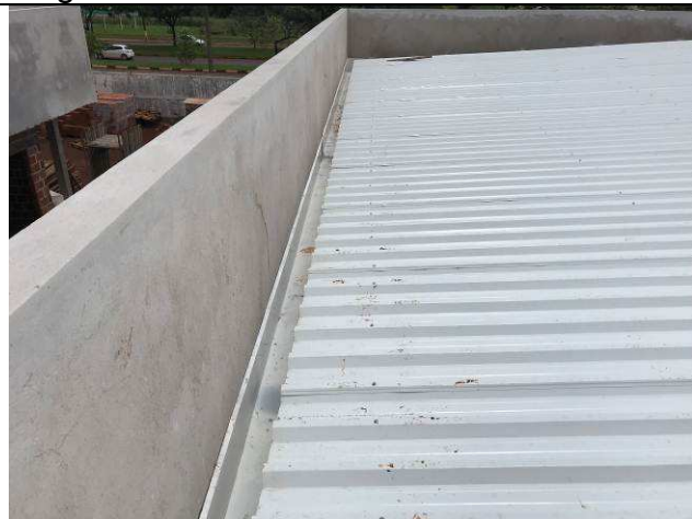
Figura 49C: Calhas de cobertura - Fórum.
