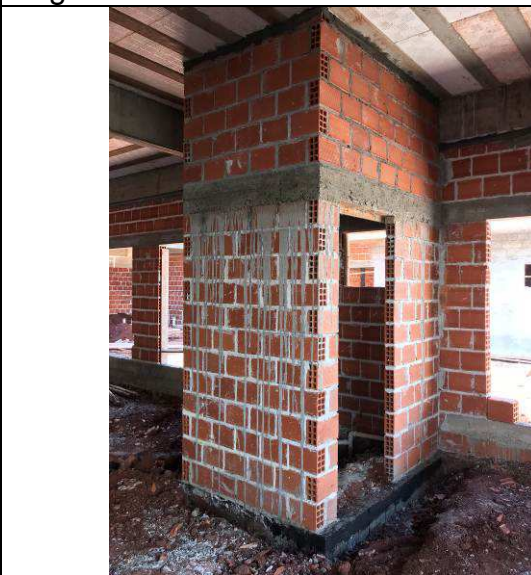
Figura 26C: Alvenarias internas do Fórum.
