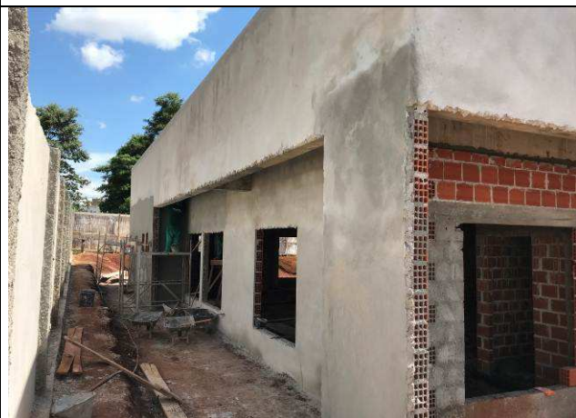
Figura 67C: Revestimento argamassado da face externa - Fórum.
