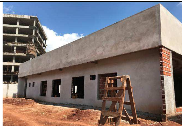
Figura 63C: Revestimento argamassado da face externa - Fórum.
