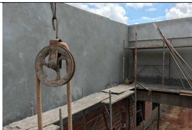
Figura 69C: Revestimento argamassado da face externa - Fórum.
