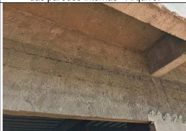
Figura 61C: Instalação da tela na junta alvenaria x viga cobertura - Fórum.
