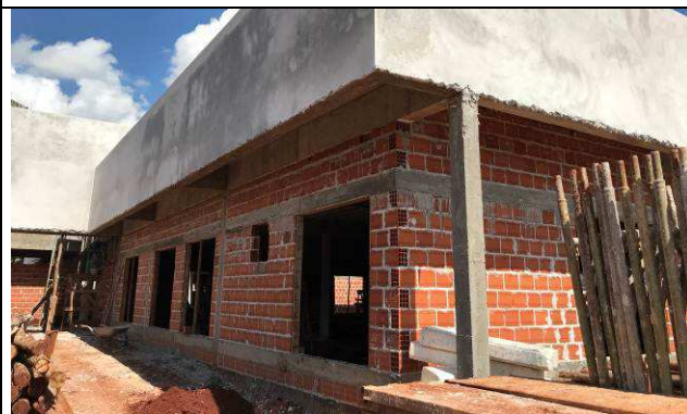
Figura 12C: Vergas e contravergas do Fórum.
