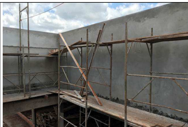
Figura 70C: Revestimento argamassado da face externa - Fórum.
