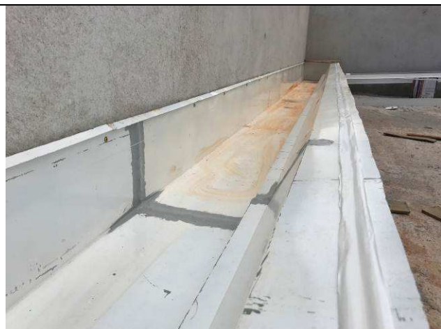
Figura 47C: Calhas de cobertura - Fórum.
