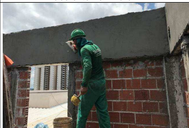
Figura 72C: Revestimento argamassado da face externa - Fórum.
