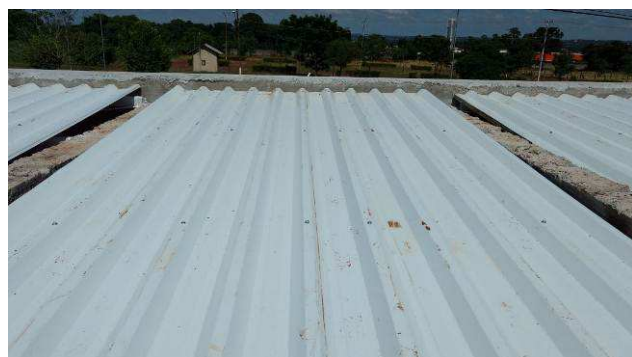
Figura 55C: Telhas metálicas de cobertura - Guarita.
