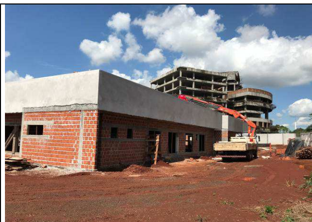
Figura 16C: Alvenarias de vedação do Fórum.
