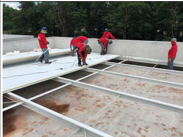
Figura 36C: Montagem das telhas metálicas de cobertura - Fórum.
