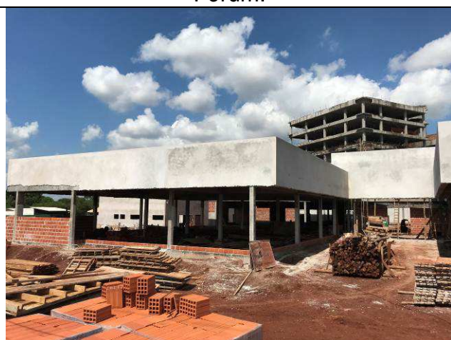
Figura 19C: Alvenarias de vedação do Fórum.
