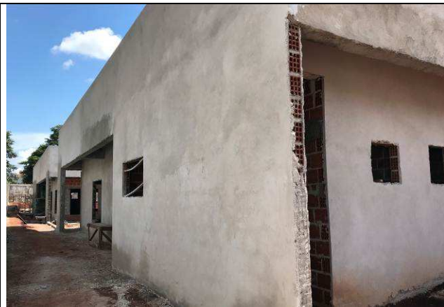
Figura 64C: Revestimento argamassado da face externa - Fórum.
