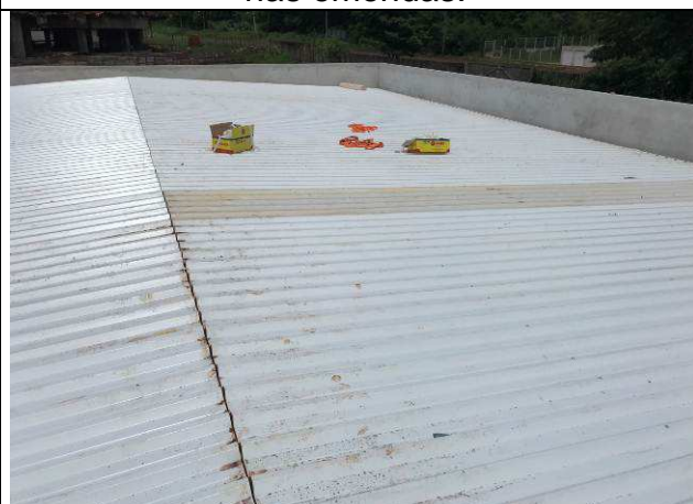
Figura 42C: Telhas metálicas de cobertura - Fórum.
