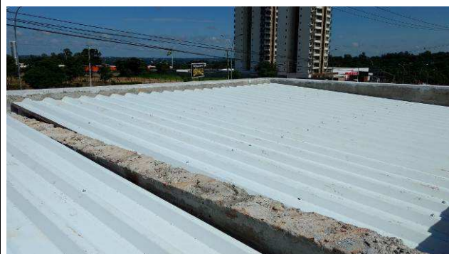
Figura 56C: Telhas metálicas de cobertura - Guarita.
