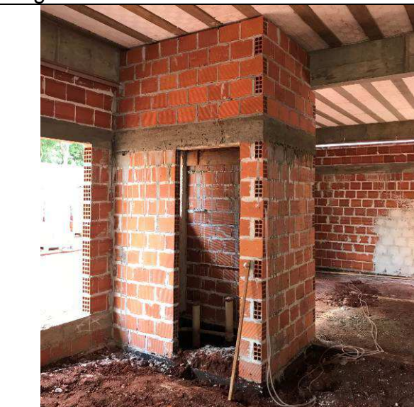
Figura 25C: Alvenarias internas do Fórum.
