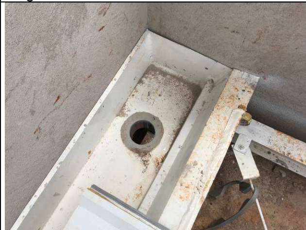
Figura 50C: Calhas de cobertura - Fórum.
