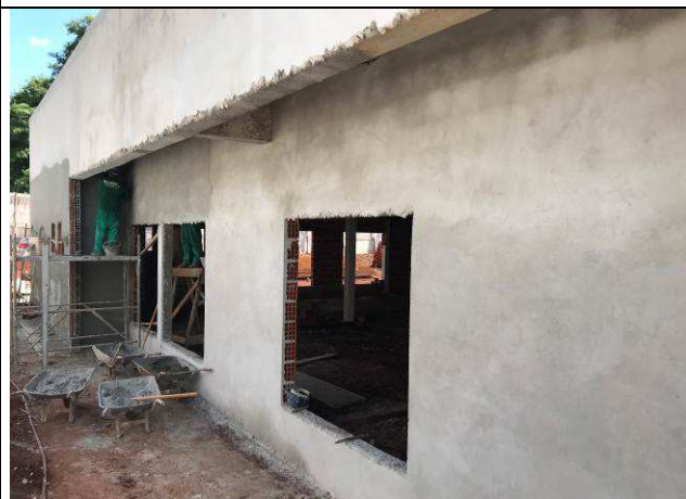
Figura 68C: Revestimento argamassado da face externa - Fórum.
