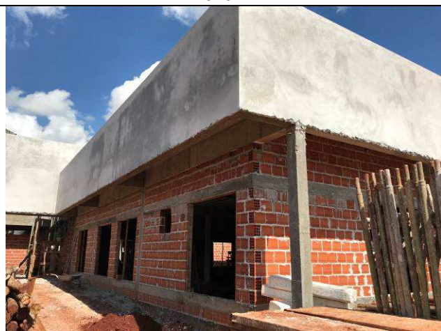
Figura 17C: Alvenarias de vedação do Fórum.
