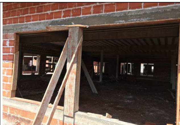
Figura 09C: Vergas e contravergas do Fórum.
