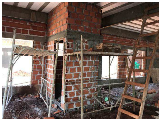
Figura 21C: Alvenarias internas do Fórum.
