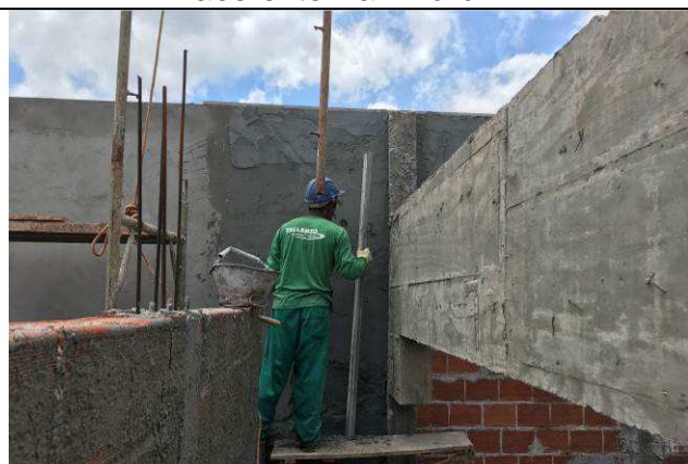
Figura 71C: Revestimento argamassado da face externa - Fórum.
