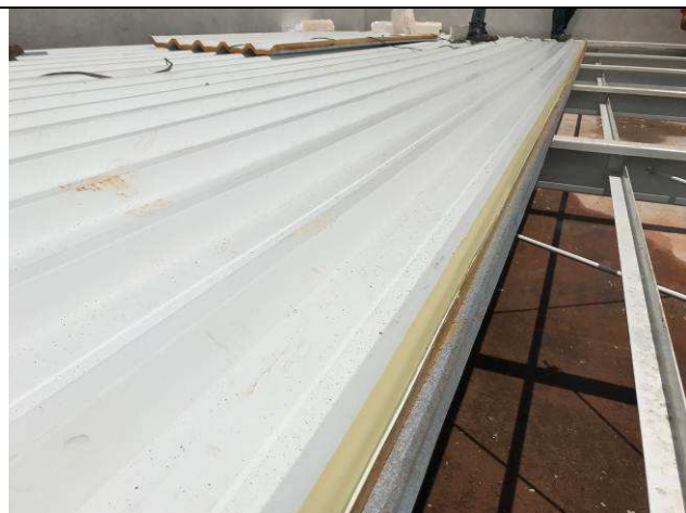
Figura 37C: Aplicação de veda onda nas extremidades junto às calhas.
