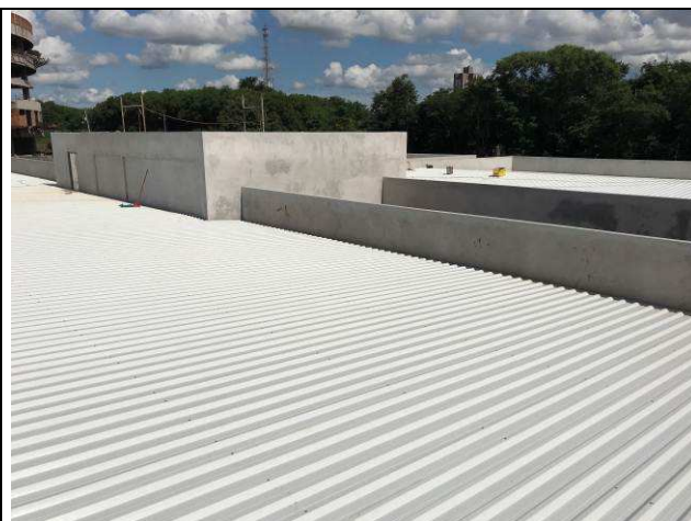
Figura 46C: Telhas metálicas de cobertura - Fórum.
