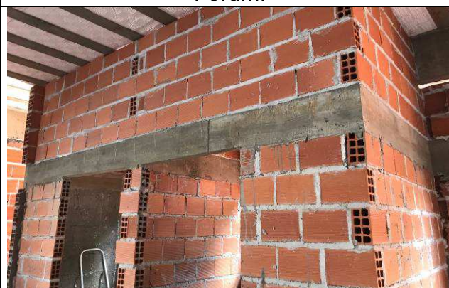
Figura 06C: Vergas e contravergas do Fórum.
