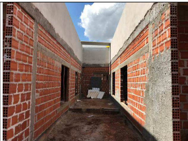
Figura 13C: Alvenarias de vedação do Fórum.
