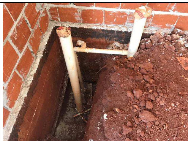
Figura 87C: Pontos de esgoto - BWC distribuição - Fórum.
