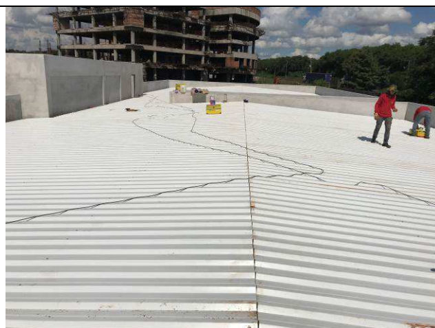
Figura 43C: Telhas metálicas de cobertura - Fórum.
