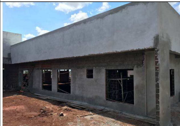
Figura 66C: Revestimento argamassado da face externa - Fórum.
