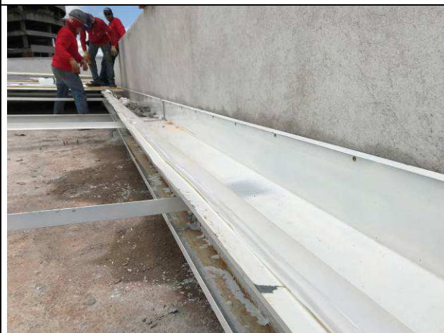
Figura 48C: Calhas de cobertura - Fórum.
