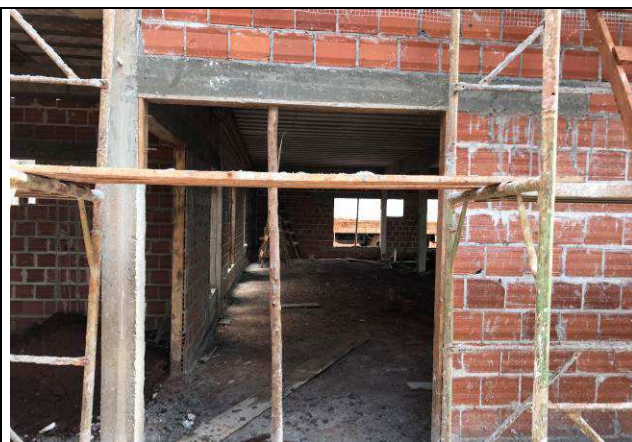
Figura 10C: Vergas e contravergas do Fórum.
