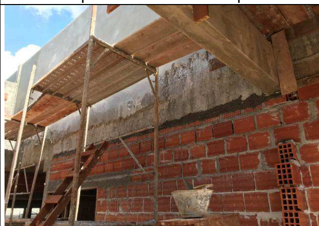
Figura 62C: Instalação da tela na junta alvenaria x viga cobertura - Fórum.
