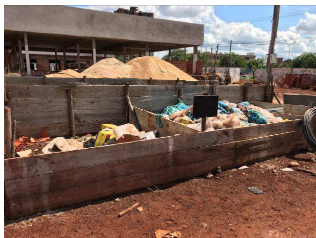
Figura 01C: Entulhos separados no canteiro de obras antes da remoção.
