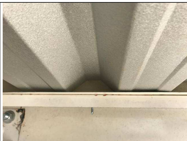
Figura 40C: Aplicação de fita de vedação nas emendas.
