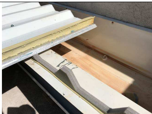
Figura 39C: Aplicação de veda onda nas extremidades junto às calhas.
