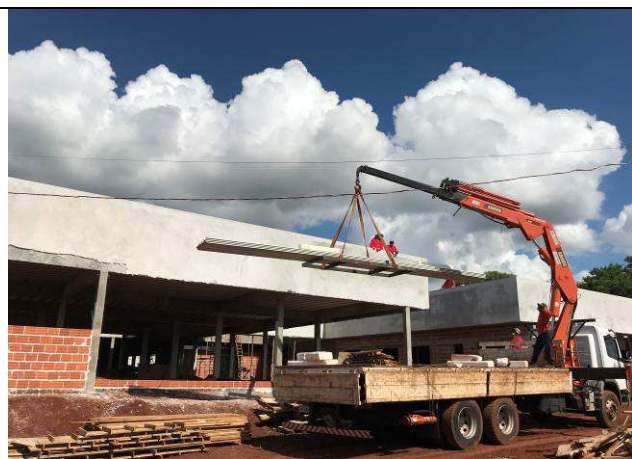
Figura 33C: Montagem das telhas metálicas de cobertura - Fórum.
