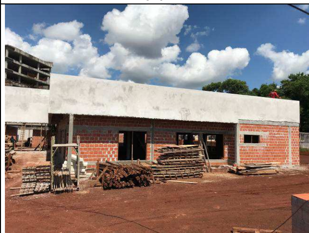
Figura 18C: Alvenarias de vedação do Fórum.
