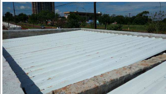
Figura 54C: Telhas metálicas de cobertura - Guarita.
