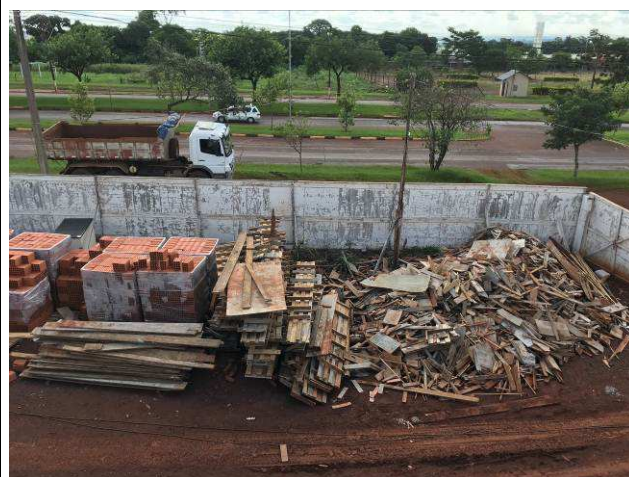
Figura 02C: Remoção de entulhos com a utilização de caminhões basculantes.
