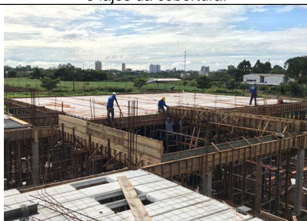
Figura 11C: Formas e armaduras das vigas e lajes da cobertura.
