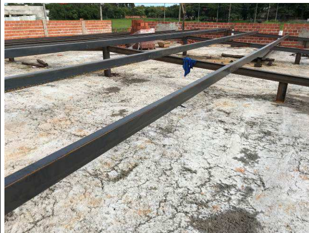
Figura 40C: Estrutura metálica de cobertura - pórticos e terças.
