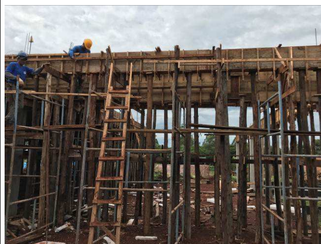
Figura 16C: Formas e armaduras das vigas e lajes da cobertura.
