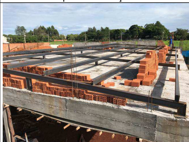
Figura 37C: Estrutura metálica de cobertura - pórticos e terças.
