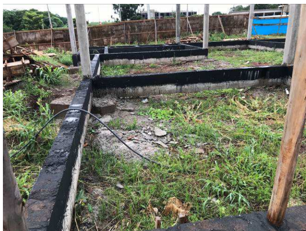
Figura 41C: Vigas baldrames impermeabilizadas.
