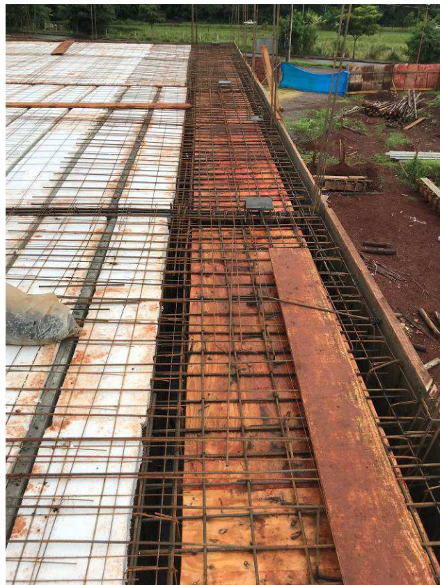
Figura 03C: Formas e armaduras das vigas e lajes da cobertura.
