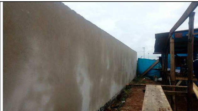
Figura 44C: Muro de fechamento dos fundos.
