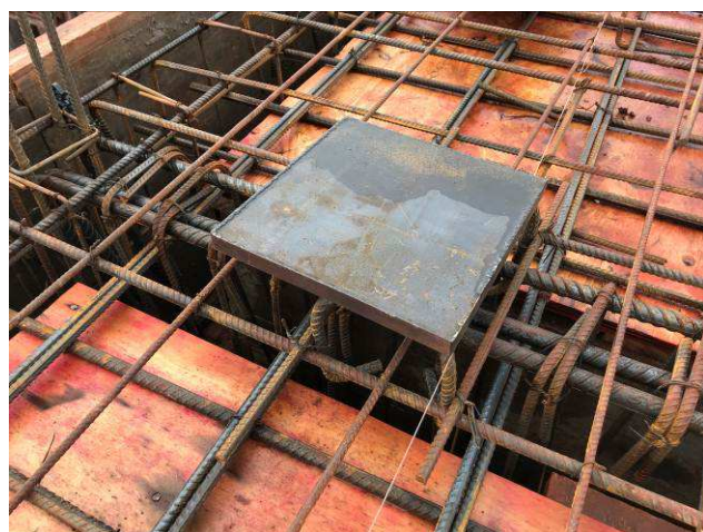
Figura 05C: Formas e armaduras das vigas e lajes da cobertura - insertes metálicos.
