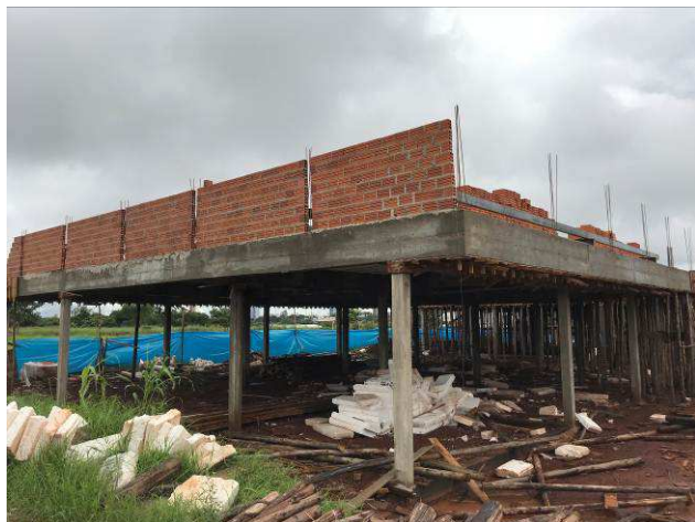
Figura 29C: Paredes de alvenaria da platibanda.
