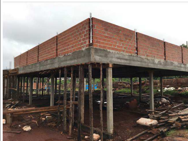
Figura 30C: Paredes de alvenaria da platibanda.
