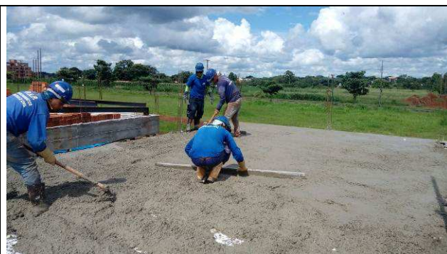
Figura 24C: Concretagem das vigas e lajes da cobertura.
