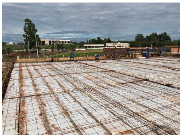
Figura 01C: Formas e armaduras das vigas e lajes da cobertura.
