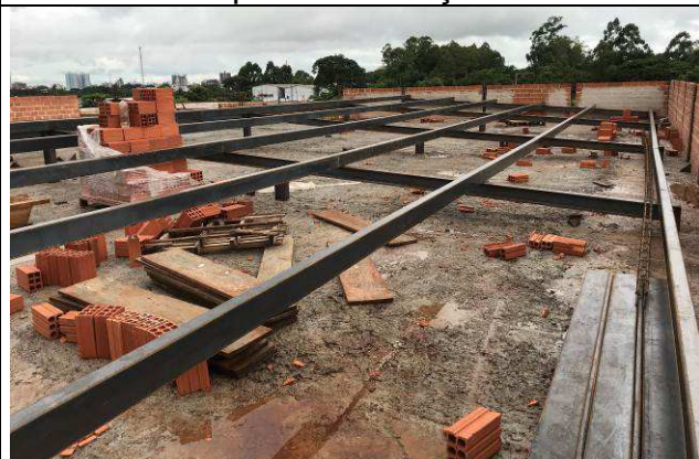
Figura 36C: Estrutura metálica de cobertura - pórticos e terças.
