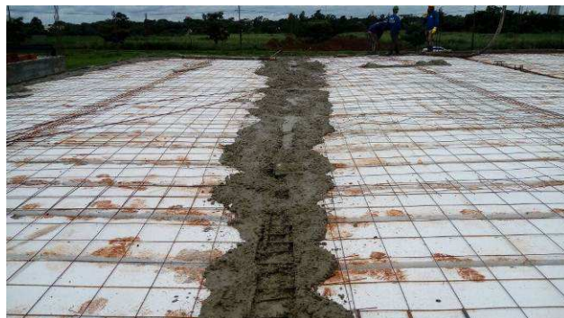
Figura 18C: Concretagem das vigas e lajes da cobertura.
