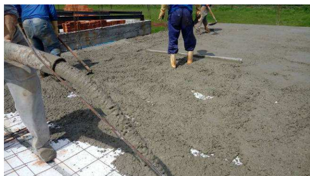
Figura 27C: Concretagem das vigas e lajes da cobertura.
