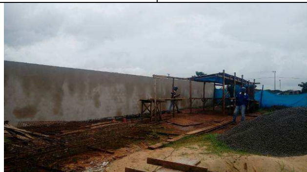
Figura 45C: Muro de fechamento dos fundos.
