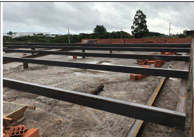
Figura 34C: Estrutura metálica de cobertura - pórticos e terças.
