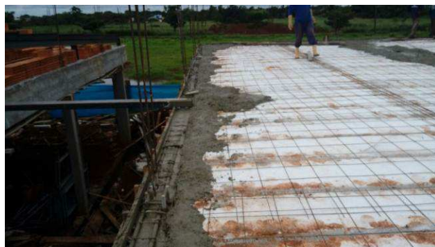
Figura 20C: Concretagem das vigas e lajes da cobertura.
