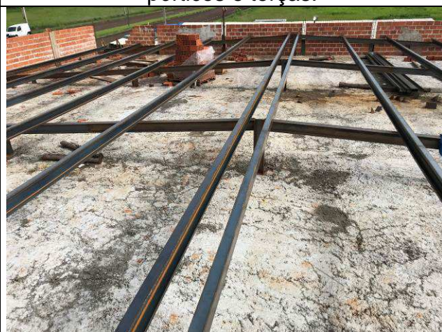
Figura 38C: Estrutura metálica de cobertura - pórticos e terças.
