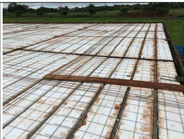
Figura 08C: Formas e armaduras das vigas e lajes da cobertura.
