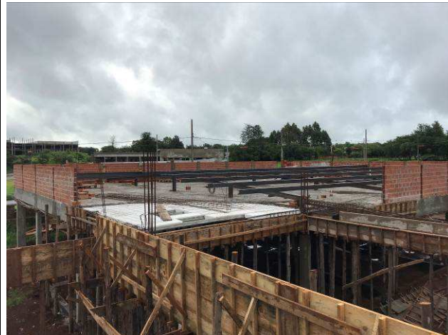
Figura 32C: Paredes de alvenaria da platibanda.
