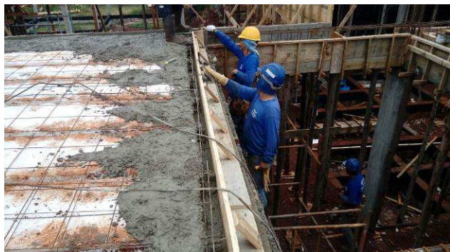
Figura 17C: Concretagem das vigas e lajes da cobertura.
