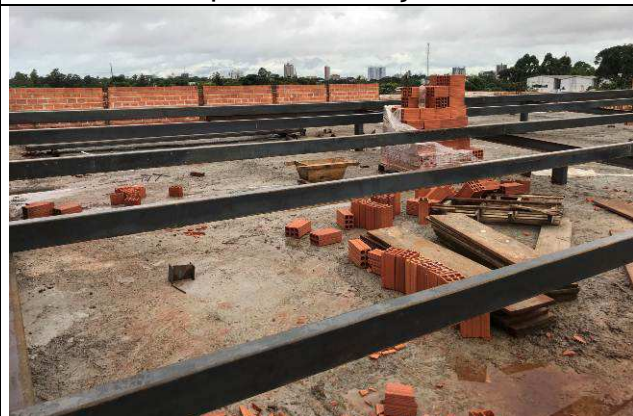
Figura 35C: Estrutura metálica de cobertura - pórticos e terças.
