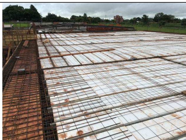
Figura 07C: Formas e armaduras das vigas e lajes da cobertura.
