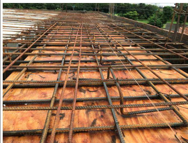
Figura 06C: Formas e armaduras das vigas e lajes da cobertura.
