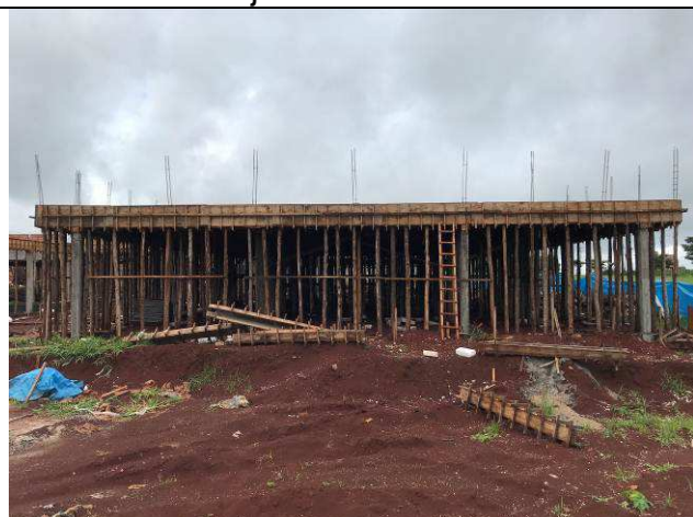
Figura 09C: Formas e armaduras das vigas e lajes da cobertura.
