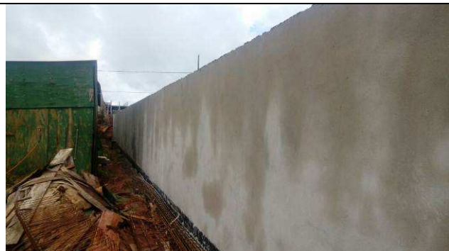
Figura 43C: Muro de fechamento dos fundos.
