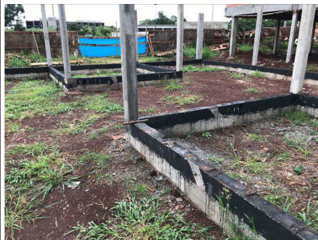
Figura 42C: Vigas baldrames impermeabilizadas.
