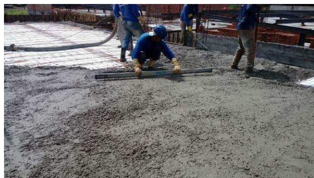
Figura 25C: Concretagem das vigas e lajes da cobertura.
