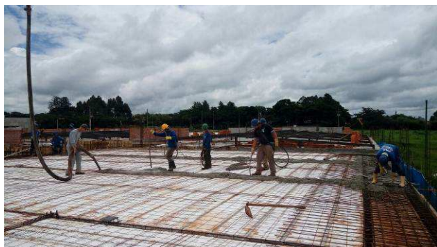
Figura 19C: Concretagem das vigas e lajes da cobertura.
