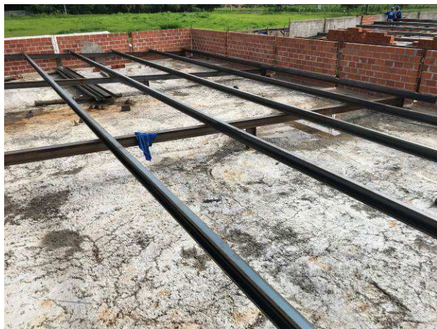
Figura 39C: Estrutura metálica de cobertura - pórticos e terças.
