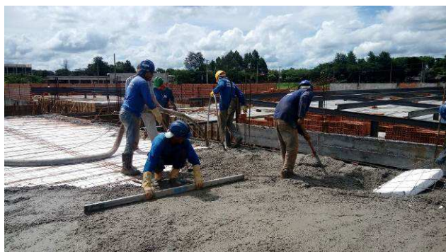
Figura 21C: Concretagem das vigas e lajes da cobertura.
