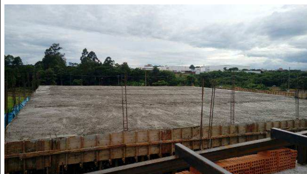
Figura 28C: Concretagem das vigas e lajes da cobertura.
