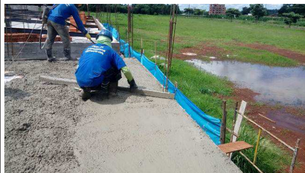
Figura 26C: Concretagem das vigas e lajes da cobertura.
