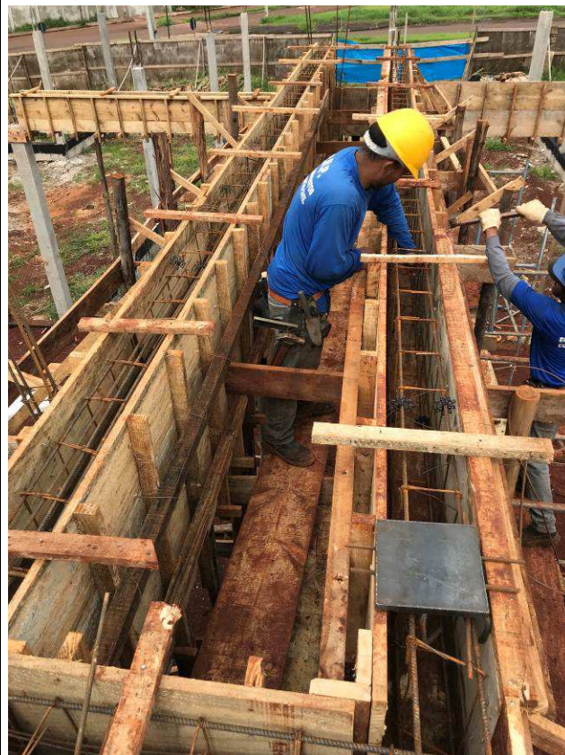
Figura 14C: Formas e armaduras das vigas e lajes da cobertura.
