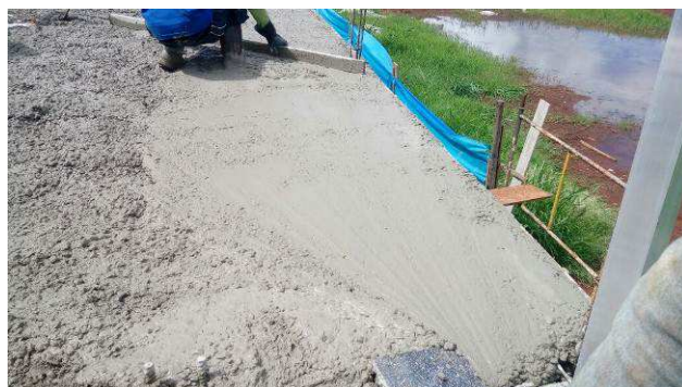
Figura 22C: Concretagem das vigas e lajes da cobertura.
