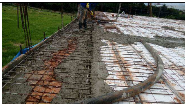
Figura 23C: Concretagem das vigas e lajes da cobertura.
