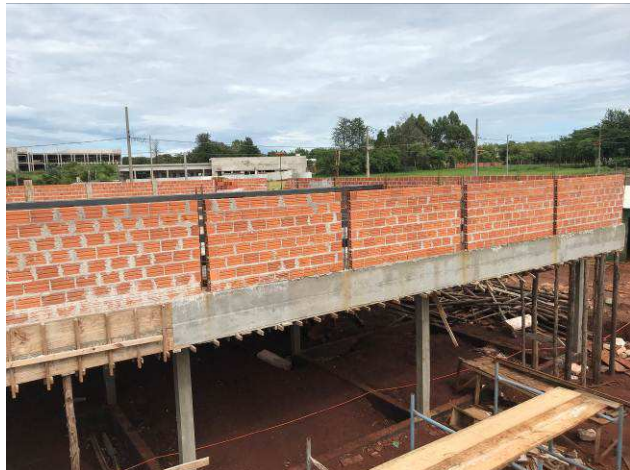
Figura 31C: Paredes de alvenaria da platibanda.
