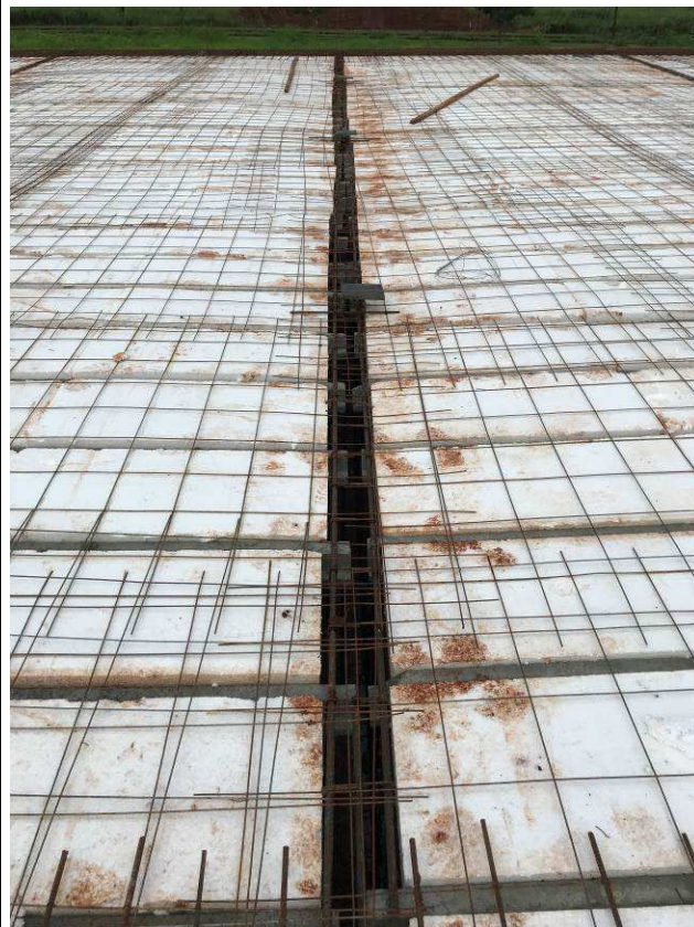
Figura 04C: Formas e armaduras das vigas e lajes da cobertura.
