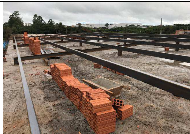
Figura 33C: Estrutura metálica de cobertura - pórticos e terças.
