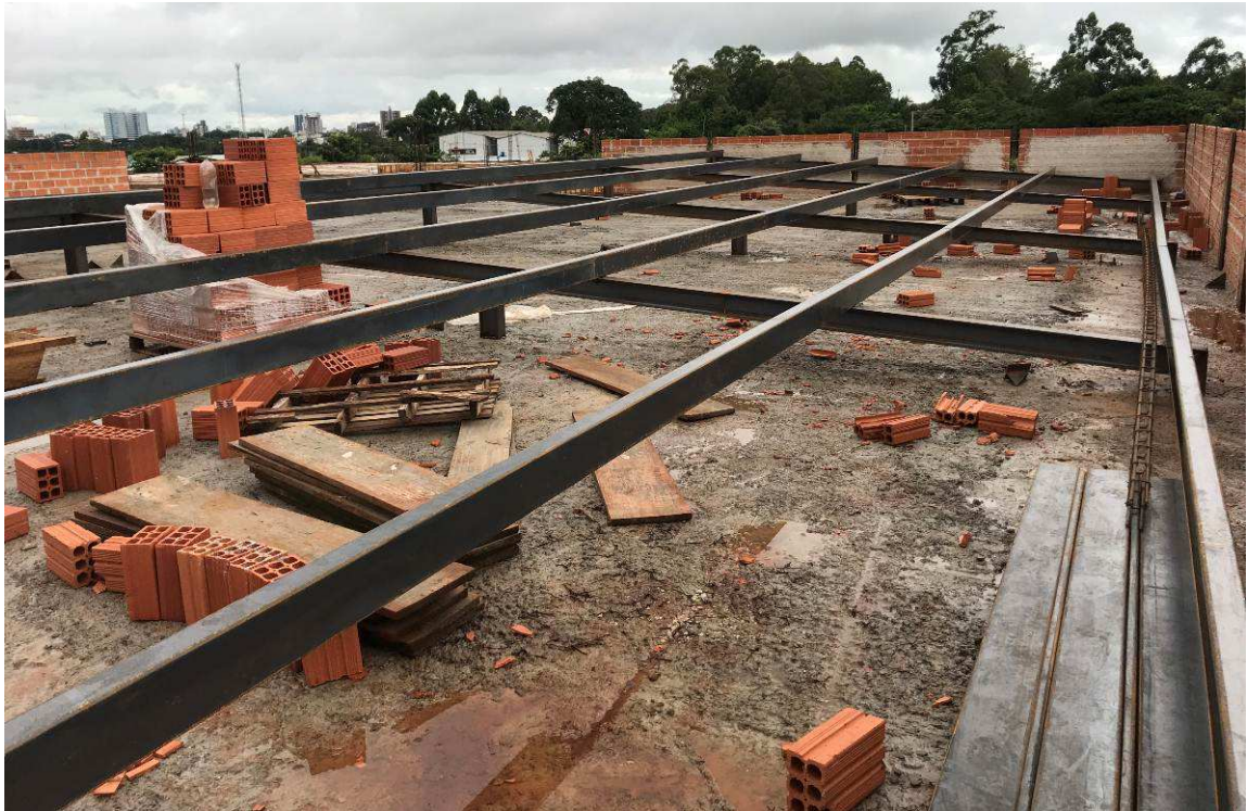
Figura 4 – Vista geral do canteiro de obras - estrutura metálica de cobertura.
