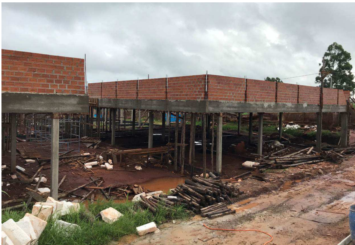
Figura 2 – Vista geral do canteiro de obras.
