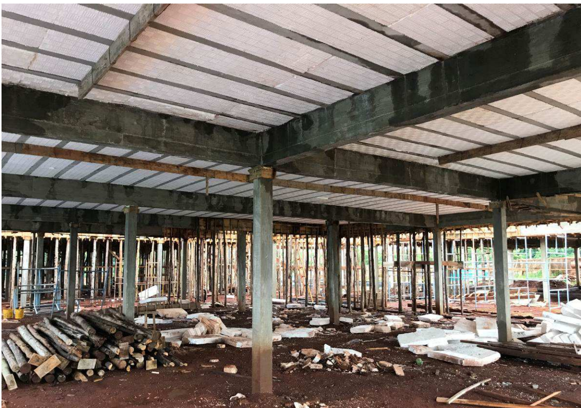
Figura 5 – Vista geral do canteiro de obras - lajes de concretadas.
