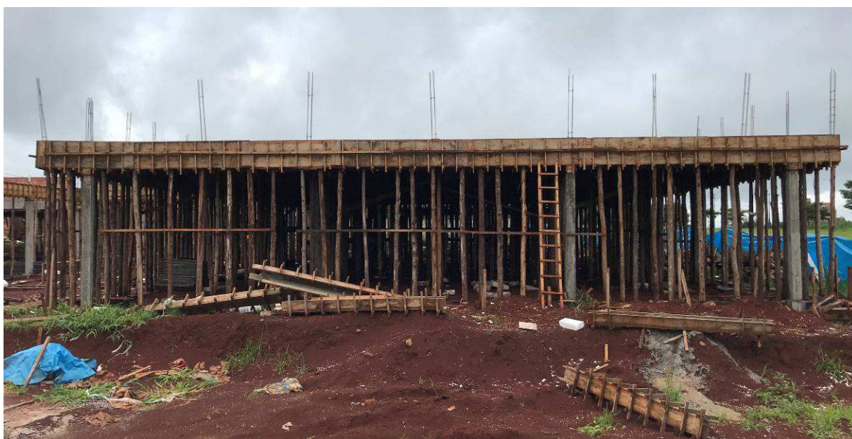
Figura 1 – Vista geral do canteiro de obras.
