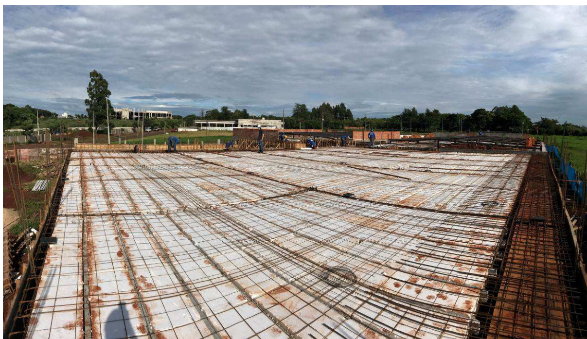
Figura 3 – Vista geral do canteiro de obras - lajes de cobertura.
