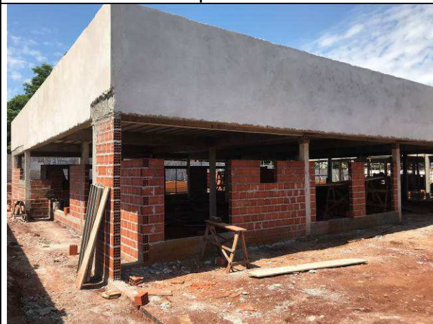
Figura 58C: Revestimento argamassado da face externa - platibandas Fórum.
