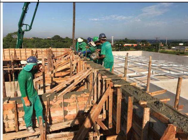
Figura 18C: Concretagem das vigas e pilares do barrilete - Fórum.
