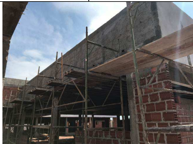
Figura 57C: Revestimento argamassado da face externa - platibandas Fórum.
