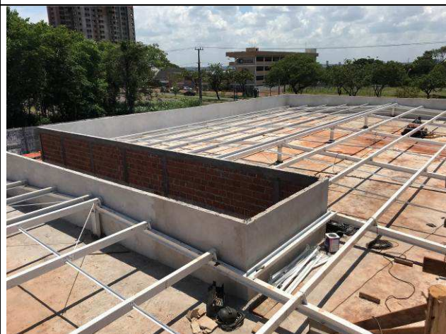
Figura 36C: Estrutura metálica de cobertura - Fórum.
