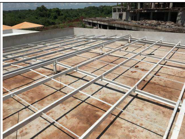
Figura 34C: Estrutura metálica de cobertura - Fórum.
