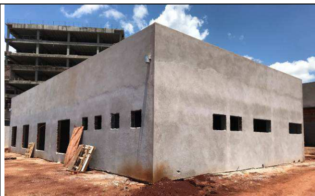
Figura 61C: Revestimento argamassado da face externa - Arquivo.
