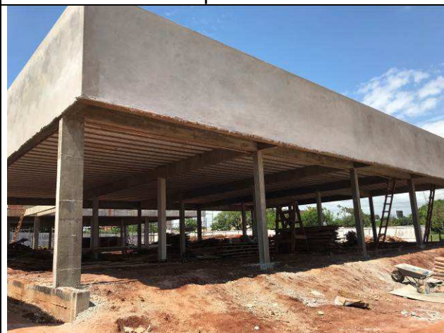
Figura 60C: Revestimento argamassado da face externa - platibandas Fórum.
