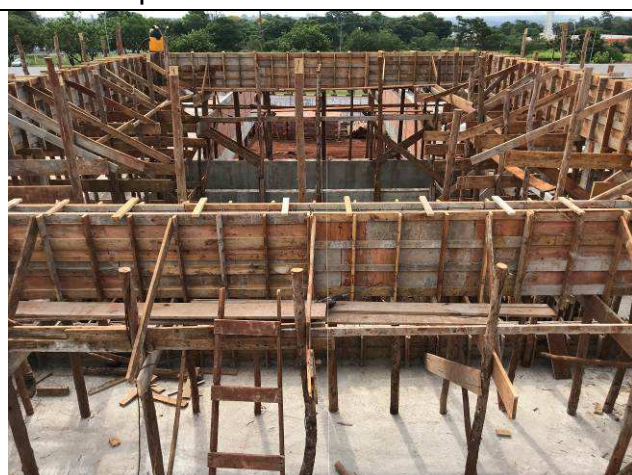
Figura 13C: Formas e armaduras das vigas e pilares do barrilete - Fórum.
