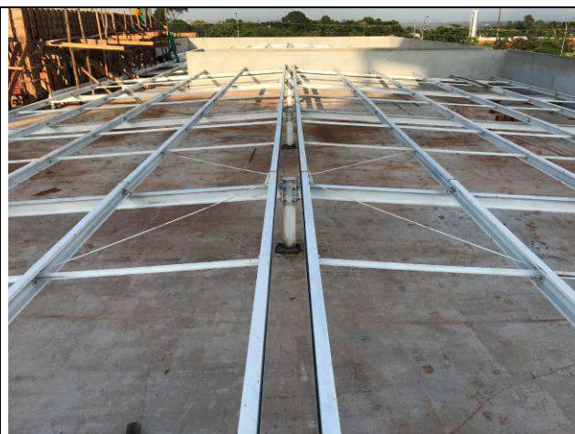
Figura 38C: Estrutura metálica de cobertura - Fórum.
