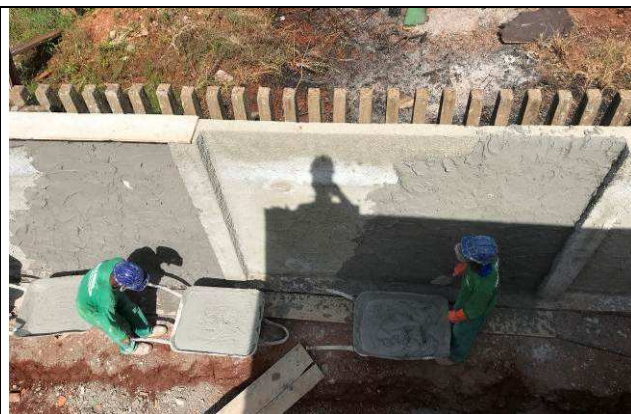
Figura 81C: Muro de fechamento - fundos.
