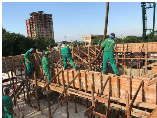
Figura 16C: Concretagem das vigas e pilares do barrilete - Fórum.
