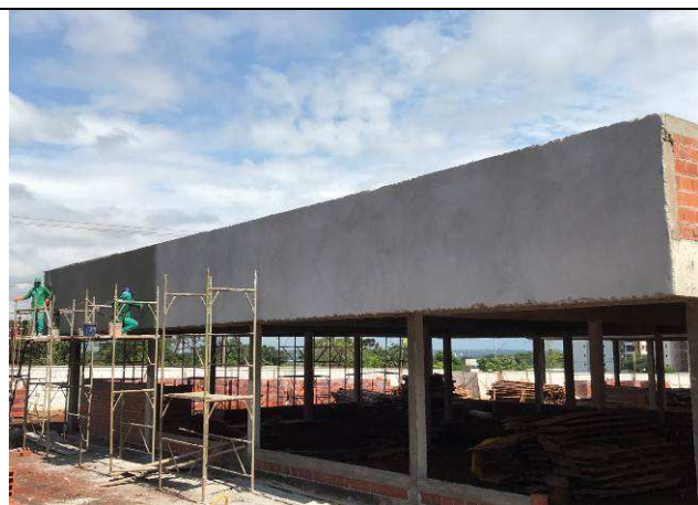
Figura 55C: Revestimento argamassado da face externa - platibandas Fórum.
