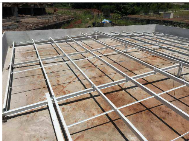
Figura 35C: Estrutura metálica de cobertura - Fórum.
