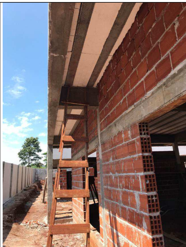
Figura 28C: Alvenarias de vedação do Fórum.
