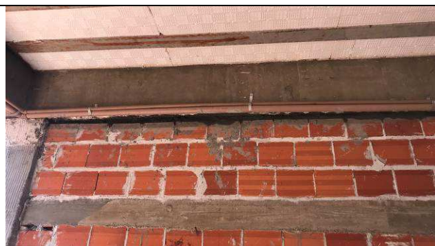
Figura 31C: Encunhamento com argamassa expansiva - Fórum.
