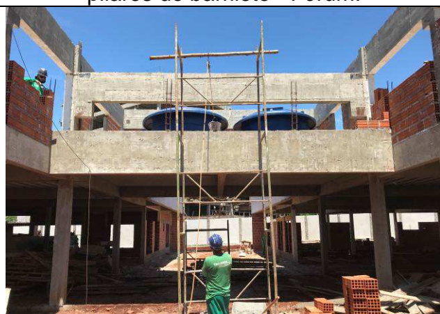
Figura 19C: Vigas e pilares do barrilete concretados - Fórum.
