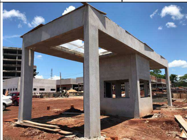
Figura 63C: Revestimento argamassado da face externa - Guarita.
