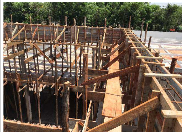
Figura 12C: Formas e armaduras das vigas e pilares do barrilete - Fórum.
