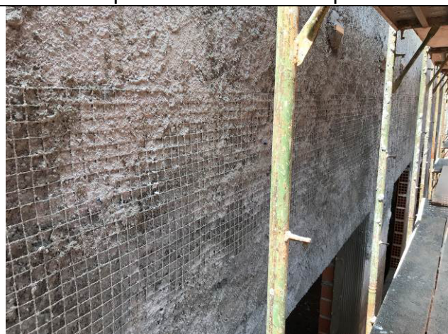
Figura 51C: Instalação da tela na junta alvenaria x viga cobertura - Arquivo.
