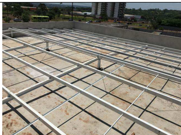
Figura 33C: Estrutura metálica de cobertura - Fórum.
