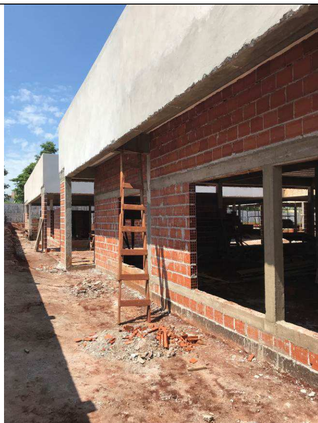
Figura 27C: Alvenarias de vedação do Fórum.
