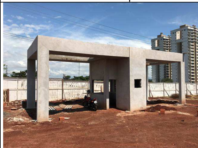
Figura 64C: Revestimento argamassado da face externa - Guarita.
