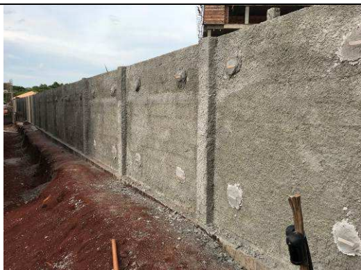
Figura 83C: Muro de fechamento - fundos.
