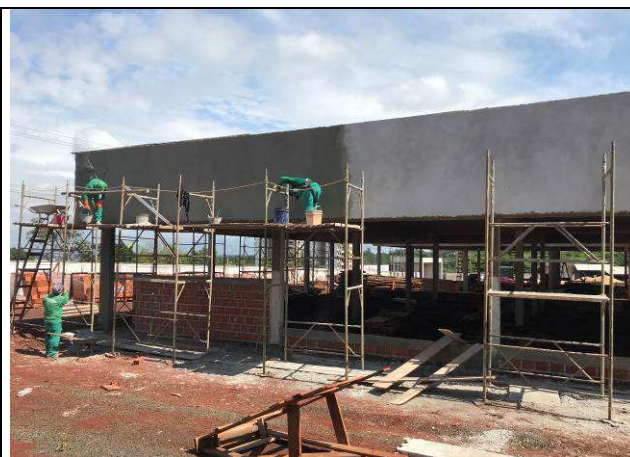
Figura 56C: Revestimento argamassado da face externa - platibandas Fórum.
