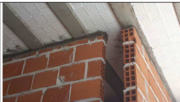
Figura 32C: Encunhamento com argamassa expansiva - Fórum.
