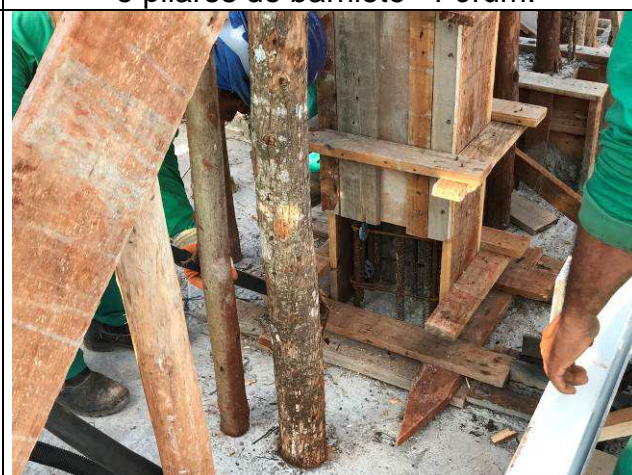
Figura 14C: Formas e armaduras das vigas e pilares do barrilete - Fórum.
