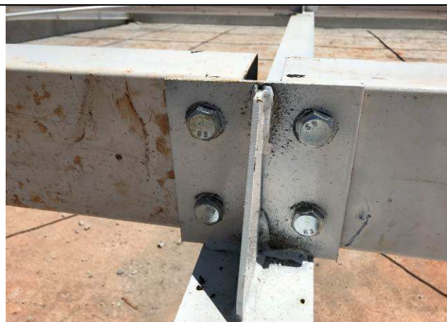
Figura 39C: Estrutura metálica de cobertura - Fórum.
