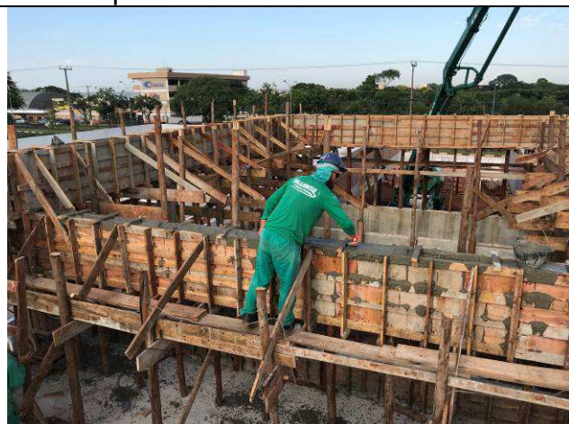
Figura 17C: Concretagem das vigas e pilares do barrilete - Fórum.
