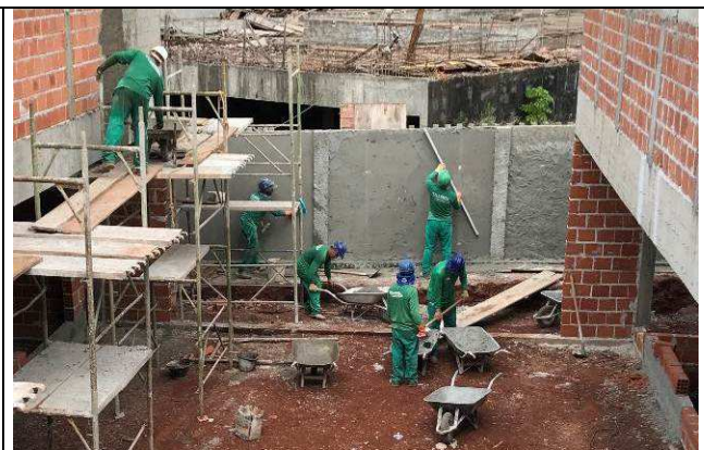
Figura 82C: Muro de fechamento - fundos.
