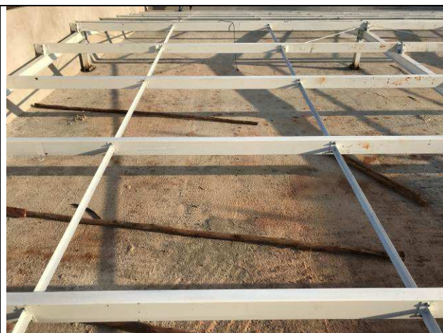
Figura 43C: Estrutura metálica de cobertura - Fórum.
