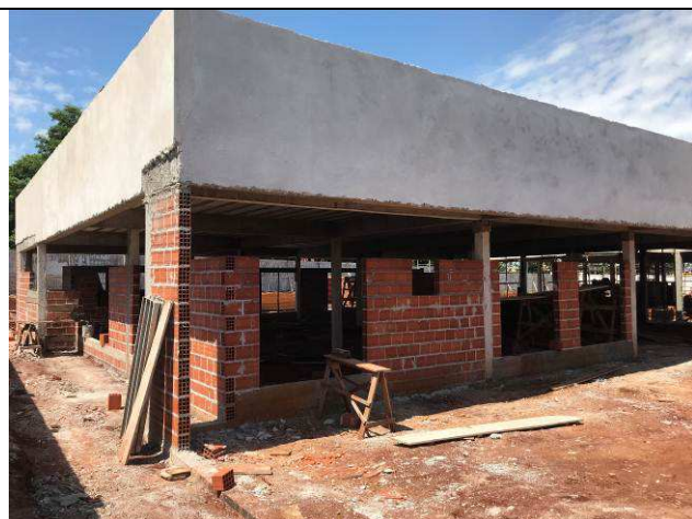
Figura 29C: Alvenarias de vedação do Fórum.
