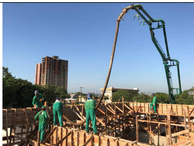
Figura 15C: Concretagem das vigas e pilares do barrilete - Fórum.
