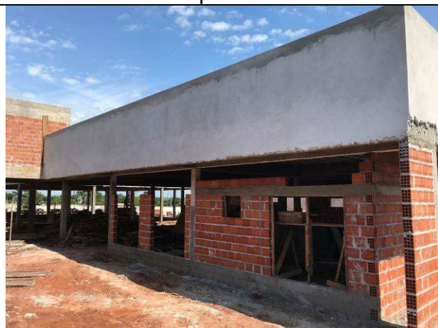
Figura 59C: Revestimento argamassado da face externa - platibandas Fórum.
