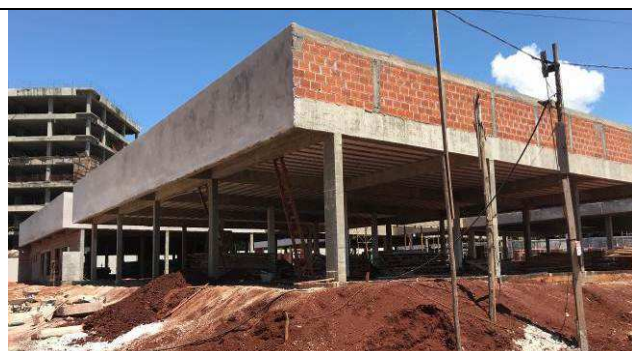
Figura 53C: Revestimento argamassado da face externa - platibandas Fórum.
