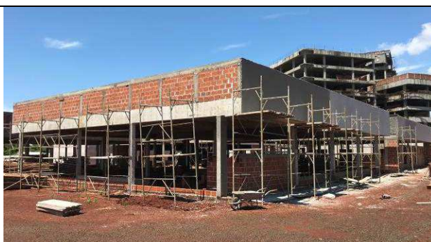
Figura 54C: Revestimento argamassado da face externa - platibandas Fórum.
