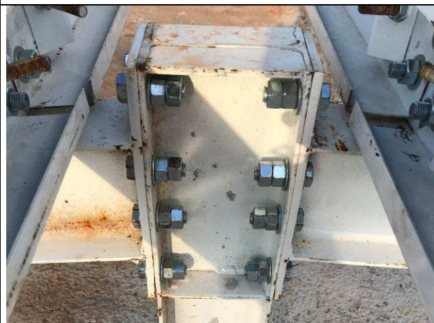
Figura 42C: Estrutura metálica de cobertura - Fórum.
