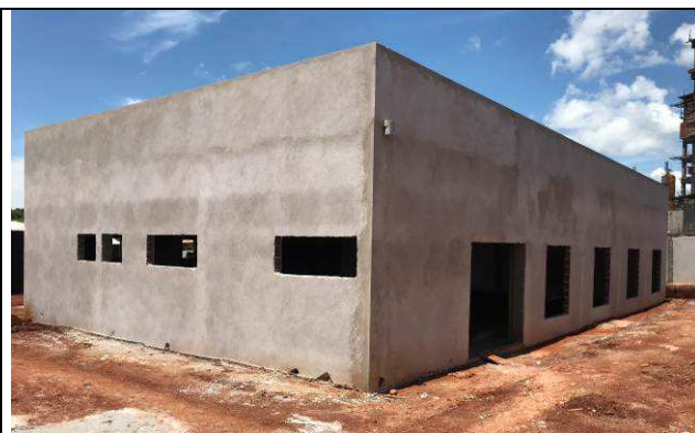
Figura 62C: Revestimento argamassado da face externa - Arquivo.
