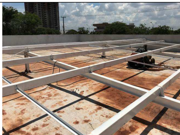
Figura 37C: Estrutura metálica de cobertura - Fórum.
