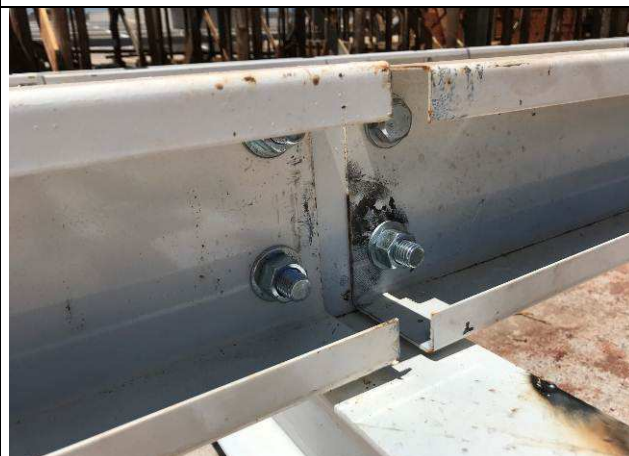
Figura 40C: Estrutura metálica de cobertura - Fórum.
