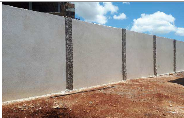
Figura 84C: Muro de fechamento - fundos.
