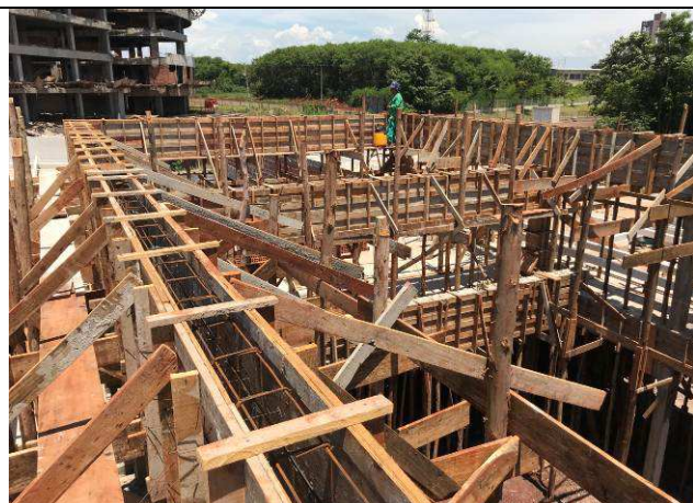
Figura 11C: Formas e armaduras das vigas e pilares do barrilete - Fórum.
