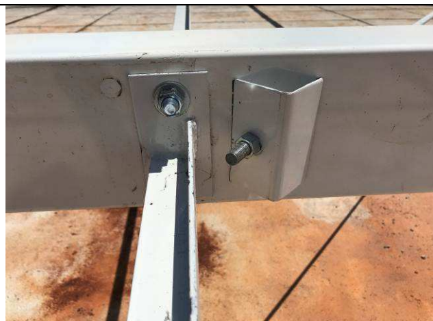
Figura 41C: Estrutura metálica de cobertura - Fórum.
