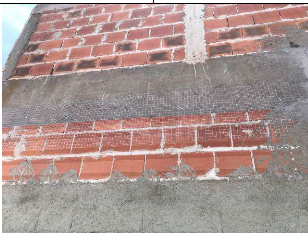
Figura 52C: Instalação da tela na junta alvenaria x viga cobertura - Arquivo.
