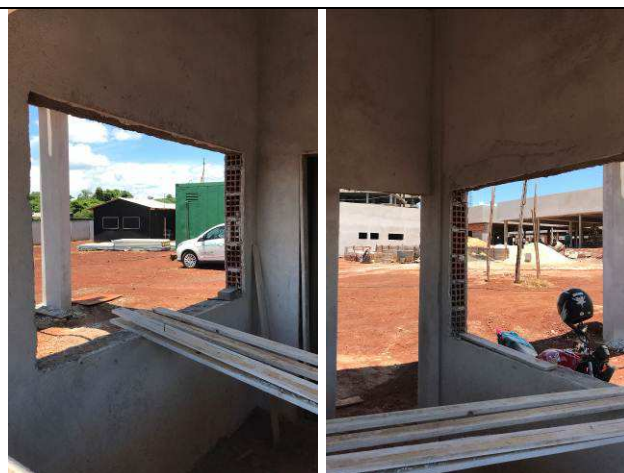
Figura 50C: Revestimento argamassado da face interna das paredes - Guarita.
