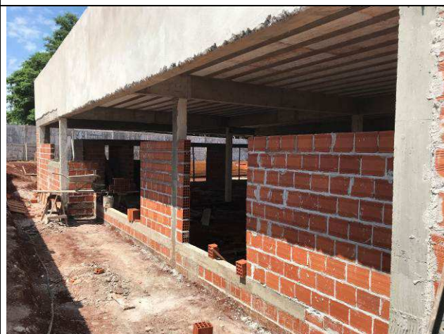
Figura 30C: Alvenarias de vedação do Fórum.
