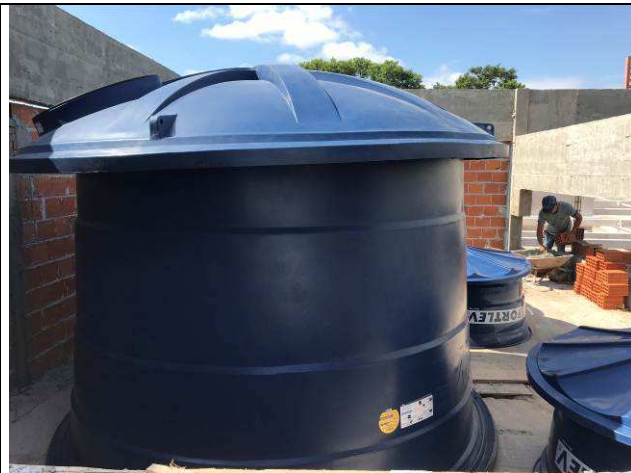
Figura 77C: Caixas d'água - 10.000 l e 1.000 l.
