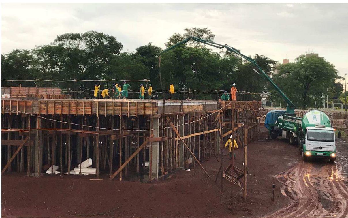
Figura 2 – Concretagem de laje - Prédio do Fórum.
