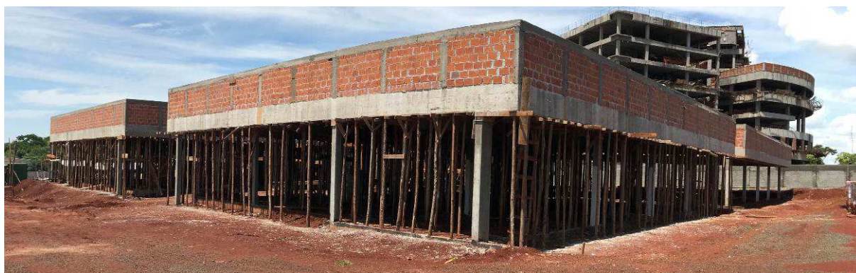
Figura 2 – Concretagem de laje - Prédio do Fórum.
