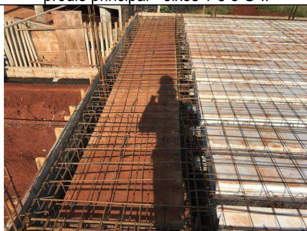
Figura 41C: Laje e vigas de cobertura do prédio principal - eixos 1-5 e G-I.
