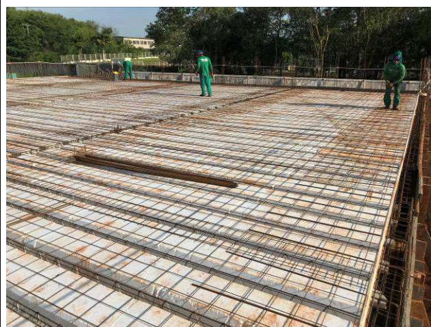
Figura 46C: Laje e vigas de cobertura do prédio principal - eixos 1-5 e G-I.
