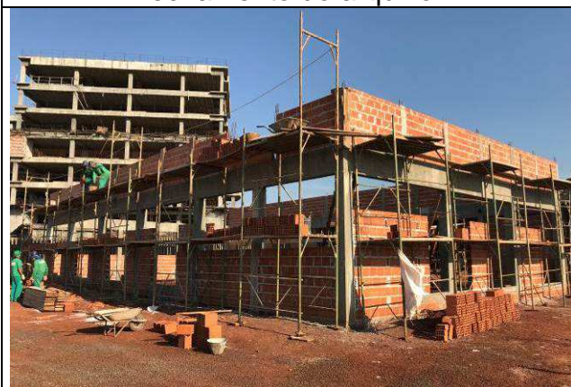
Figura 57C: Alvenaria das paredes de fechamento do arquivo.
