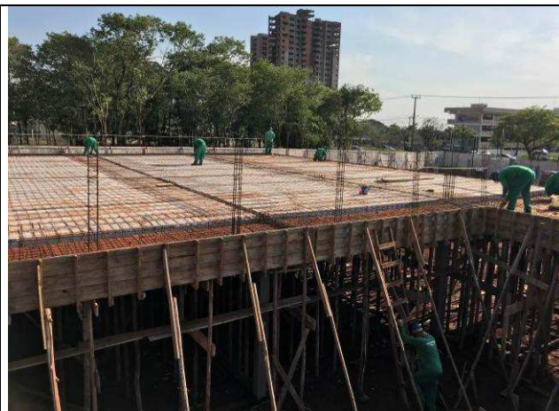
Figura 38C: Laje e vigas de cobertura do prédio principal - eixos 1-5 e G-I.
