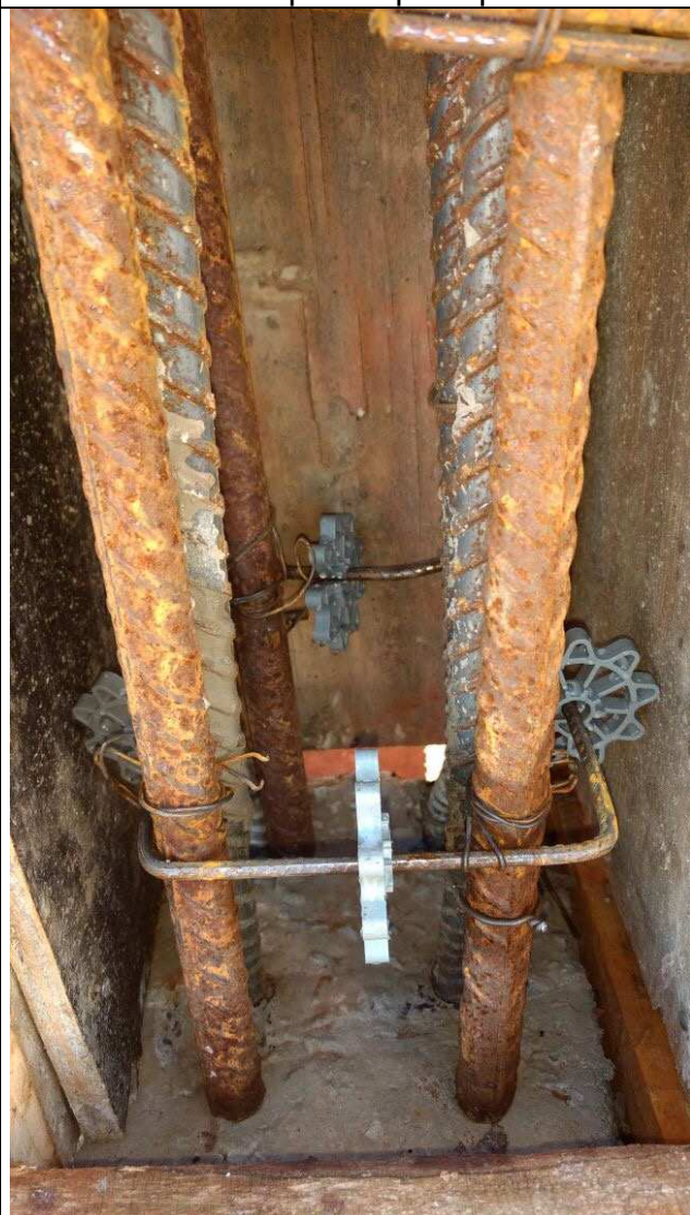
Figura 17C: Formas e armaduras do pilar P52 do prédio principal.
