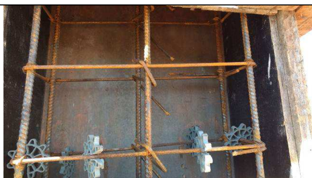
Figura 30C: Formas e armaduras do pilar P78 do prédio principal.
