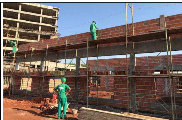
Figura 59C: Alvenaria das paredes de fechamento do arquivo.
