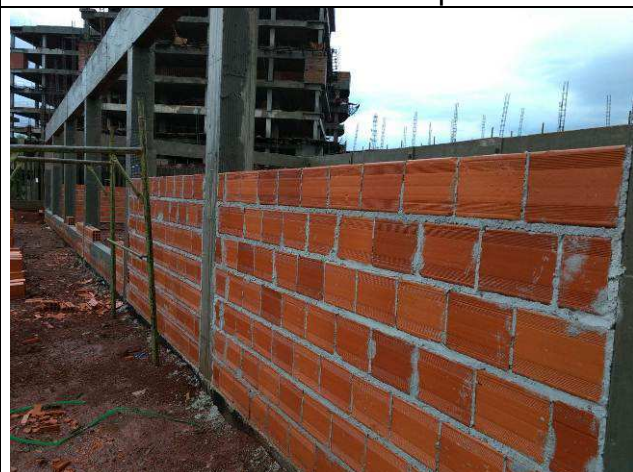
Figura 56C: Alvenaria das paredes de fechamento do arquivo.
