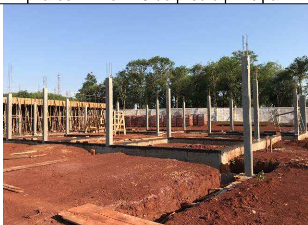
Figura 33C: Pilares do prédio principal concretados.
