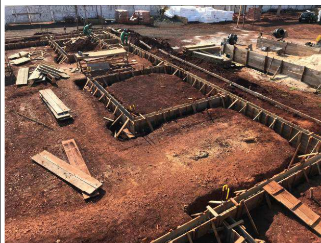
Figura 02C: Formas e armaduras das vigas baldrame do prédio principal.
