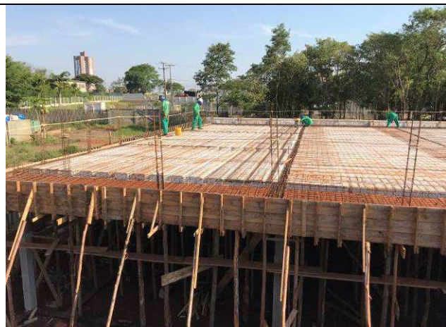
Figura 37C: Laje e vigas de cobertura do prédio principal - eixos 1-5 e G-I.
