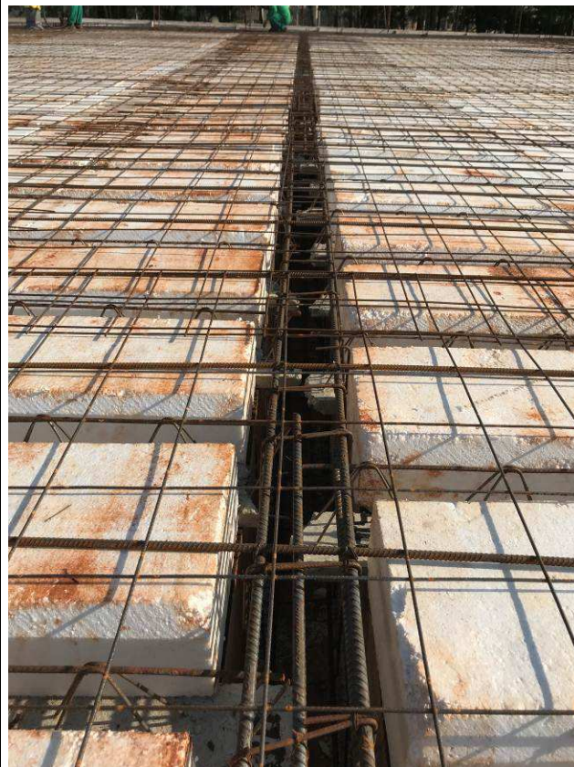
Figura 44C: Laje e vigas de cobertura do prédio principal - eixos 1-5 e G-I.
