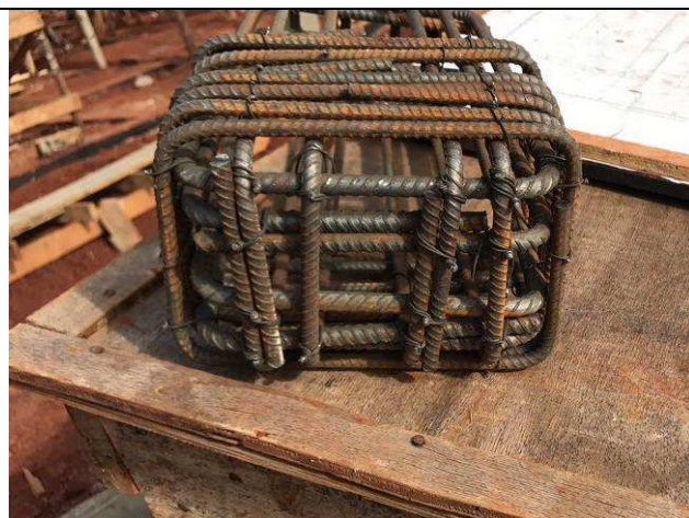
Figura 32C: Armaduras dos consoles dos pilares P44 e P45 do prédio principal.
