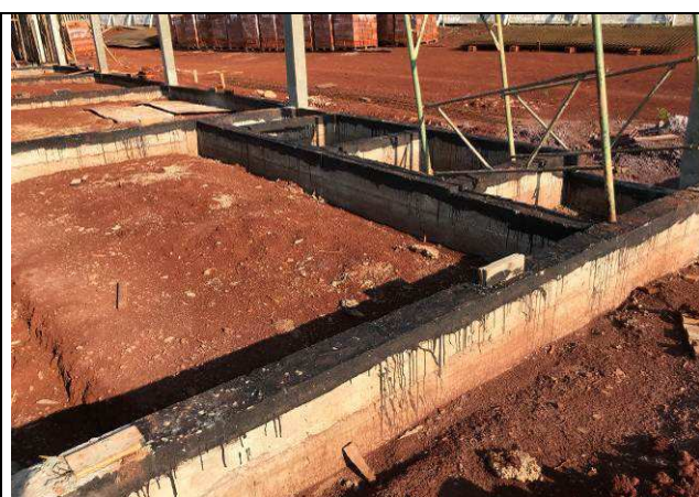
Figura 64C: Impermeabilização das vigas baldrame do prédio principal.
