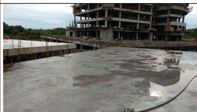
Figura 49C: Concretagem da laje e vigas de cobertura do prédio principal.
