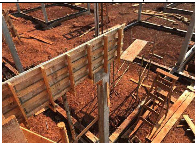
Figura 34C: Console do pilar P45 do prédio principal concretado.
