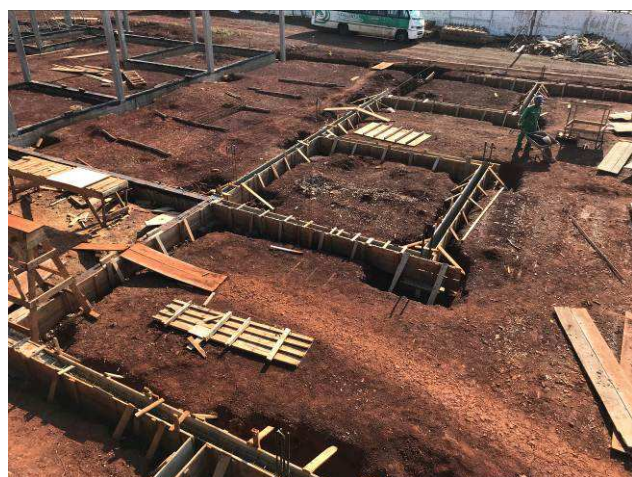
Figura 01C: Formas e armaduras das vigas baldrame do prédio principal.
