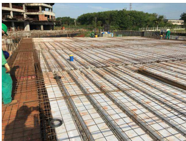
Figura 45C: Laje e vigas de cobertura do prédio principal - eixos 1-5 e G-I.
