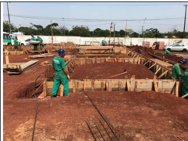
Figura 04C: Formas e armaduras das vigas baldrame do prédio principal.
