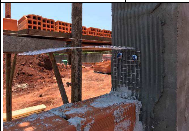
Figura 61C: Tela de união entre os pilares e a alvenaria.
