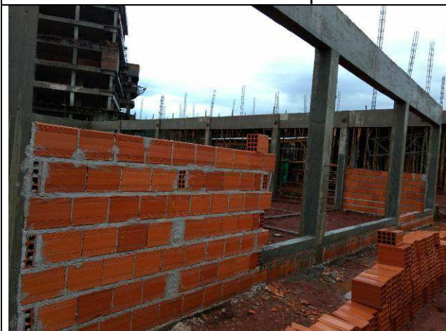
Figura 55C: Alvenaria das paredes de fechamento do arquivo.
