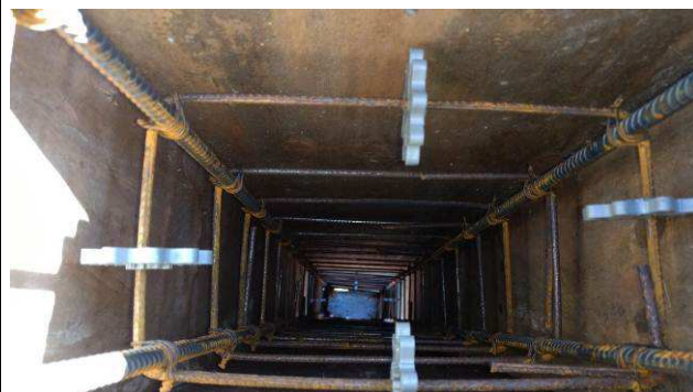
Figura 22C: Formas e armaduras do pilar P56 do prédio principal.
