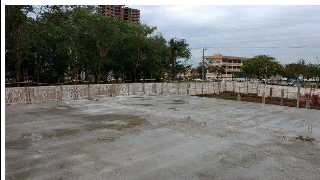
Figura 51C: Laje e vigas de cobertura do prédio principal concretadas.
