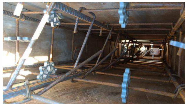
Figura 20C: Formas e armaduras do pilar P48 do prédio principal.
