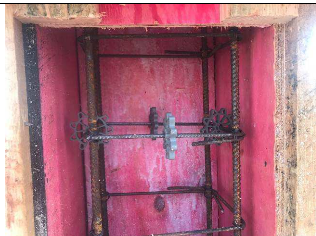
Figura 25C: Formas e armaduras do pilar P69 do prédio principal.
