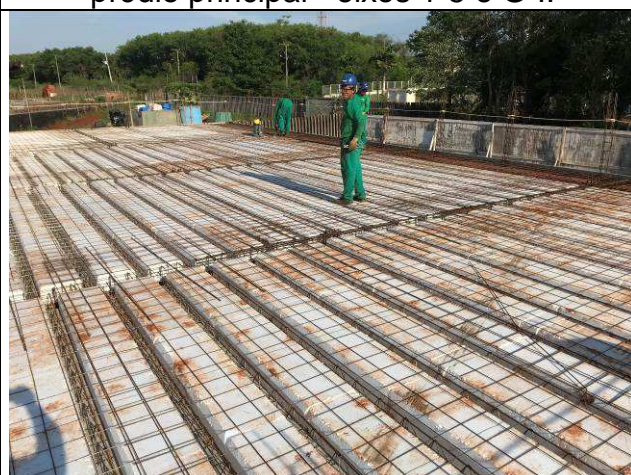
Figura 42C: Laje e vigas de cobertura do prédio principal - eixos 1-5 e G-I.
