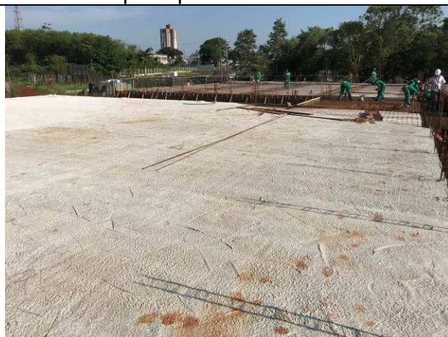
Figura 36C: Laje e vigas de cobertura do prédio principal - eixos 1-5 e D-I.
