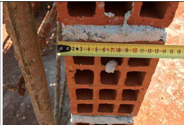
Figura 54C: Tijolo utilizado para as paredes de fechamento do arquivo.
