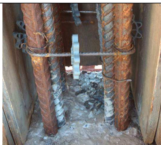
Figura 28C: Formas e armaduras do pilar P79 do prédio principal.
