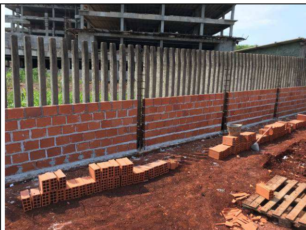
Figura 70C: Alvenarias - muro de fechamento - fundos.
