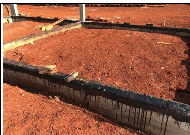
Figura 63C: Impermeabilização das vigas baldrame do prédio principal.
