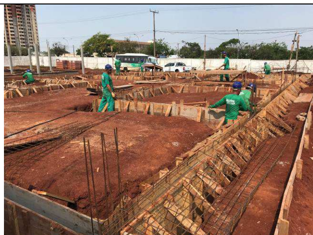
Figura 05C: Formas e armaduras das vigas baldrame do prédio principal.
