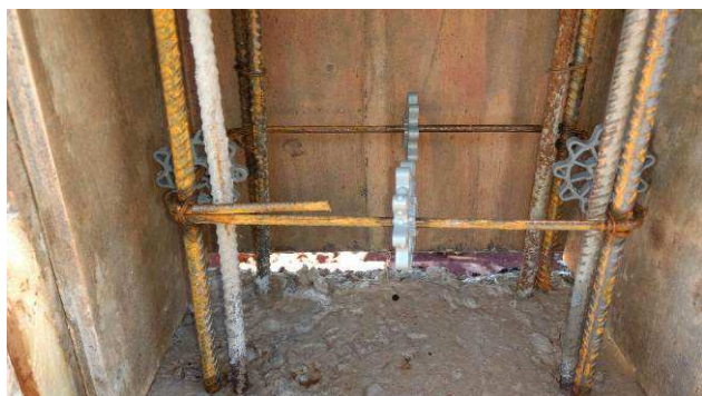
Figura 21C: Formas e armaduras do pilar P56 do prédio principal.
