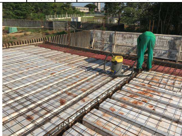
Figura 39C: Laje e vigas de cobertura do prédio principal - eixos 1-5 e G-I.
