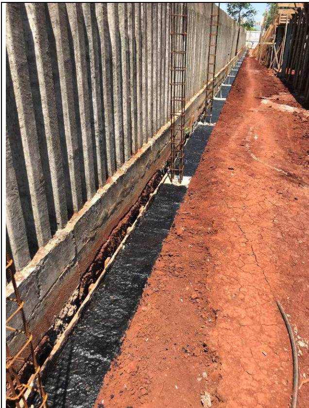
Figura 65C: Vigas baldrame - muro de fechamento - fundos.
