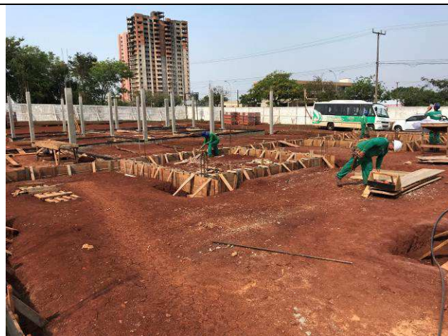
Figura 03C: Formas e armaduras das vigas baldrame do prédio principal.
