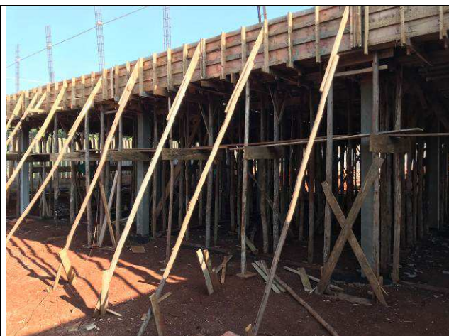
Figura 47C: Laje e vigas de cobertura do prédio principal - eixos 1-5 e G-I.
