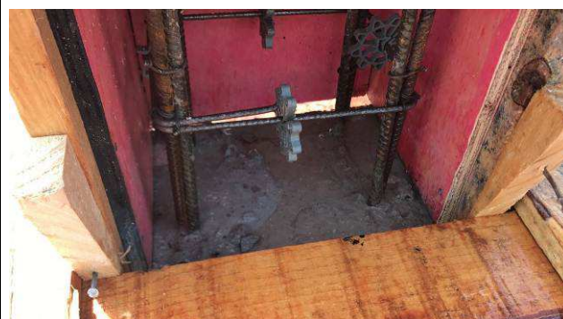
Figura 24C: Formas e armaduras do pilar P69 do prédio principal.
