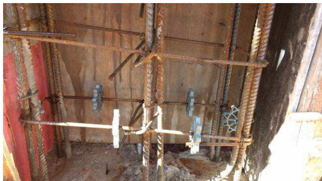
Figura 19C: Formas e armaduras do pilar P48 do prédio principal.
