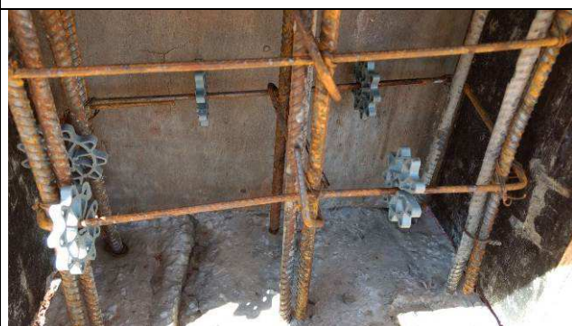
Figura 29C: Formas e armaduras do pilar P78 do prédio principal.
