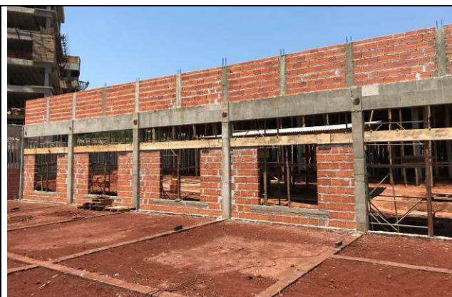
Figura 60C: Alvenaria das paredes de fechamento do arquivo.
