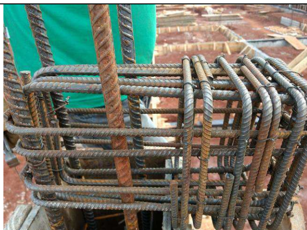
Figura 31C: Armaduras dos consoles dos pilares P44 e P45 do prédio principal.
