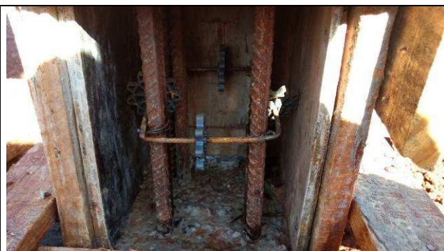
Figura 15C: Formas e armaduras do pilar P45 do prédio principal.
