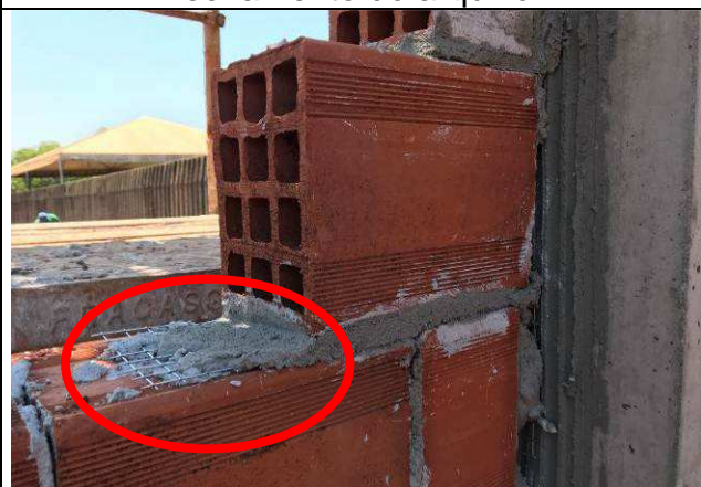
Figura 62C: Tela de união entre os pilares e a alvenaria.
