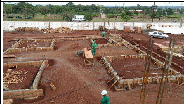
Figura 08C: Vigas baldrame do prédio principal concretadas.
