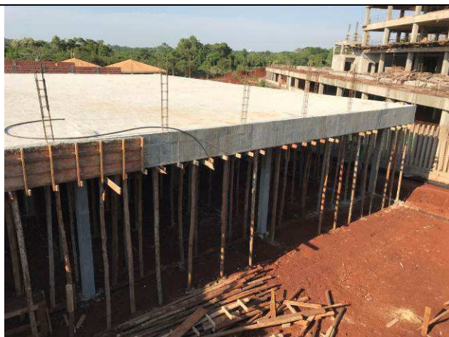
Figura 35C: Laje e vigas de cobertura do prédio principal - eixos 1-5 e D-F.
