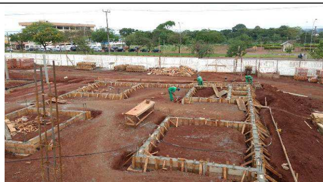
Figura 07C: Vigas baldrame do prédio principal concretadas.
