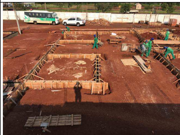
Figura 06C: Vigas baldrame do prédio principal concretadas.
