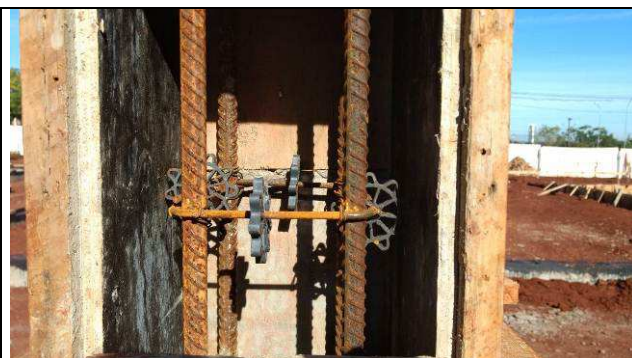
Figura 16C: Formas e armaduras do pilar P45 do prédio principal.
