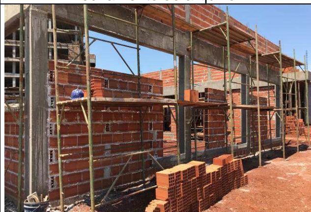
Figura 58C: Alvenaria das paredes de fechamento do arquivo.
