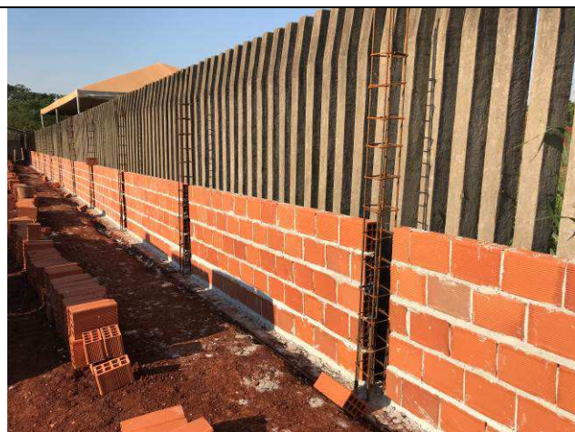
Figura 69C: Alvenarias - muro de fechamento - fundos.
