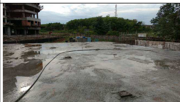
Figura 50C: Laje e vigas de cobertura do prédio principal concretadas.
